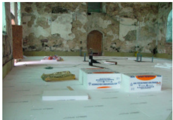
Fig 19. Frigolitplattor som isolering.
