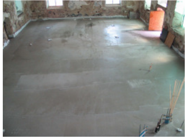
Fig 21. Betongen är gjuten.
