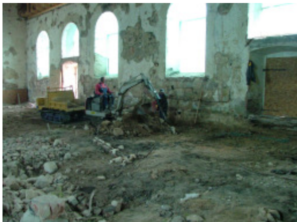
Fig 11. En Bobcat användes för att ta bort kalkstengångarna längs sidorna.
