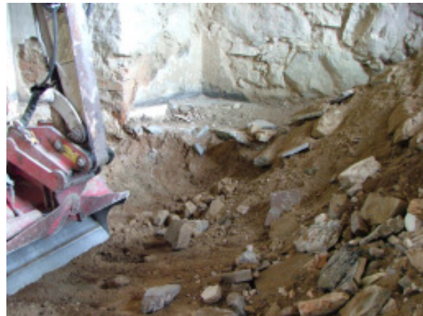
Fig 23. Schaktning i tornet. Foto Eeva Rajala.
