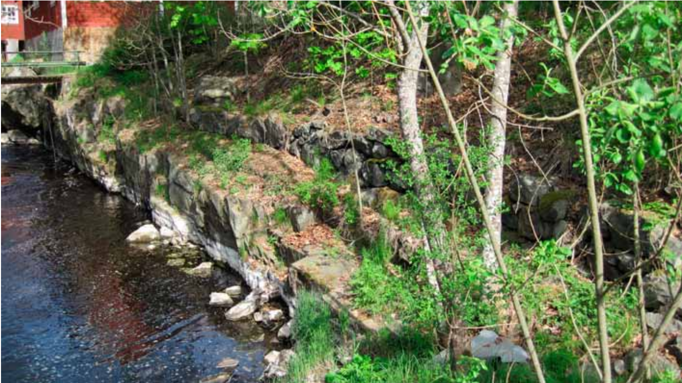
Fig. 20. Den kallmurade resten av en mur som löper mellan lokal 3 uppströms mot lokal 2 och mjölkvarnen. Foto: Ulrika Söderström, KLM.
