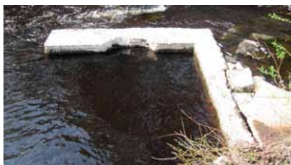
Fig. 19. Sentida konstruktion i åfåran invid lokal 3. Foto: Ulrika Söderström, KLM.
