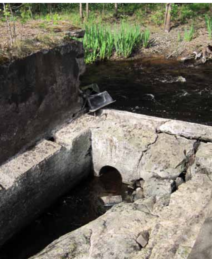
Fig. 18. Del av sektion som föreslås sänkas för att leda om vattnet i ån. Lokal 3. Foto: Ulrika Söderström, KLM.
