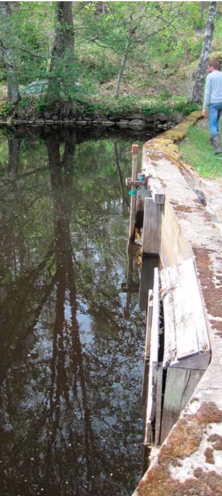
Fig. 24. Den befintliga dammvallen med dammluckorna. Foto: Ulrika Söderström, KLM.
