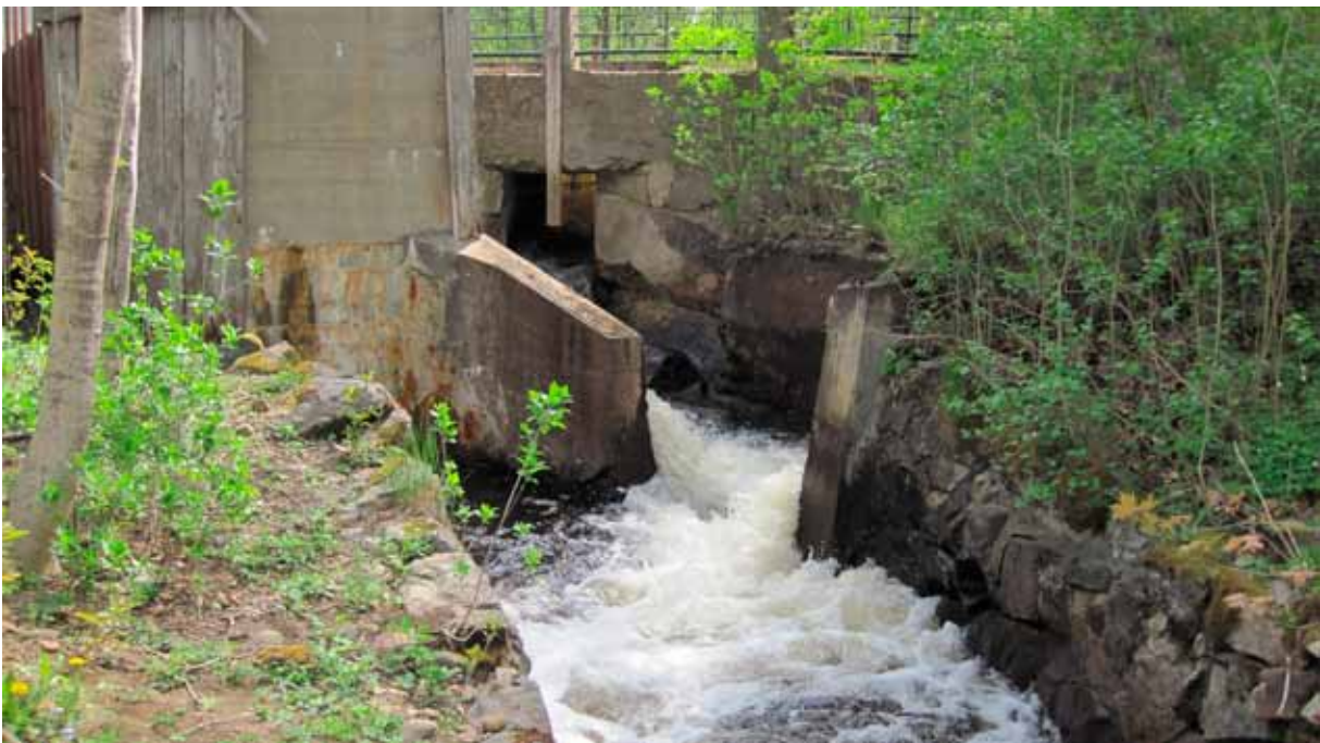
Fig. 27. Betongförstärkta kanter vid vattenfallet, lokal 5. Foto: Ulrika Söderström, KLM.
