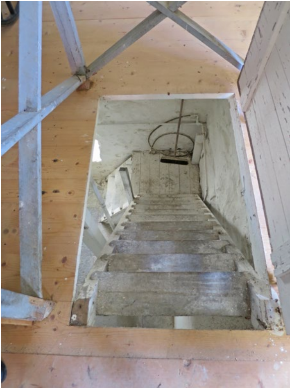
Inre trappan före ny ledstång monterades, uppifrån.
