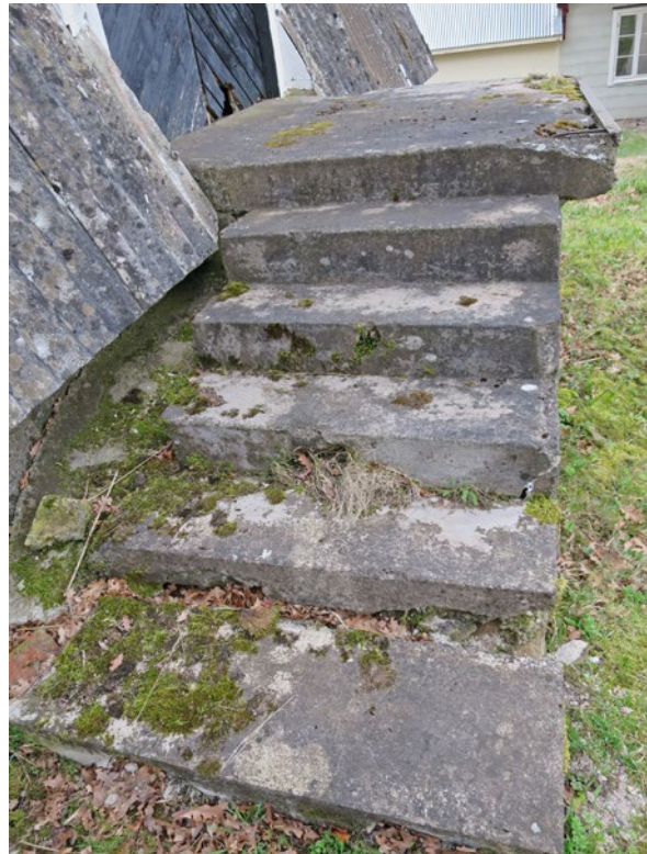
Trappan mot norr före åtgärder.
