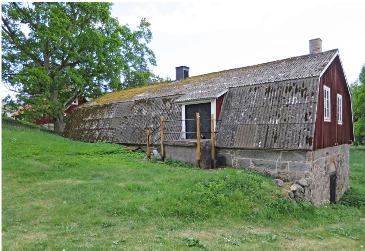
Mältans nordvästra fasader med yttre ingången efter åtgärder.
