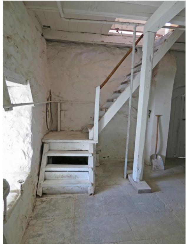
Inre trappan efter att ny ledstång monterades, nerifrån.
