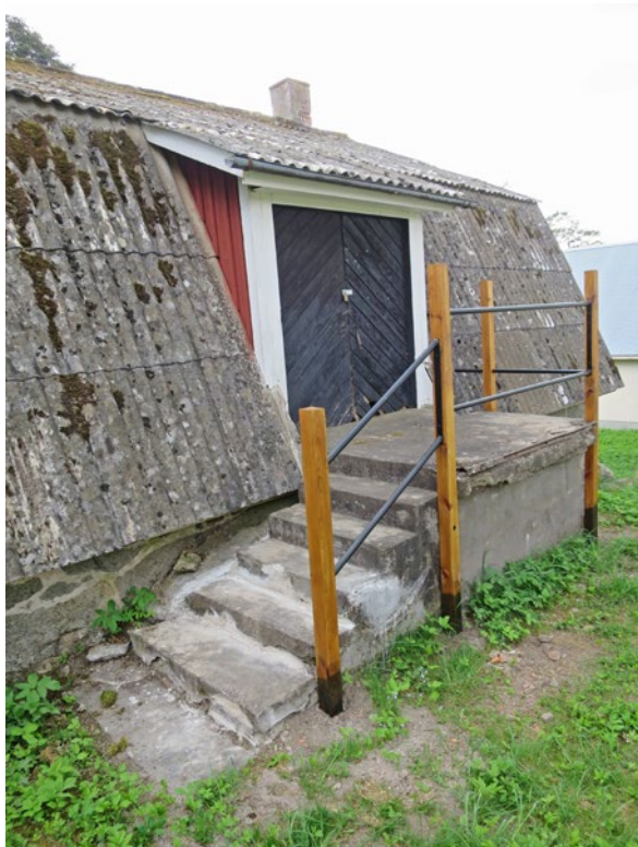
Yttre ingången mot norr efter åtgärder.
