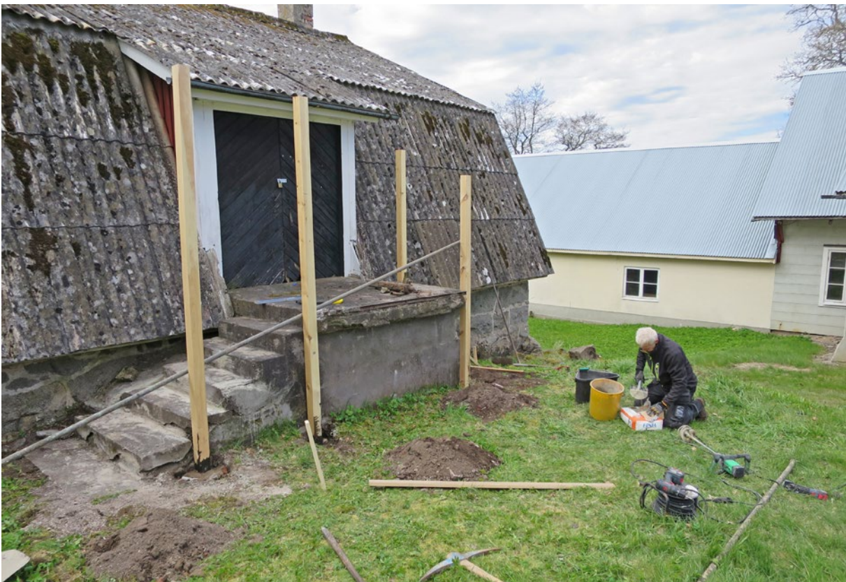
Upplagning av trappa och montering av nya stolpar.
