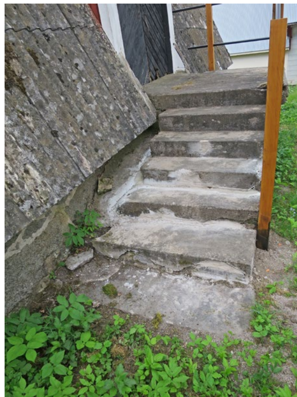
Trappan mot norr efter åtgärder.
