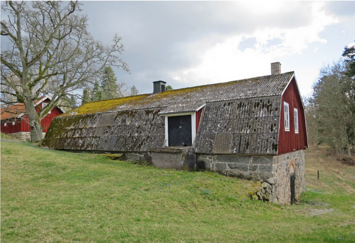
Mältans nordvästra fasader med yttre ingången före åtgärder.
