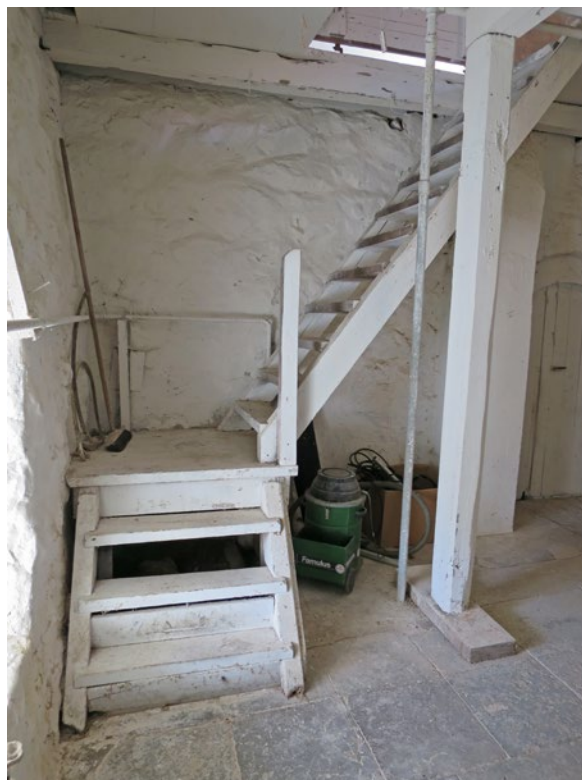
Inre trappan före ny ledstång monterades, nerifrån.
