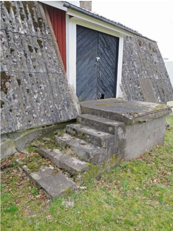
Yttre ingången mot norr före åtgärder.
