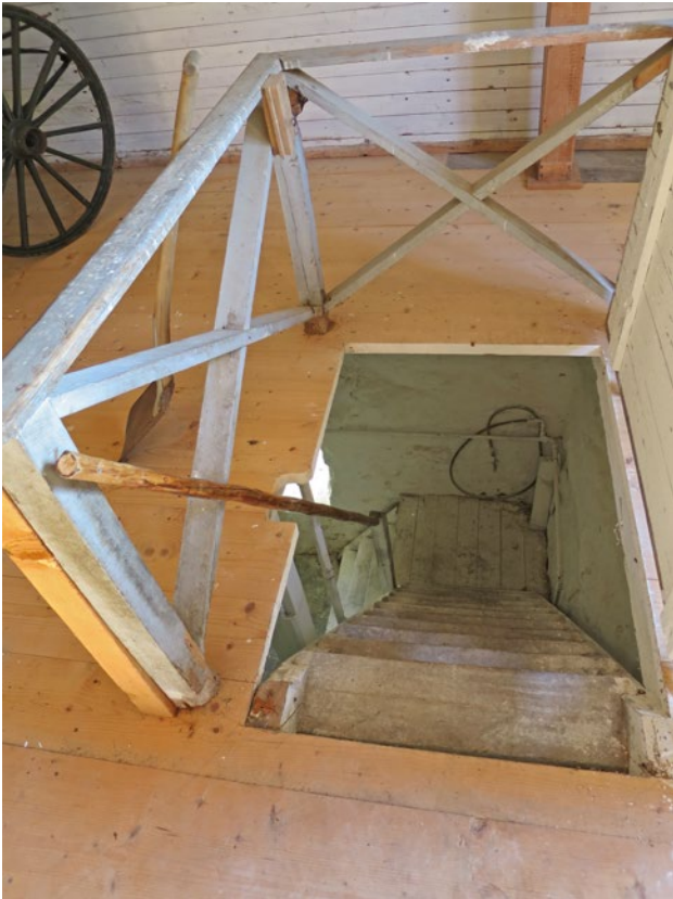
Inre trappan efter att ny ledstång monterades, uppifrån.
