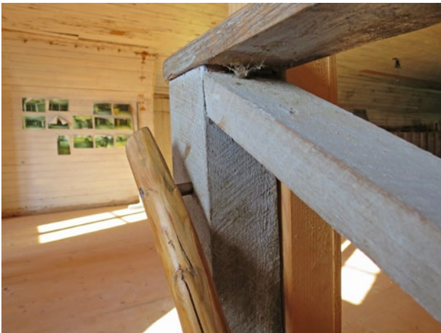
Ledstången av en granslana monterades på distanser.
