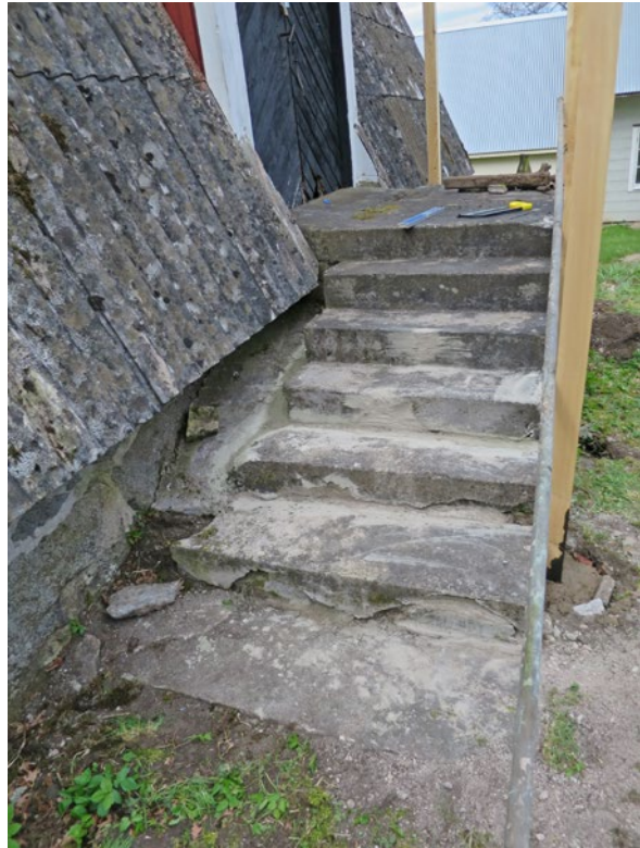
Upplagning av trappa och montering av nya stolpar.
