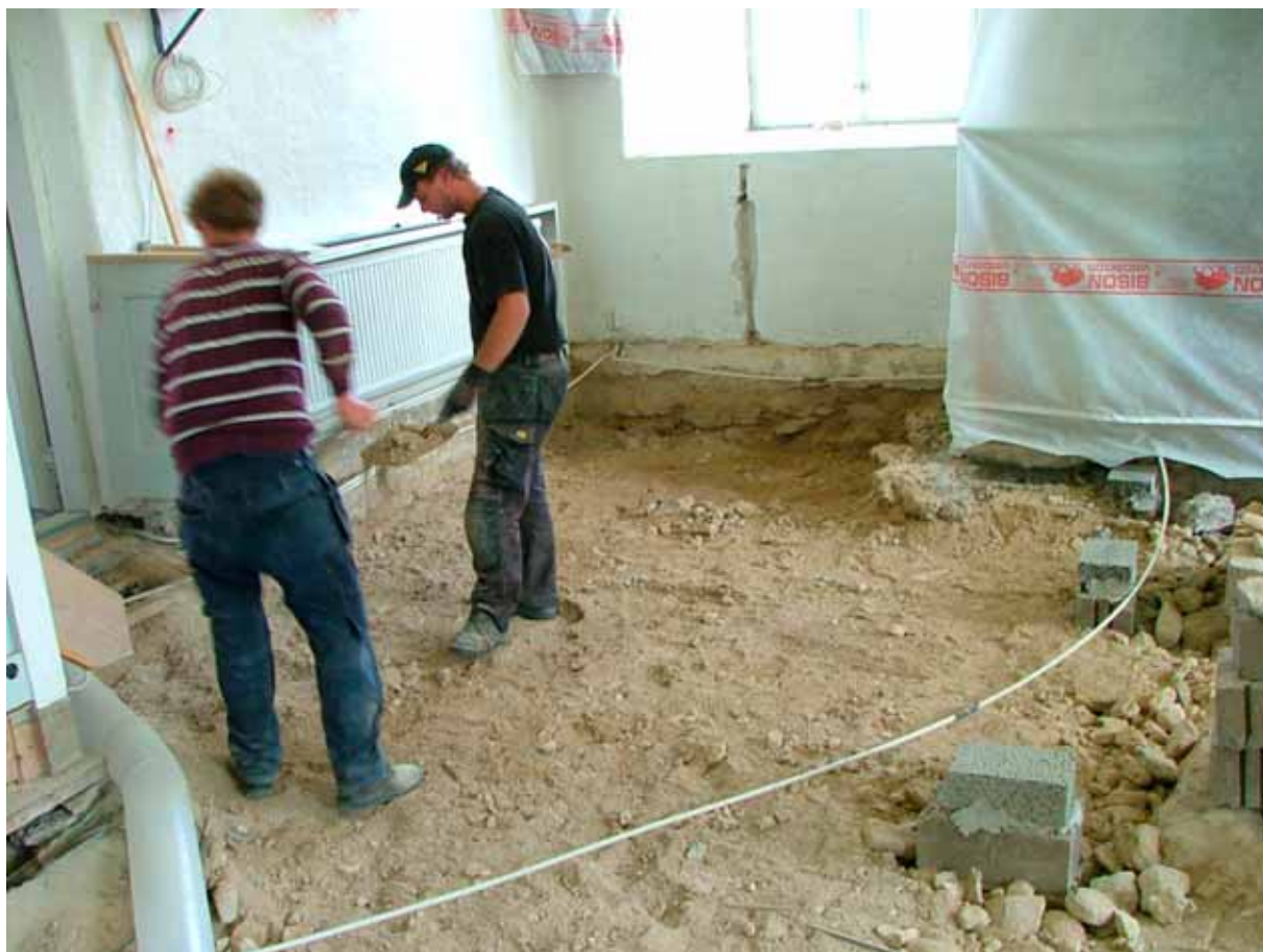
Fig 4. Platsen efter borttagandet av de lösa massorna. På plintarna till höger i bild skall den nya golvkonstruktionen vila på.
