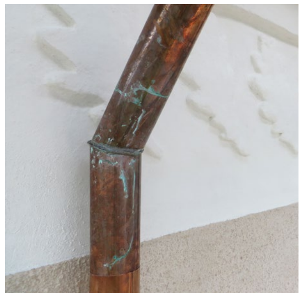
Detaljbild på stuprör på tornet.
