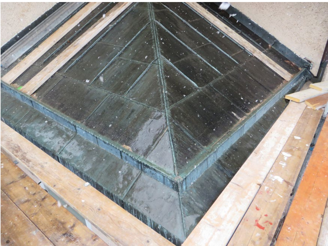
Ena körtillbyggnadens tak före åtgärd.
