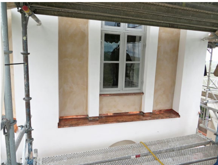
Lanterninen efter åtgärd.
