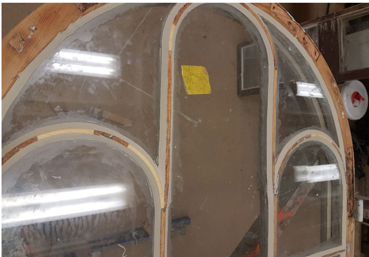
Delar av ett av långhusets fönsterbågar under pågående åtgärd. Delar av bågen har lagats med nytt virke. Foto: Staffan Bergström.
