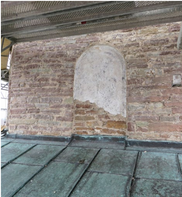
Lanterninen under pågående åtgärd. Delar av putsen på stolparna hade god vidhäftning och togs därför inte bort.
