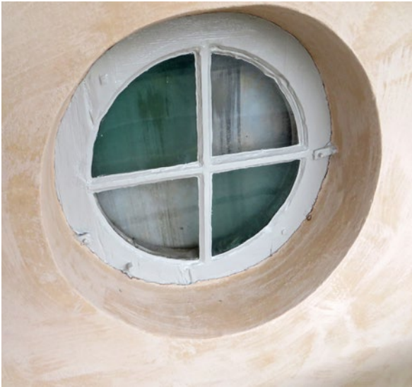
Ett av lanterninens små, runda fönster efter åtgärd.
