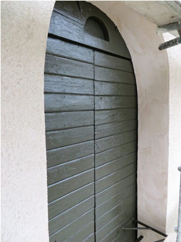
En av tornets ljudluckor efter åtgärd. Luckan har fått en brungrön kulör.
