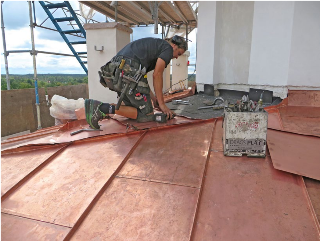
Delar av torntaket under pågående åtgärd. Ny kopparplåt har lagts på delar av torntaket.
