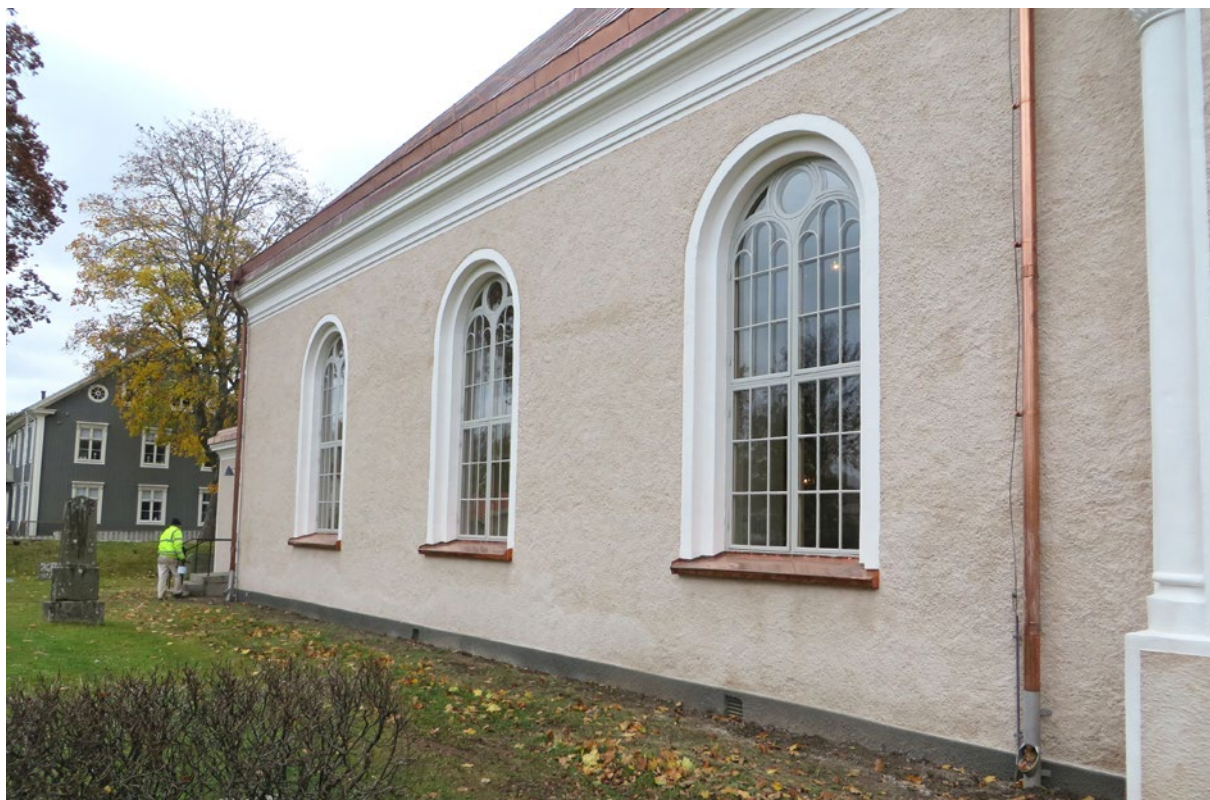
Del av norra fasaden efter renovering.
