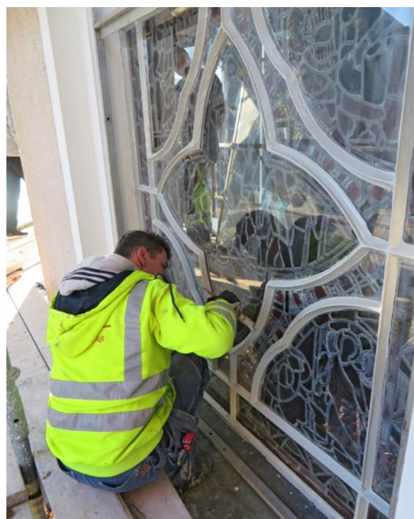
Delar av korets ena blyinfattade fönster under pågående åtgärd.
