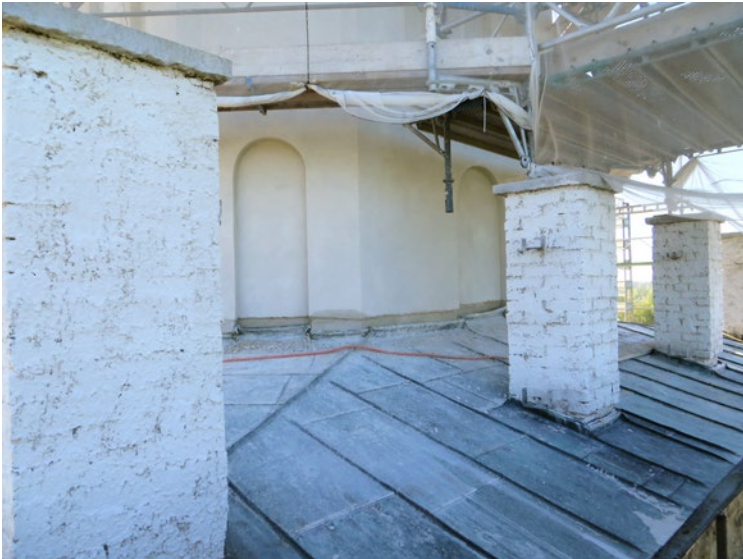
Lanterninen under pågående åtgärd. Stolparna runt lanterninen har här fått ett påslag utsockningsbruk.
