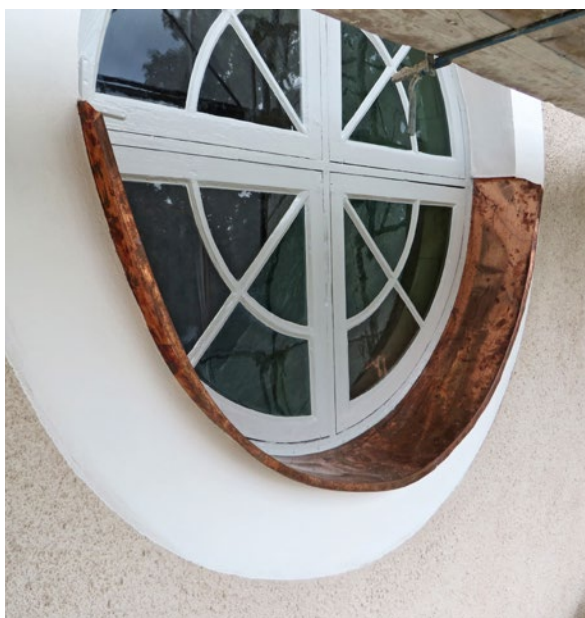
Delar av tornet ena runda fönster efter åtgärd.
