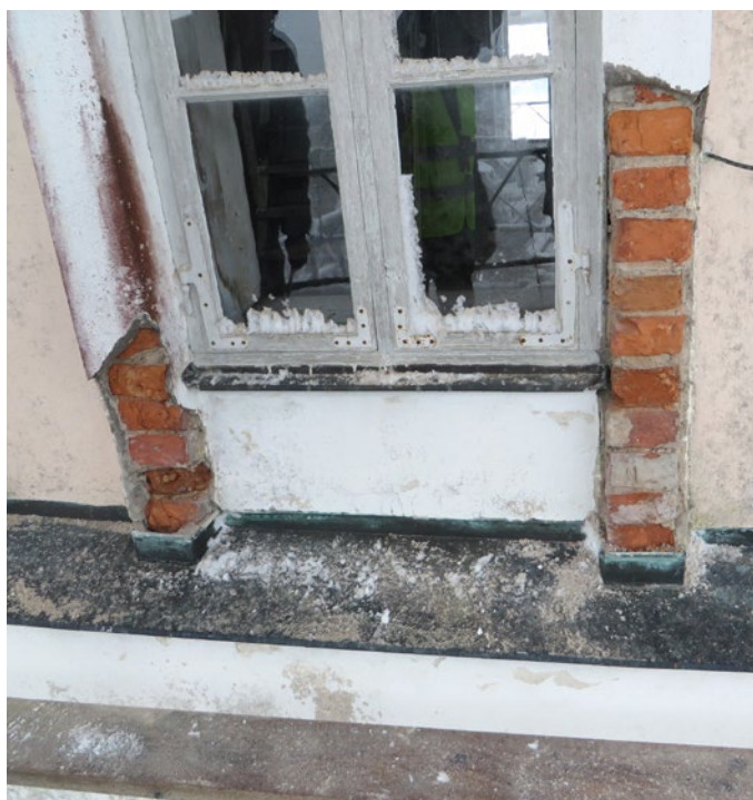
Lanterninen före åtgärd. Exempel på putsskador vid ett av fönstren respektive lanterninens hörn.
