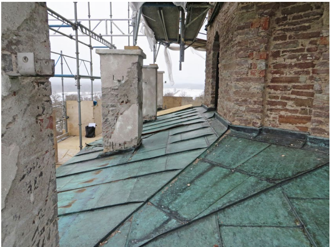
Delar av torntaket före åtgärd.
