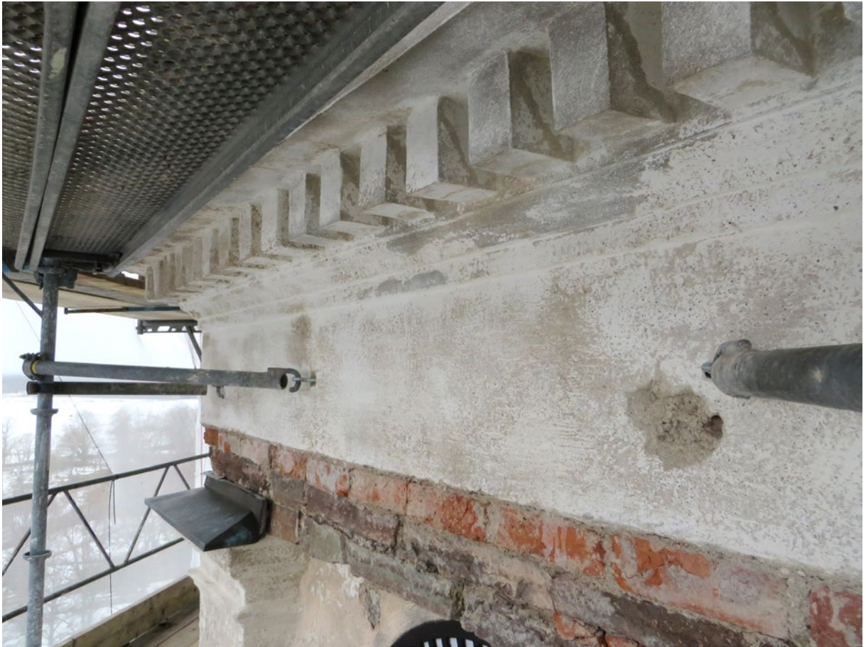
Lanterninen under pågående åtgärd. Tandfrisen sparades i största möjliga mån.
