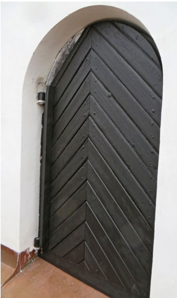
Lanterninens trädörr före åtgärd. Trädörren har målats med svart linoljefärg.
