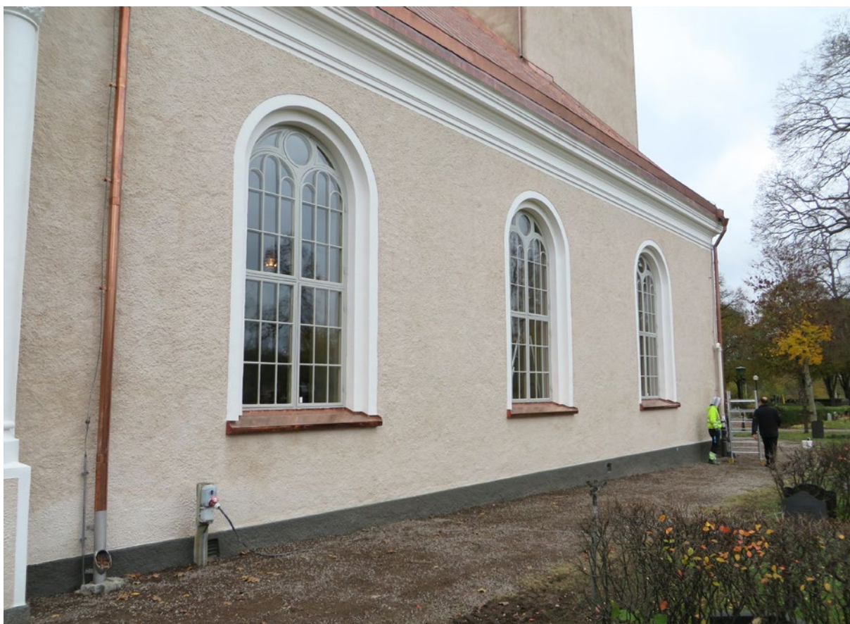
Tre av norra fasadens stora, rundbågiga fönster efter åtgärd.
