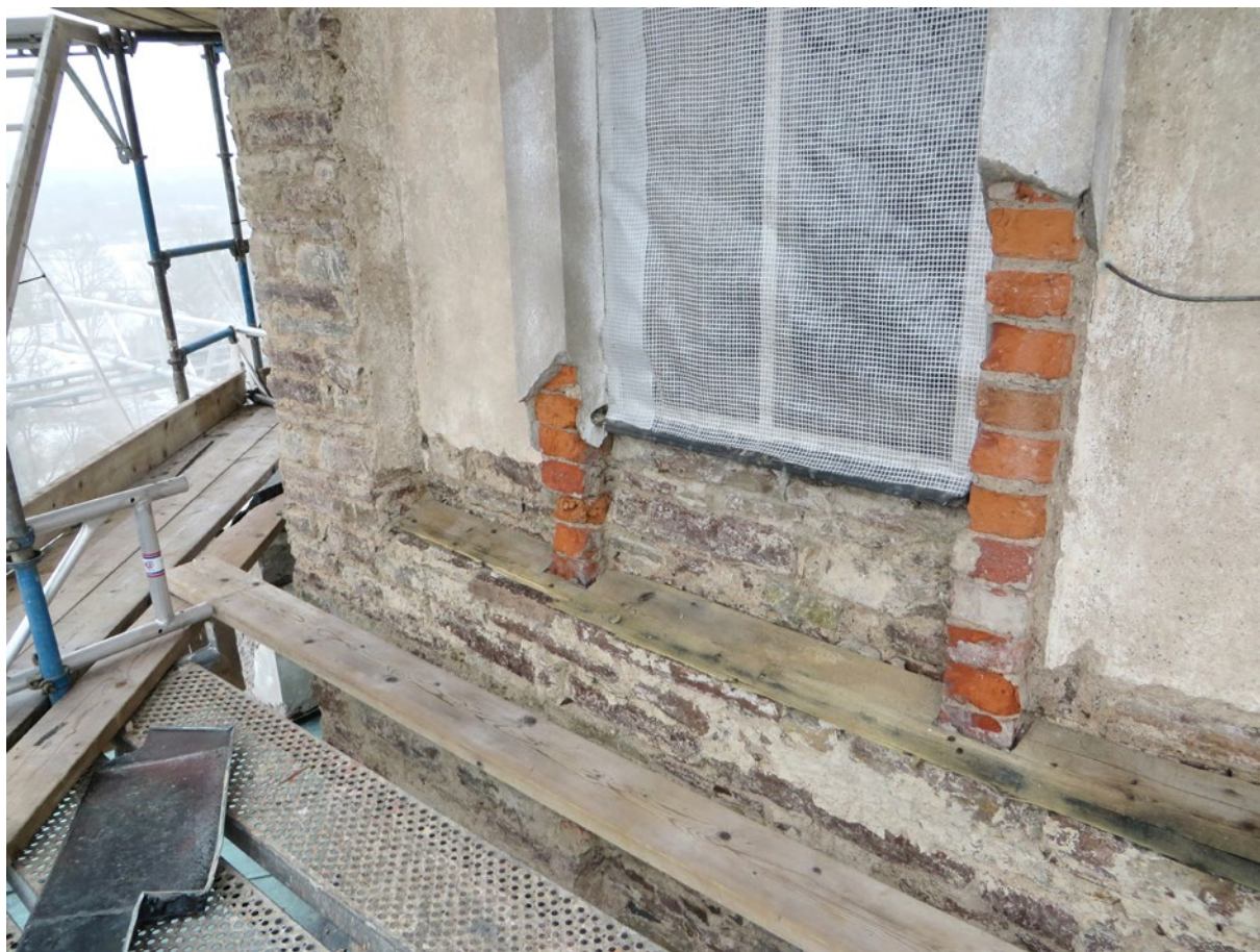
Lanterninen under pågående åtgärd. Lös puts har knackats ner och ytorna har blästrats. Vissa delar av den äldre putsen sparas.
