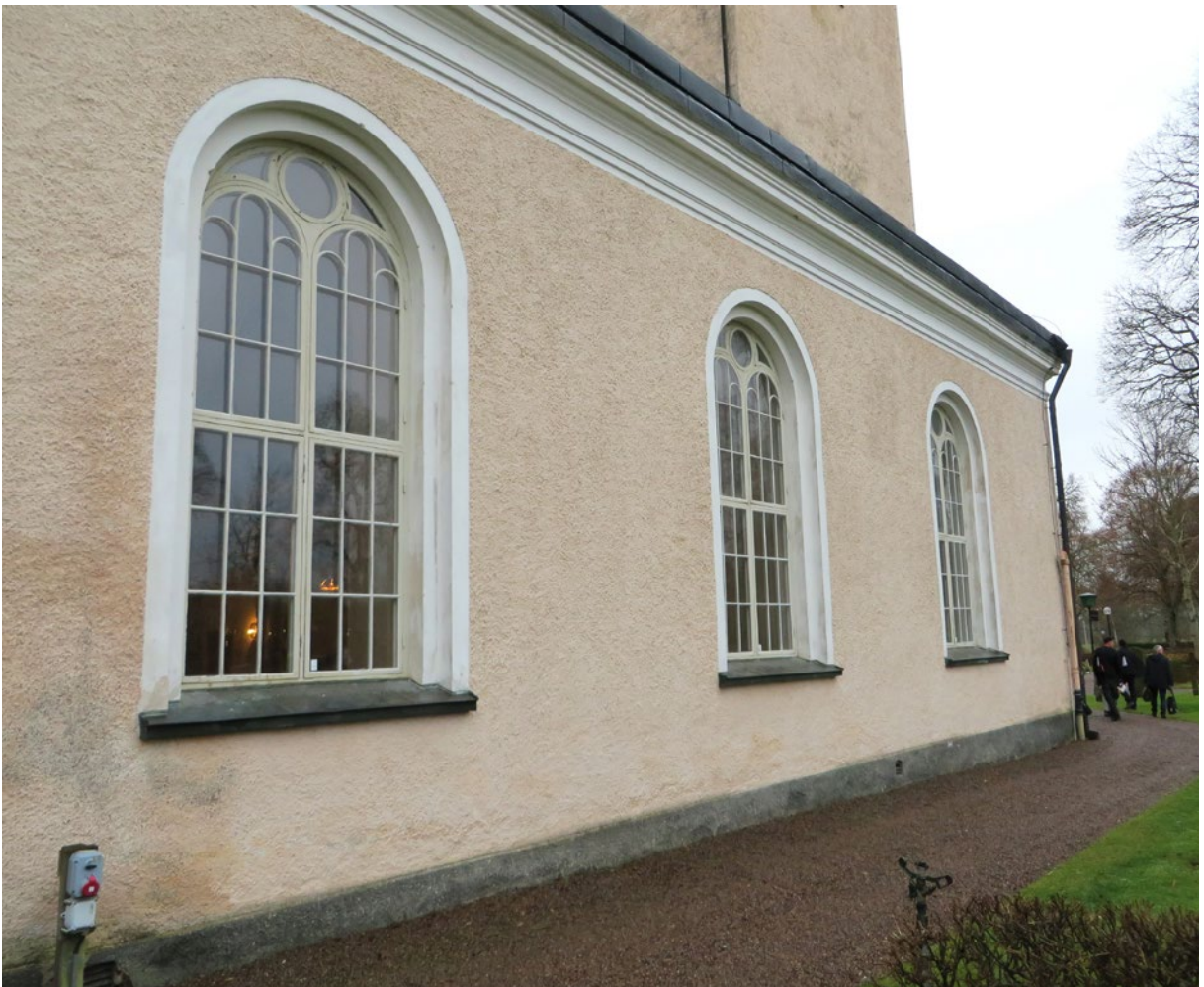
Tre av norra fasadens stora, rundbågiga fönster före åtgärd.
