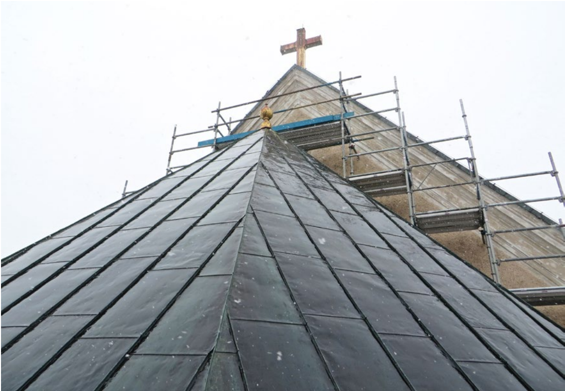
Delar av körtaket före åtgärd.
