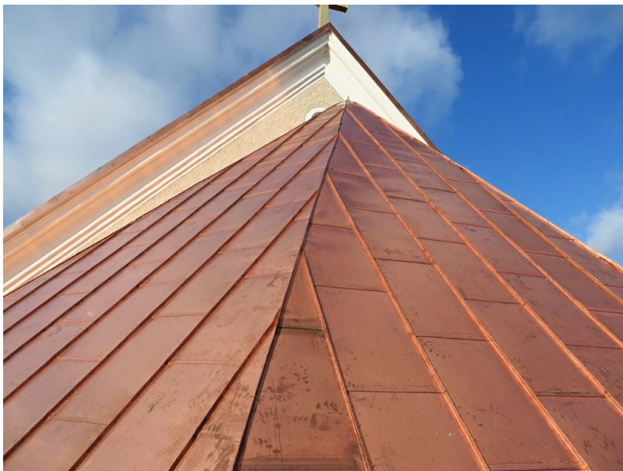
Delar av kortaket efter åtgärd.
