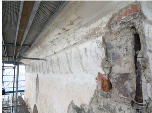
Under pågående åtgärd. Efter blästring hade delar av eklövsfrisen försvunnit, men stora delar kunde sparas.
