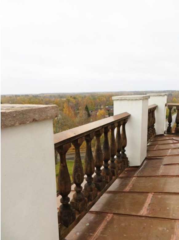
Lanterninen efter åtgärd. Stolparna har lagats och avfärgats med KEIM Purkristalat.
