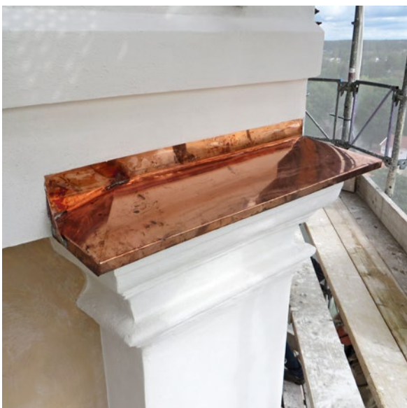
Detaljbild på bleck över pilastrarna på lanterninen.
