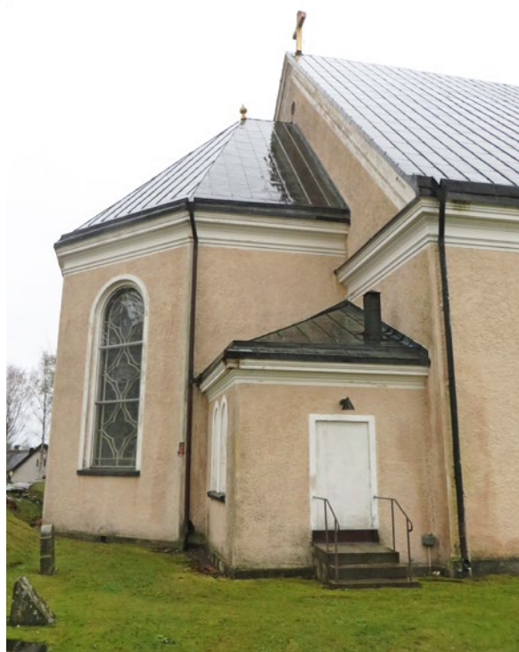
Norra delen av koret före åtgärd.
