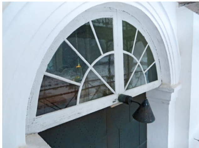
Överljuset som sitter ovanför porten i väster före åtgärd.
