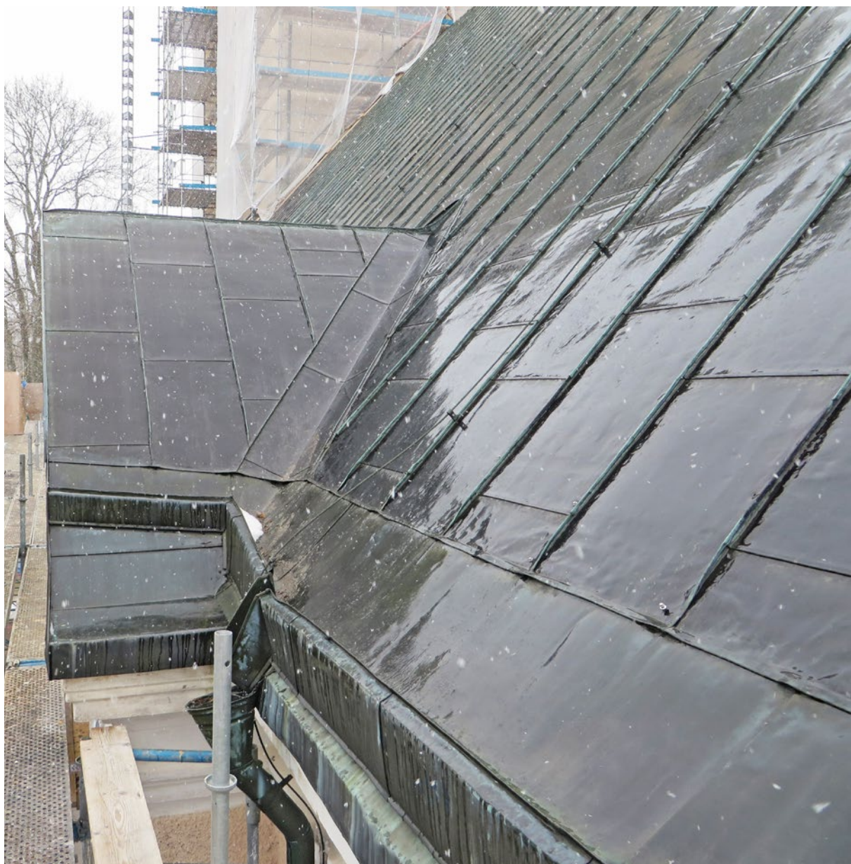
Sydportalens tak före åtgärd.
