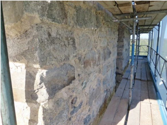
Tornet under pågående åtgärd. Del av tornets norra sida efter att den frilagt från gammal puts.
