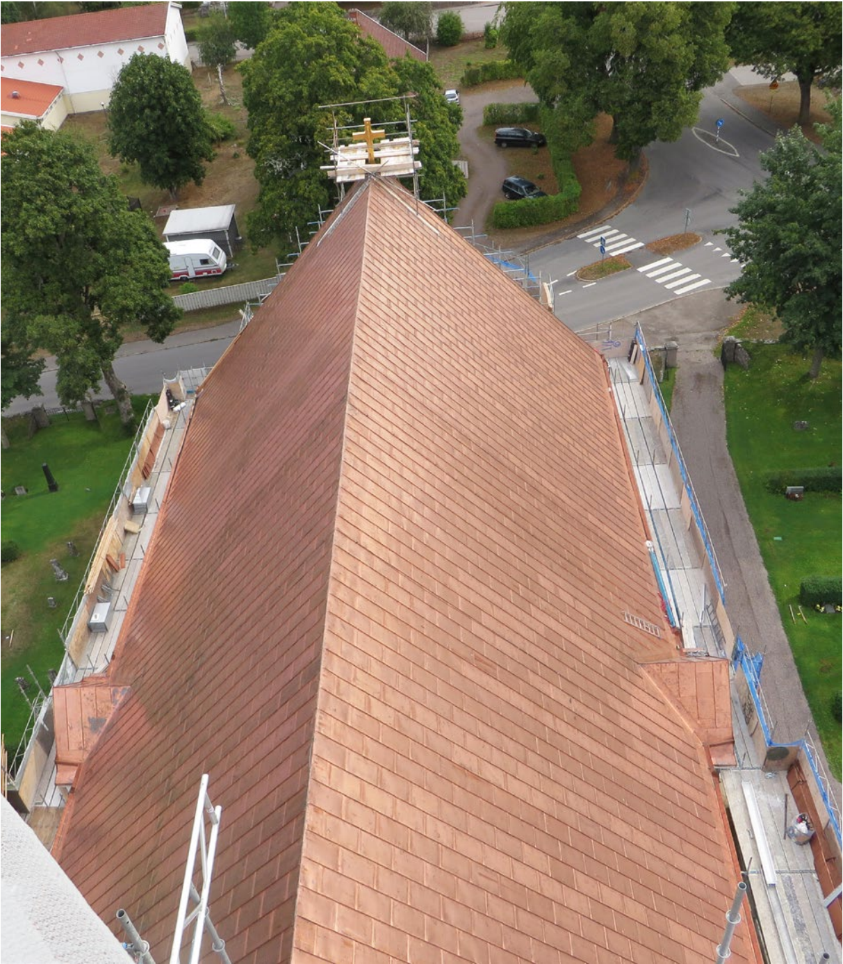
Långhustaket efter åtgärd.
