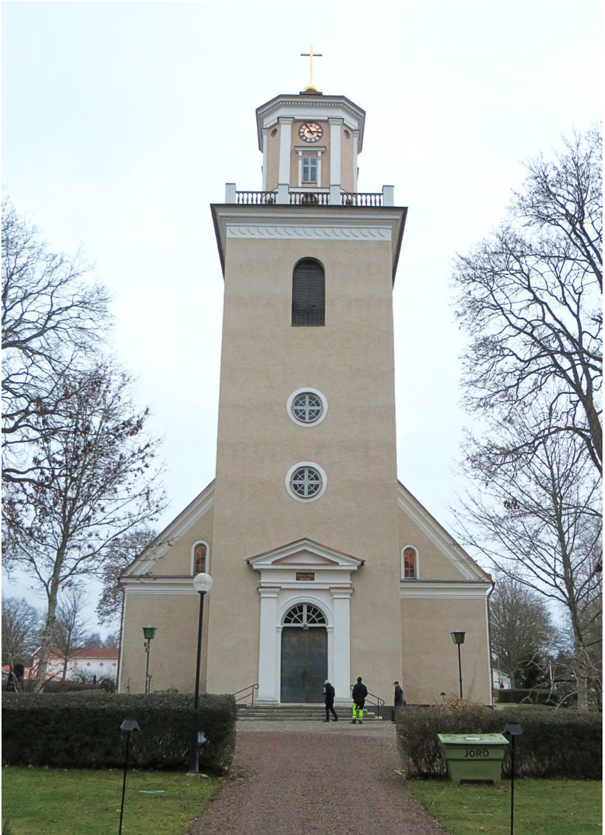
Tornet efter åtgärd.
