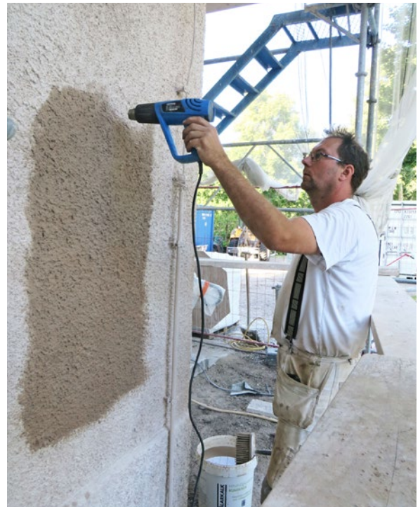
Tornet under pågående åtgärd. Här pågår lagning av eklövsfrisen. Resterande ytor har fått ett påslag med utsockningsbruk.
