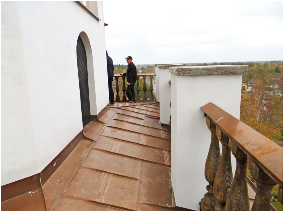
Delar av torntaket efter åtgärd.
