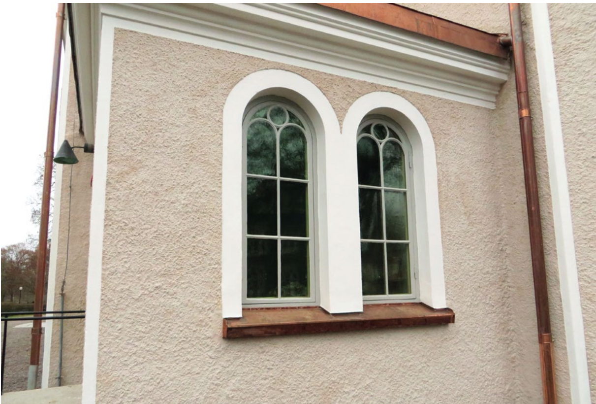
Fönsterparti på kortillbyggnad efter renovering.
