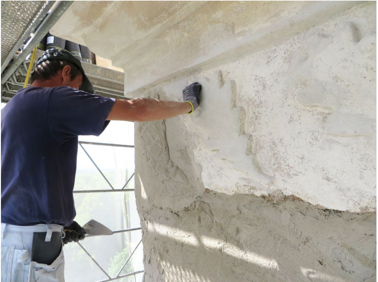
Tornet under pågående åtgärd. Här pågår lagning av eklövsfrisen. Resterande ytor har fått ett påslag med utsockningsbruk.
