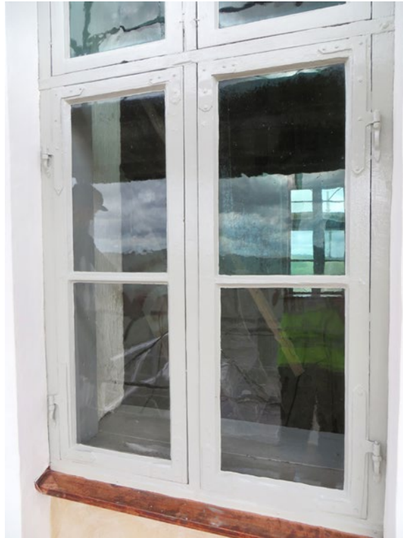
Ett av lanterninens korspostfönster efter åtgärd.
