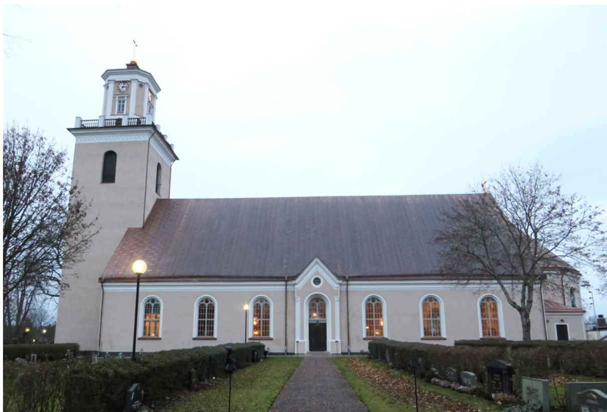
Kyrkan från söder efter renovering.
