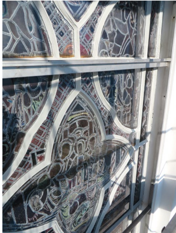
Delar av korets ena blyinfattade fönster efter åtgärd.
