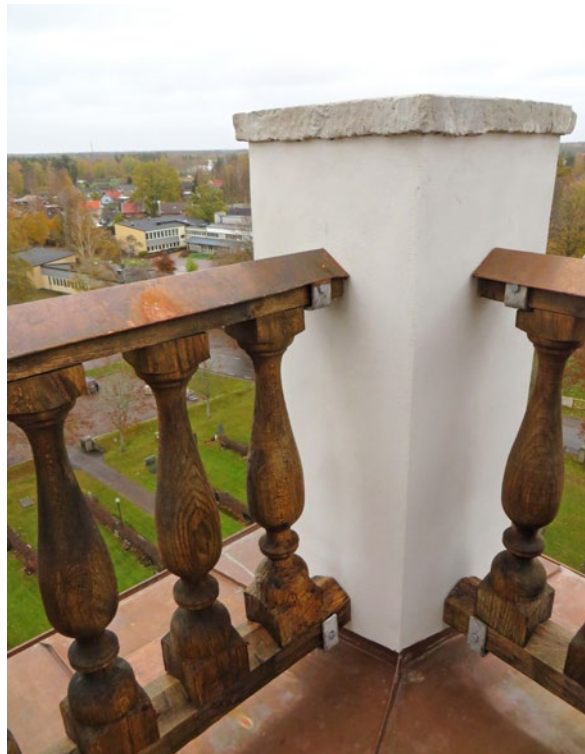
Delar av lanterninräcket efter åtgärd. Räcket har rengjorts och behandlats med olja.
