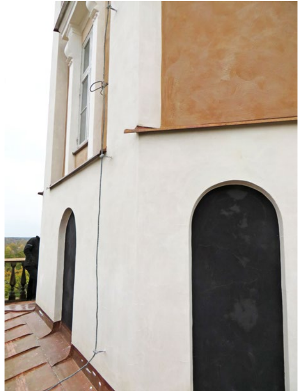
Lanterninen efter åtgärd. Blindluckorna har avfärgats med KEIM Purkristalat.
