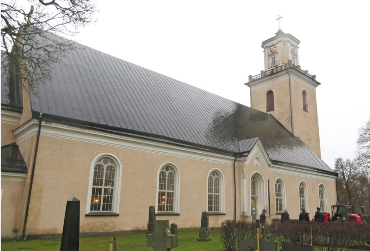
Norra fasaden av långhuset före åtgärd.
