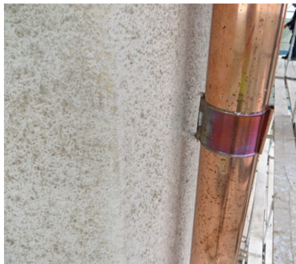
Tornet efter åtgärd. Tornets spritputsade fasad har avfärgats.
