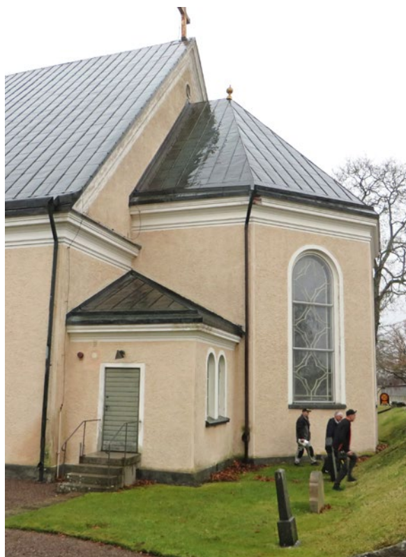
Södra delen av koret före åtgärd.
