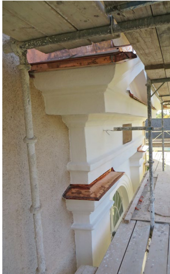
Tornet efter åtgärd. Delar av portalen kring porten mot väster.
