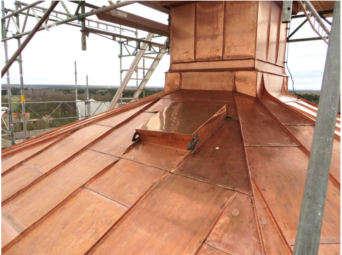
Delar av lanternintaket efter åtgärd.
