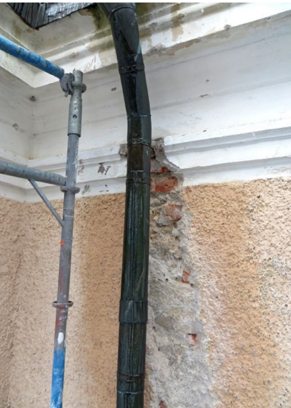
Koret före åtgärd. Spricka i ovankant på ett av korfönstren.
