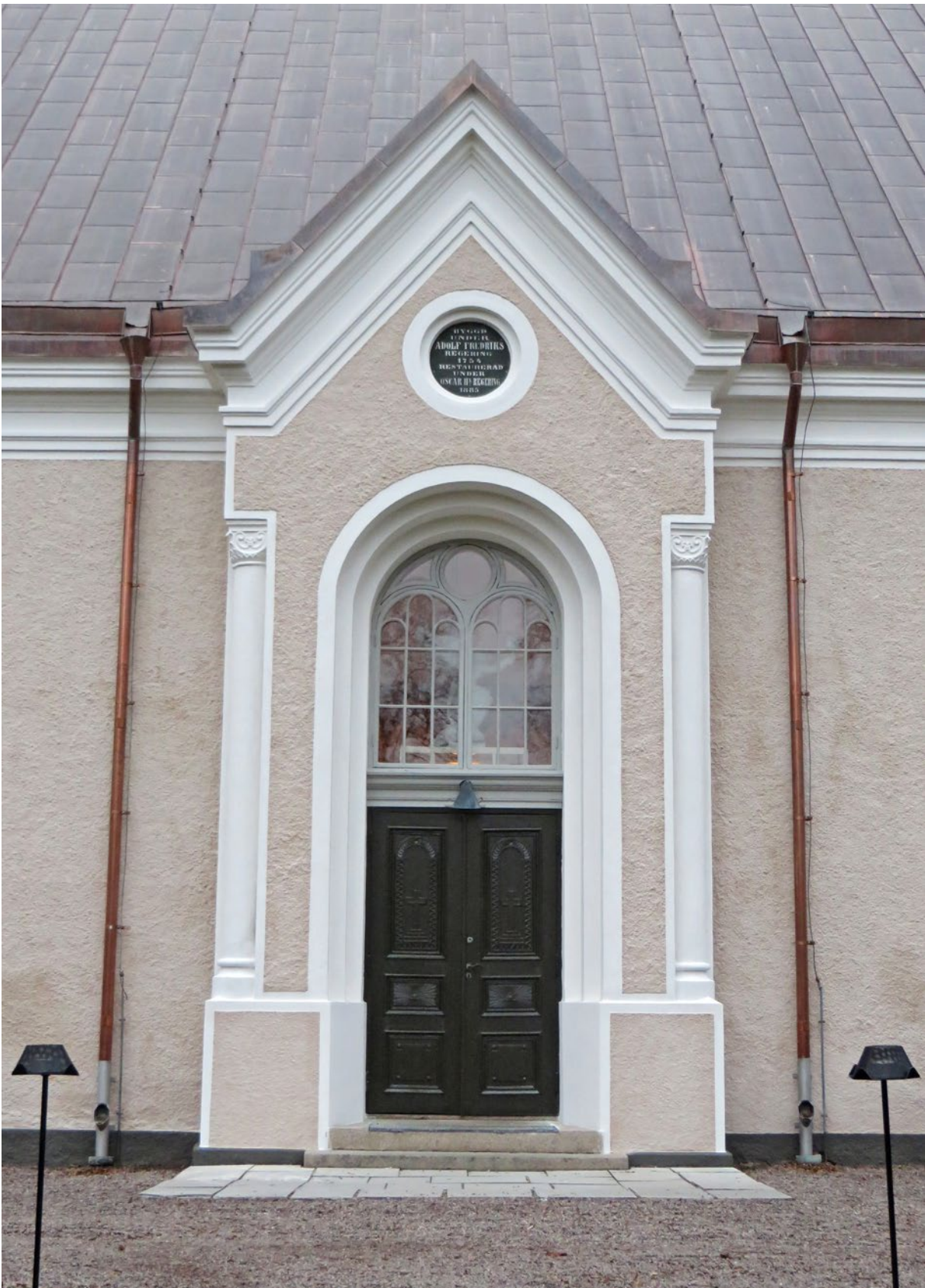
Södra entrén efter renovering.
