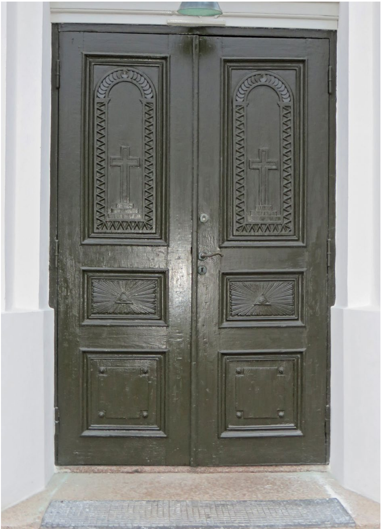
Södra entrén efter renovering.
