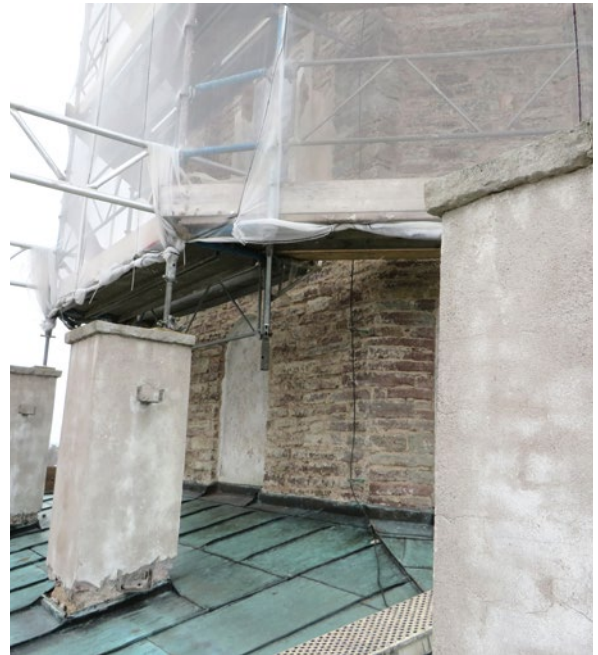
Lanterninen under pågående åtgärd. Delar av putsen på stolparna hade god vidhäftning och togs därför inte bort.
