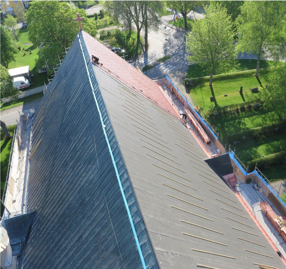
Långhustaket under pågående åtgärd. På södra takfallet har den gamla kopparplåten demonterats, takfallet har fått ny papp och ny kopparplåt har börjat läggas.
