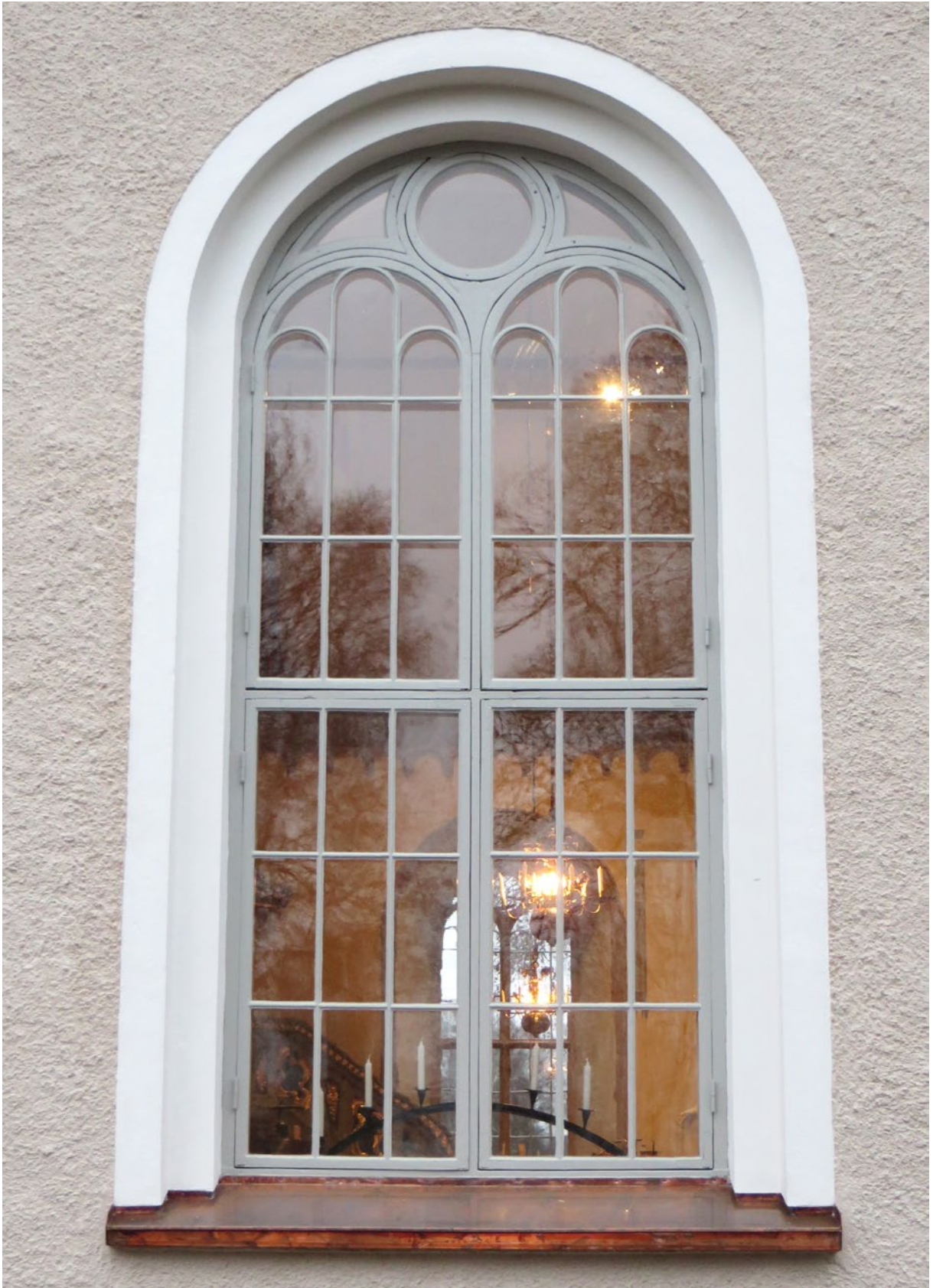
Fönster på södra långhusfasaden efter renovering.
