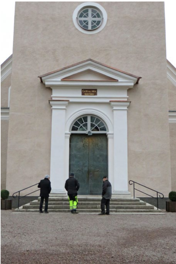
Tornet efter åtgärd.
