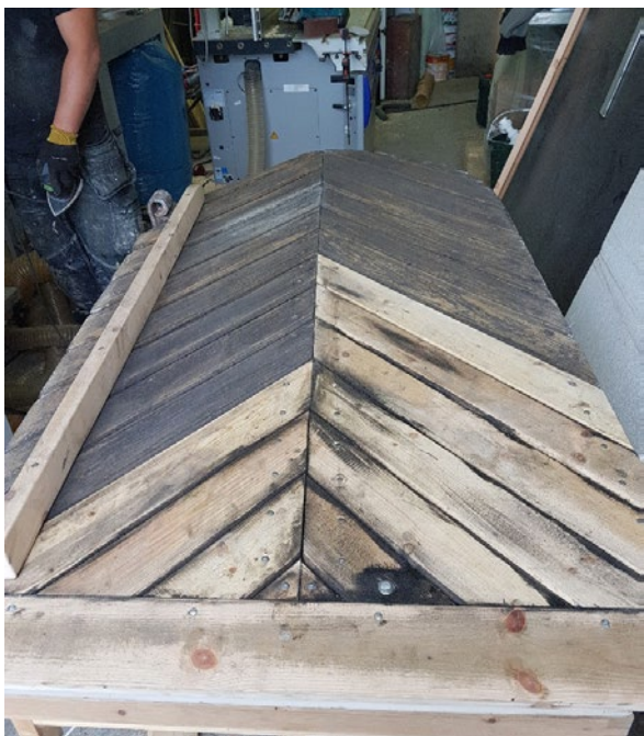
Lanterninens trädörr under pågående åtgärd. Delar av trädörrens virke har fått bytas ut. Foto: Staffan Bergström.
