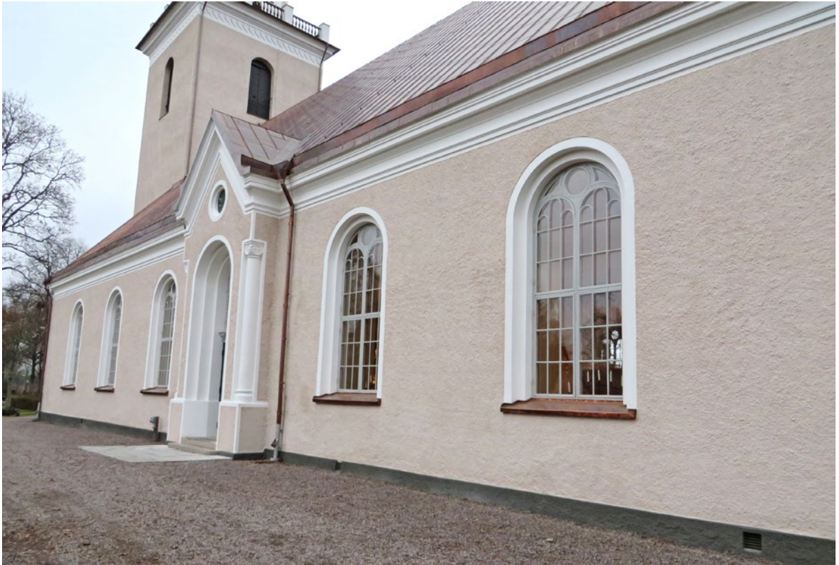
Kyrkans södra fasad efter renovering.
