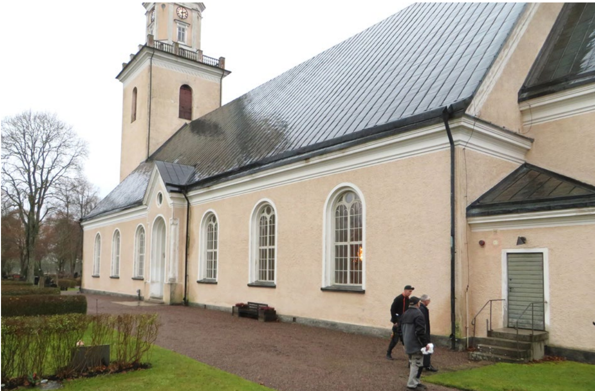
Södra fasaden av långhuset före åtgärd.
