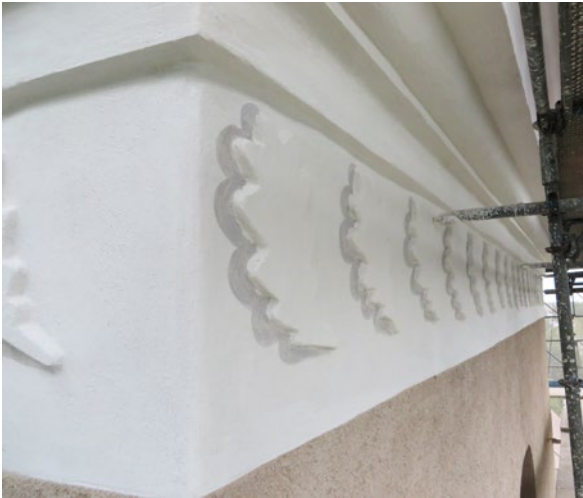
Tornet efter åtgärd. Eklöven på frisen har återfått en skugga på ena sidan.
