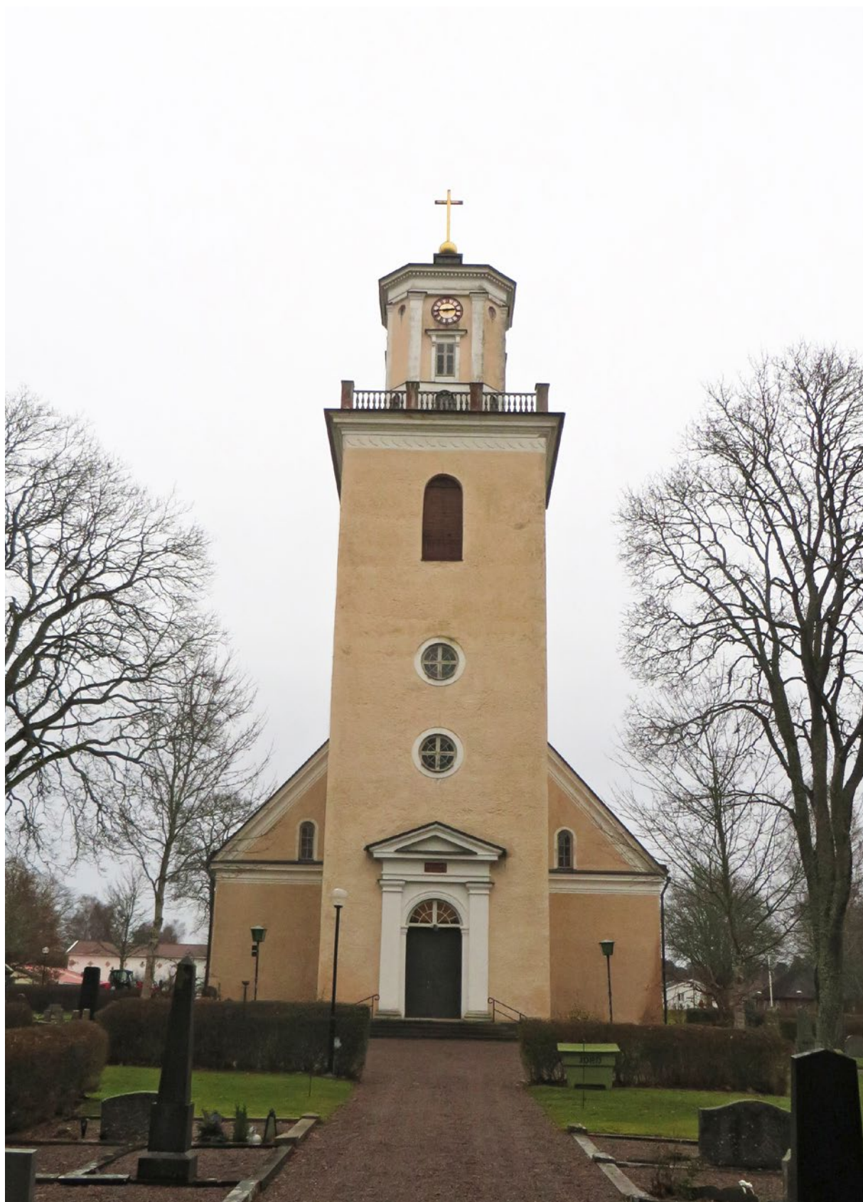
Tornet före åtgärd.
