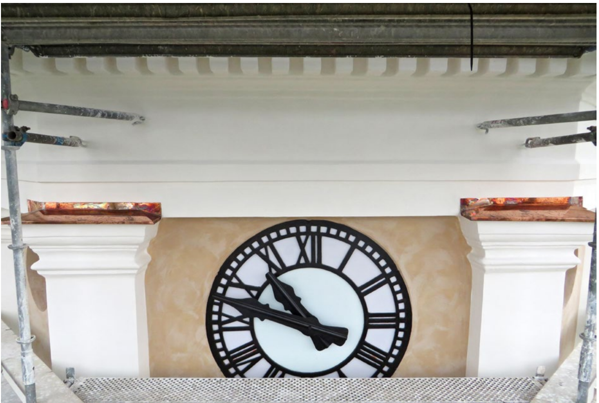
Lanterninen efter åtgärd. Tandfrisen och delar av fasaden.
