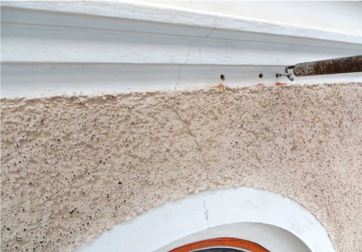
Koret före åtgärd. Spricka i ovankant på ett av korfönstren.
