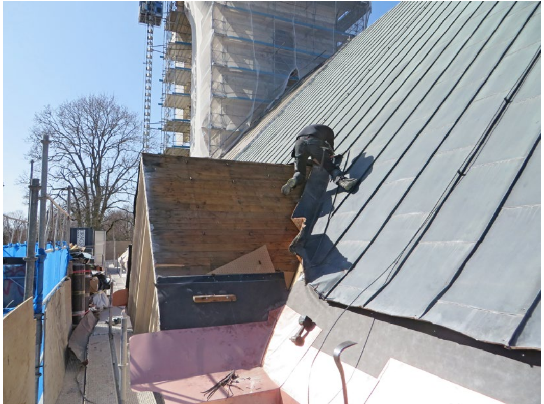
Sydportalens tak under pågående åtgärd. Den gamla kopparplåten har demonterats.
