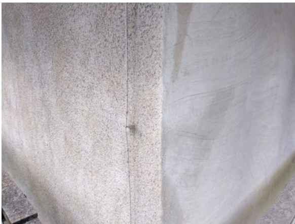
Tornet under pågående åtgärd. Delar av tornets fasader har spritputsats.
