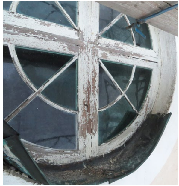
Delar av tornets ena runda fönster före åtgärd.
