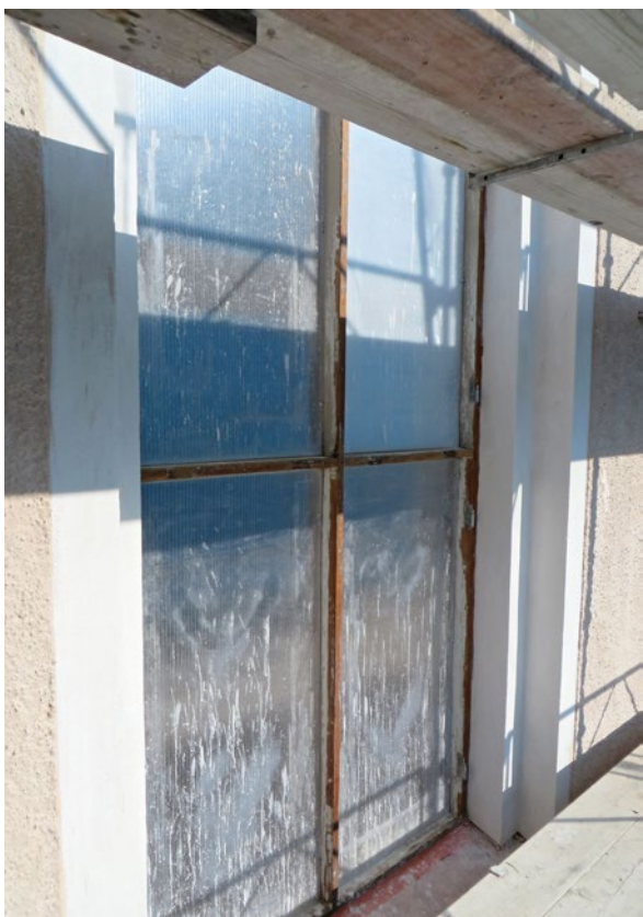
Delar av en av långhusets fönsterkarmar under pågående åtgärd. Karmen har skrapats ren från lös färg och väntar på att få några nya lager linoljefärg.
