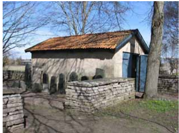
Förrådsbyggnad på nordvästra delen av kyrkogården. (Mörbylånga kyrkog 135)
