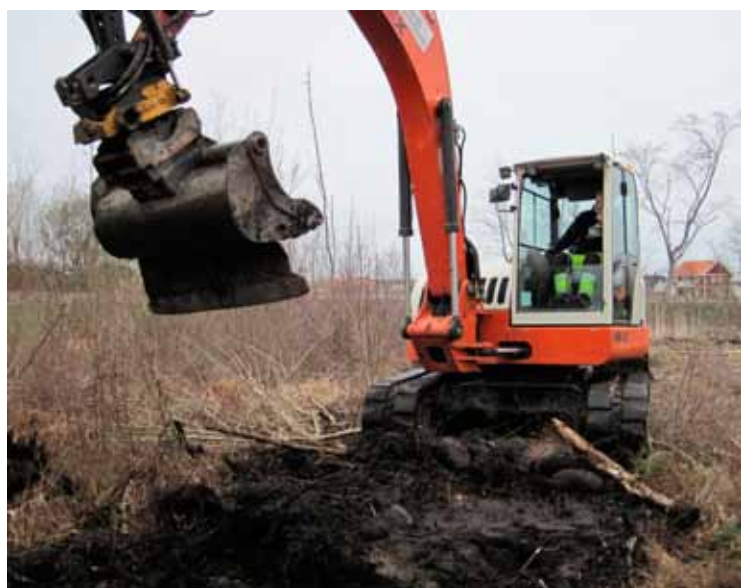
Fig.5. Den steniga och blockrika terrängen knäckte grävskopan. Bokstavligt talat. Foto: Ulrika Söderström, KLM.
