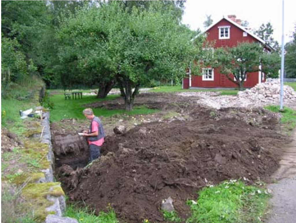
Dokumentation av fördämningsvallen. Mot huset ses den färdigställda delen av fiskvägen. Foto mot nordväst/Mattias Persson, Ist Kalmar.
