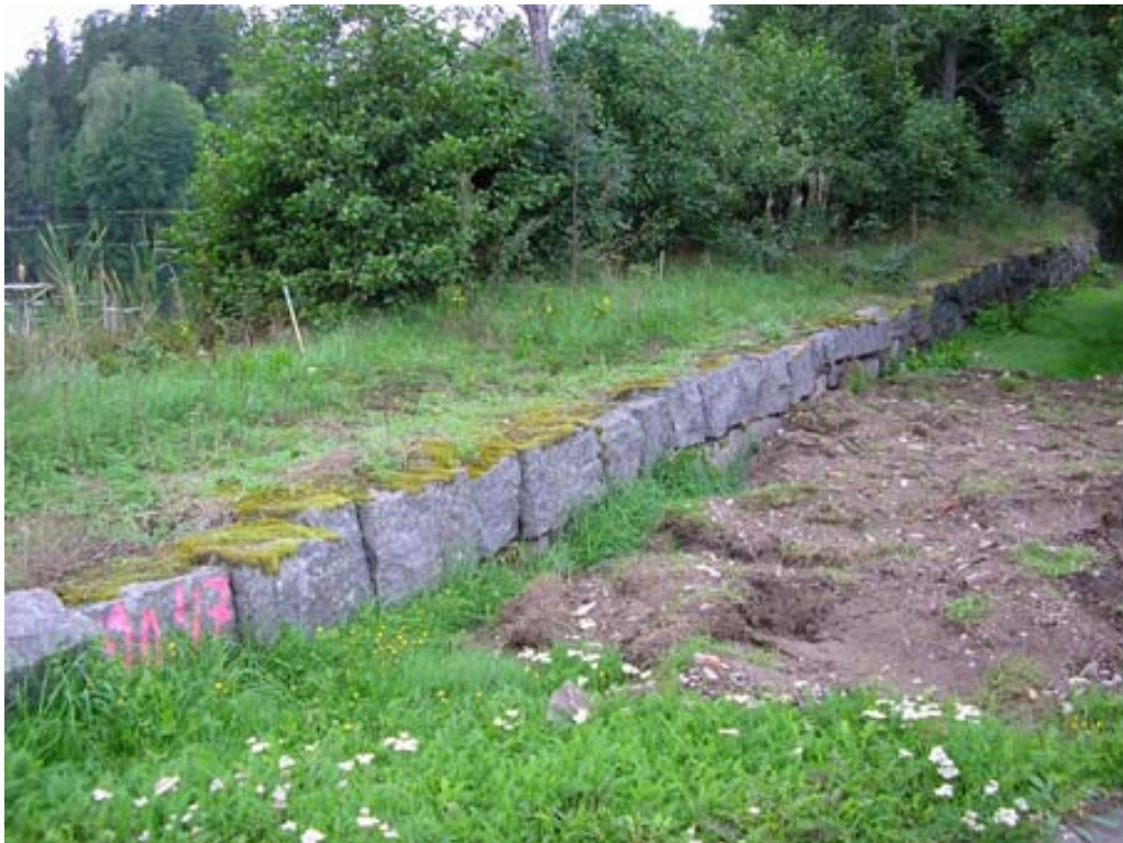
Fördämningsvallens inre stenskonung före schaktning. Foto mot väster/Mattias Persson, Ist Kalmar.
