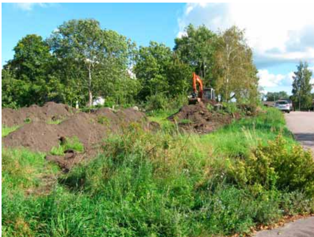
Schaktning pågår, förundersökning på Tings Ene I:1 i september 2007. Foto Ludvig Papmehl-Dufay / Kalmar läns museum.
