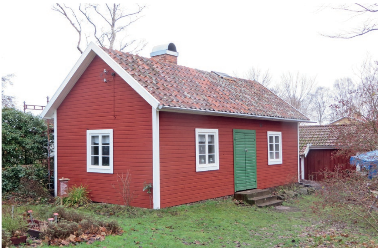
Brygghuset sett från nordväst efter åtgärd.
