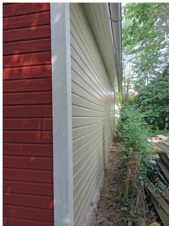
Brygghusets östra fasad efter åtgärd.
