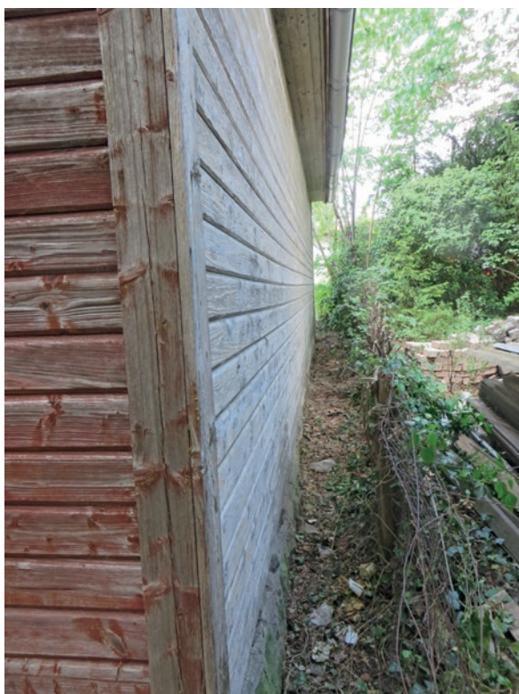
Brygghusets östra fasad efter att marknivån kring huset sänkts.
