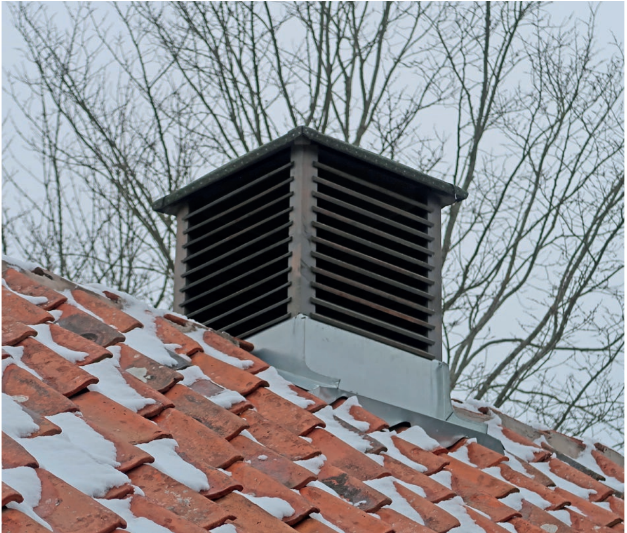
Ventilationshuven efter åtgärd.
