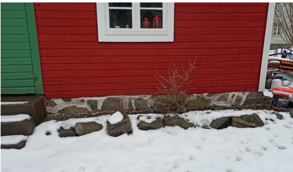
Sydvästra delen av brygghusets stensockel efter åtgärd. Sockeln har fått nya fogar av hydrauliskt kalkbruk.
