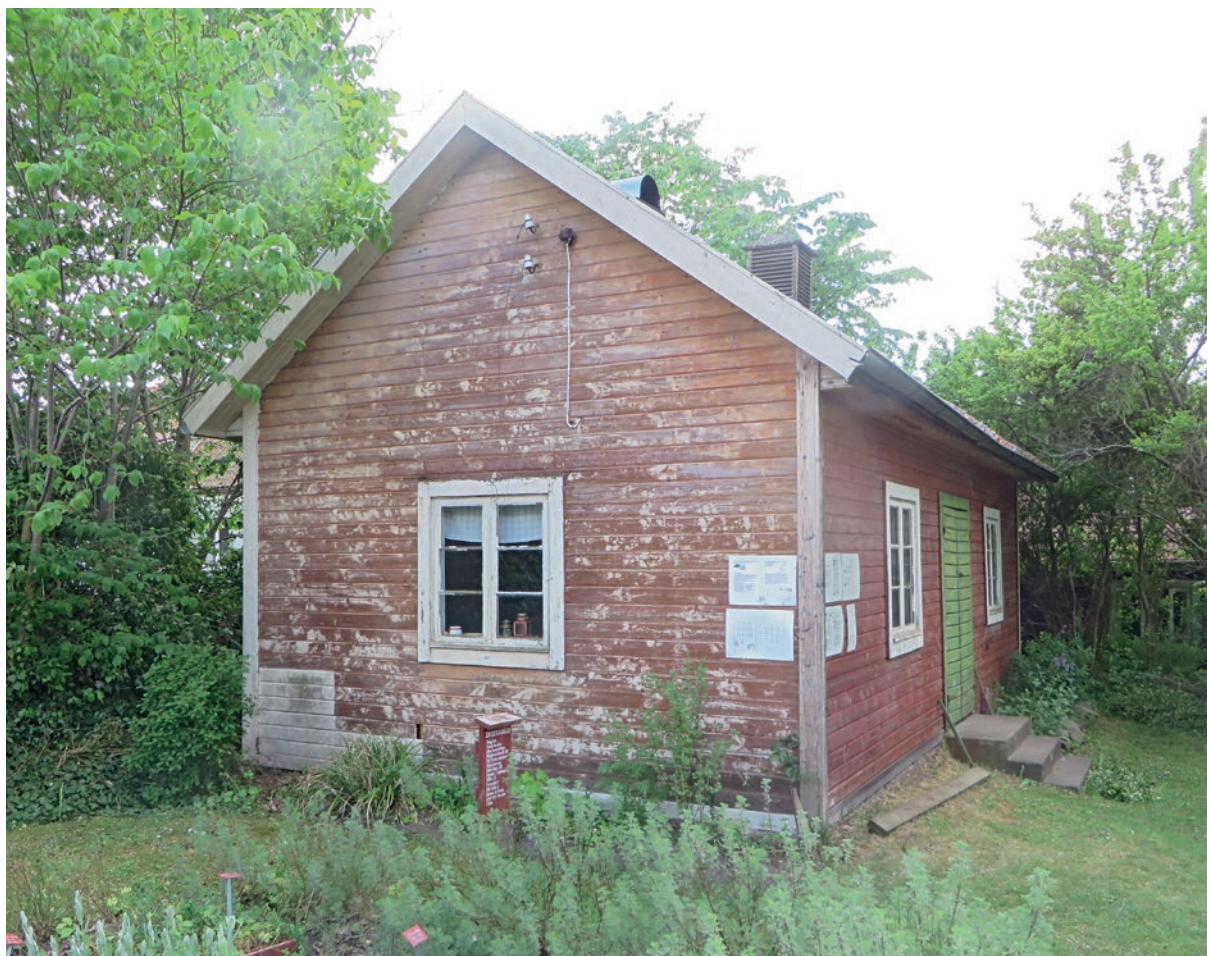
Brygghuset sett från nordväst efter att marknivån kring huset sänkts. Notera de utbytta panelbrädorna på norra gavelns nedre, östra hörn.
