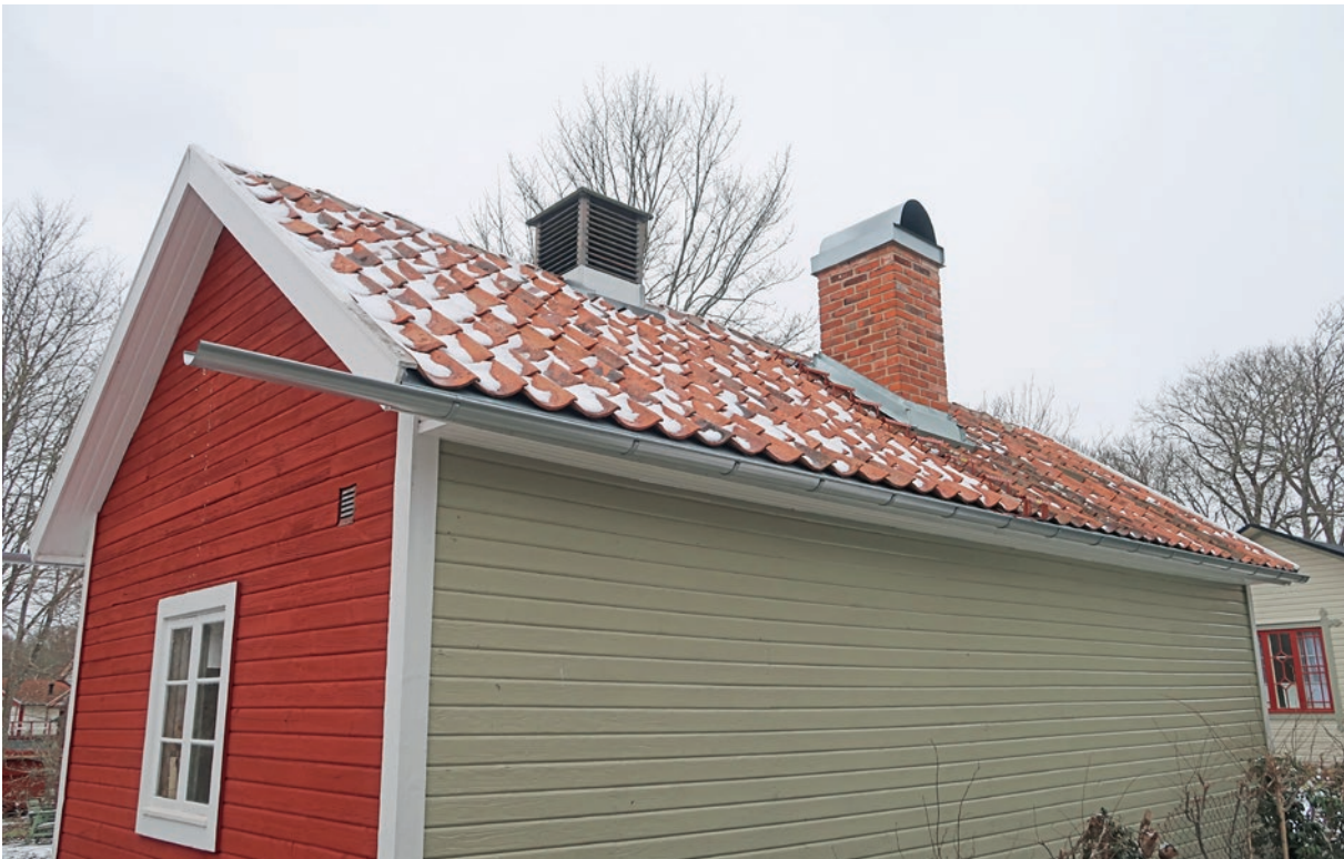
Östra takfallet efter åtgärd. Notera takstegen som monterats söder om skorstenen. Den östra hänggränsen, vid det sydöstra hörnet har förlängts ett par decimeter.
