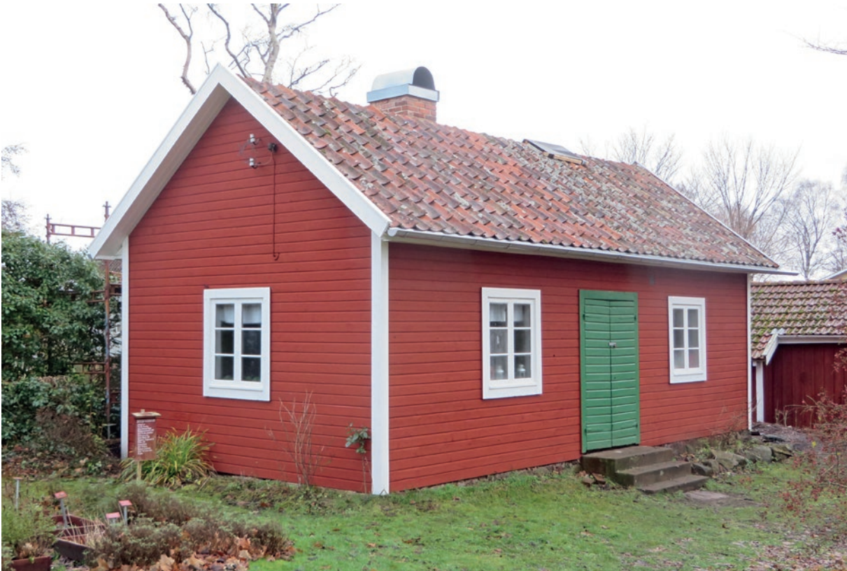
Västra takfallet efter åtgärd.
