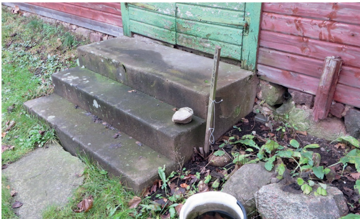
Närbild av trappan mot väster. På bilden syns även byggnadens stensockel. En stor del av fogbruket har fallit bort.
