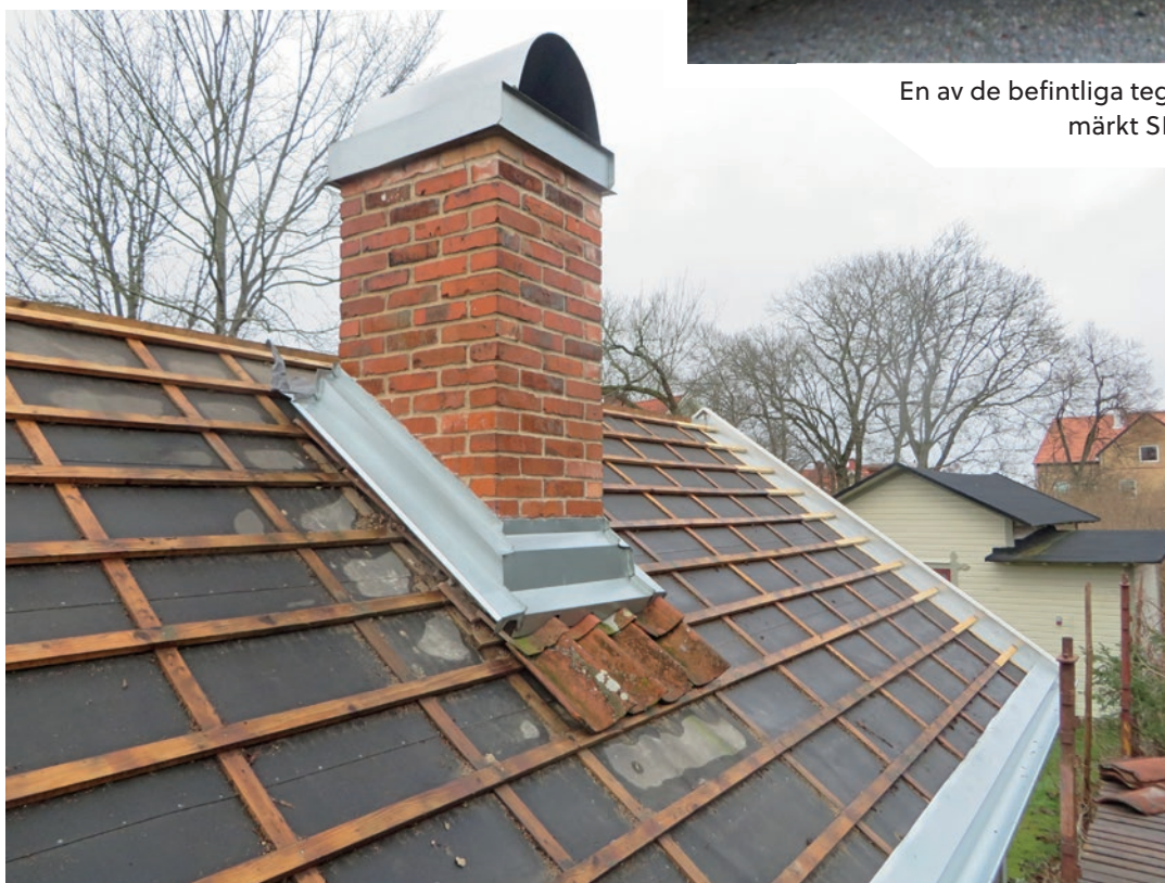
Del av östra takfallet under pågående åtgärd. Här har ny papp samt bär- och ströläkt monterats.
