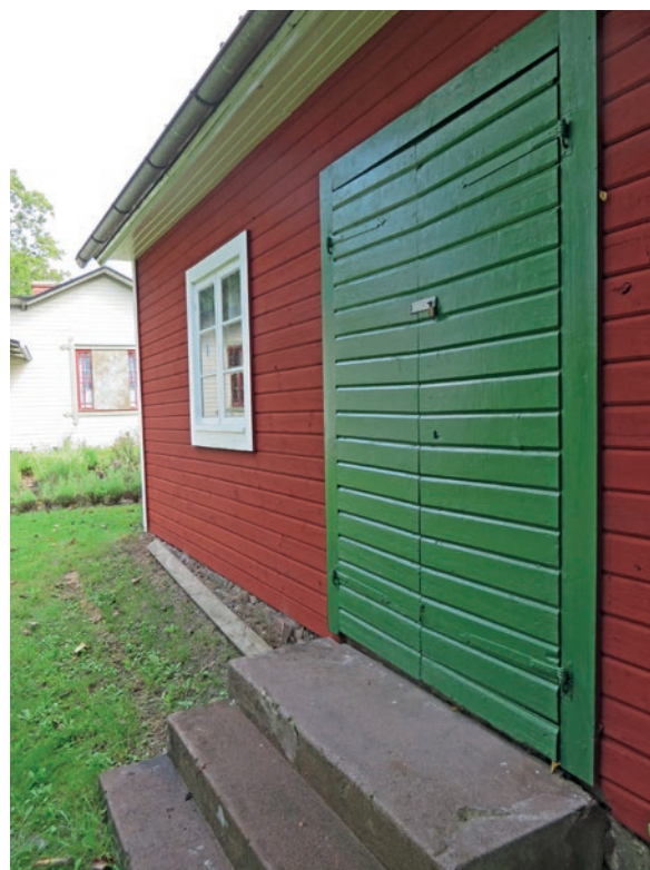
Pardörren på brygghuset efter åtgärd.
