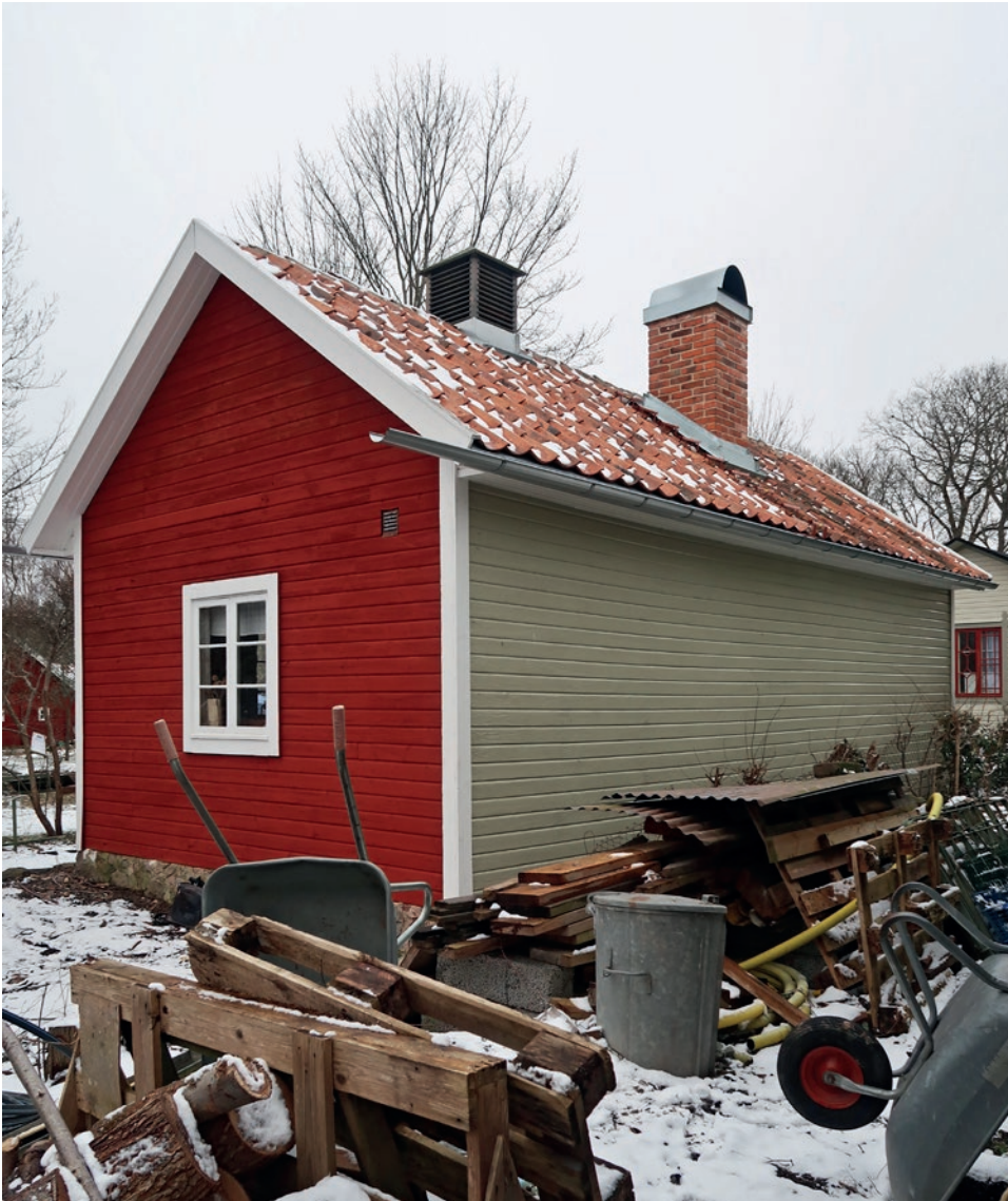
Brygghuset sett från sydöst efter åtgärd.
