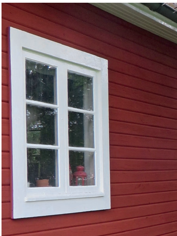
Ett av fönstren på brygghuset efter åtgärd.
