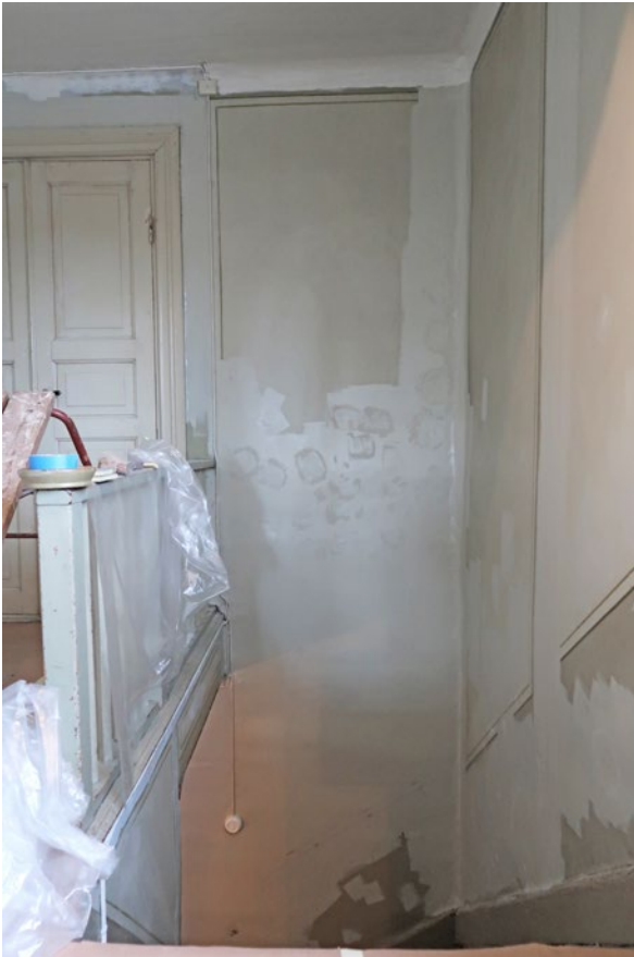
Pågående ommålning av hallen. Hantverkaren hade svårt att få markuleringspappen att fästa mot de befintliga oljefärgsmålade pappytorna.
