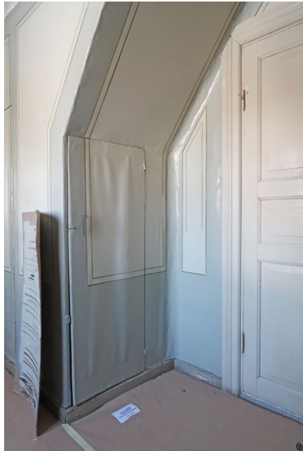
Pågående ommålning. Till vänster syns en pappskiva där hantverkaren provat sig fram för att få rätt kulörer och utförande på linjerna.
