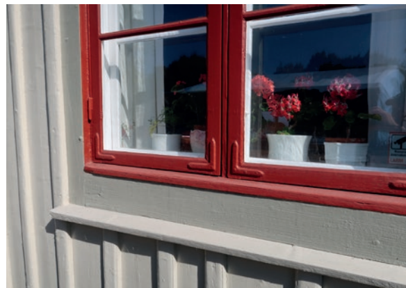
Närbild av fönster mot söder efter ommålning.
