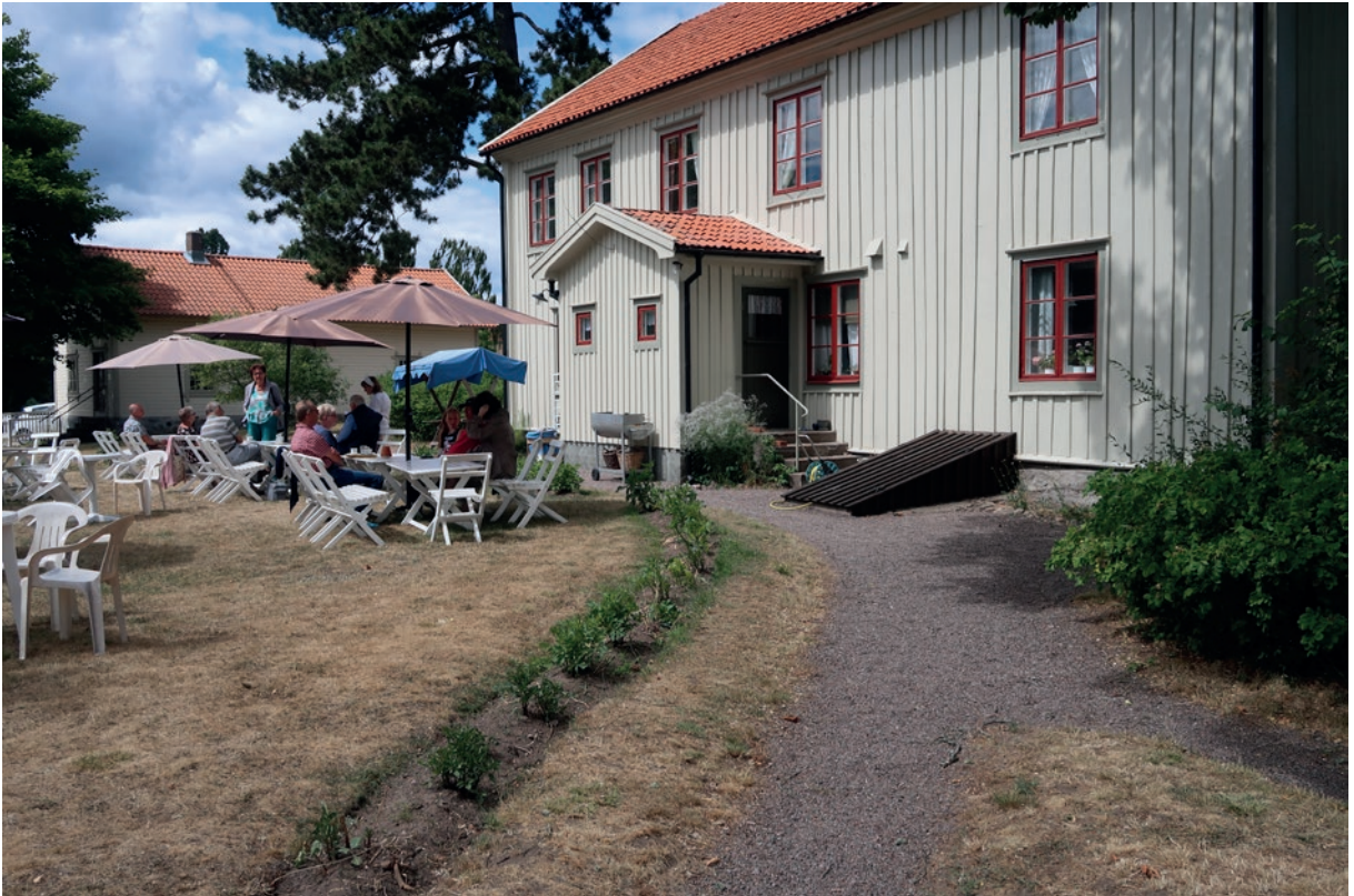
Fasad mot söder efter ommålning.
