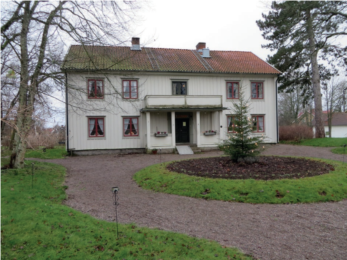
Bostadshusets huvudfasad mot norr före ommålning.
