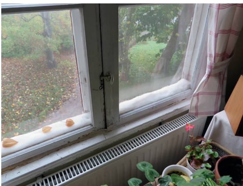
Närbild av fönster mot öster från köket på andra våningen.
