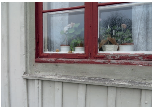
Närbild av fönster mot söder före ommålning.
