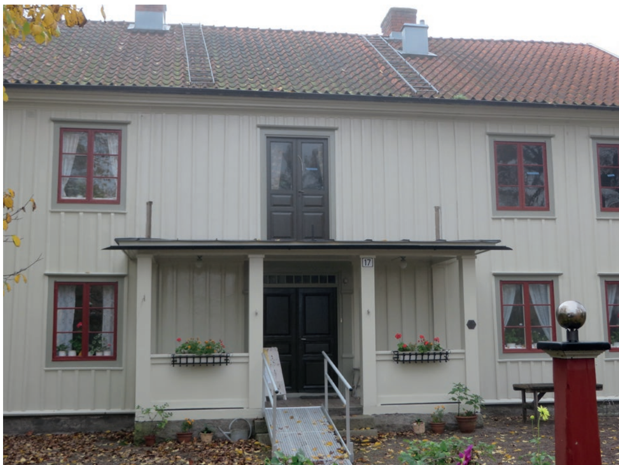
Norrfasadens mittparti efter demontering av balkongräcke. (Arbetet med reparation av balkongräcke beskrivs i en separat rapport.)
