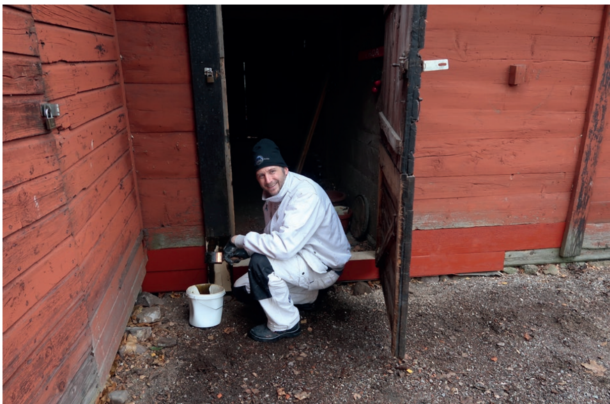
Alla utbytta delar har målats med falu rödfärg. Övriga delar av fasaderna skall målas om under 2019 eller 2020.
