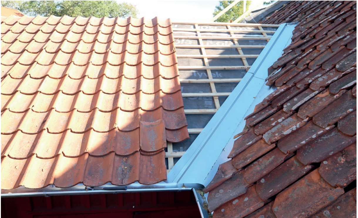
Närbild av innerhörnet mot nordväst. Pågående arbeten.
