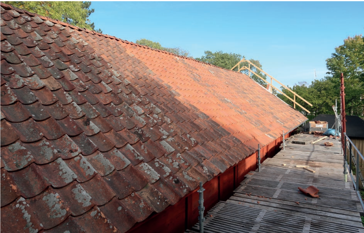
Ladugårdens södra takfall efter avslutade arbeten.
