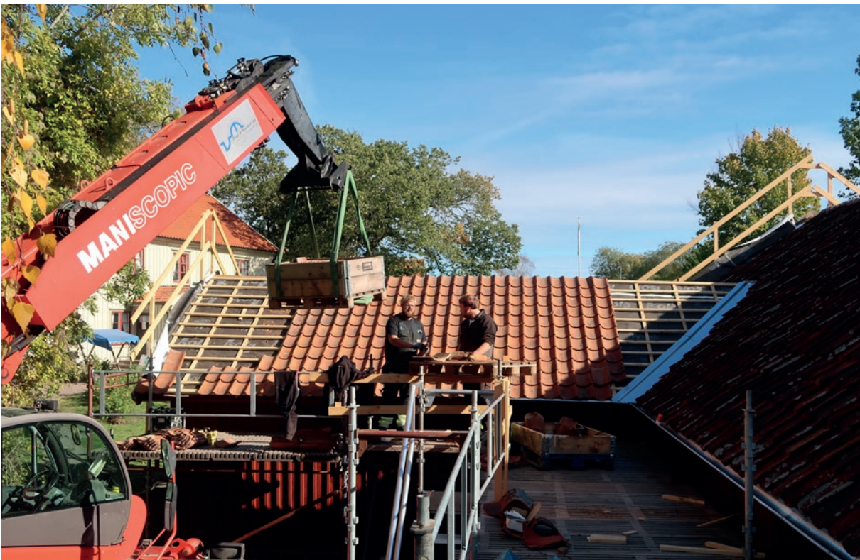
Pågående omläggning av den lägre byggnadsdelens takfall mot väster. På bilden syns Anton Olofsson och Johan Svensson från VM Bygg & Snickeri AB.
