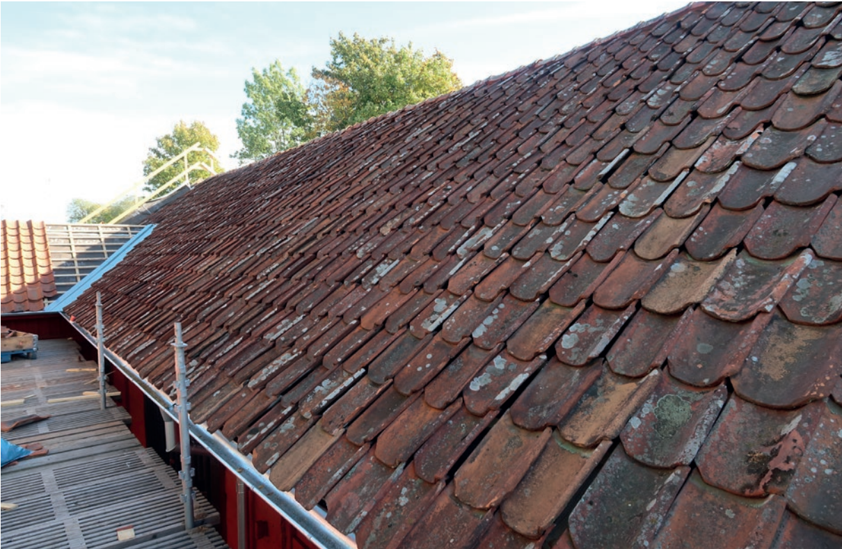
Norra takfallet efter omläggning.
