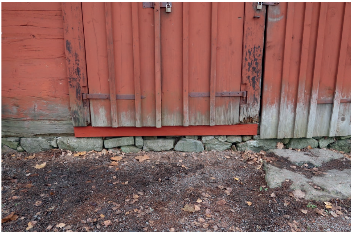
Syllen under dörren har förstärkts med en bräda.
