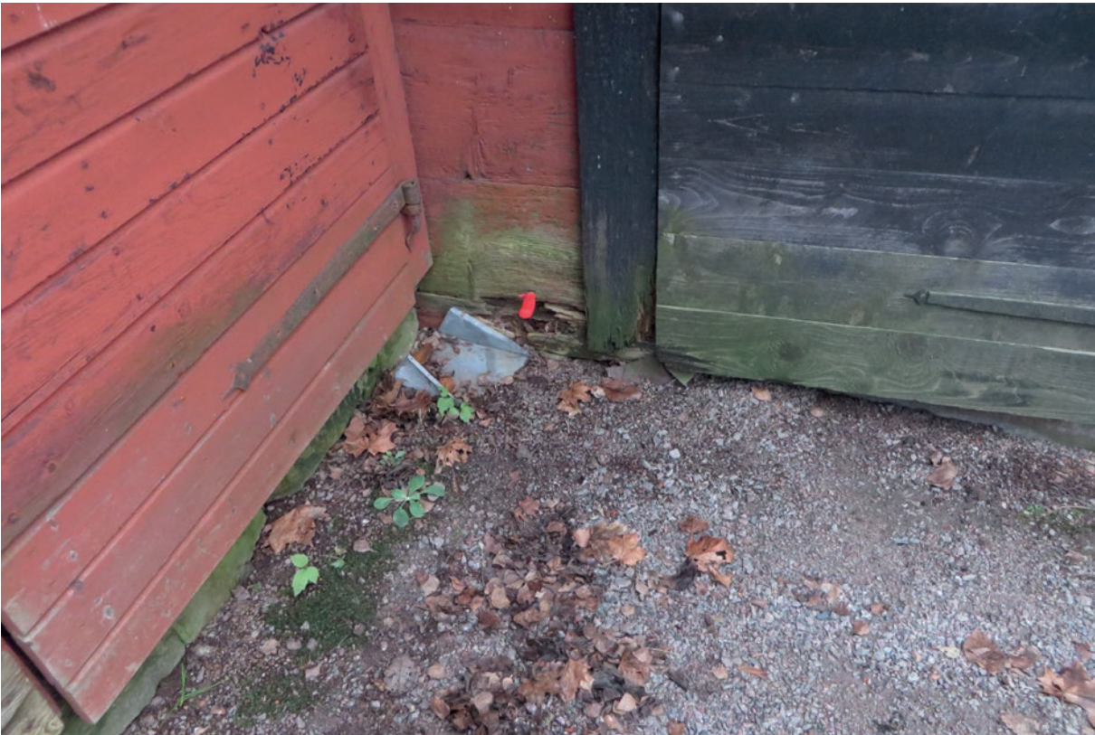
Skadorna var allvarligast vid norra fasadens innerhörn i öster. Här var det nödvändigt att byta ut syllen.
