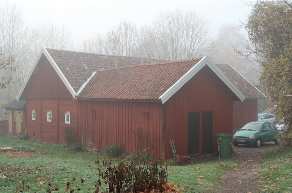
Ladugården fotograferad från nordost efter avslutade arbeten. Jämför med bild på sidan 6.
