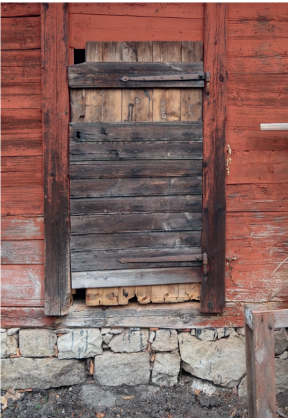
Skadorna var allvarligast vid norra fasadens innerhörn i öster. Här var det nödvändigt att byta ut syllen.
