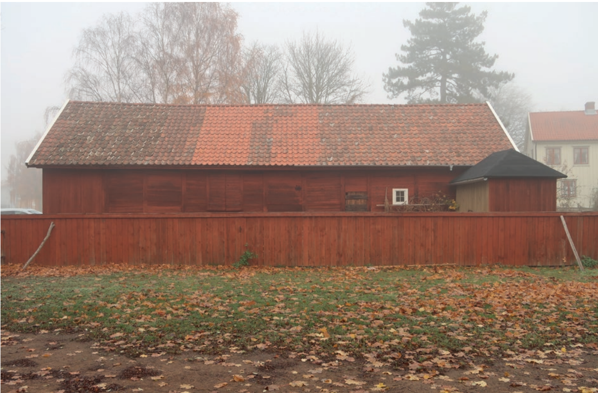
Ladugårdens södra fasad efter avslutade arbeten. Jämför med bild på sidan 7.
