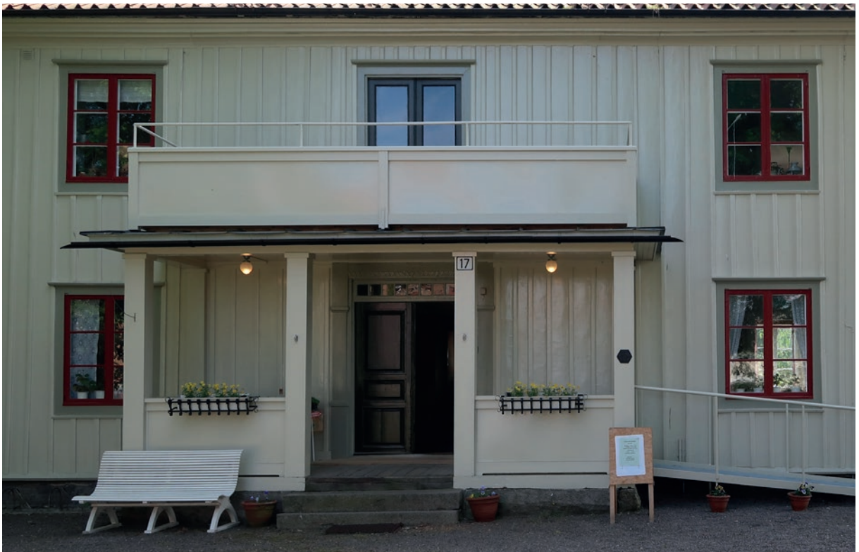
Olssonska gårdens norra fasad efter åtgärd. Det nya räcket har sina fästpunkter rakt ovanför de pelare som finns på den öppna verandan under balkongen.
