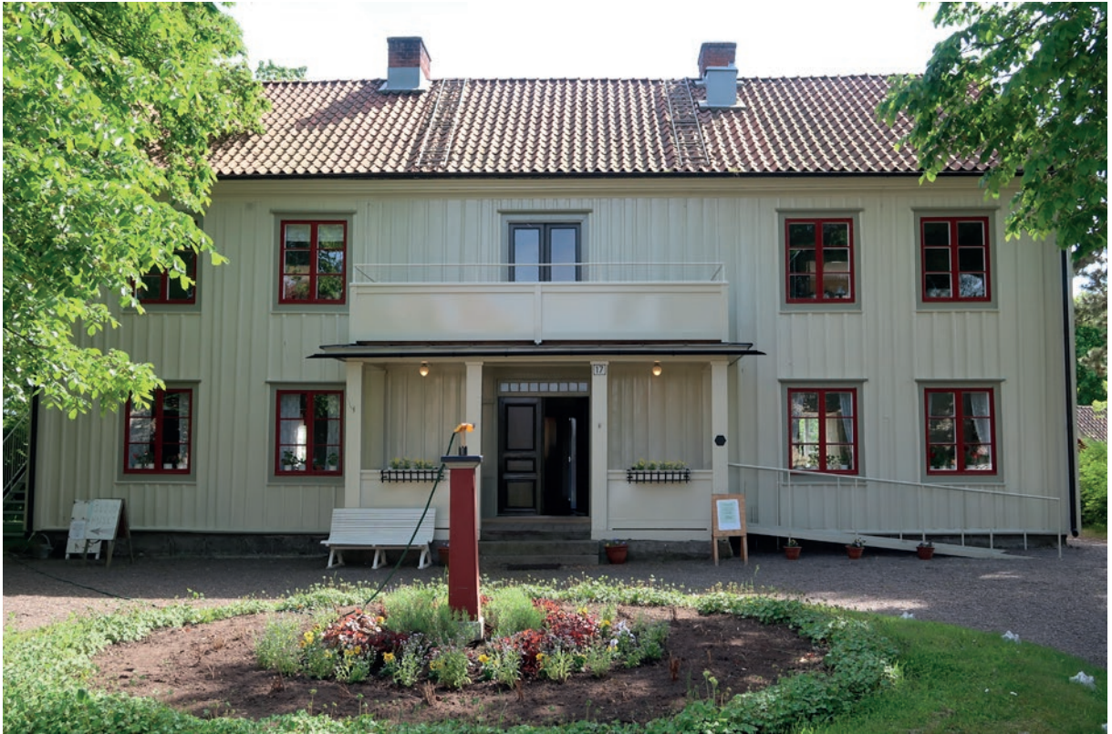
Olssonska gårdens norra fasad efter åtgärd. Det nya räcket i järn är monterat ovanpå det gamla balkongräcket.
