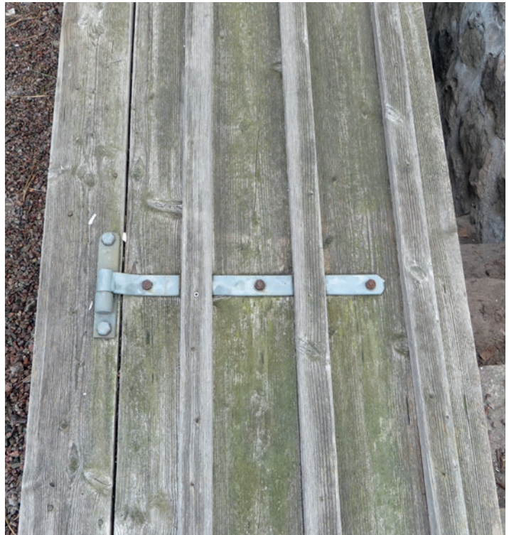
Källarluckan före åtgärd. Luckorna hade blivit skeva och så pass rötskadade att de gått sönder på vissa ställen. Här syns ett av gångjärnen som har en relativt modern utformning.
