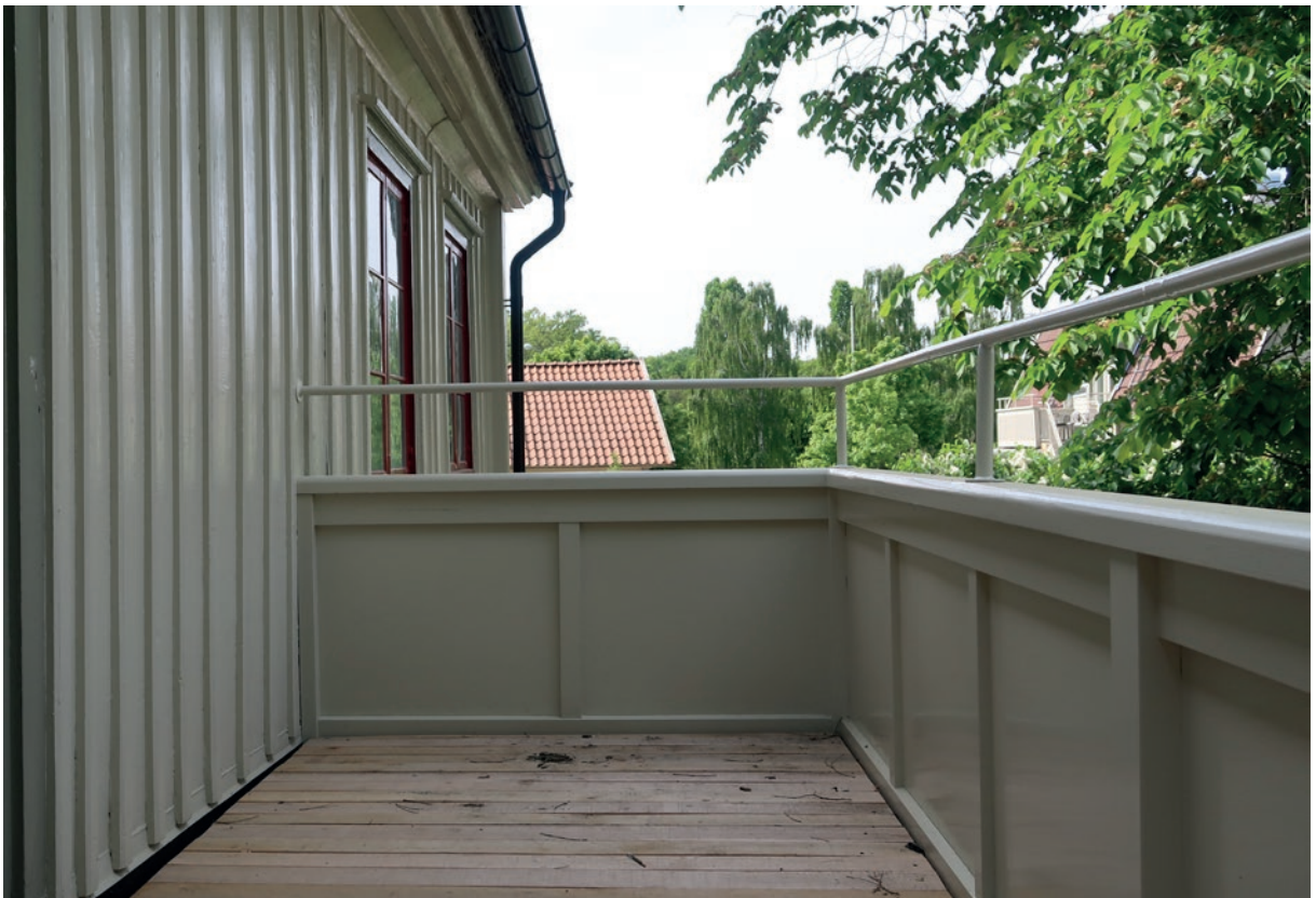
Balkongräcket efter åtgärd. Här syns också det nya ekgolvet.
