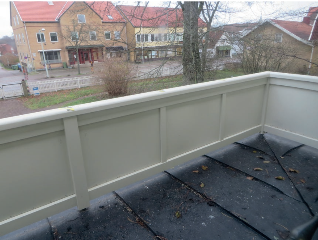
Balkongräcket under pågående åtgärd. Det nya räcket i järn fattas fortfarande.
