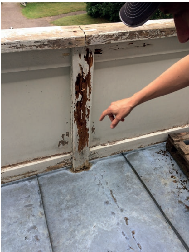
Balkongräcket på Olssonska gården efter skrapning av färg. Balkongfrontens stomme i furu var i mycket dåligt skick med omfattande rötskador.
