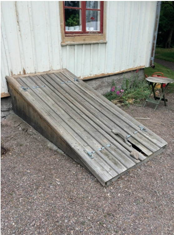
Källarluckan före åtgärd. Luckorna hade blivit skeva och så pass rötskadade att de gått sönder på vissa ställen. Här syns ett av gångjärnen som har en relativt modern utformning.
