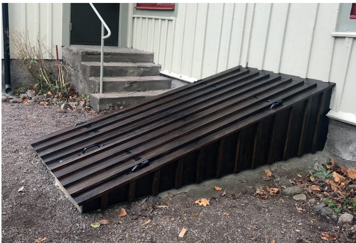
Källarluckan efter åtgärd. Här är luckan relativt nytjärad. På bilden syns de nya gångjärnen och handtaget.
