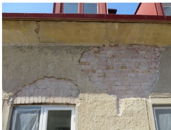
Detalj gatuhuset mot innergården med delar av tegelstommen blottlagd där lagningar skulle utföras.
