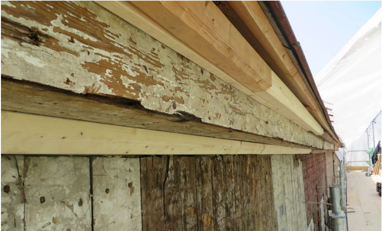
Lagning med nytt virke i takfoten.
