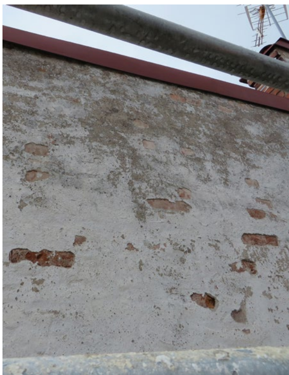
Detalj av gavelns övre parti med tunn, porös puts inför arbetet.
