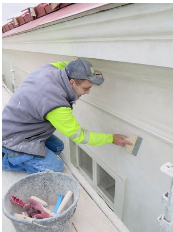
Billy Sjöstrand "skäggjar av" putsen när den är klar och har torkat för att få bort löst bruk och ojämnheter.
