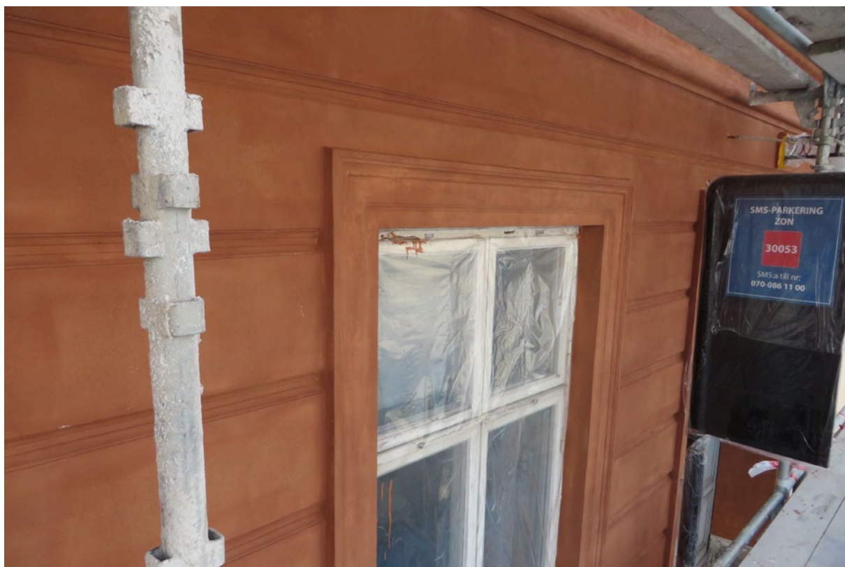
Fasaden struken första gången med brun linoljafärg på alla putsade ytor.
