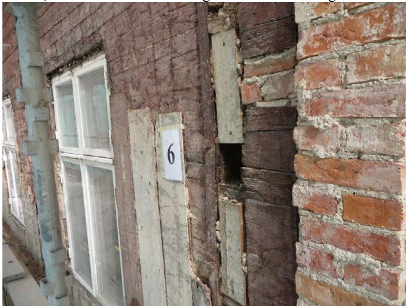
Prov 6 Knut gatufasaden vid västra hörnet
