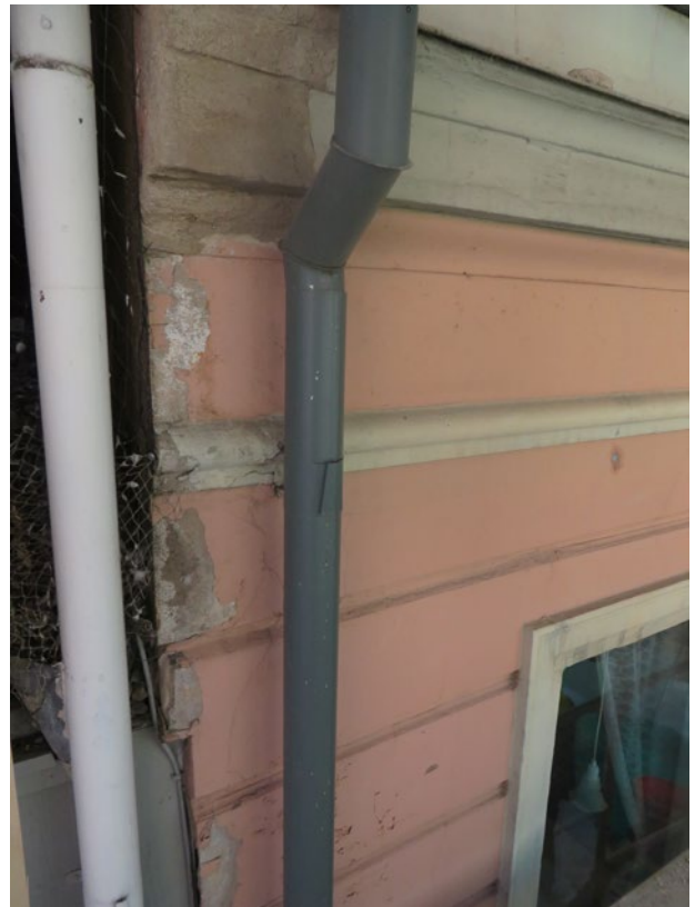
Provblästning av en yta inför beslut om arbetets omfattning.
