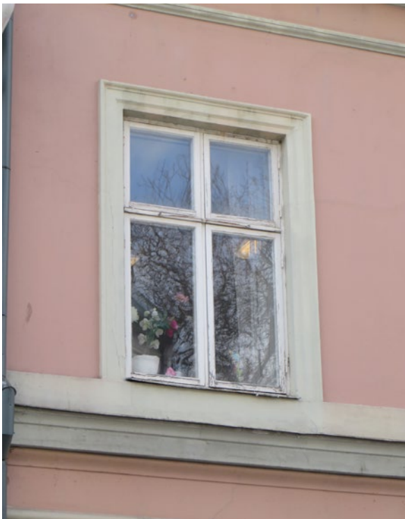
Fönster i andra våningen inför arbetet.
