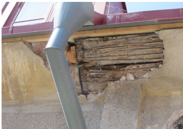
Detalj på mötet mellan tegelstomme och trästomme i takfoten mot innergården.
