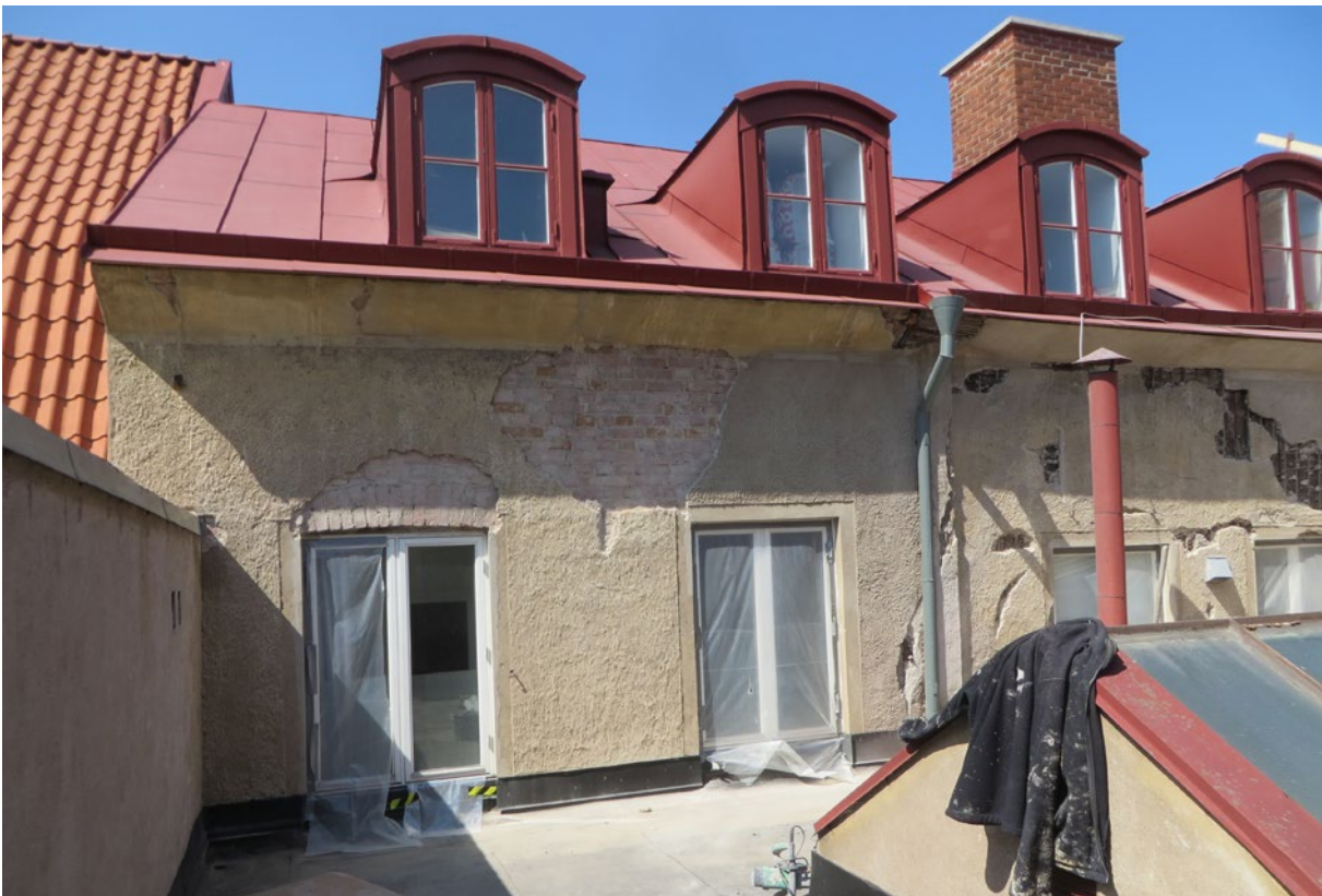
Gatuhuset mot innergården efter rengöring och borttagning av dålig puts.
