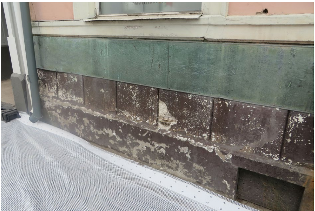
Sockeln och nedre delen av fasaden inför arbetet. Notera cykelplåten i koppar som satt där.
