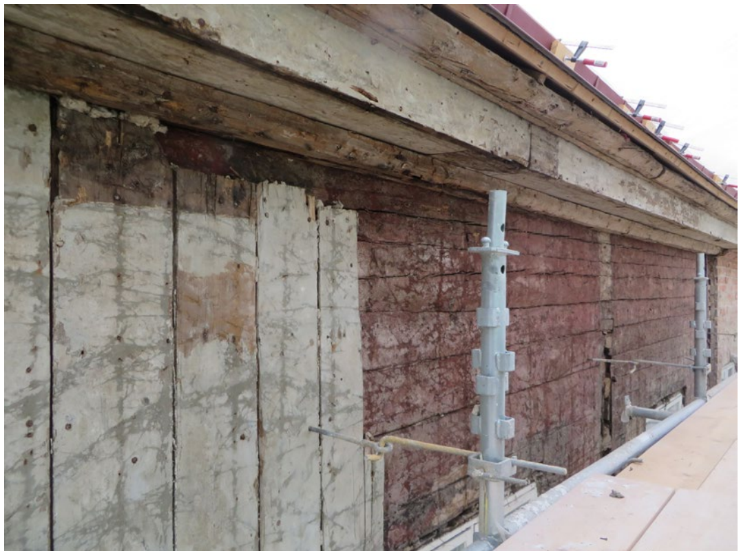
Detalj där man ser att delar av timmerfasaden var klädd med grönmålad panel.
