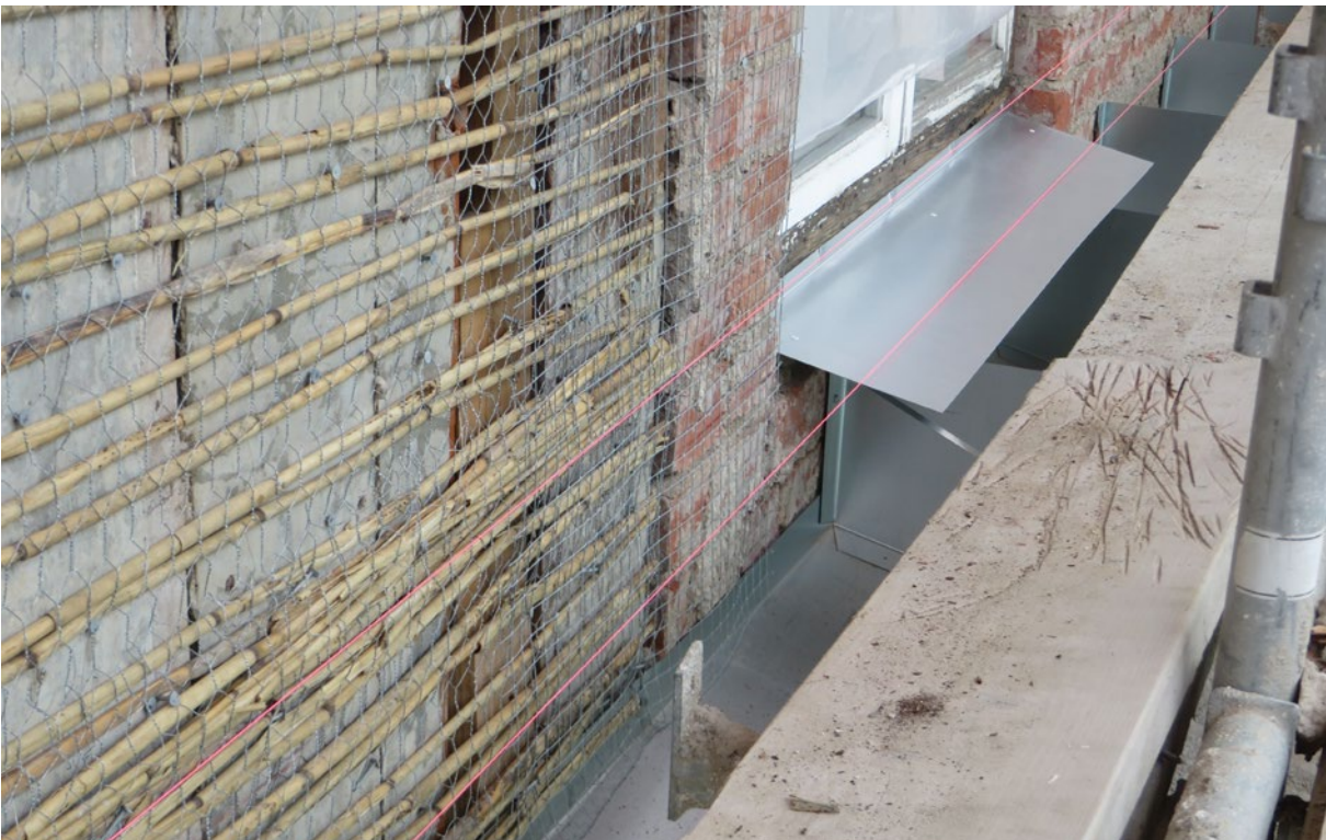
Fästbleck i plåt monterat inför start av putsarbeten.
