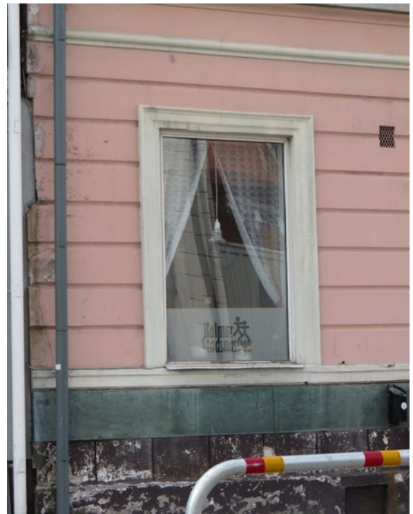
Fönster i bottenvåningen inför arbetet.
