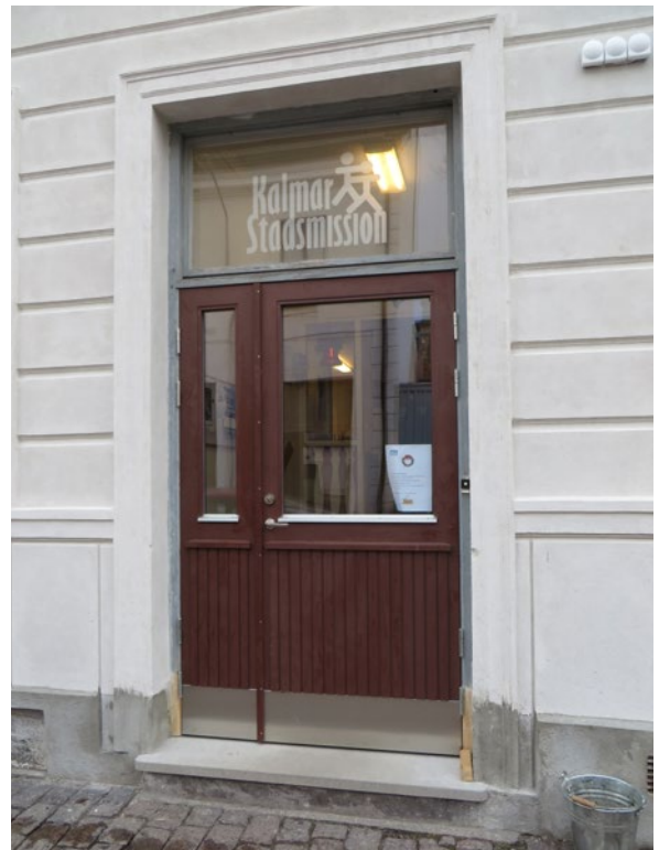
De nya dörrbladen monterade i den nyputsade fasaden. Här ser man att lagningar i sockeln utförts i ett cementbruk som också användes kring entréns nedre del mot sockel och trappsten. Dörren har här en aluminiumlist som efter påtalande ersättes med en trälist.
