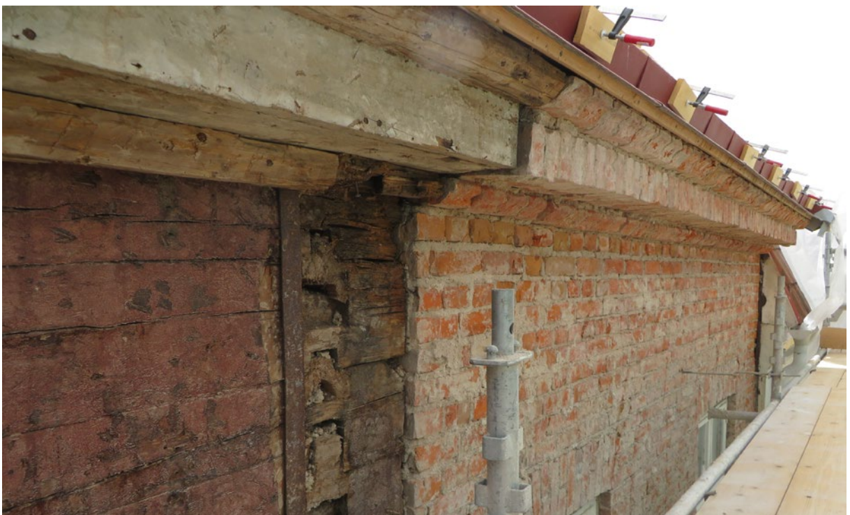
Rengjord stomme inför att ny puts ska läggas på.
