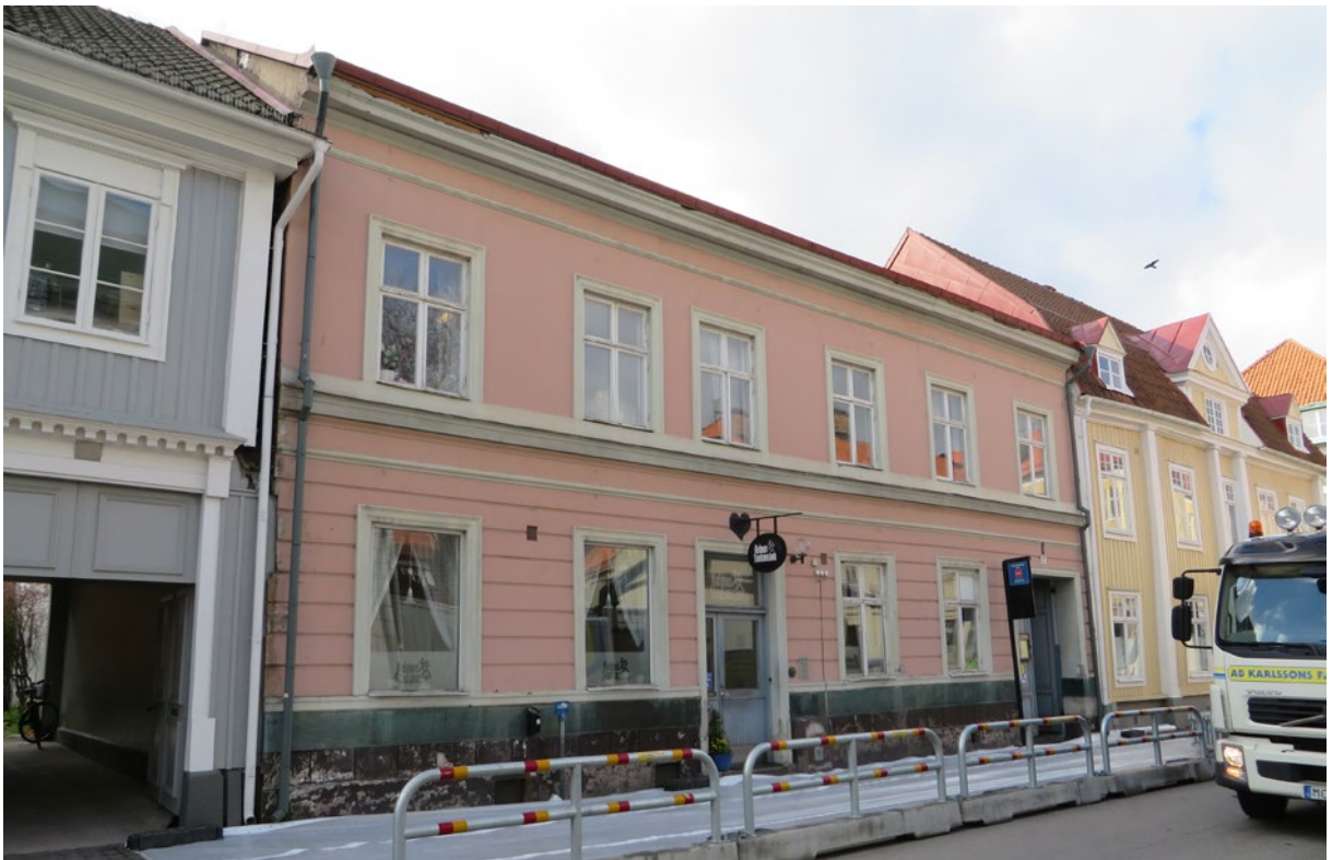
Borgmästaren 11 inför fasadarbeten.
