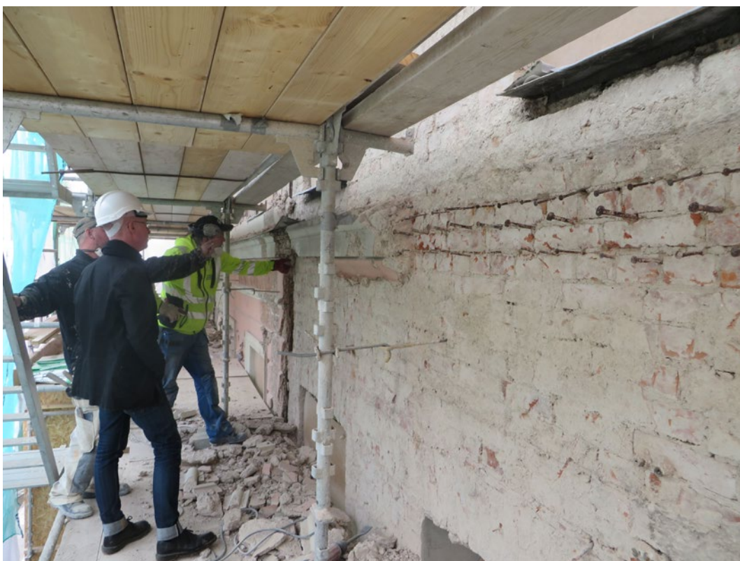
Jan Westergren, läns museet och murarna Billy Sjöstrand och Håkan Holmström inspekterar fasaden under rivning. Här ser man delar av tegelstommen.
