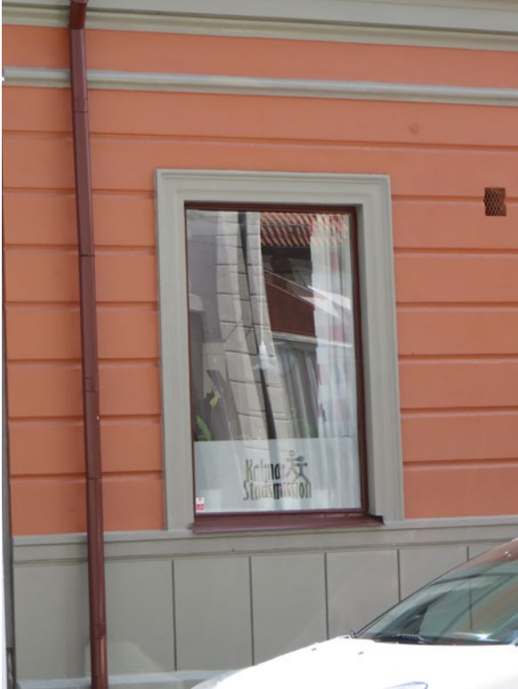
Fönster i bottenvåningen i färdigställt skick.
