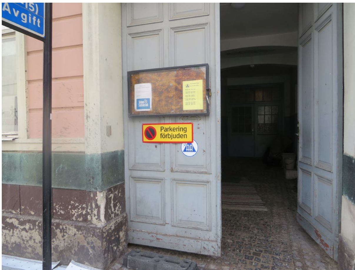
Porten inför arbetet.
