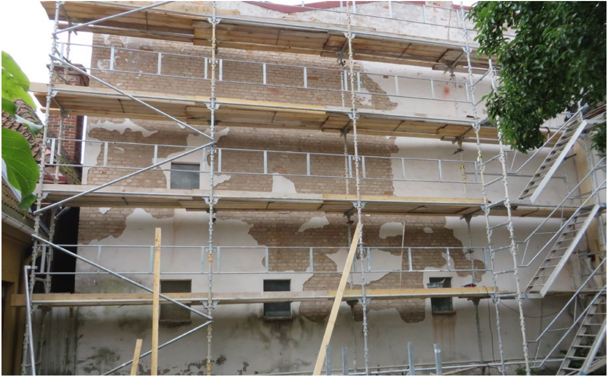
Vid rengöring föll stora partier av lös och tunn puts ner och blottade tegelsstommen bakom.
