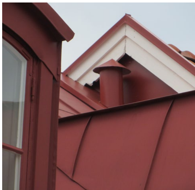
Detalj av taket ovan pråmman med ventilationsröret.
