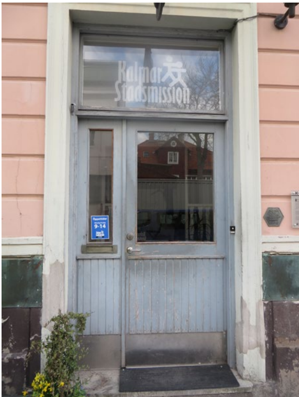
Entrén med den gamla entrédörren inför arbetet.
