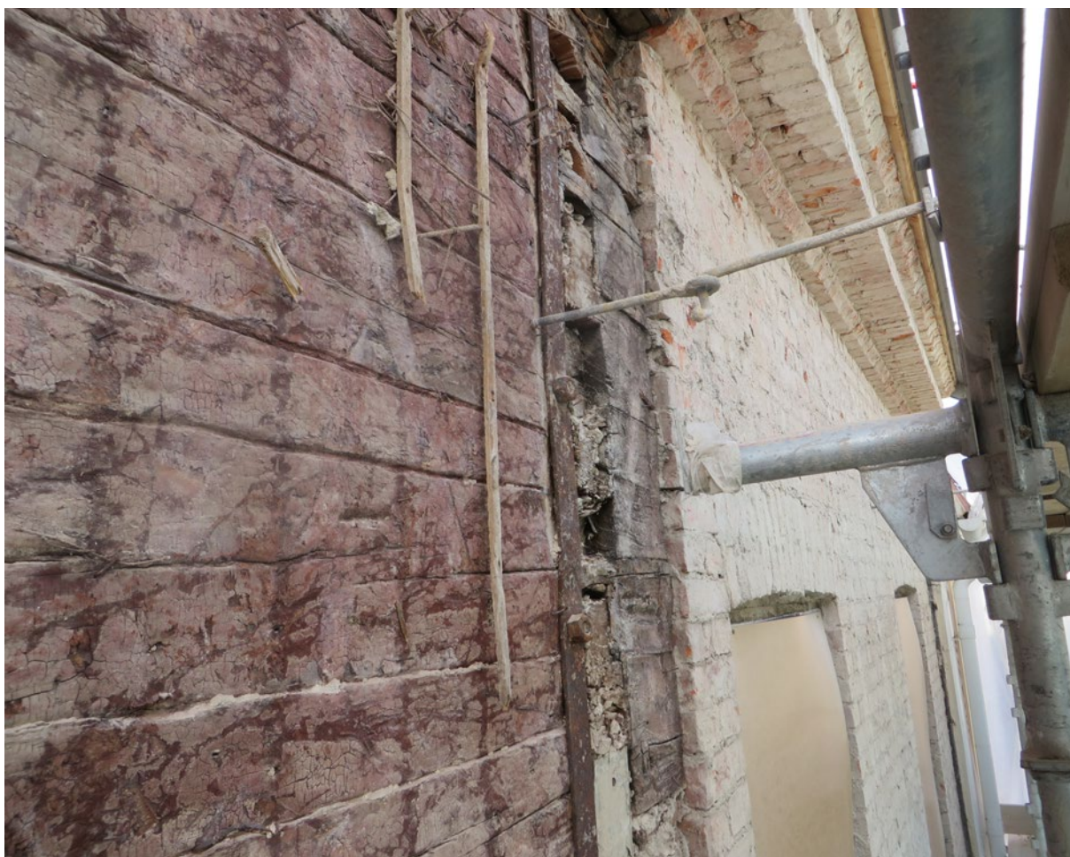
Timmerstomme möter tegelstomme. Här ser man också en av knutarna förstärkt med järn.
