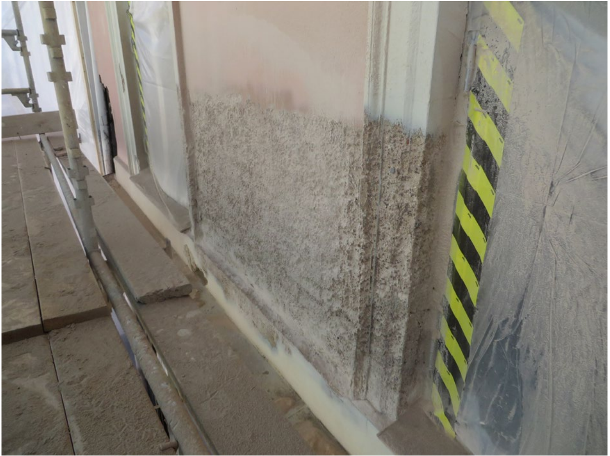
Provblästning av en yta inför beslut om arbetets omfattning.
