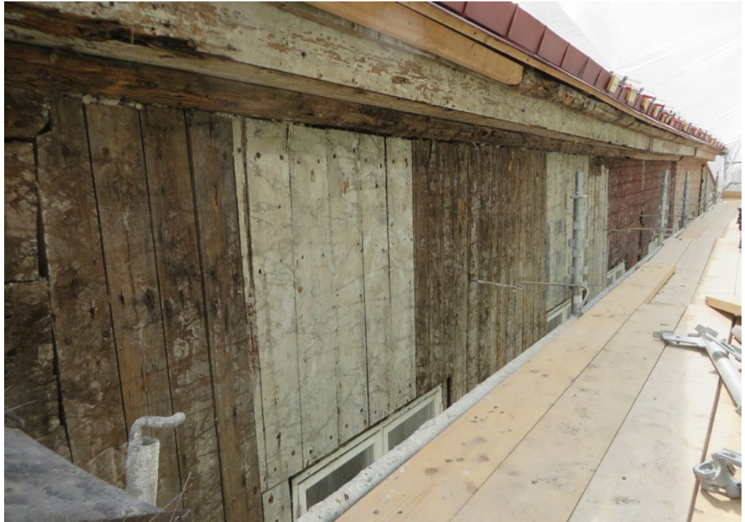
En översiktsbild över stommen när putsen och putsbäraren tagits bort och stommen rensats och rengjorts.
