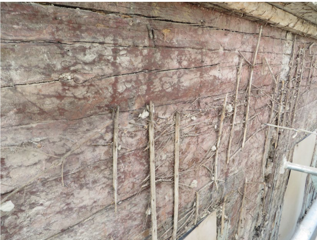
Delar av underlaget till putsen bestående av granris och tunna träribbor sitter kvar på timmerstommen efter rivning av puts.
