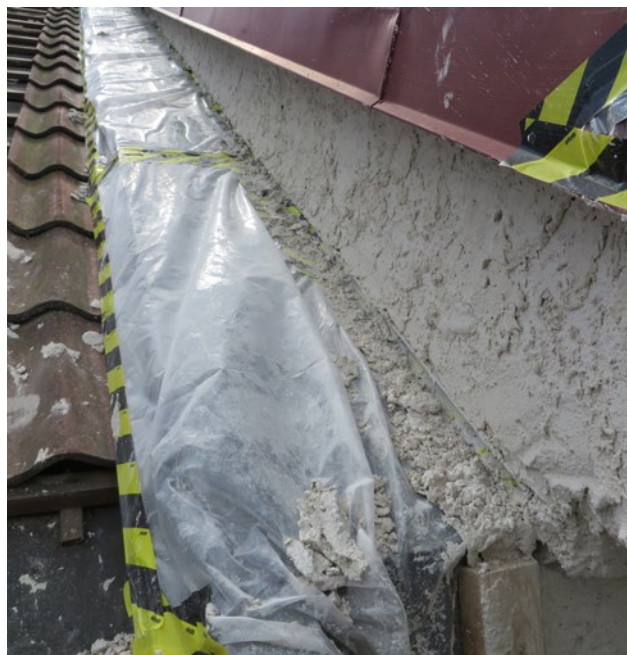
Här har en plåt monterats mot gaveln på Borgmästaren 11 och ytan ovan har putsats om vid inbyggnad av pråmman.
