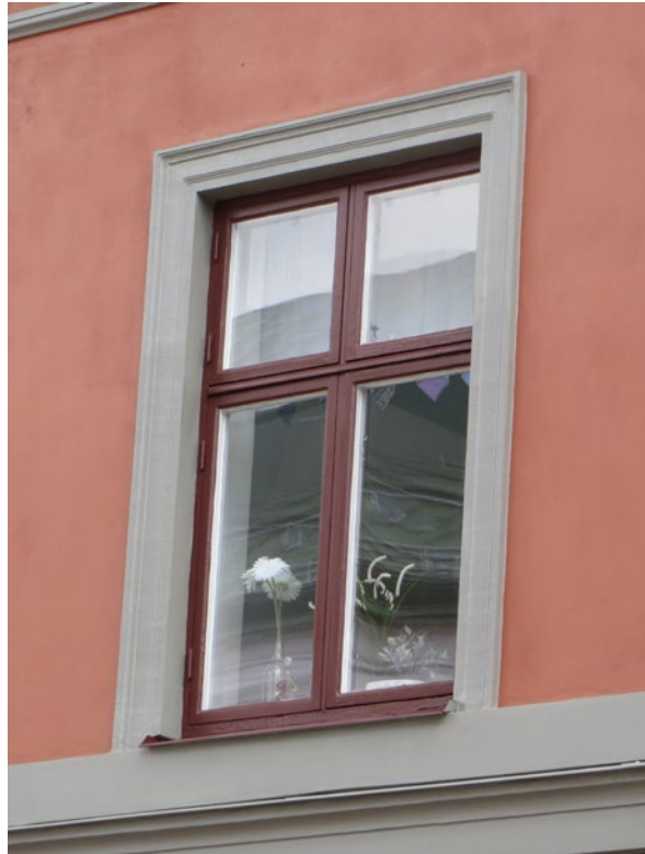
Fönster i andra våningsplanet i färdigställt skick.
