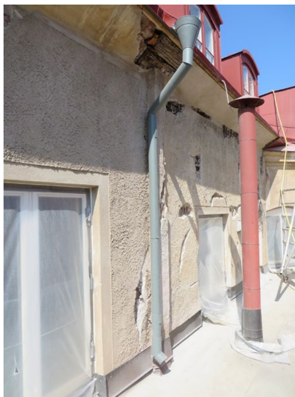
Gatuhuset mot innergården i mötet mellan tegelstomme och trästomme.
