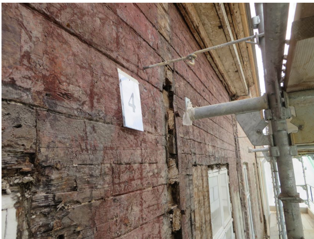
Spikrensad fasad inför att arbetet med uppbyggnaden av putsfasaden ska påbörjas. Här syns också var nr 4 av de dendrokronologiska proverna togs.
