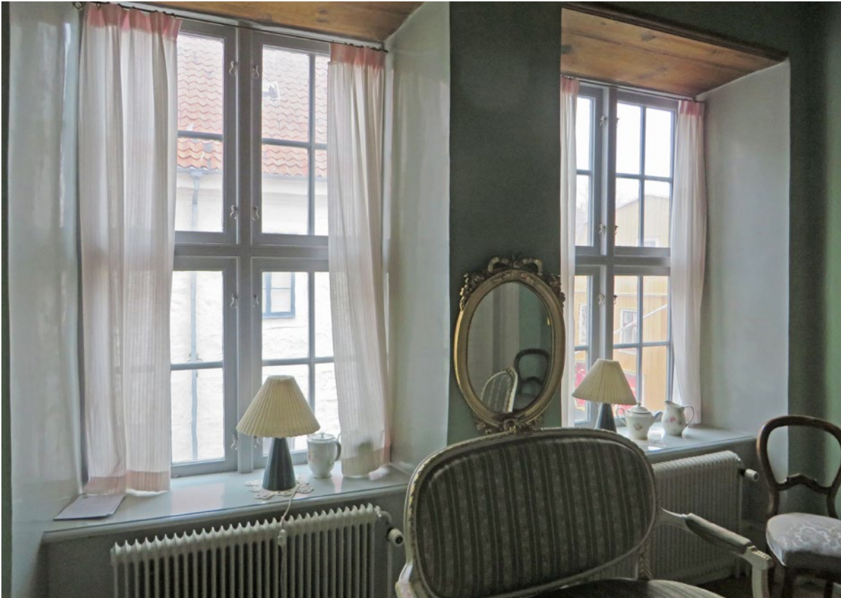
Invändigt, D3 och D4 inför arbetet.
