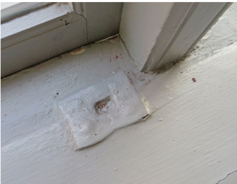
Fönster D8 där det finns tydliga spår efter invändiga luckor eller galler.
