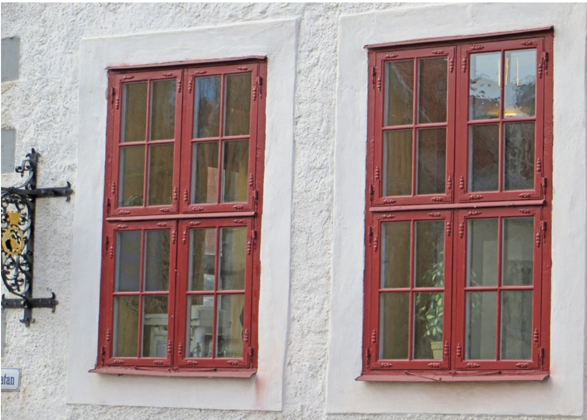
Fönster D6 och D7 efter slutfört arbete.
