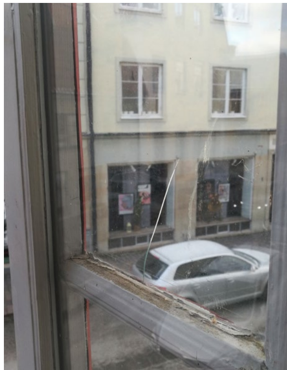
Detalj av B1 som visar exempel på trasigt glas samt skicket på det grå måleriet på yttre bågens insida, inför arbetet. Foto: Jörgen Svensson.
