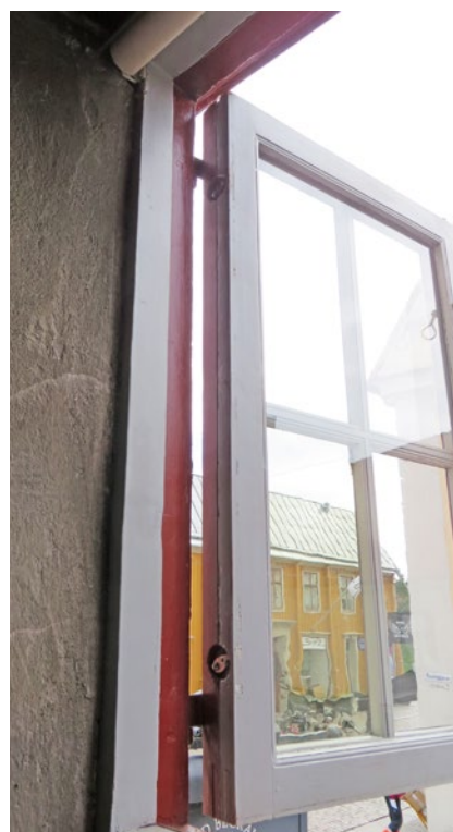
Fönster C4 efter renovering. Insida ytterbåge också nymålad.
