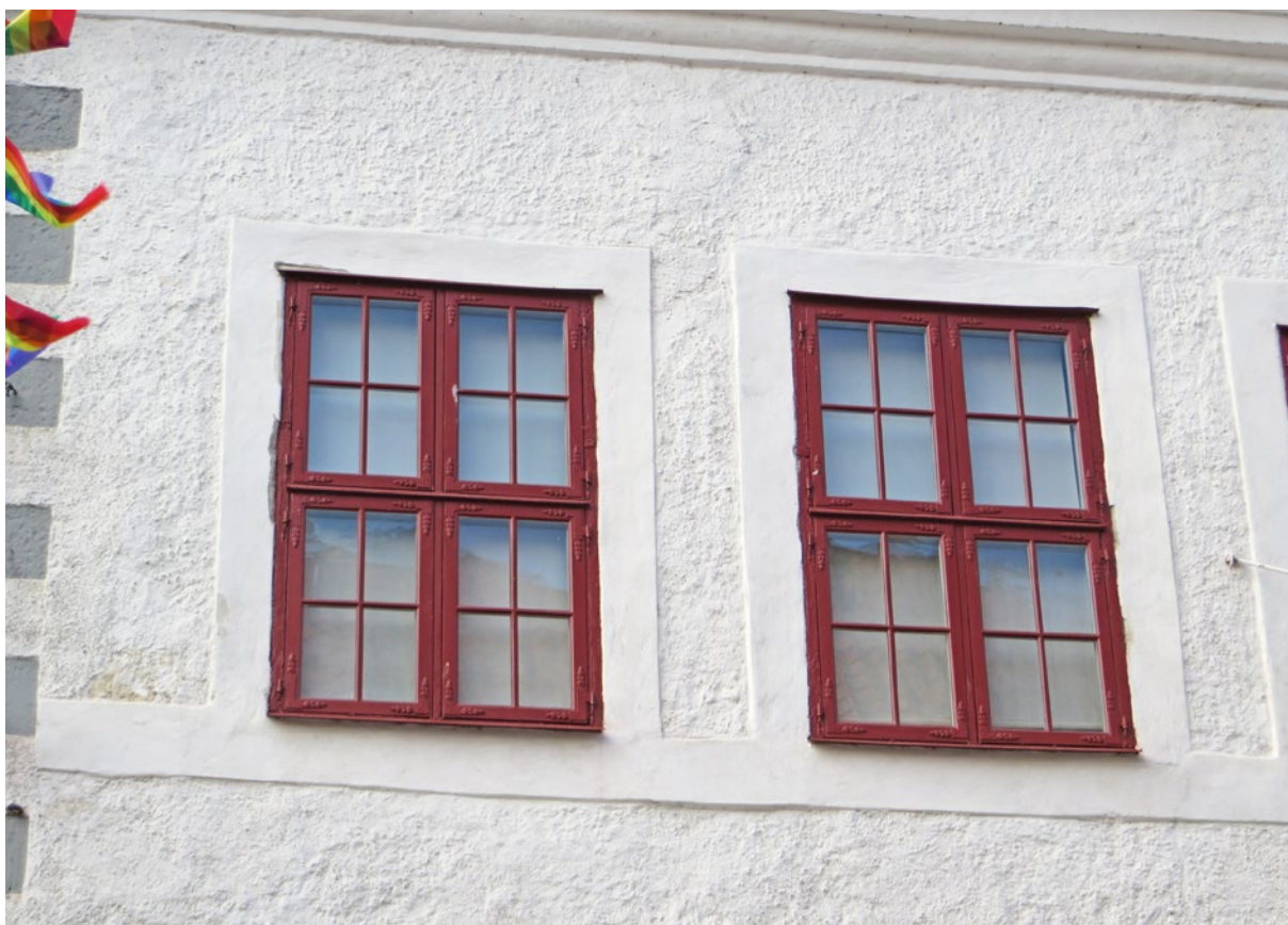
Fönster D1 och D2 efter slutfört arbete.
