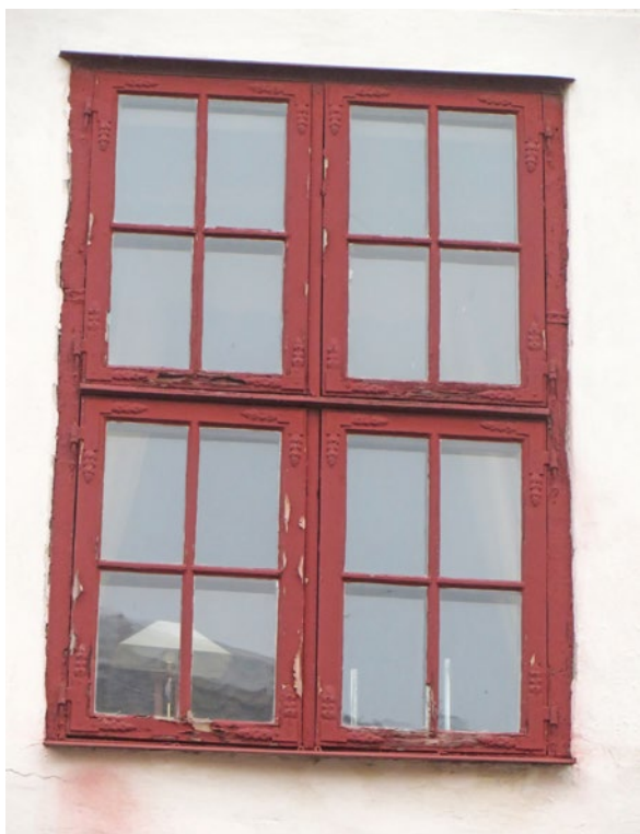
Fönster C3 inför arbetet.
