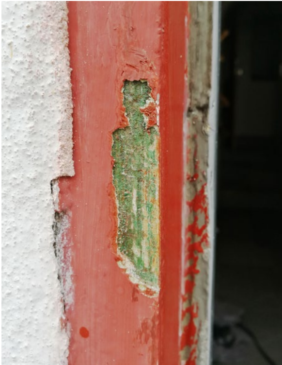
Fönster D8 där en grön kulör återfanns underst på karmen i samband med arbetena. Den gröna kulören återfanns inte på andra karmar. Foto: Jörgen Svensson.
