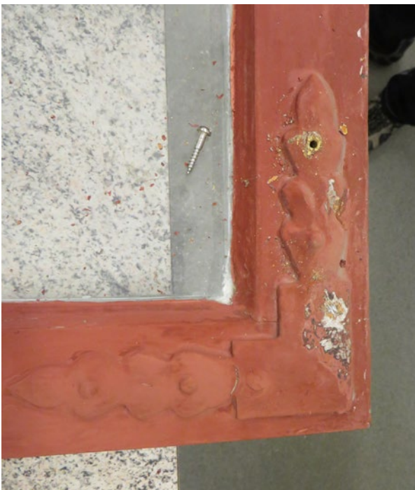
Närbilder på hörnbeslag av barocktyp. Hörnbeslagen var olika distinkta i sin form vilken skulle kunna indikera att en del är äldre och en del är nyare (tillverkats som komplettering). Här har skrapning för kulörundersökning påbörjats på ett av beslagen.
