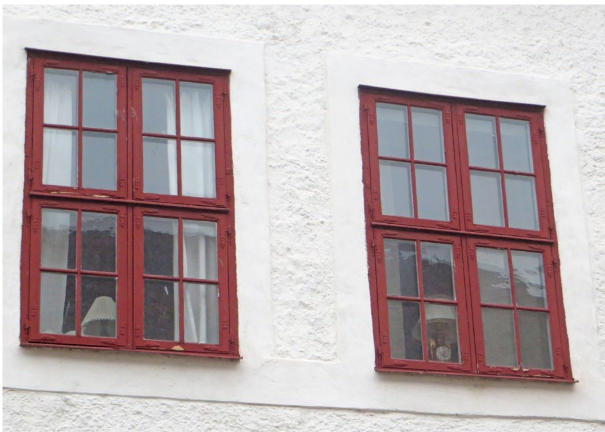
D4 och D5 inför arbetet.
