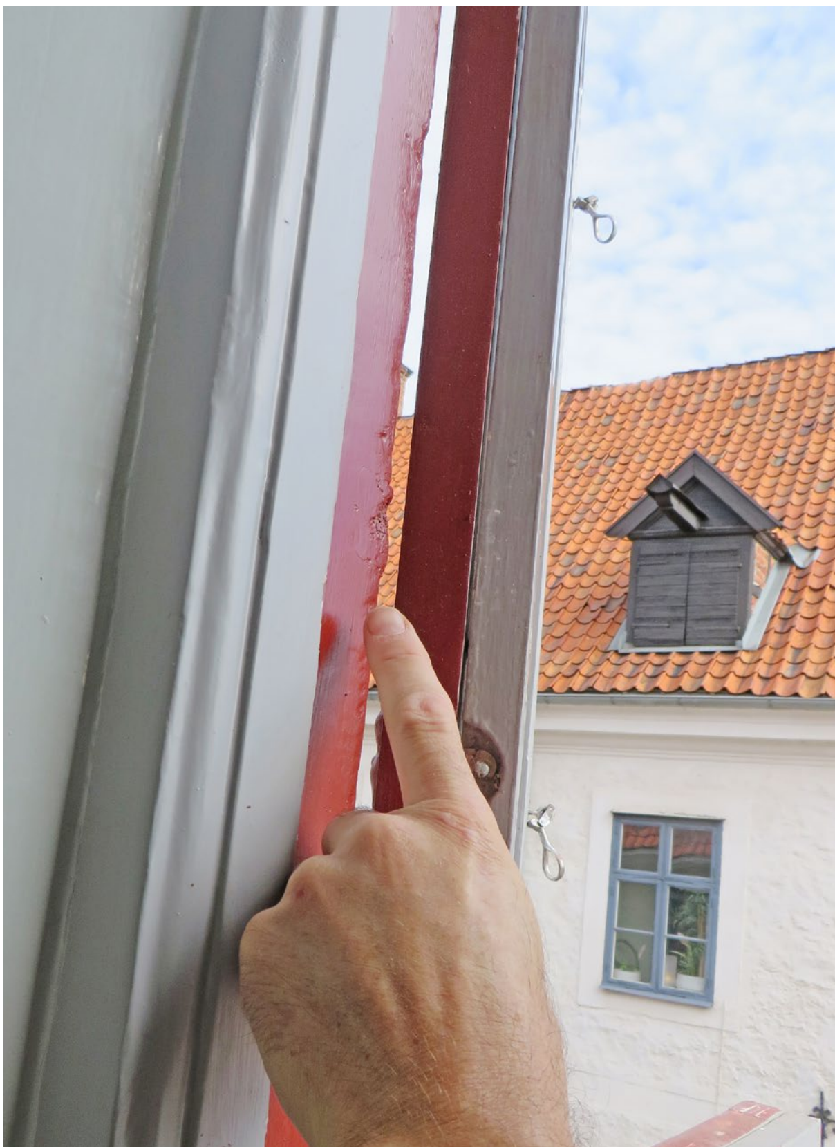
Fönster D4 där man kan se spår efter avsågad tvärpost även efter avslutad fönsterreovering.
