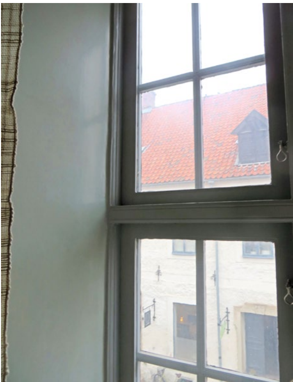
Invändigt, D2 inför arbetet.
