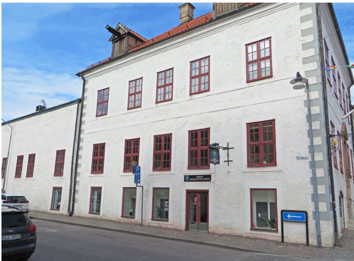
Fasad C efter slutfört arbete.
