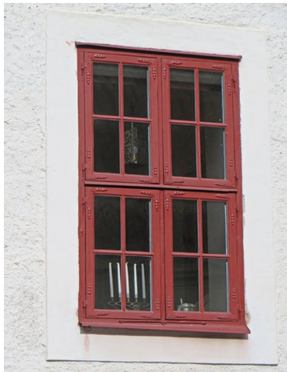
Fönster B4 efter slutfört arbete.
