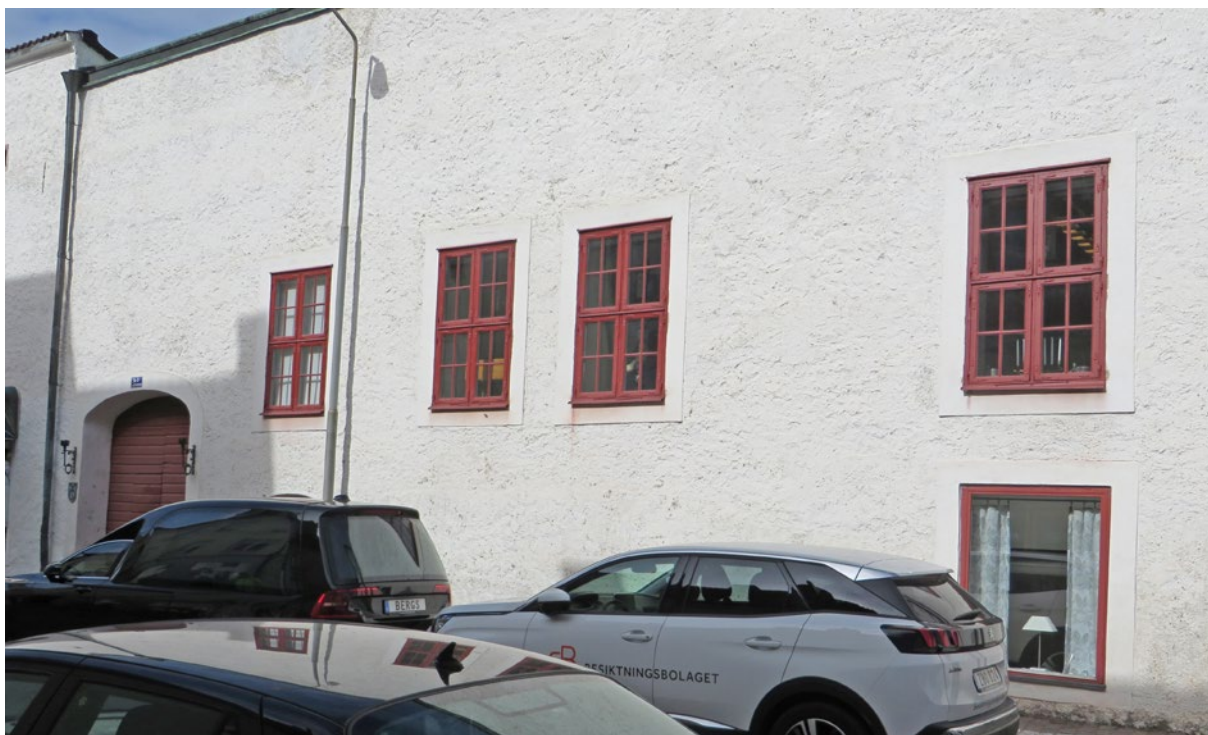
Fasad B efter slutfört arbete.
