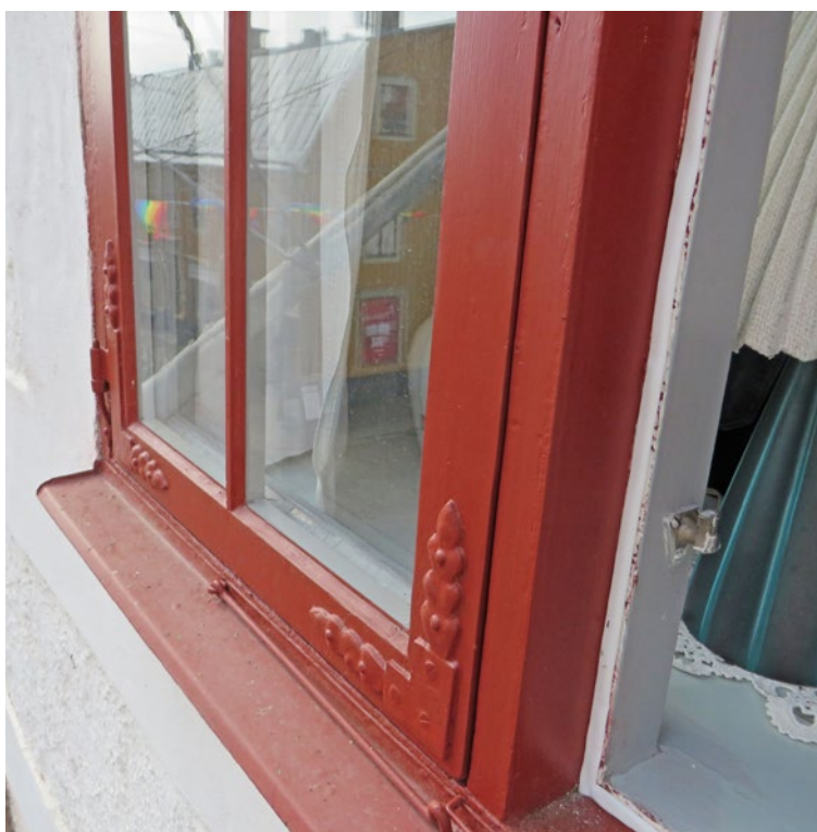
Detalj fönster D9 efter färdigställt arbete.
