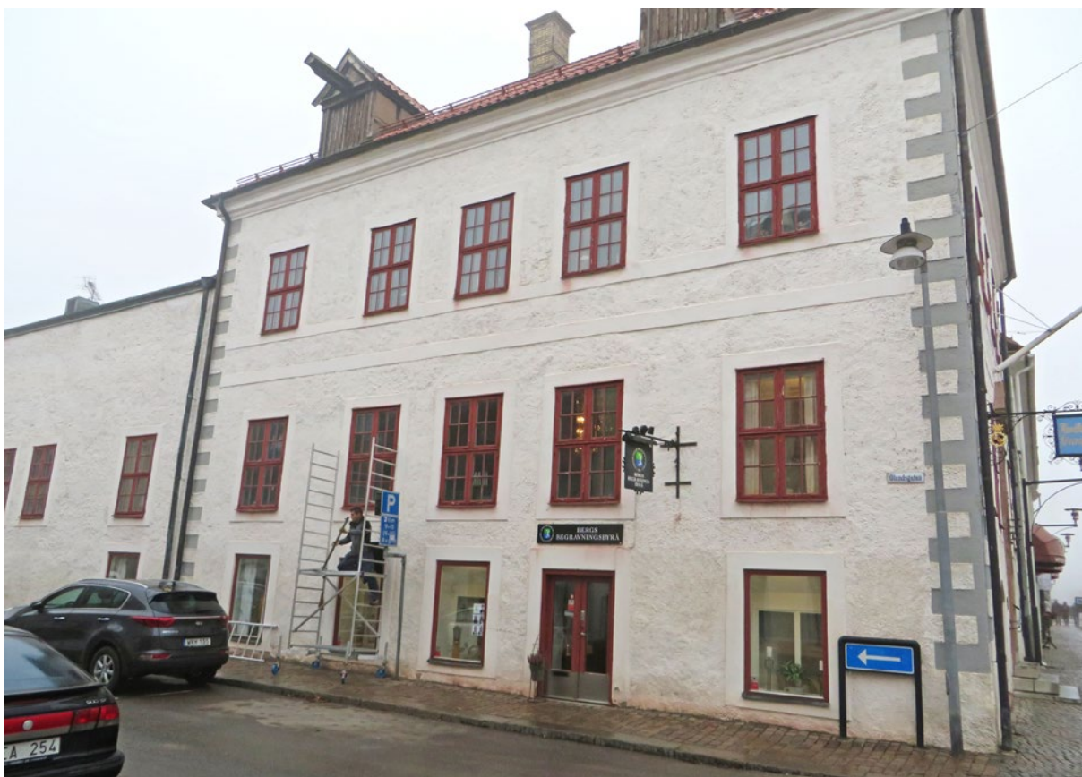
Fasad C inför arbetet.
