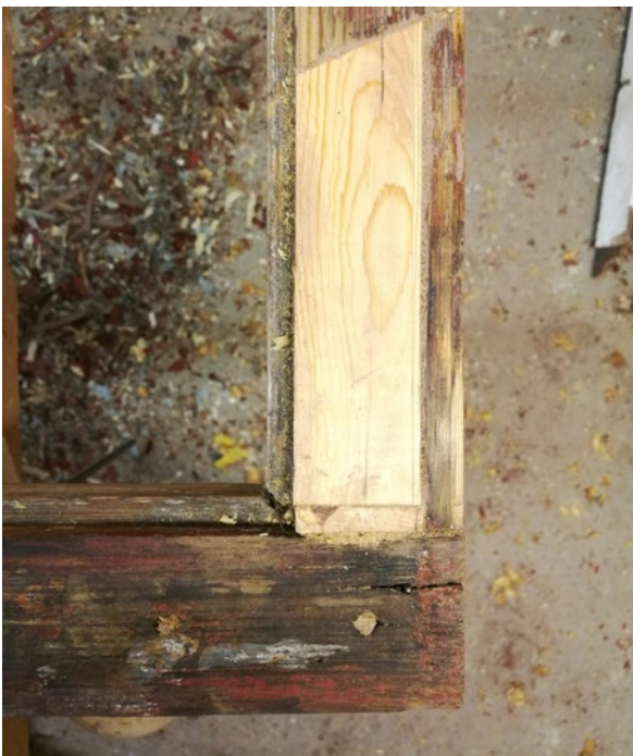
På en av fönsterbågarna gjordes denna lagning som var en av två som utfördes. Oklart vilken båge. Foto: Jörgen Svensson.
