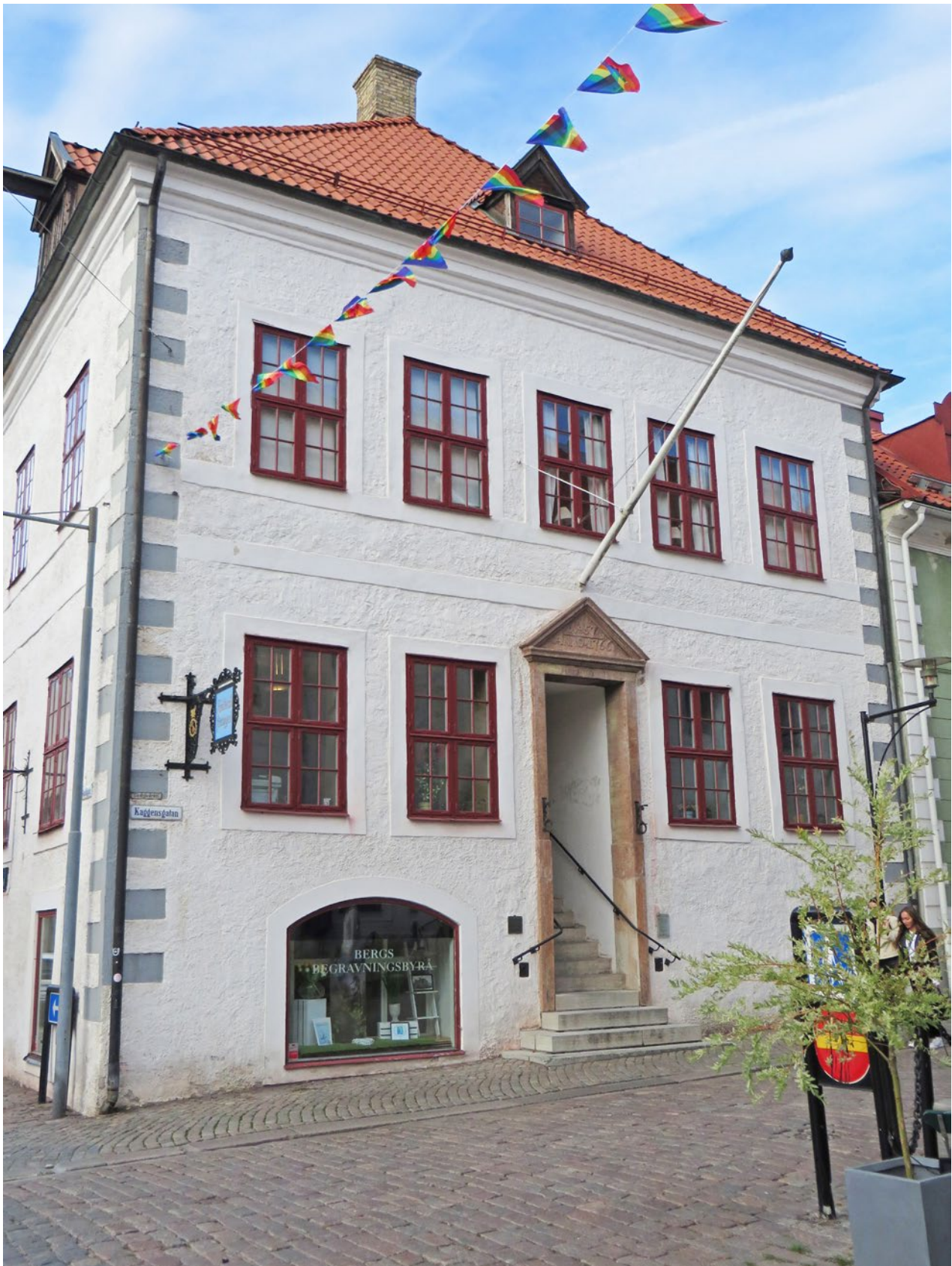
Fasad D efter slutfört arbete.
