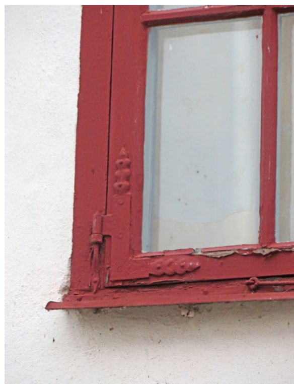
Detalj D6 inför arbetet.
