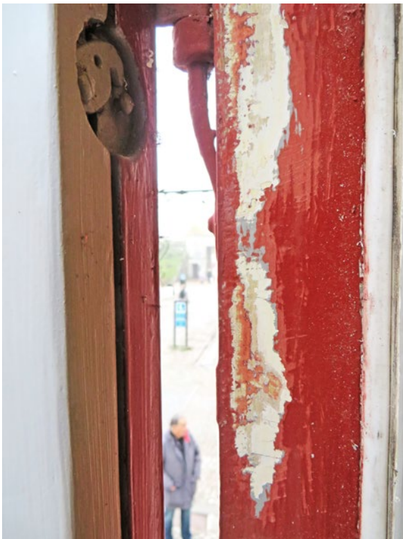
Karm till fönster D6 vid färgundersökning.
