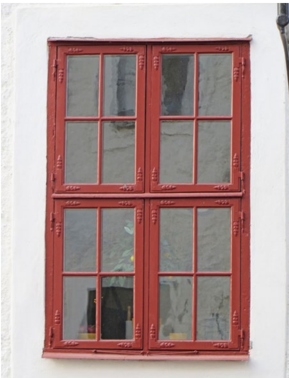
Fönster D9 efter slutfört arbete.
