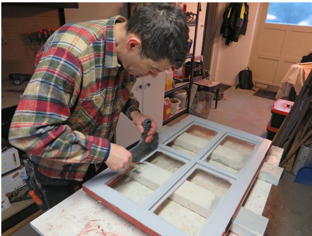
Jörgen Svensson skär bort överflödigt färg efter målning av bågns insida.
