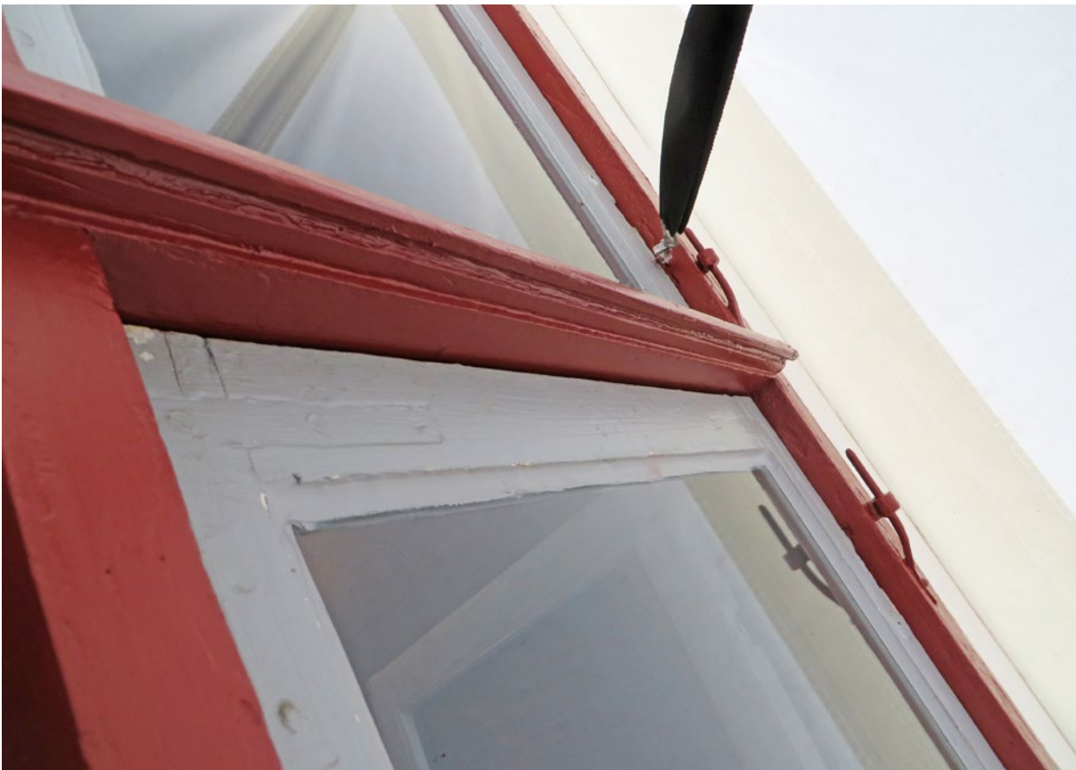
Närbild på målad karm inför återmontering av båge. Fönster D6.
