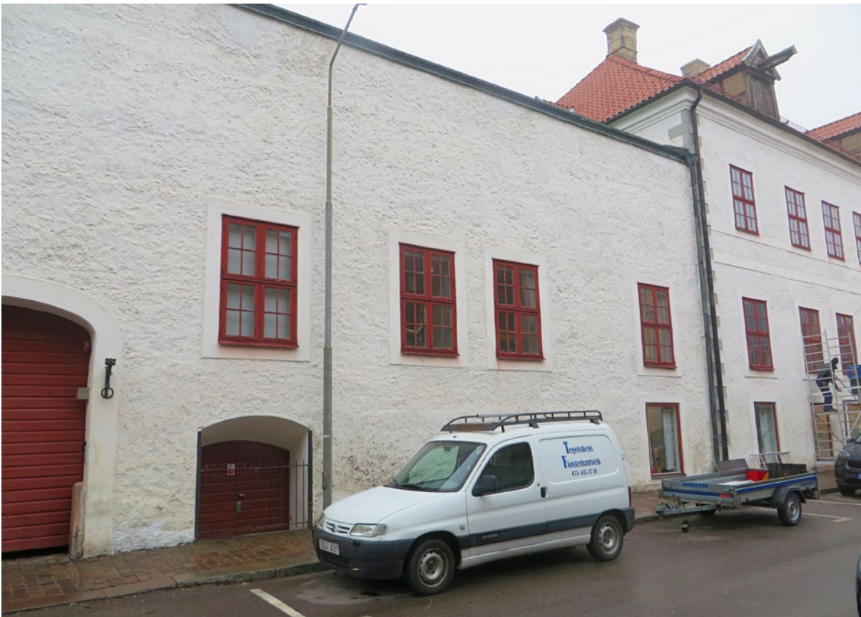
Fasad B inför arbetet.
