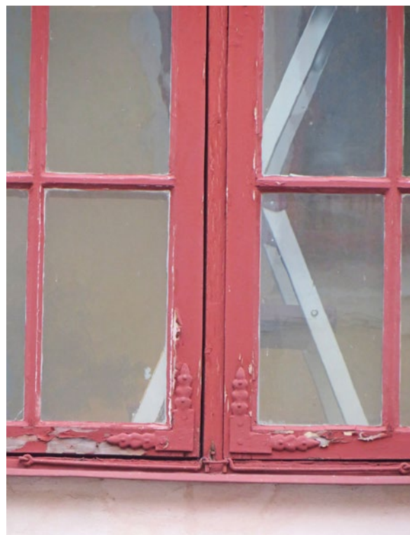
Detalj C7 inför arbetet.
