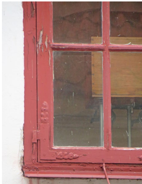
Detalj B3 inför arbetet.
