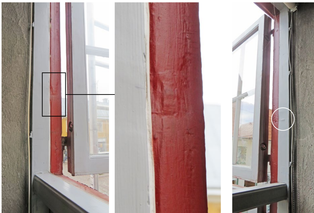
Fönster C9 med spår efter avsågad tvärpost inför renovering.
