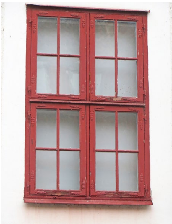
Fönster B1 inför arbetet.
