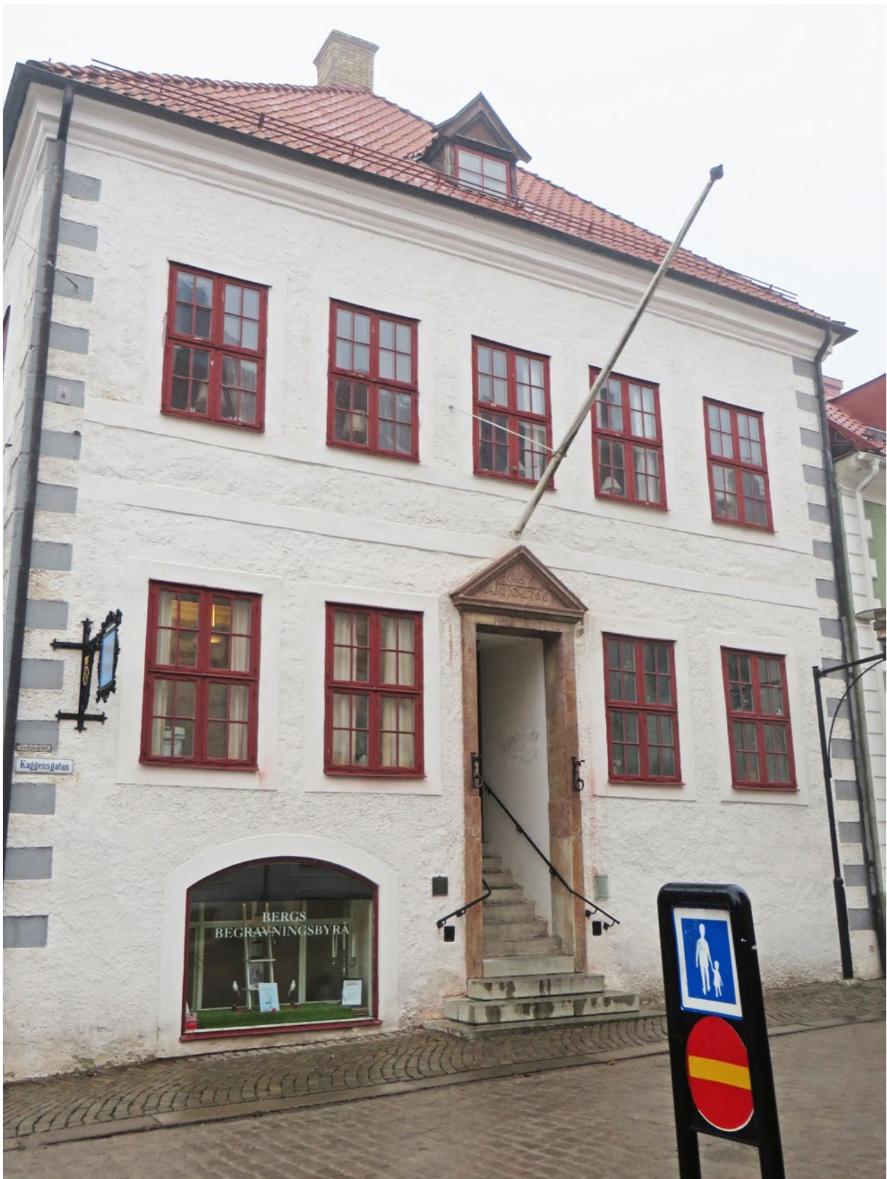
Fasad D inför arbetet.
