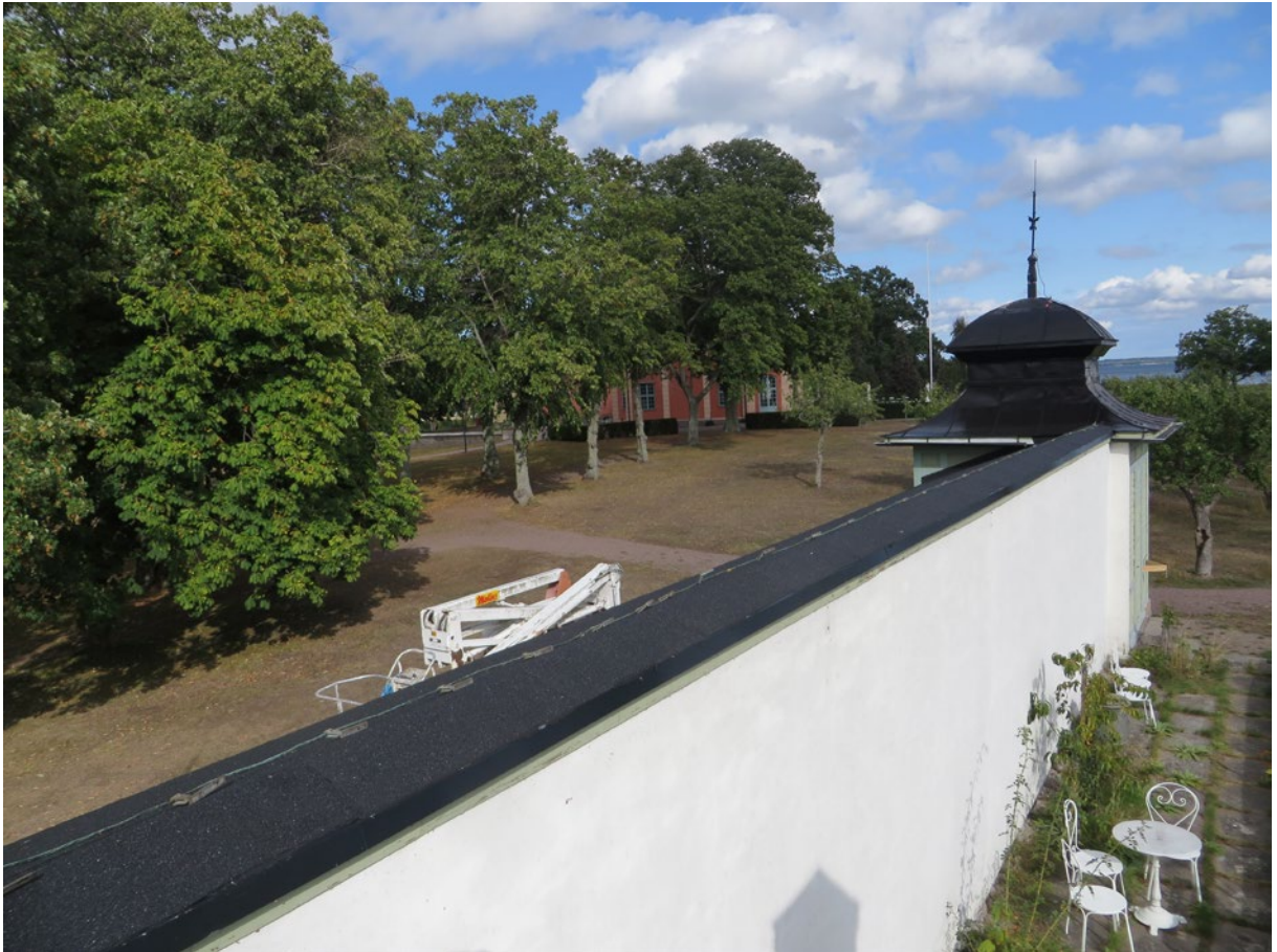
Här har ny takpapp lagts på pulpettakets, åskledaren är återmonterad och kupolerna målade.
