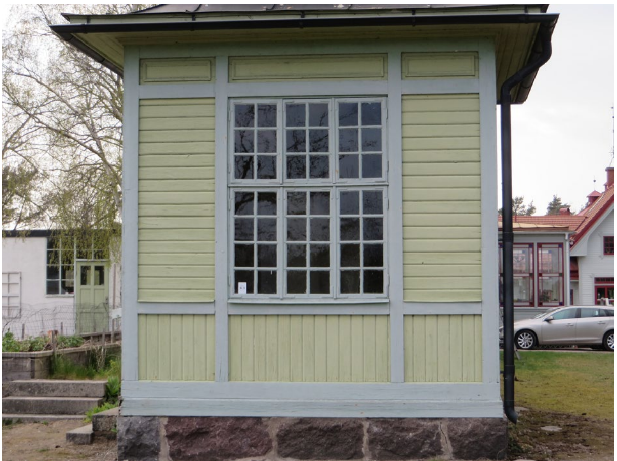
Fasad mot öster inför renovering.
