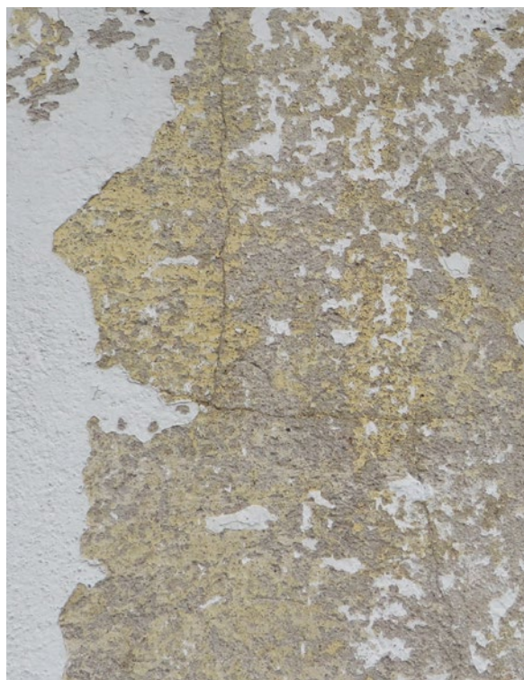
Södra fasadens putsparti vid kulörundersökning.
