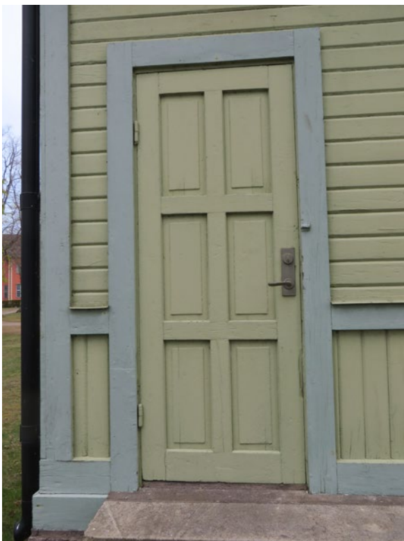
En av dörrarna i västra fasaden inför renovering.
