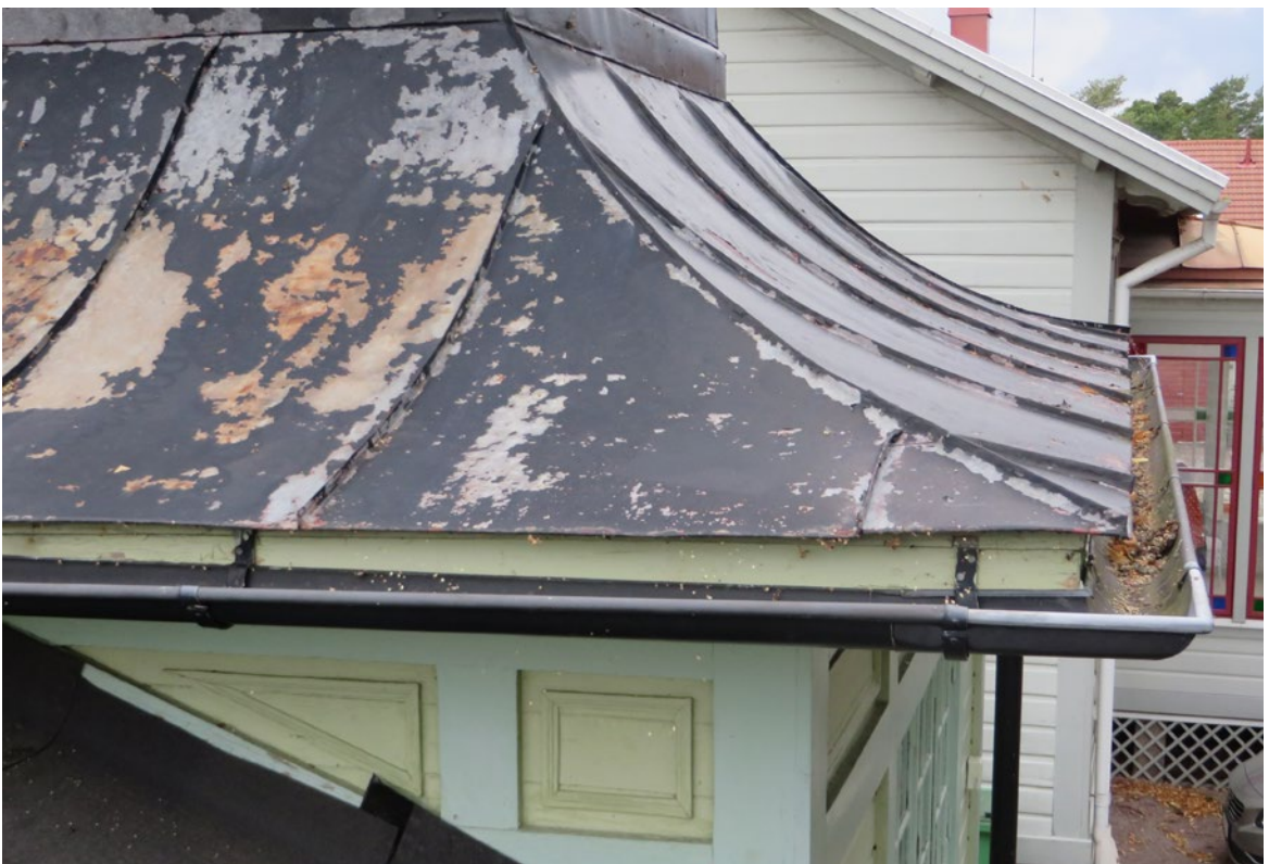
Detaljer av östra kupolen under skrapning.
