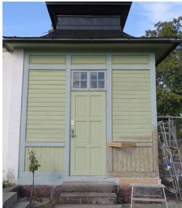
Fasad mot söder när arbetet med att frilägga panelen från färg påbörjats.
