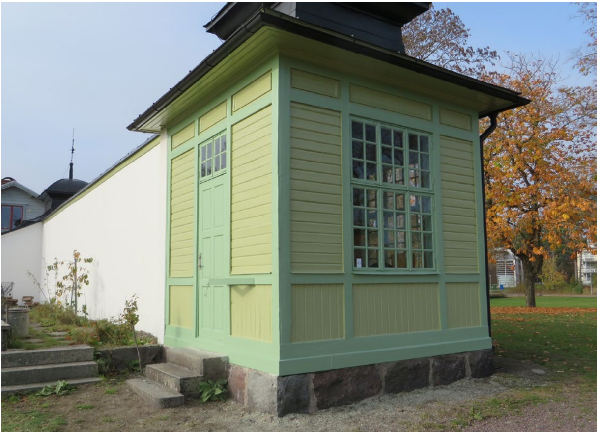
Kägelbanans södra och östra fasad färdigställd.
