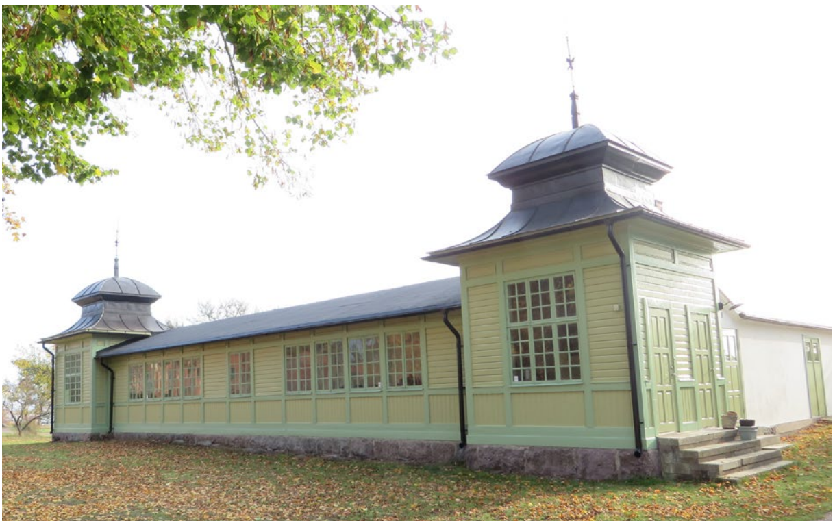
Tak och fasader färdigställda.
