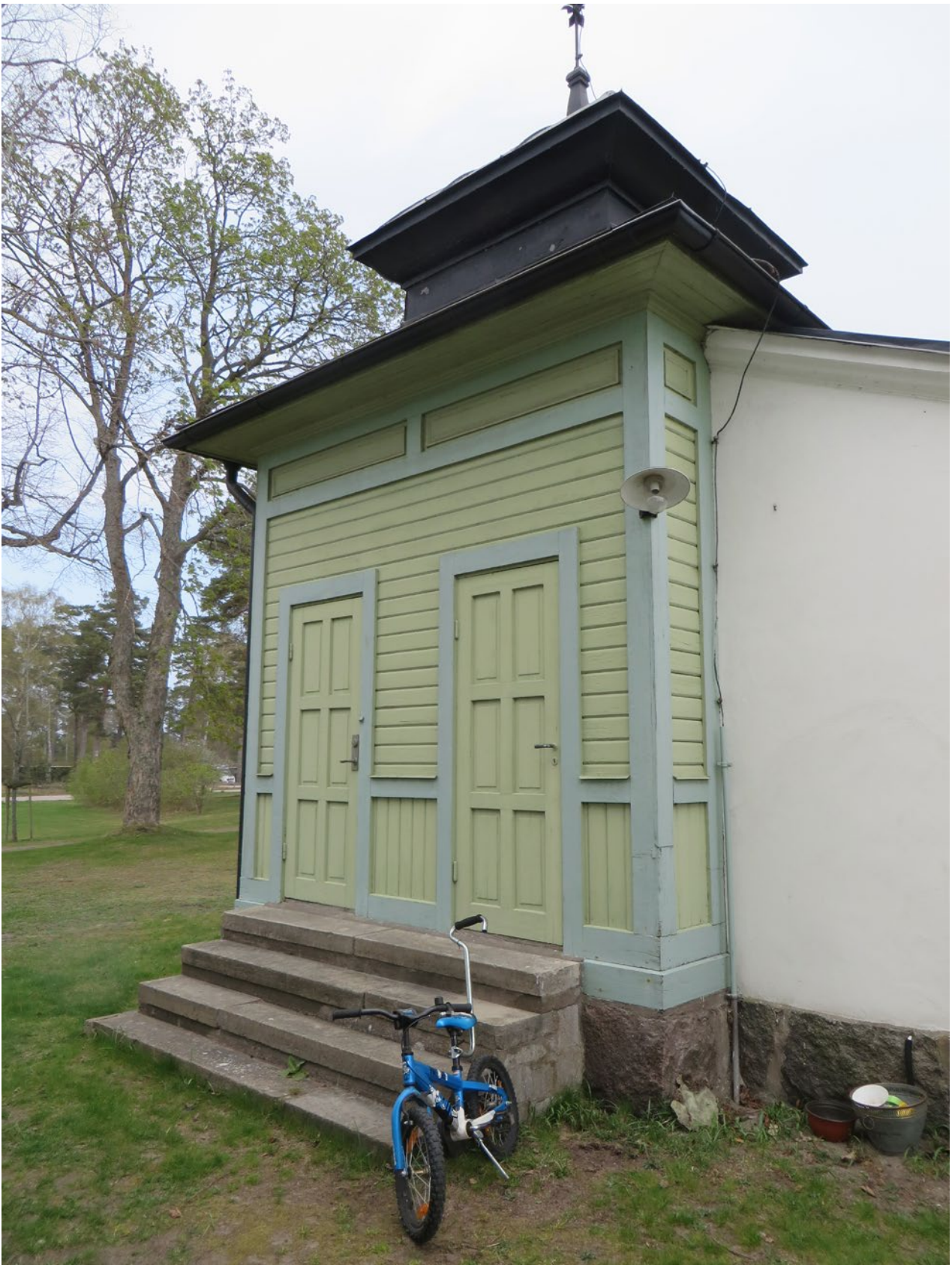
Fasad mot väster inför renovering.
