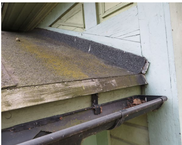
Mötet mellan takpapp och fasad under västra kupolen inför arbetet.
