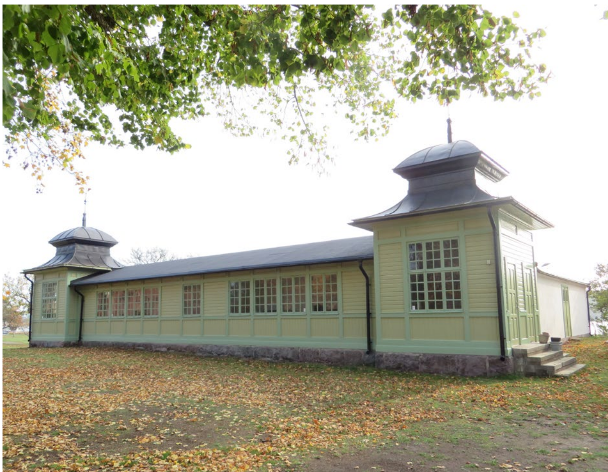
Tak och fasader färdigställda.
