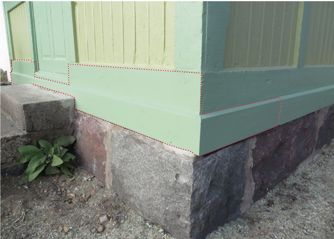
Detalj som visar sydöstra hörnet där lagning utfördes. Bytt material markerat med rödprickad linje.
