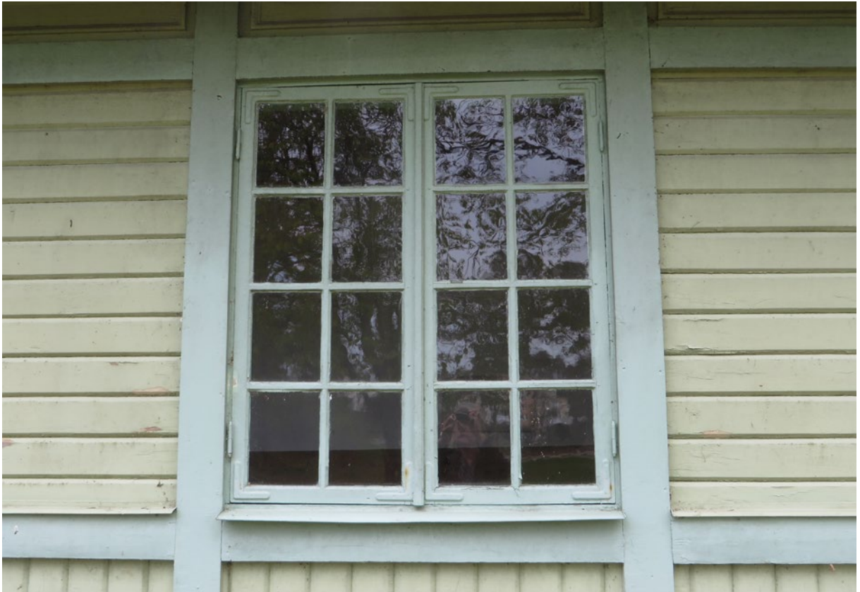
Ett av fönsterpartierna på norra fasaden inför renovering.
