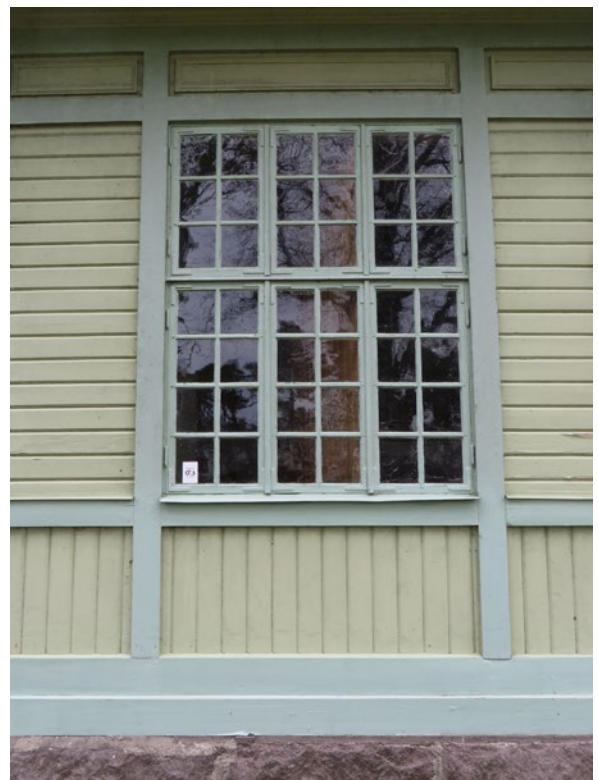
Ett av fönsterpartierna på norra fasaden inför renovering.
