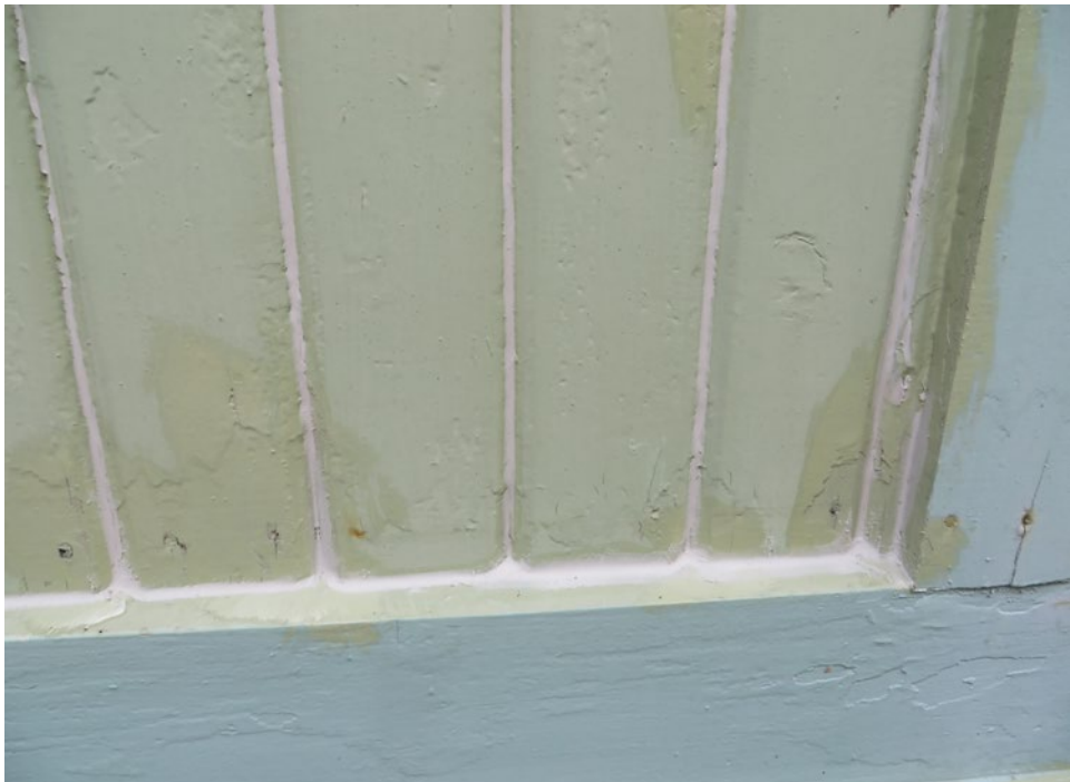
Detalj av fasad där kittning och viss grundmålning har gjorts efter tvätt och skrapning.
