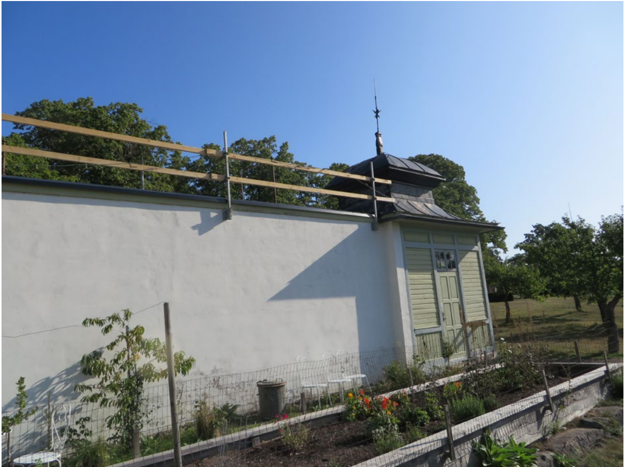
Fasad mot söder med delar av den putsade fasaden när skydd för takarbetet just monterats, men fasad- arbeten inte påbörjats.
