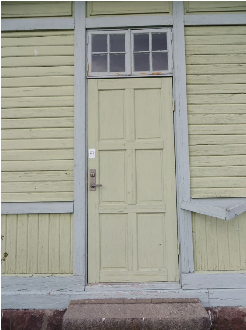
Huvudingången på södra fasaden med dörr och överljus.
