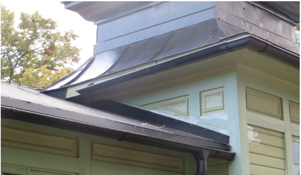
Här har ny takpapp lagts på pulpettakets och man ser anslutningen mellan tak och fasad. Pappen är uppvikts och spikad mot fasad på samma sätt som tidigare.
