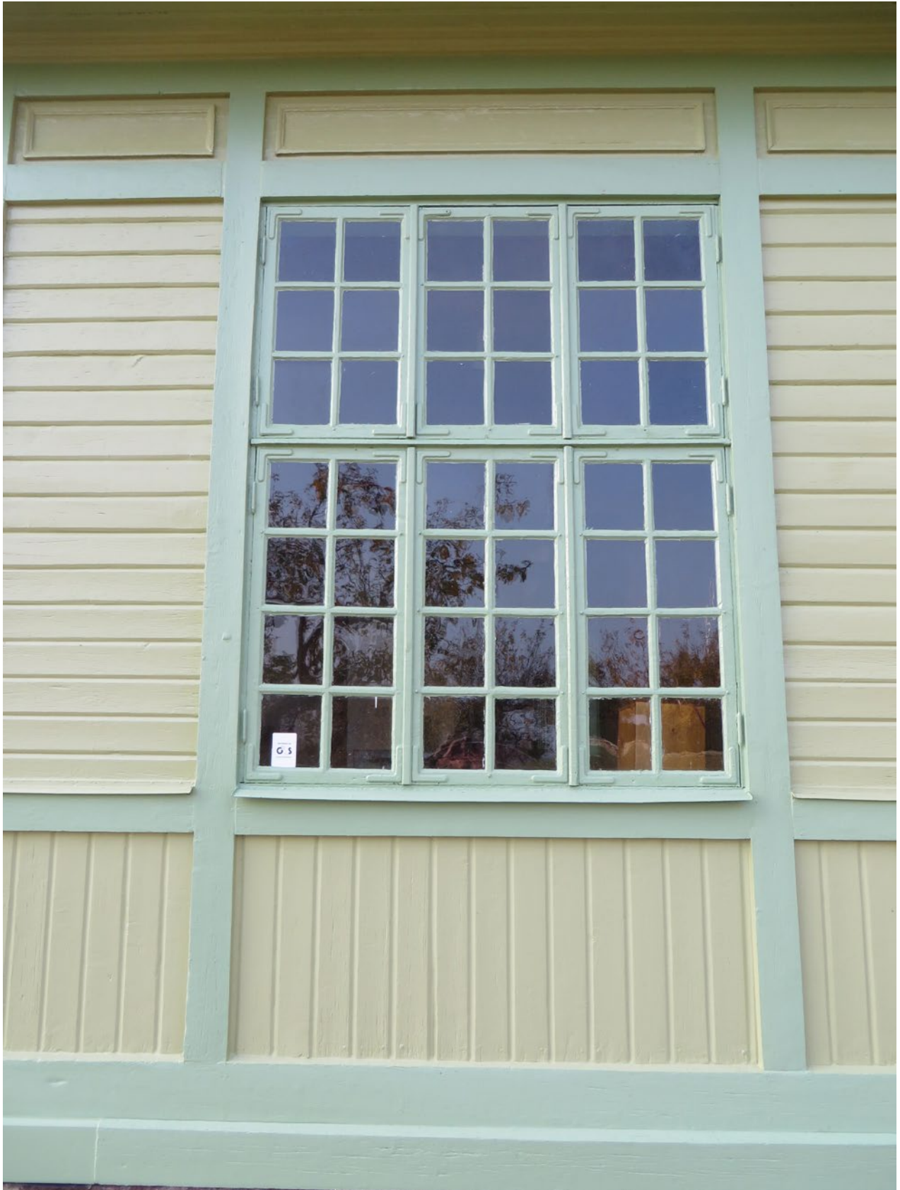
Östra fasadens fönsterparti efter slutfört arbete.
