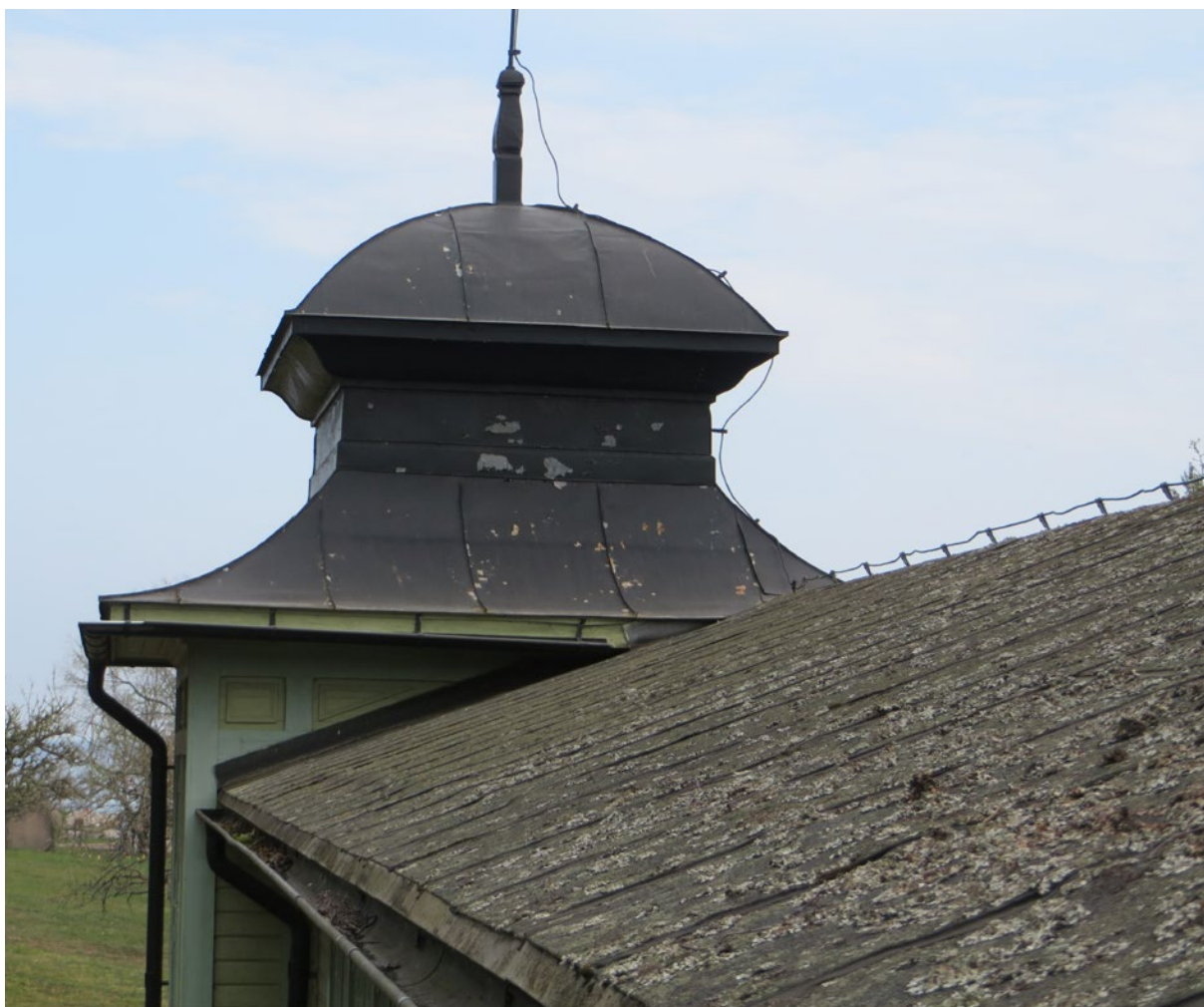
Östra kupolen och lite av takpappen inför arbetet.
