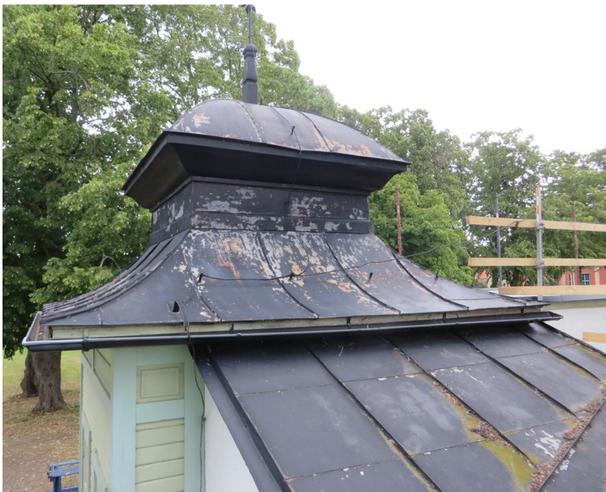
Skrapning av kupolen i väster har påbörjats. Här ser man också mötet mellan kupolen och packhusets tak. Den gamla plåten mellan kupol och rännal behölls. Resten av packhusets plåt byttes ut.
