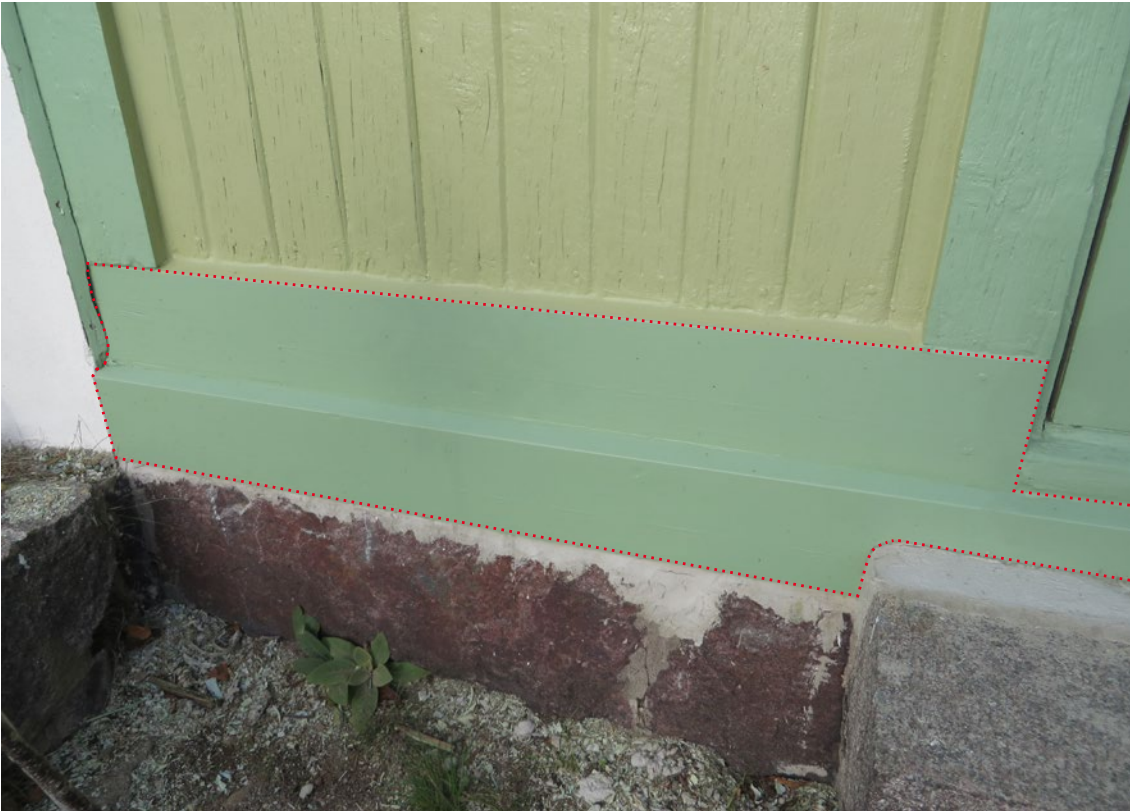
Detalj som visar del av fasad i söder där lagning utfördes. Bytt material markerat med rödprickad linje.
