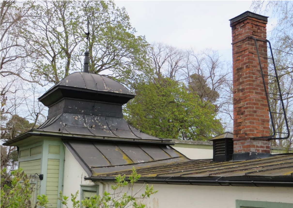
Västra kupolen inför arbetet.
