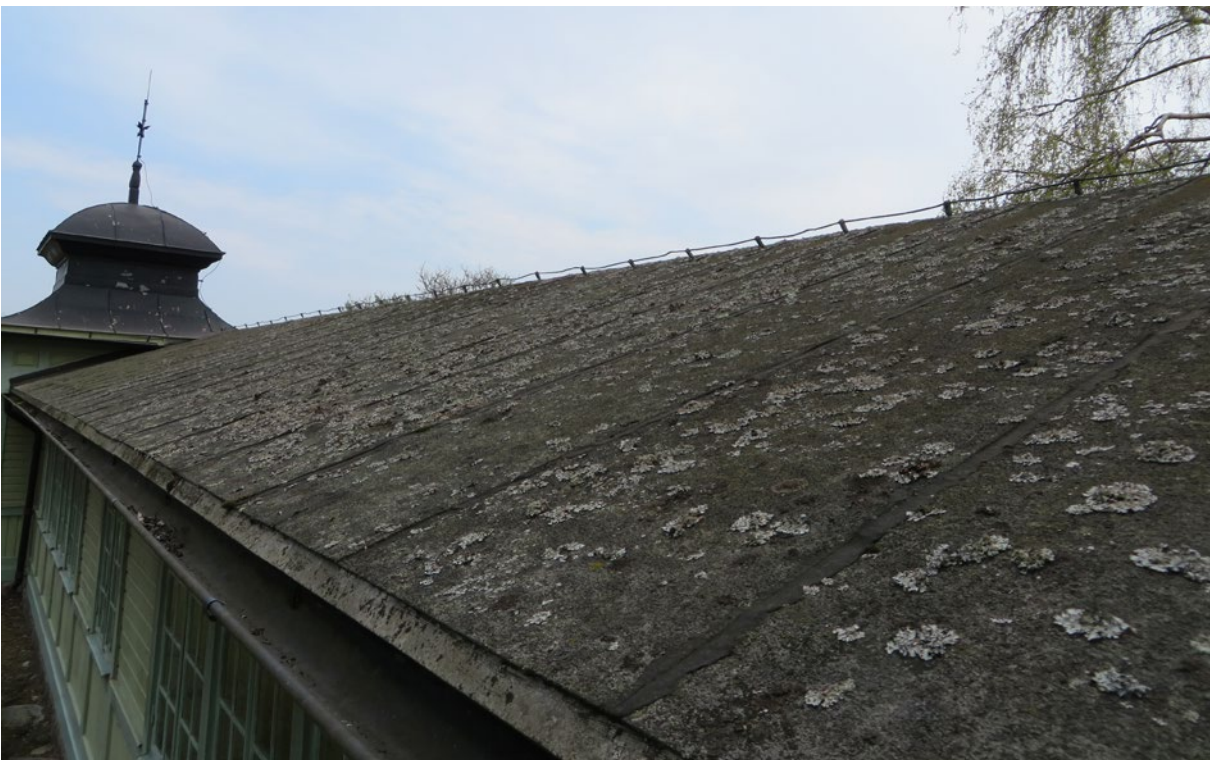
Taket inför omläggning.
