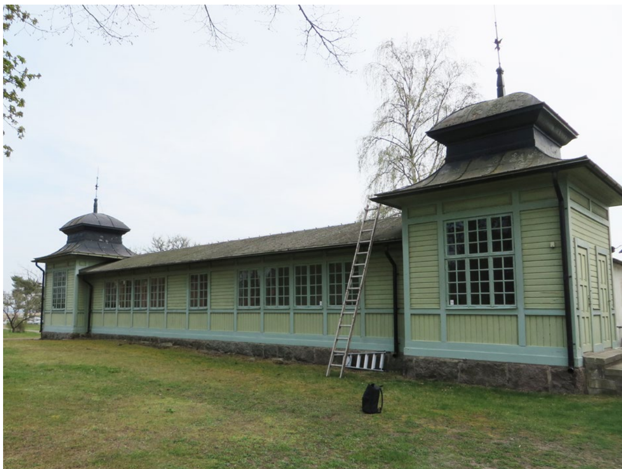
Kägelbanan mot norr inför renovering.
