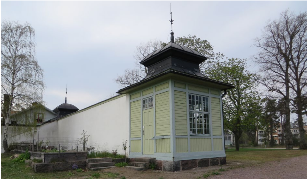
Kägelbanans södra fasad där merparten utgörs av putsad yta. Inför renovering.
