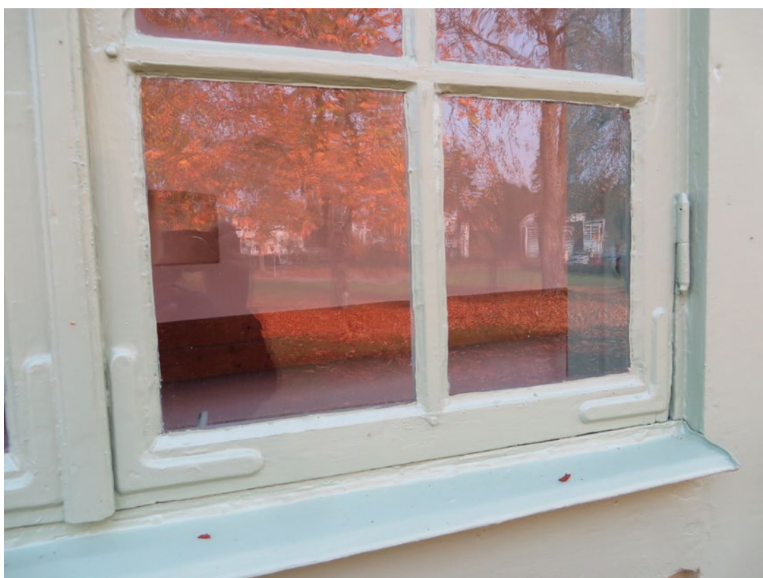
Detaljer av fönster mot norr efter slutfört arbete.
