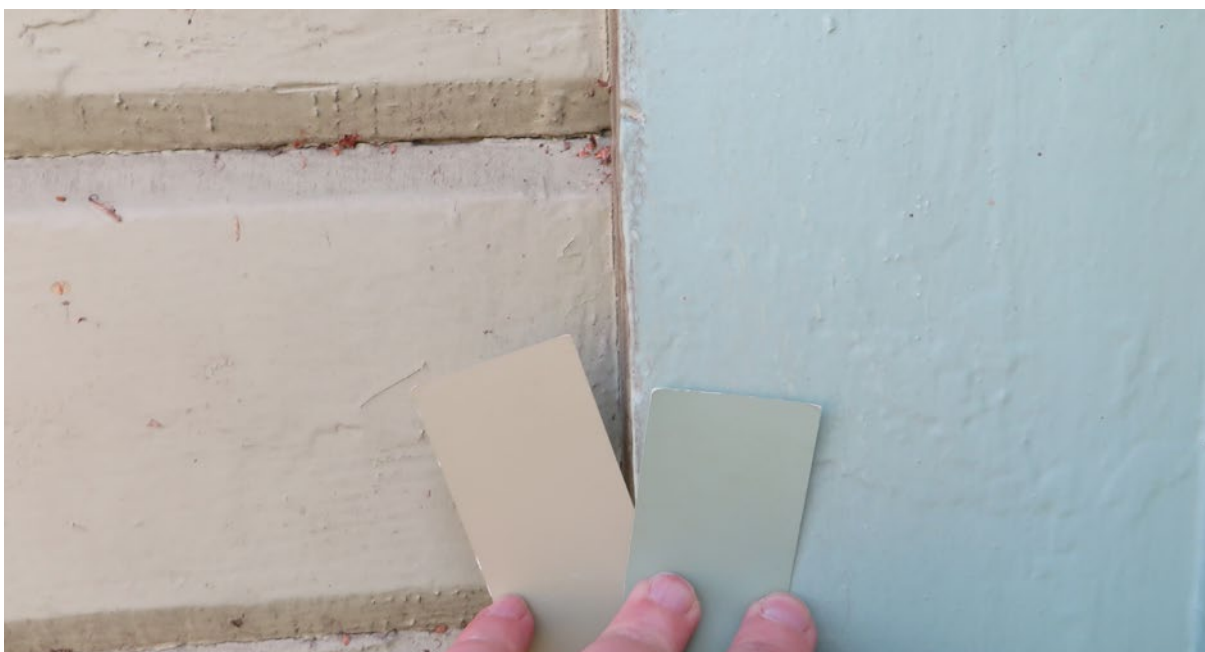
Nuvarande kulörer plockades ut med hänsyn till att färgskikten var blekta. Kulörundersökning på fasaden.
