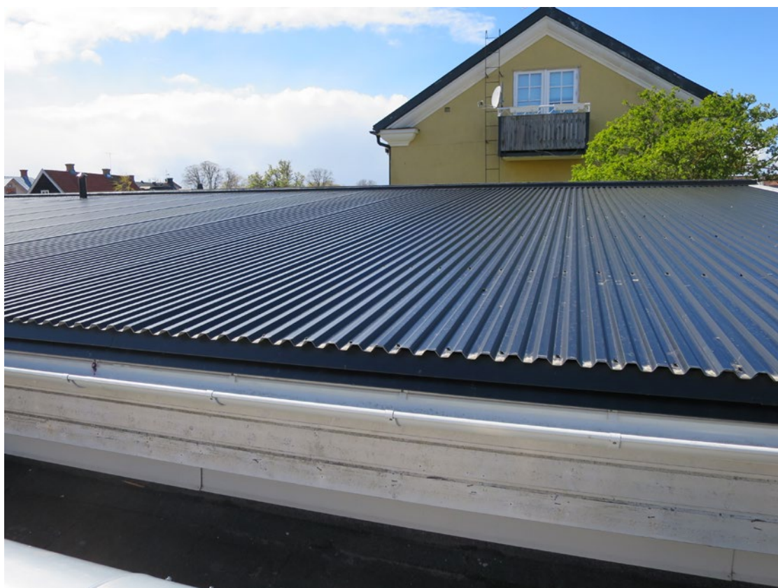
Tak efter åtgärd.
