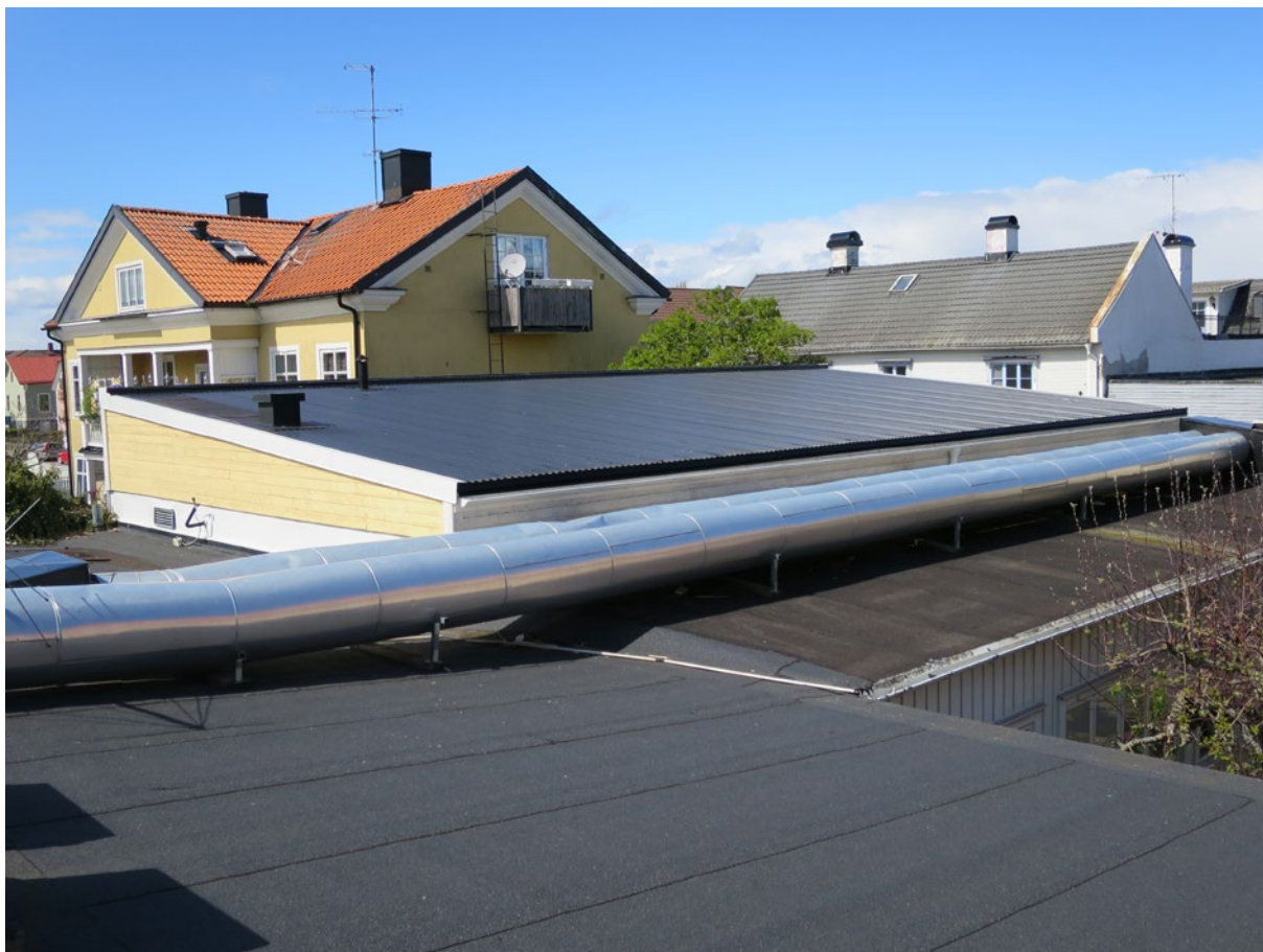
Tak efter åtgärd.
