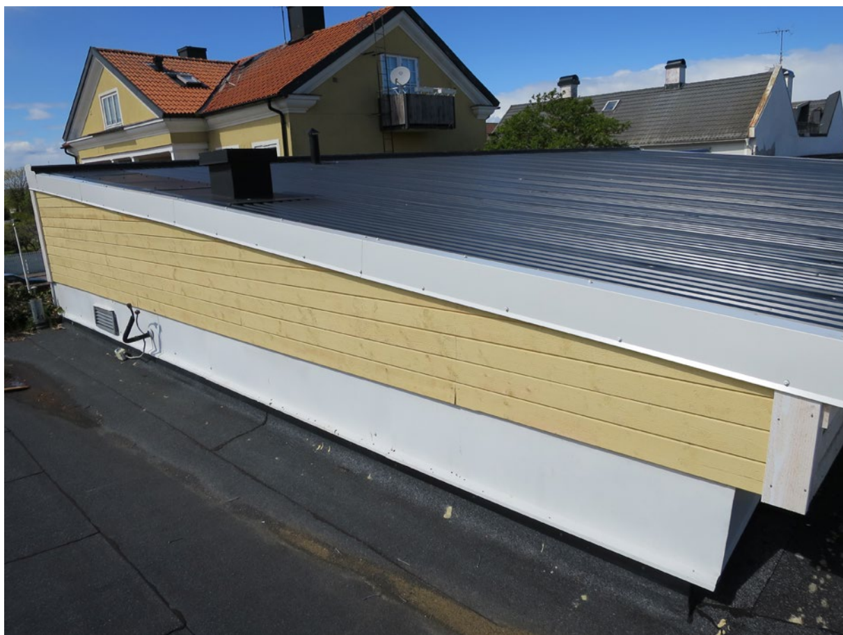
Tak och panel efter åtgärd.
