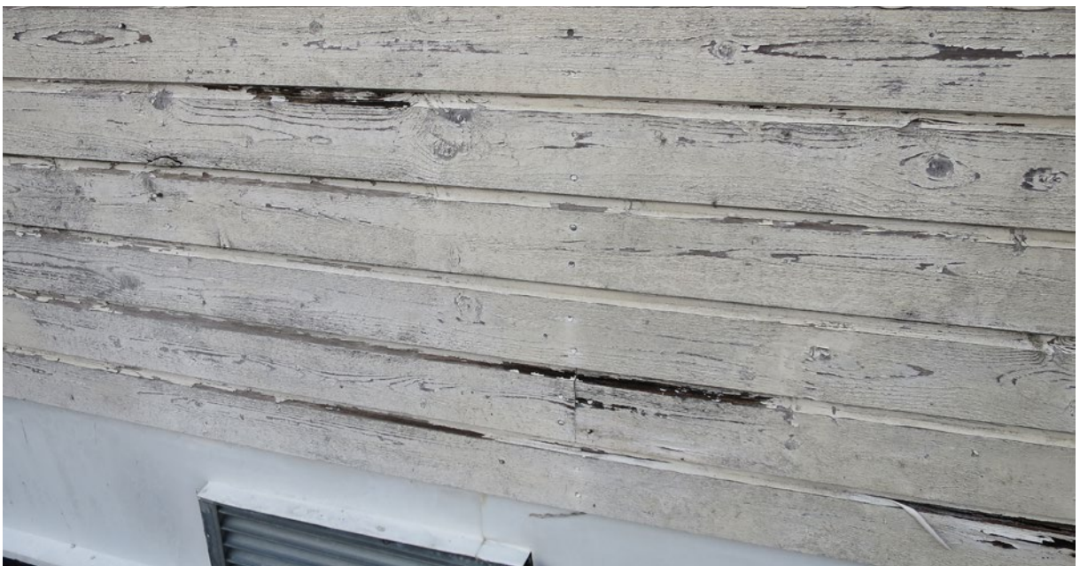
Takdelens sidopanel före åtgärd.
