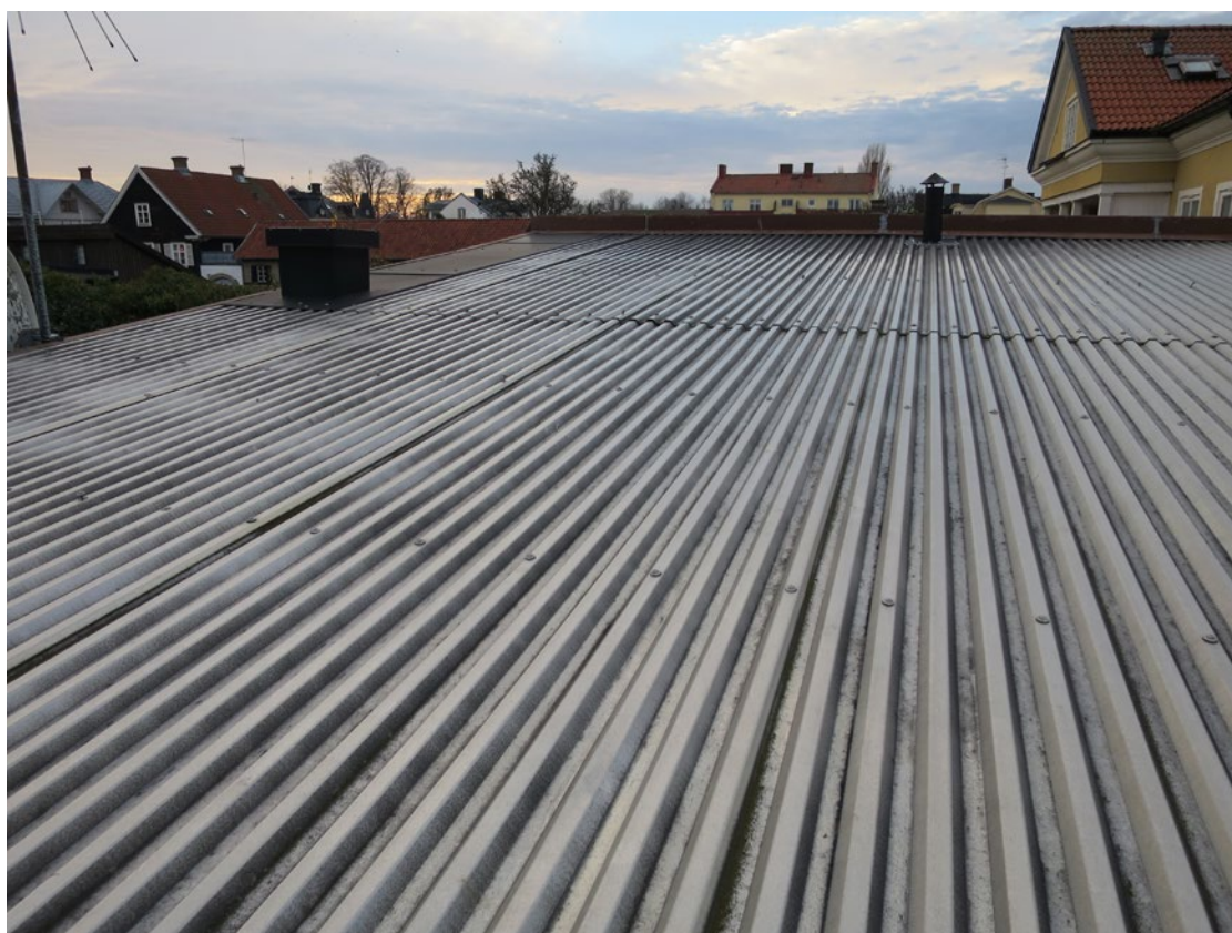
Tak före byte.
