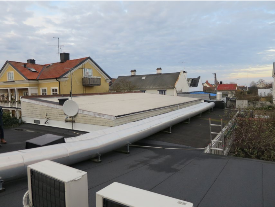
Tak före byte.
