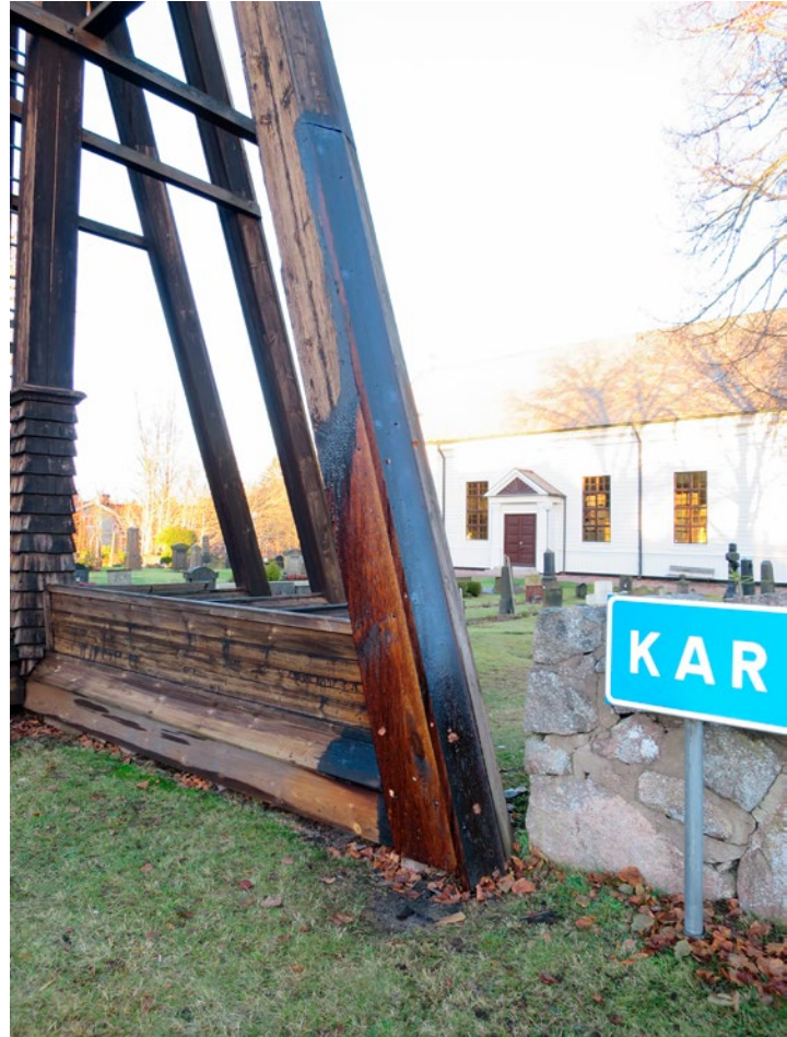
Ilagad brädklädning på lodrätta stödben.
