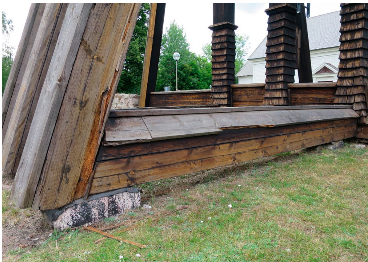
Klockstapeln före renoveringen, detaljbilder.
