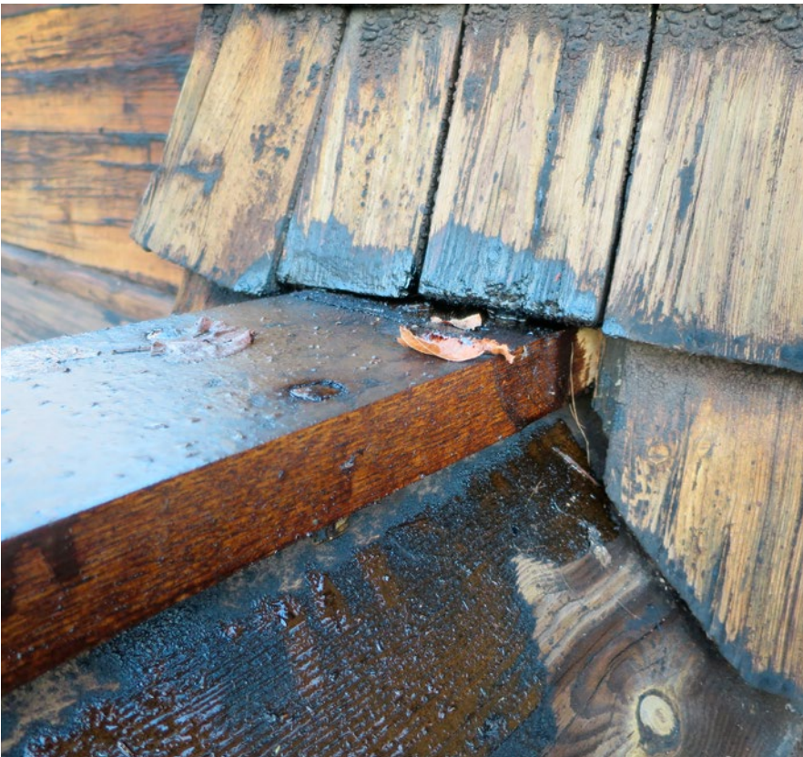
Ilagad brädklädning på lodrätta stödben.
