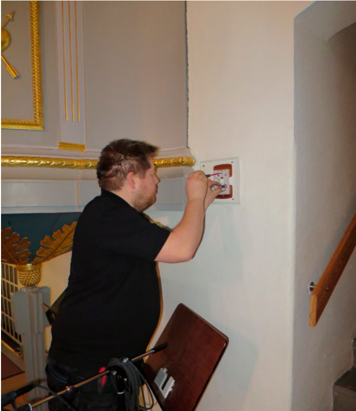
Bortmontering av tidigare givare i koret.
