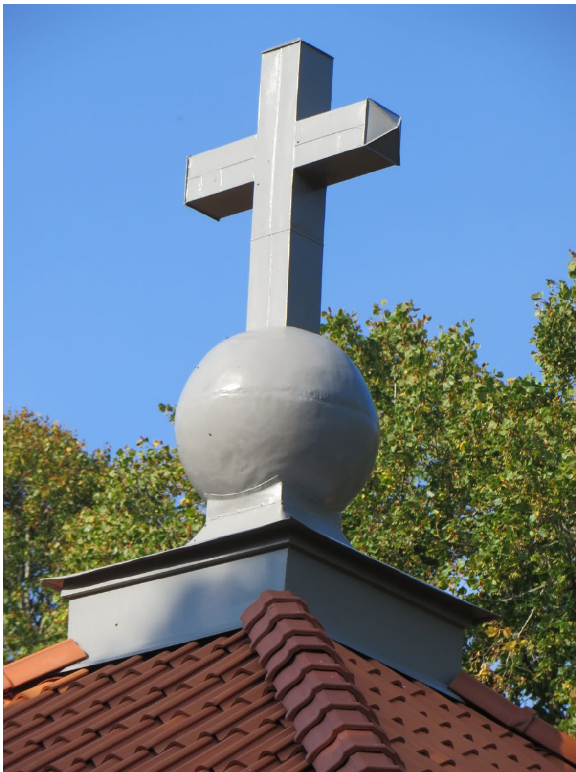
Korset efter åtgärd.
