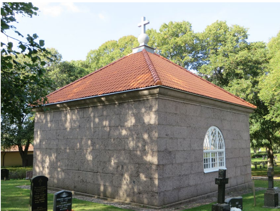
Gravkapellet efter åtgärd.
