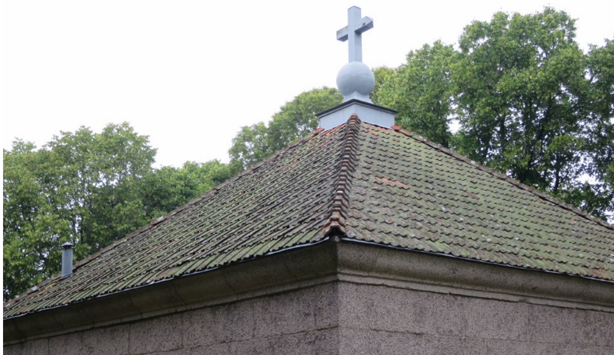
Tegeltaket före åtgärd.
