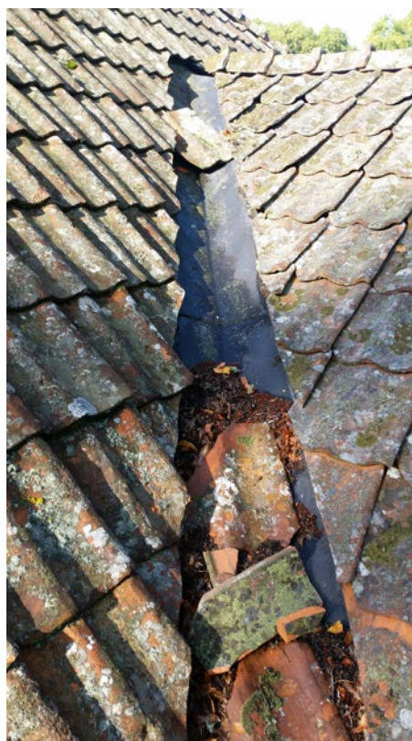
Rännnal före åtgärd.
