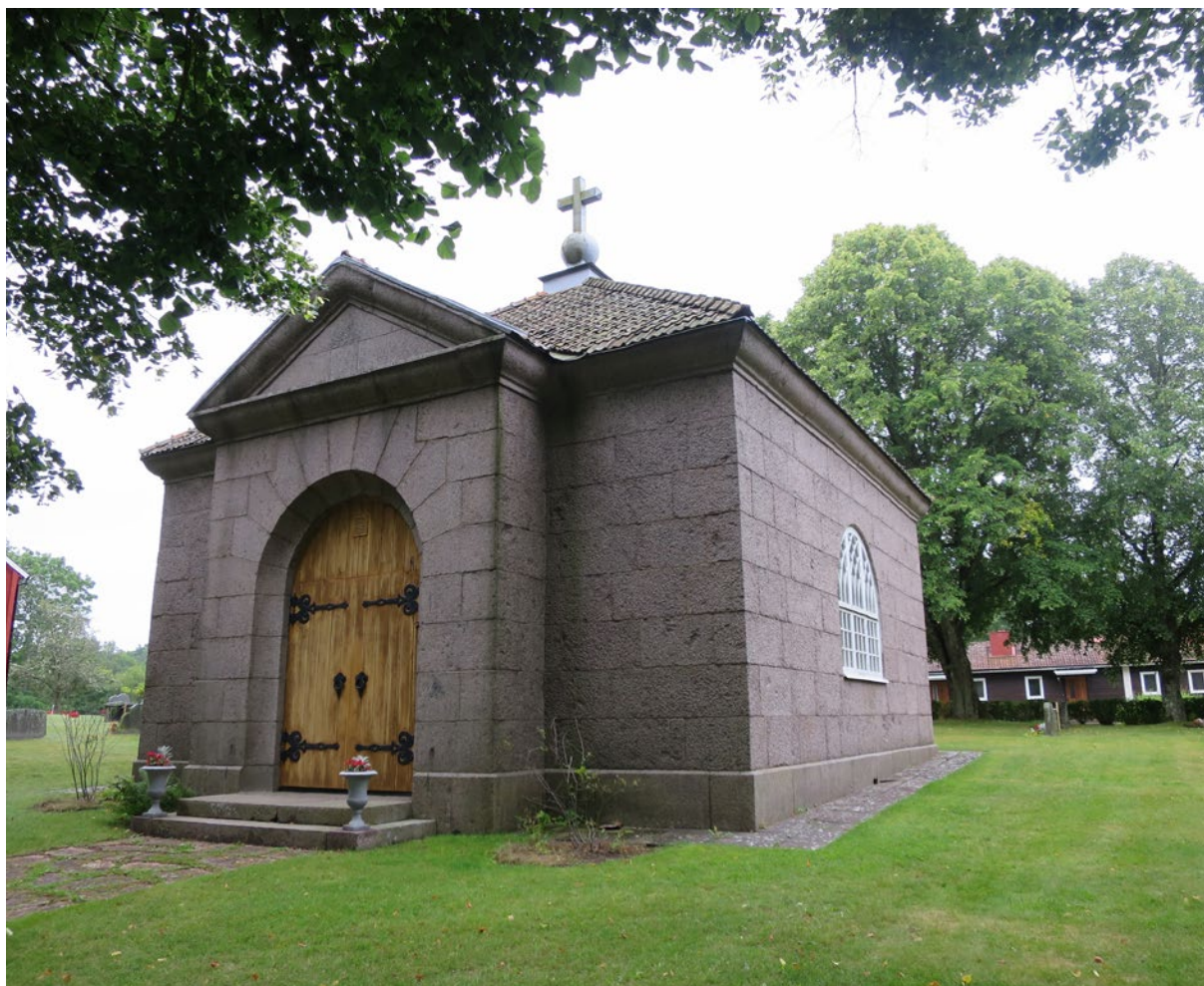
Gravkapellet före åtgärd.
