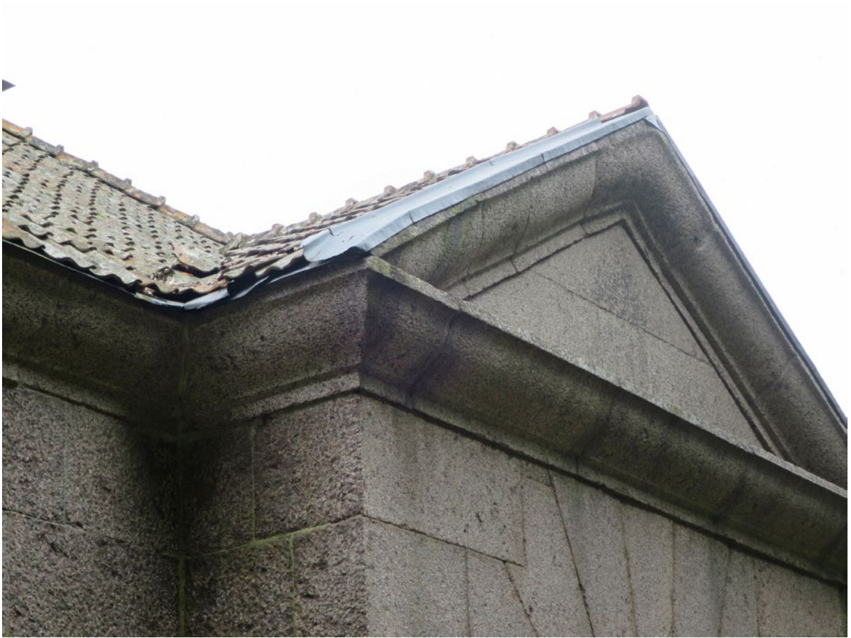
Tegeltaket före åtgärd.
