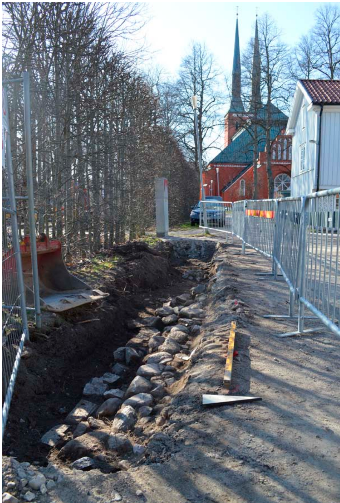
Fig. 15: Parti av den stenlagda vägen A217 framrensad. Lägg märke till de avlånga kantiga stenar som kantar vägens södra sida. Foto från öster.
