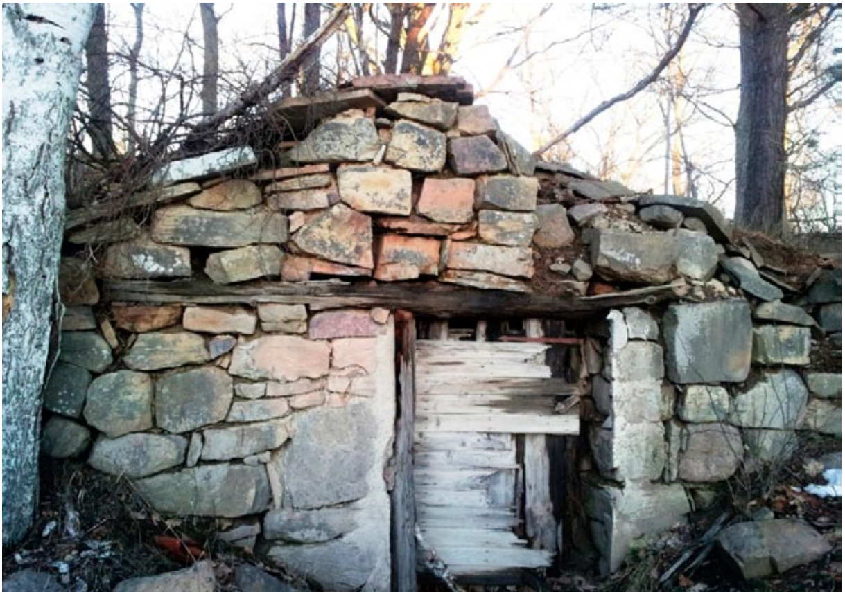
Fig. 14. Källaren (hus nr 9) som låg i slutningen på östra sidan av vägen. Bilden tagen från väster. Foto: Jonny Nilsson, 2013.
