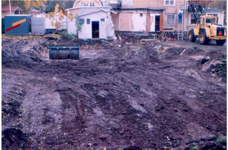
Fig 6. Översikt av schaktet, i bakgrunden hotellkroppen. Från Ö.
