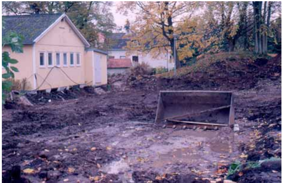
Fig 7. Översikt av schaktet, t h del av vallen. Från SV.
