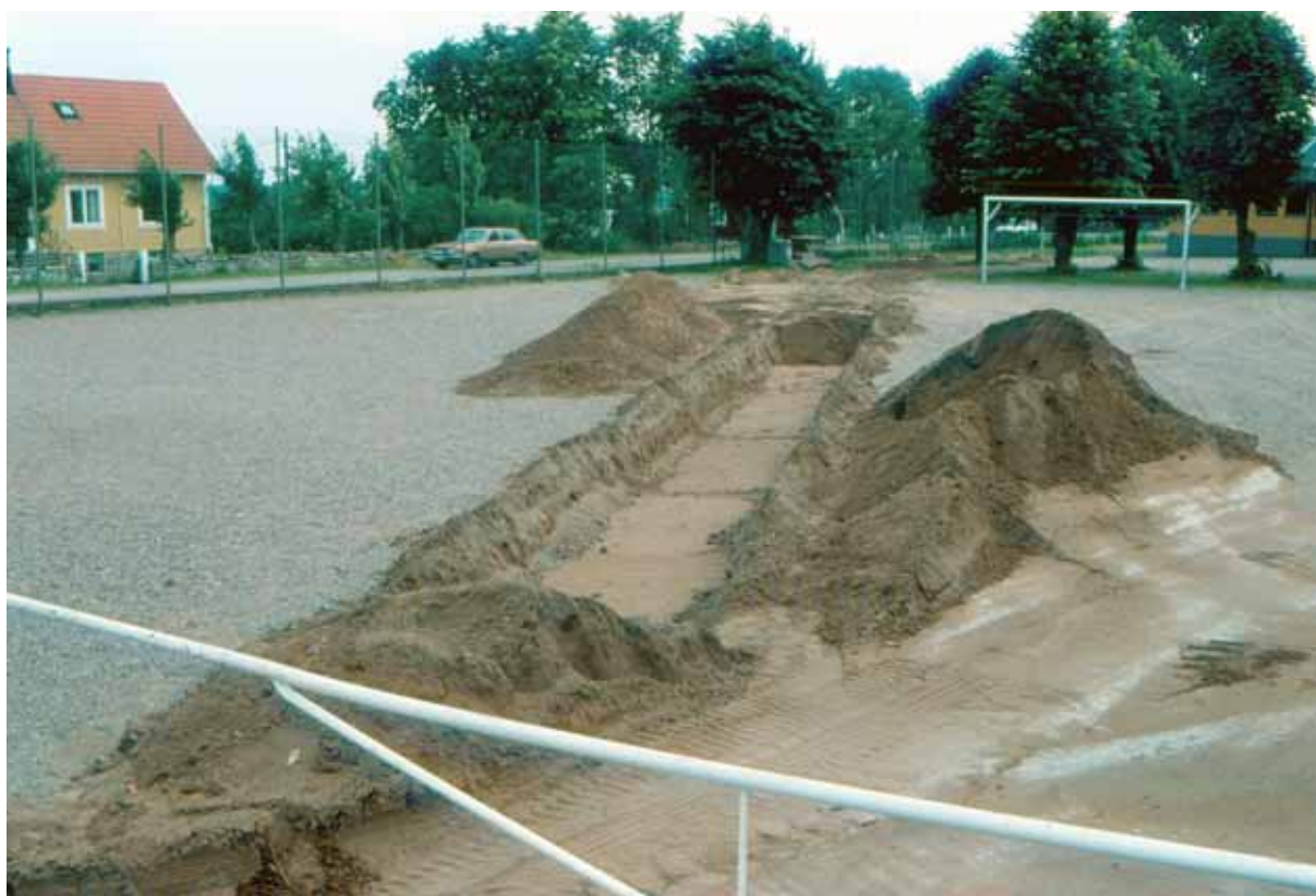
Fig 3. Va-schaktet öster om skolbyggnaden.
