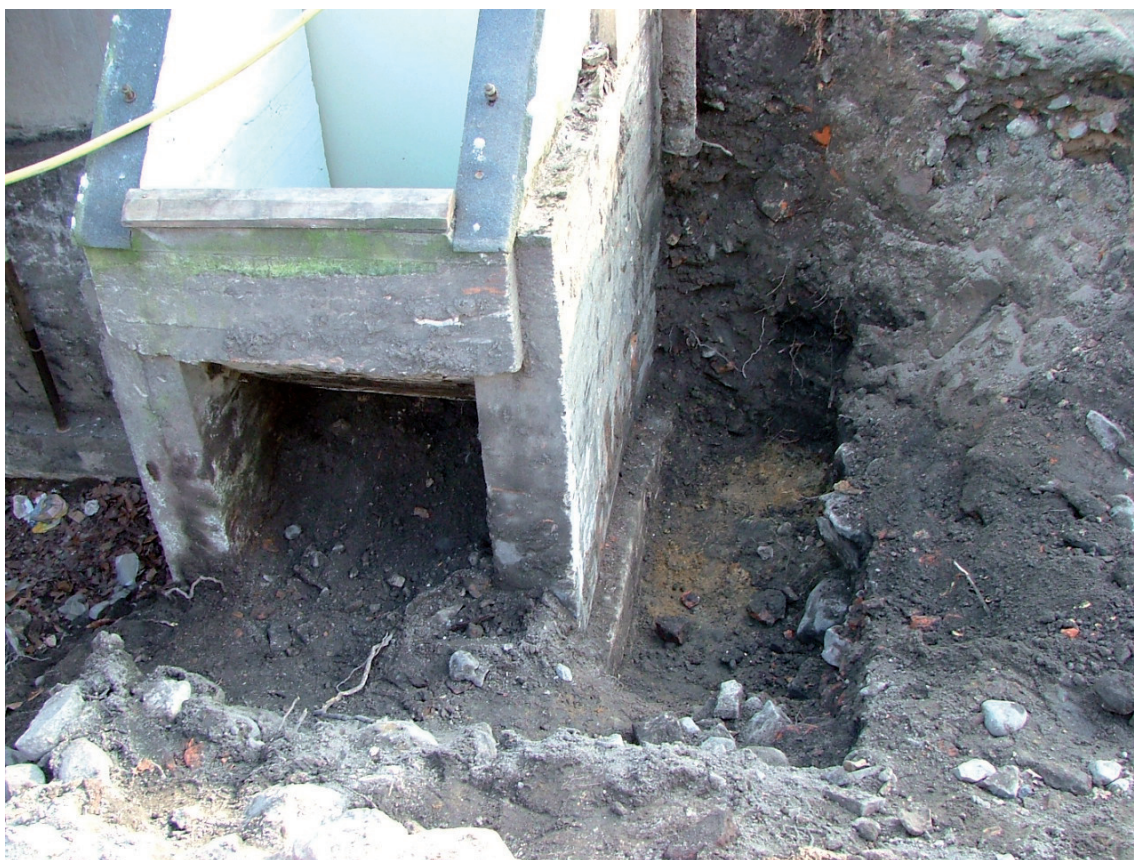
Fig.10. Källarnedgången vid Byttans NV hörn. Vid sidan om källaren synd det gamla dagvattenschakt som nu tömts. I botten syns den sterila sanden.
