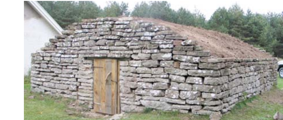
Nyrenoverad fristående källare i Sandby, innan torvtaket är pålagt.
