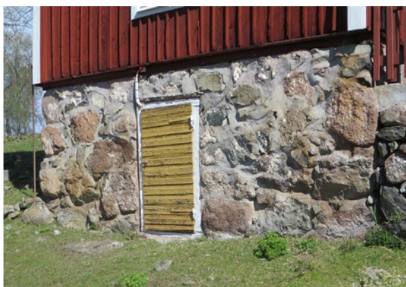
Hög källarsockel, tidigare putsad. Hus nr 6.
