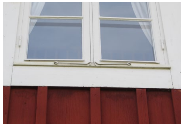
Modernt fönster med metallbleck i bågens bottenstycke och floatglas.
