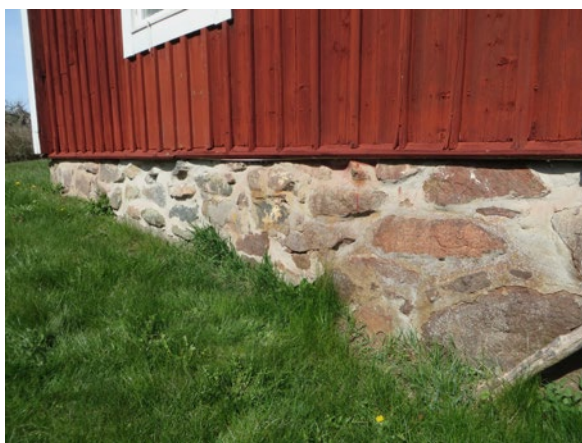
Sockel av natursten, delvis fogad med cement.
