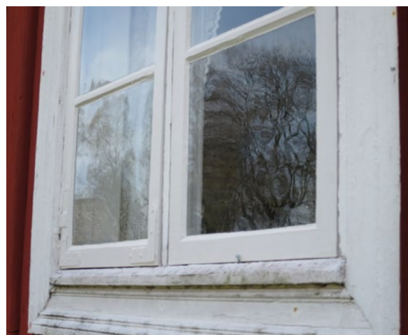
Bevarat fönster på hus nummer 8003 med gammalt munblåst glas och beslag.
