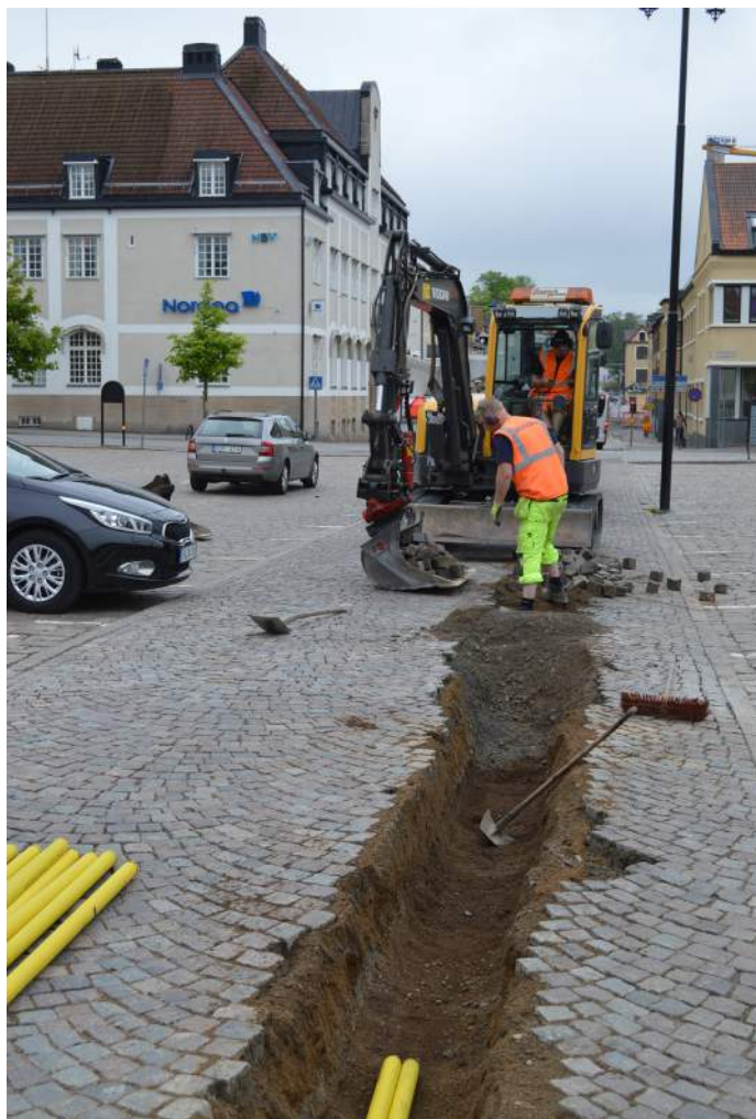
Figur 8. Schakt 350. Foto mot öster.
