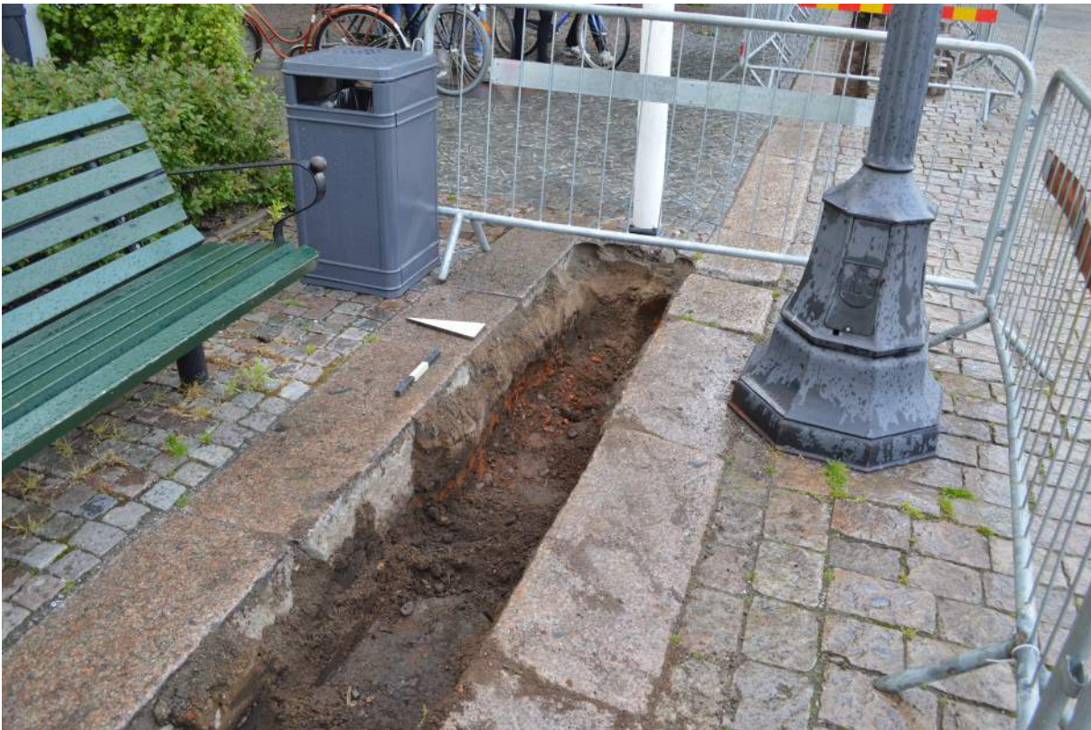
Figur 5. Schakt 210 framför residenset. I botten på schaktet syns raseringslagret L5003.
