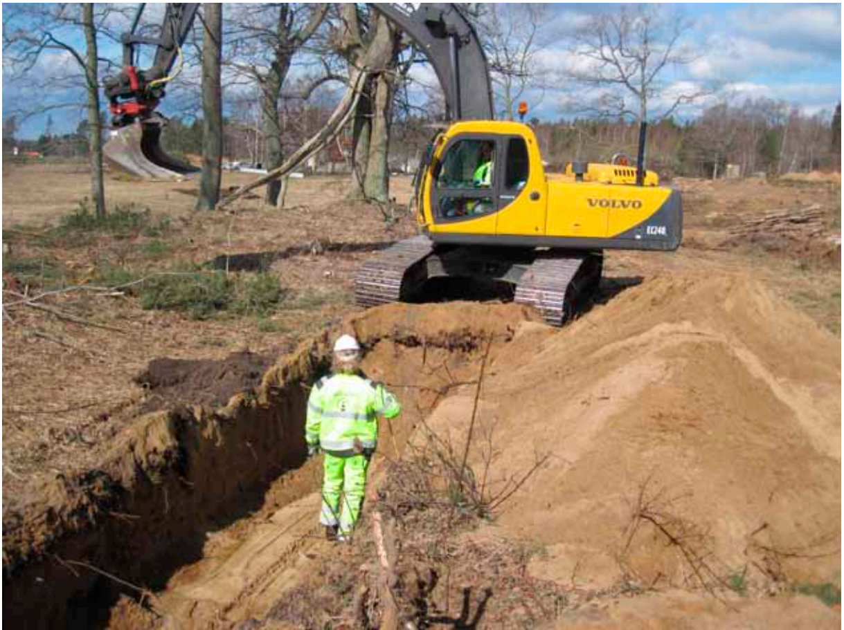
Figur 13. Kenneth Alexandersson djupschaktar i södra delen av sandåsen. Foto Ludvig Papehli-Dufay/KLM.
