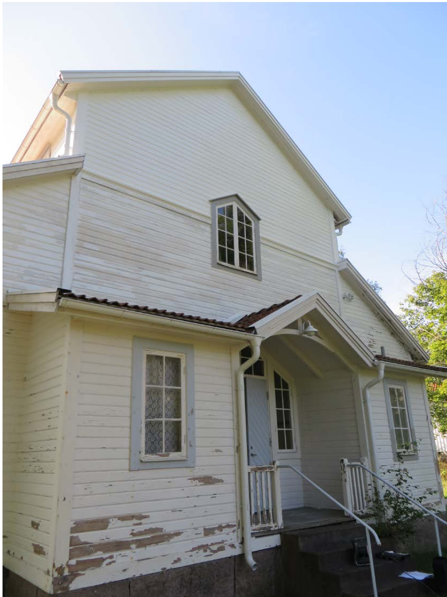
Under pågående ommålning. Vissa ytor är bara tvättade och skrapade. På övre delen mot väster börjar målningen bli klar.
