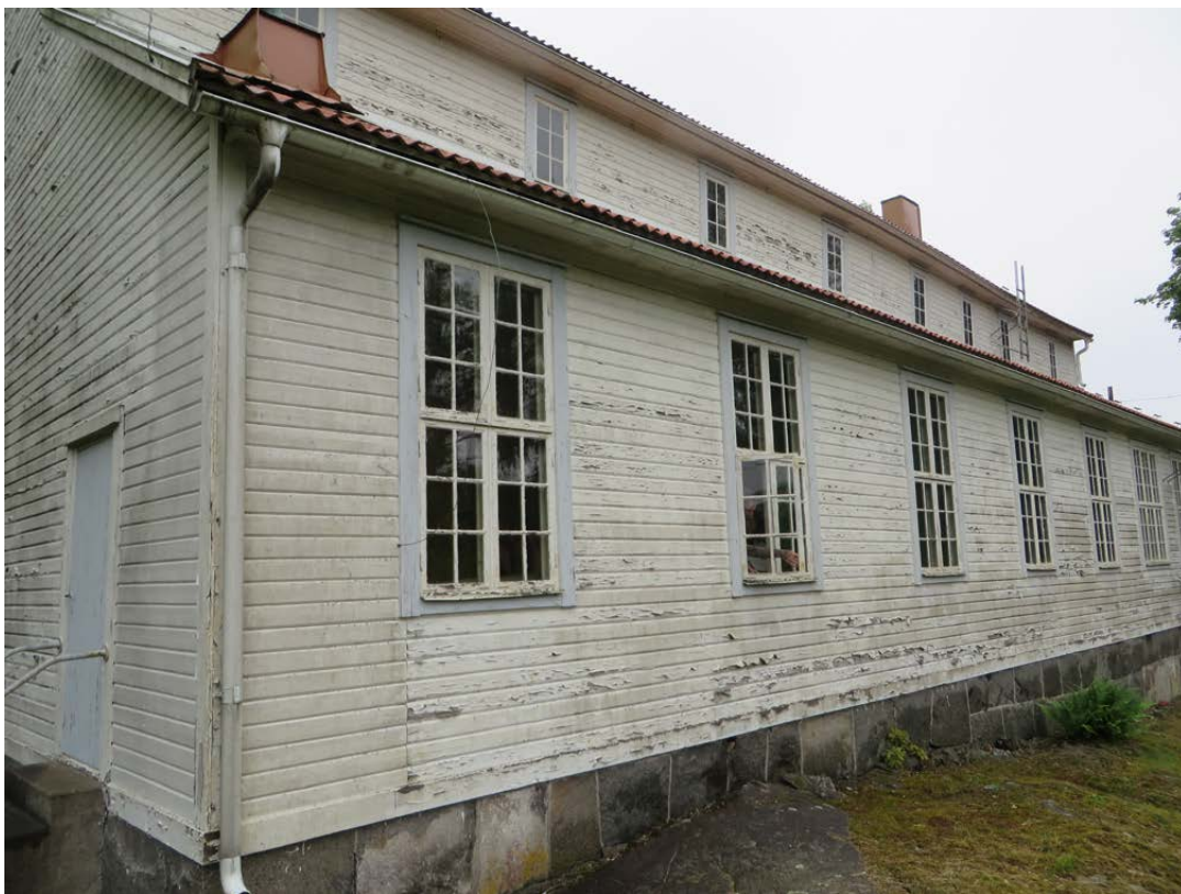
Norra fasaden inför ommålning.
