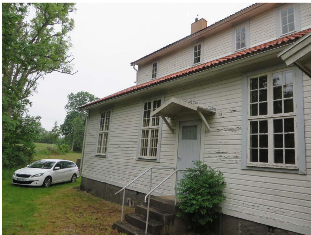
Delar av södra fasaden inför ommålning.
