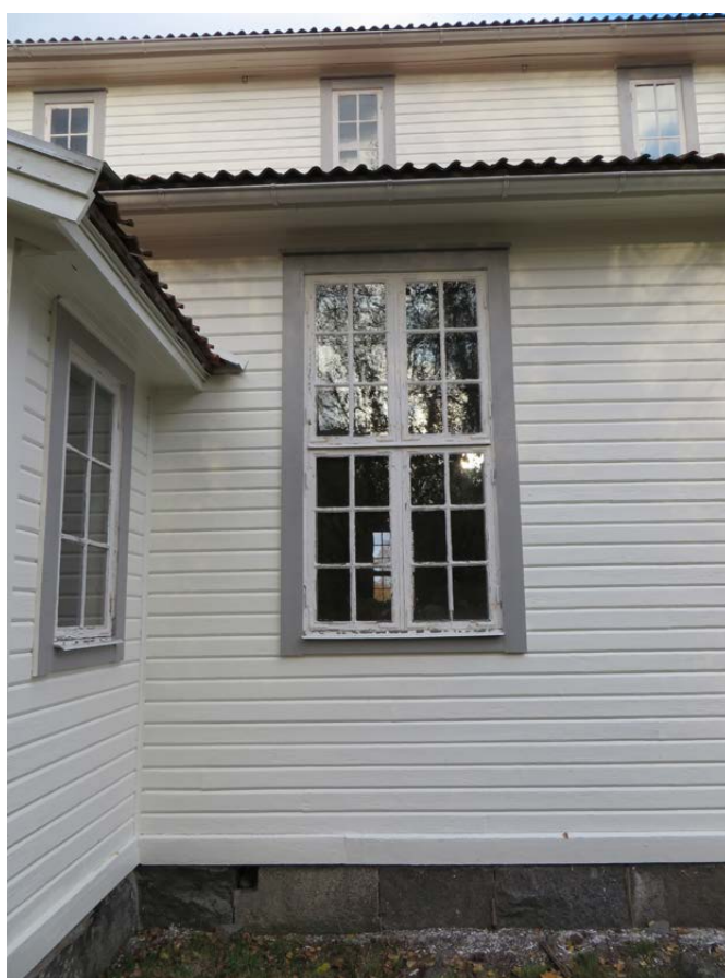
Ett parti av södra fasaden efter utfört arbete.
