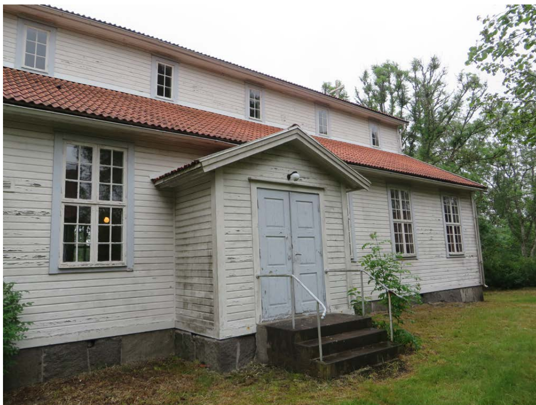
Delar av södra fasaden inför ommålning.
