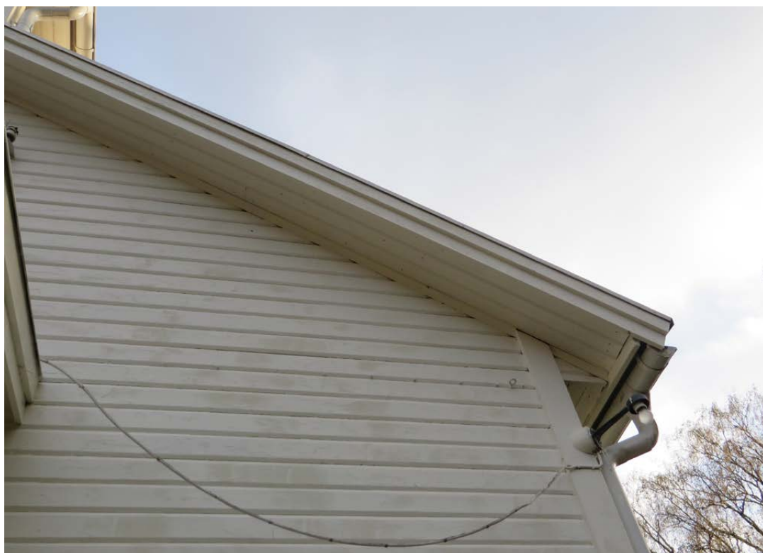
Underlaget i sydväst lagat med ny pärlspont. Här kan man se mattfläckarna som främst finns i väster och norr.
