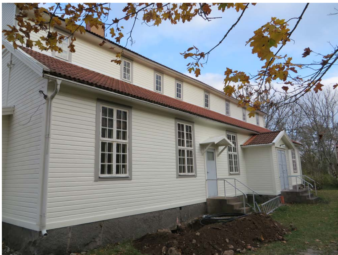
Ett parti av södra fasaden efter utfört arbete.
