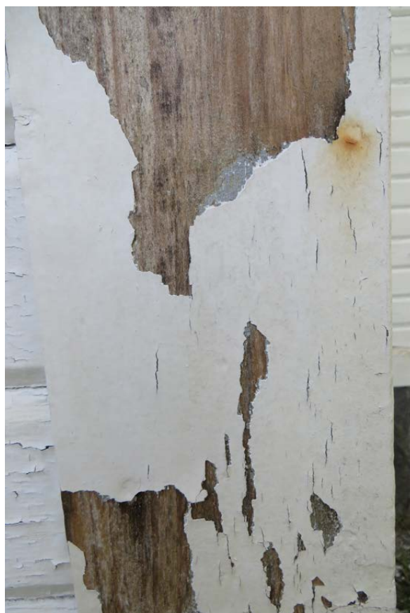
Knutbräda med grå färg underst NCS S 3502-Y visar att knutbrädorna i ett skede varit målade i grå kulör.
