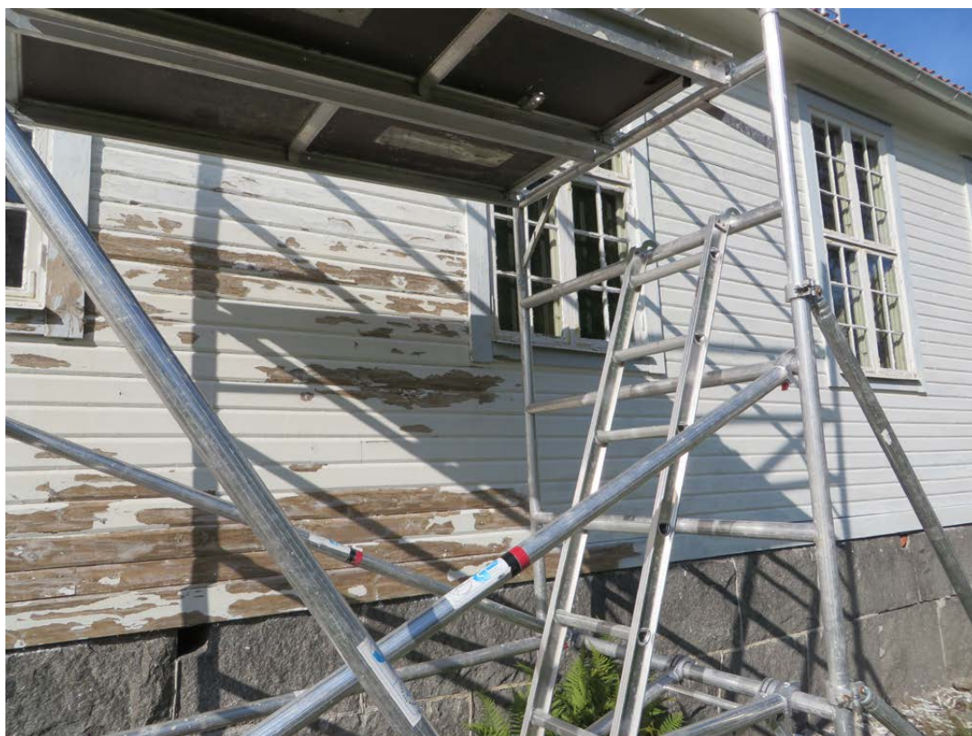
Skrapning pågår på norra fasaden.
