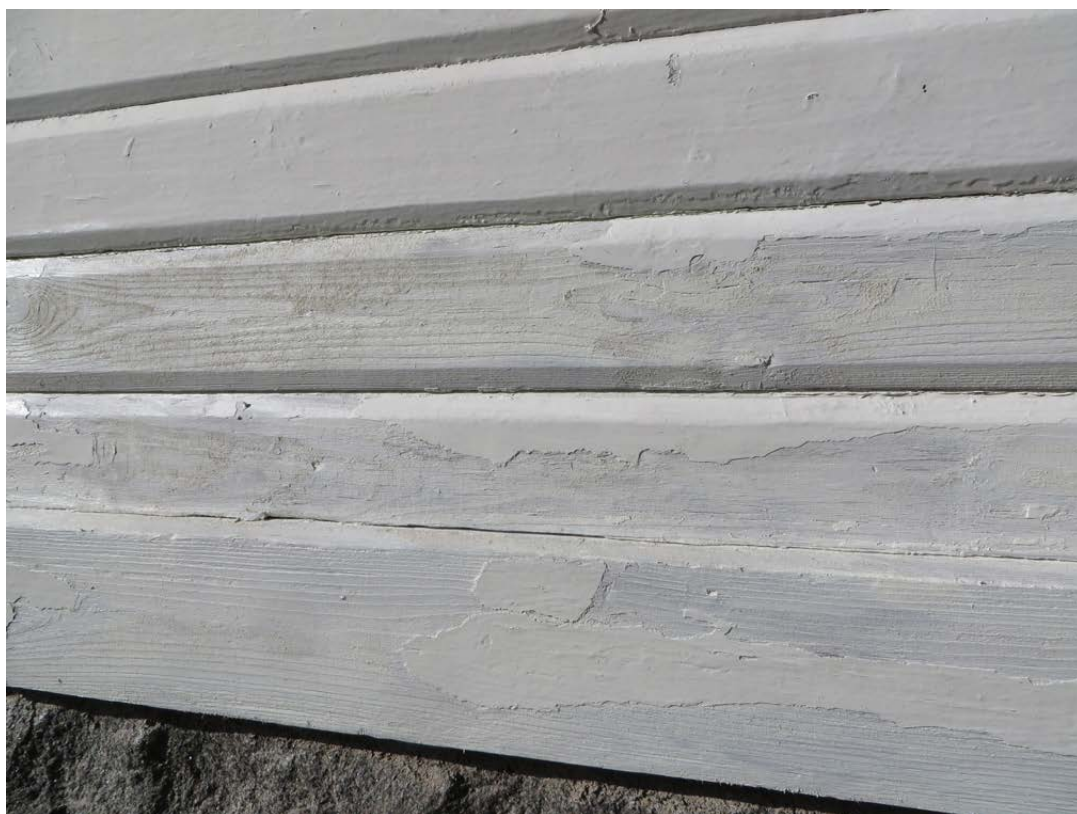
Grundmålad yta efter tvättning och skrapning.
