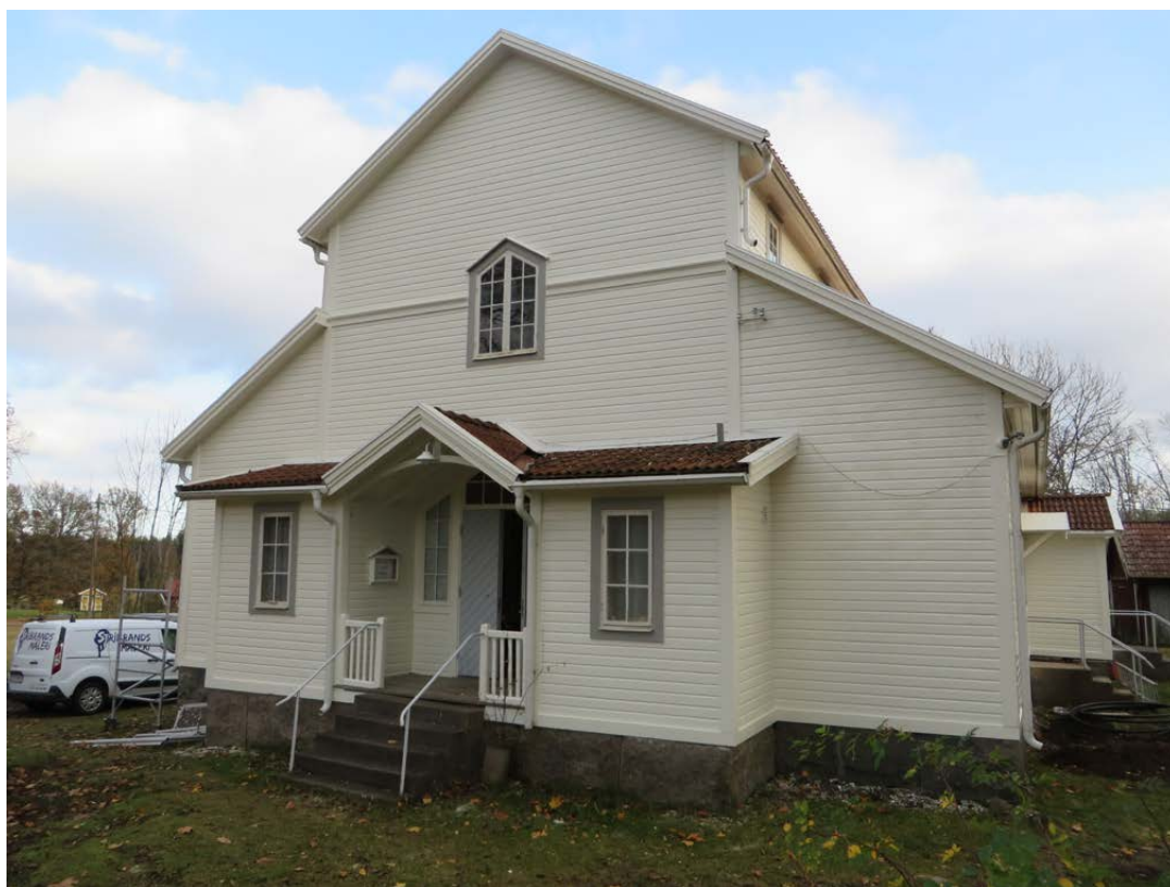
Kapellets västra fasad efter utfört arbete.
