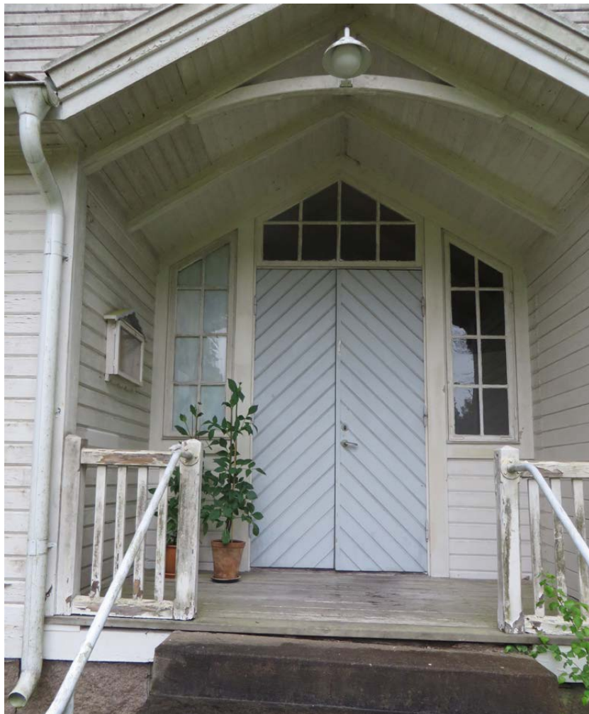
Entrén i väster inför ommålning.
