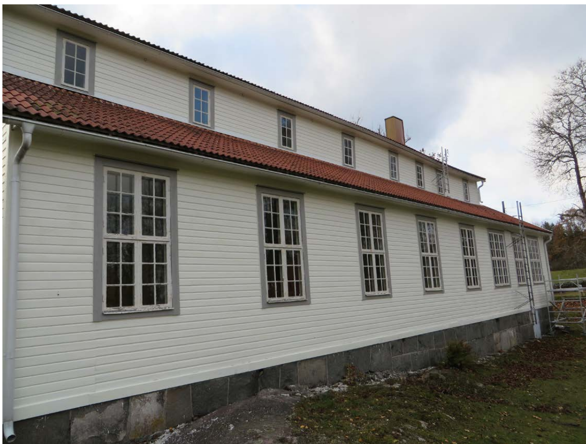
Norra fasaden efter utfört arbete.
