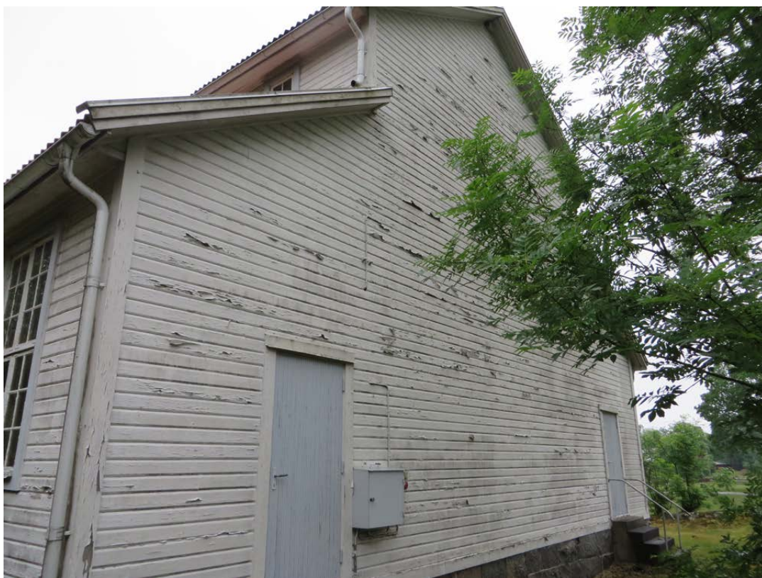
Östra fasaden inför ommålning.
