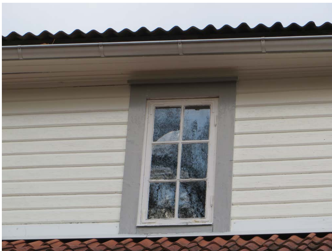
En del av mittskeppets höga södra sida efter utfört arbete.
