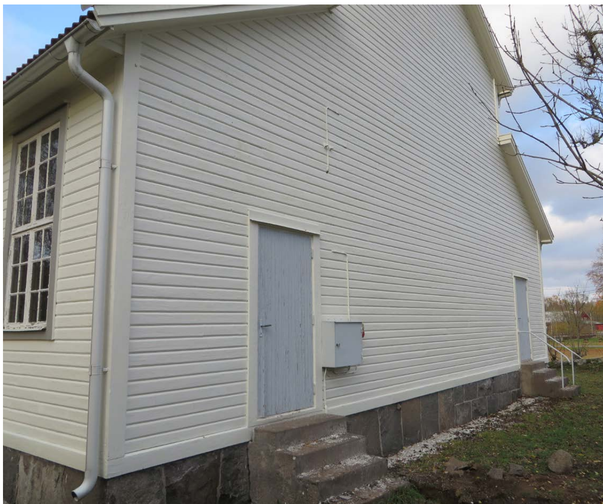
Östra fasaden efter utfört arbete.
