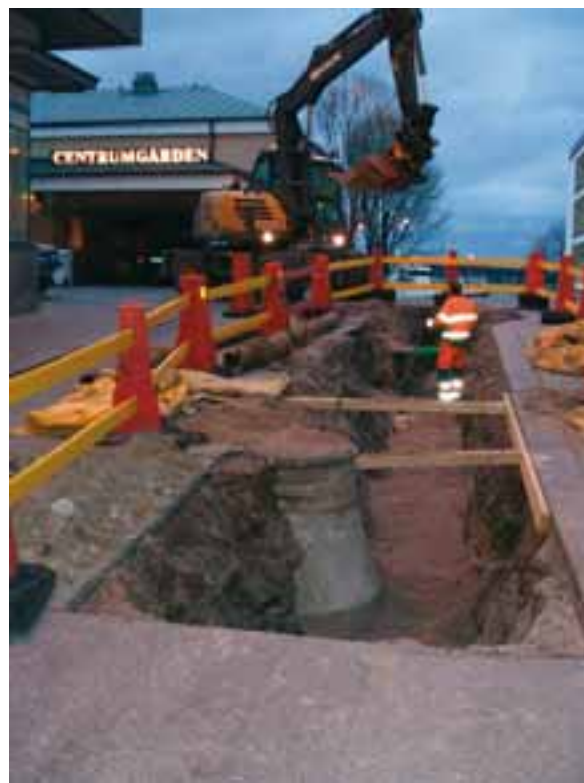
Bild 9. Schaktning för byte av VA-servis i korsningen Storgatan - Strömsgatan. Foto: V Palm, 2007.
