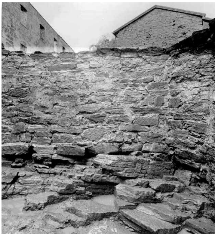
Fig 11 & 12. Den undre bilden visar hörntornet i närbild med anläggning 2b:s stötfog mot denna. Den övre bilden visar hörntornet till höger och det förband som finns med ringmuren. Under ringmuren syns hur man huggit sten ur klippan.
