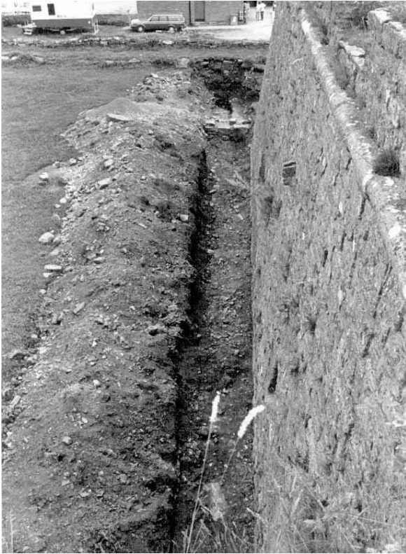
Fig 16. Östra delen av VA-schaktet med äldre bevarat murverk markerat som troligen utgör en äldre föregångare till den idag stående yttervärmuren. Bilden är tagen från vallmuren.
