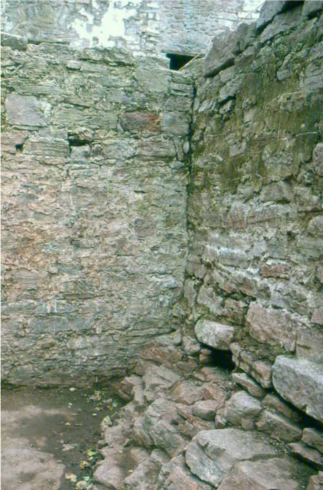
Fig 10. Stötfogen mellan ringmuren och anläggning 2a. Sedd från norr
