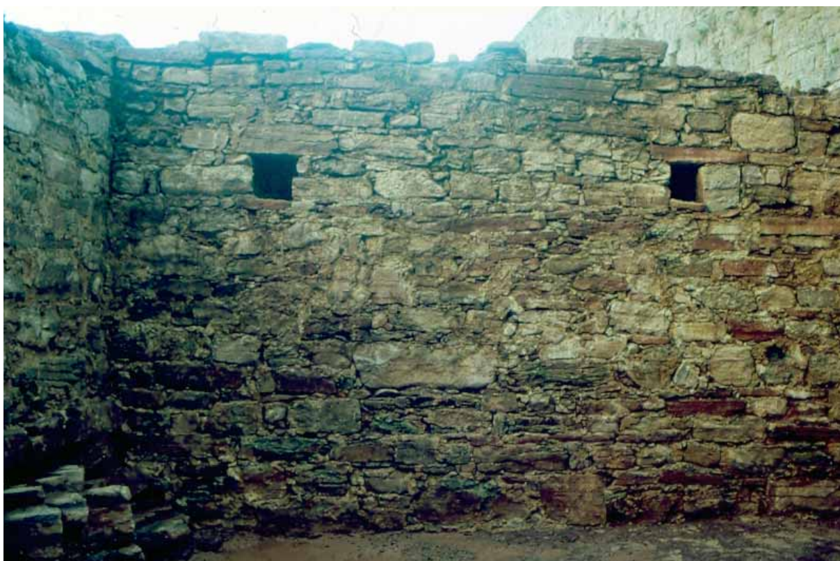
Fig 9. De igensatta bomhålen i den norra väggen av anläggning 2a.
