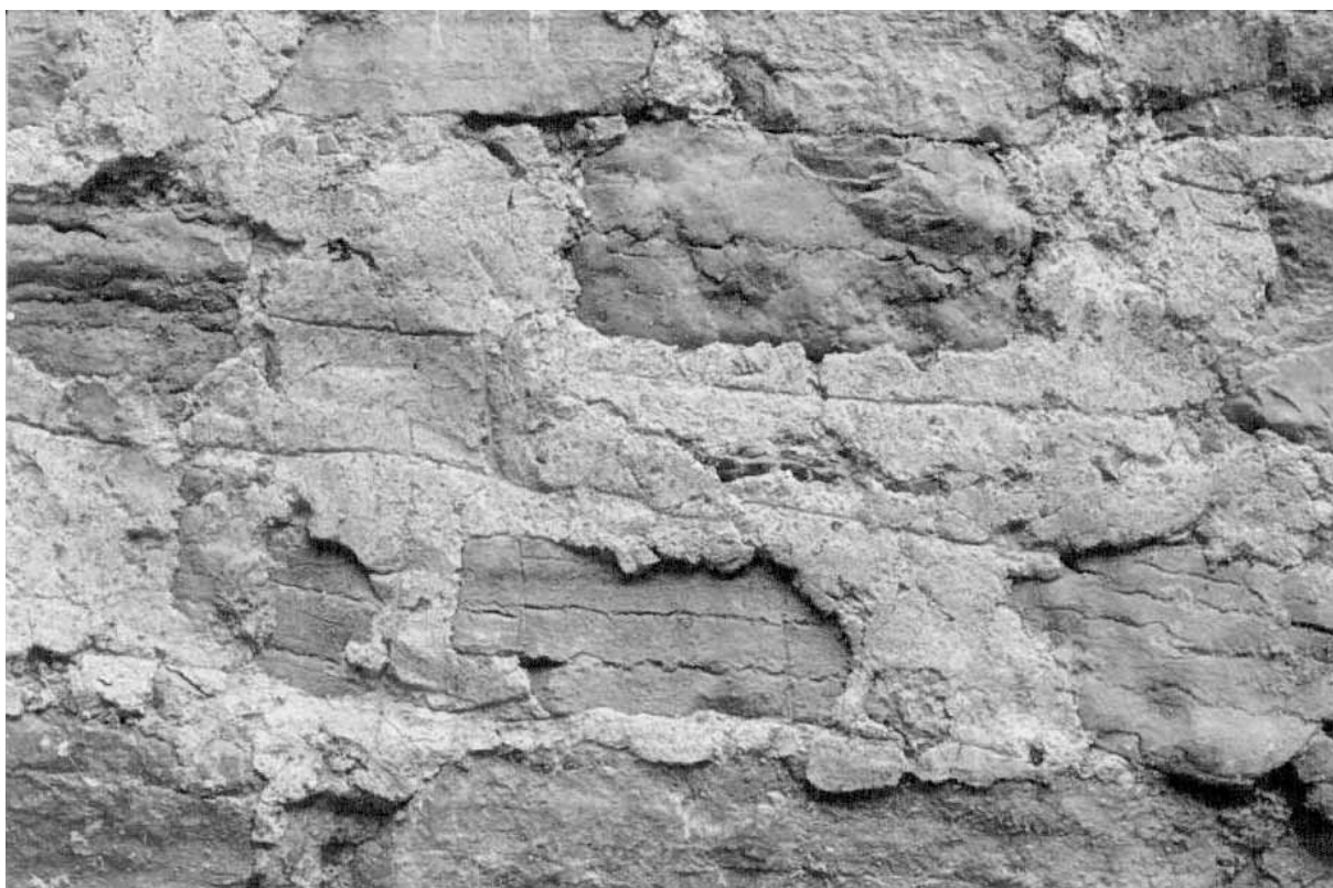
Fig 7. Närbild på kalkputs med bevarad kvaderrits.
