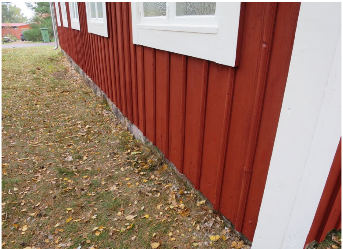
Fasaden, nederdelen mot söder efter målning.
