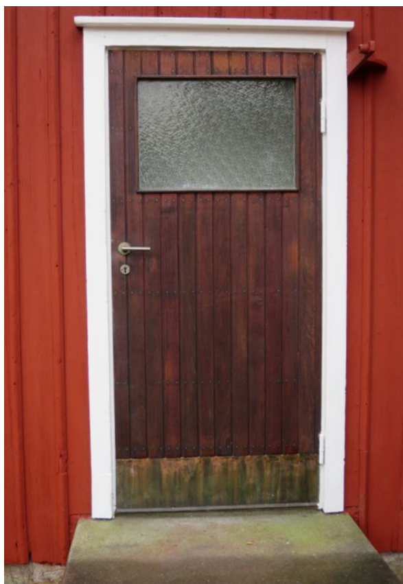
Sidoingångens ytterdörrs utsida efter målning.
