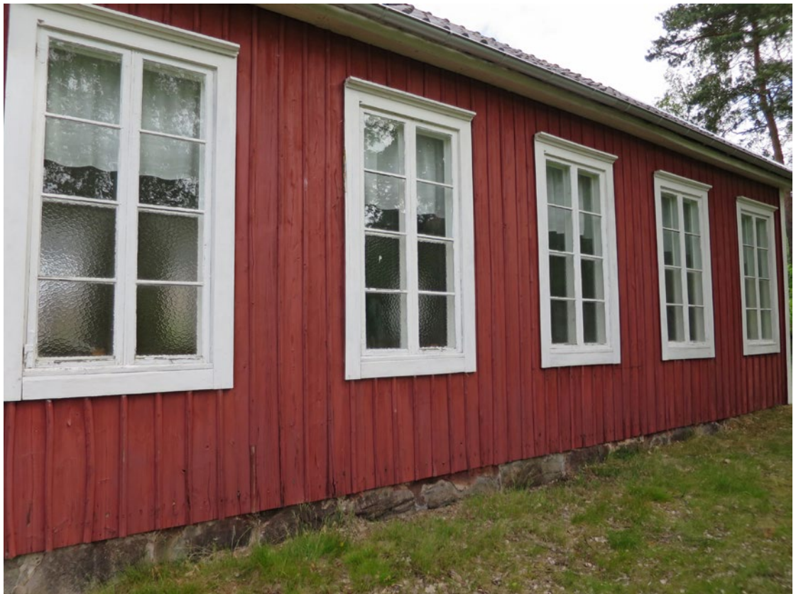
Fasaden, nederdelen mot söder och fönster före målning.
