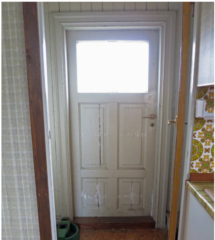
Dörr mot insidan före målning.
