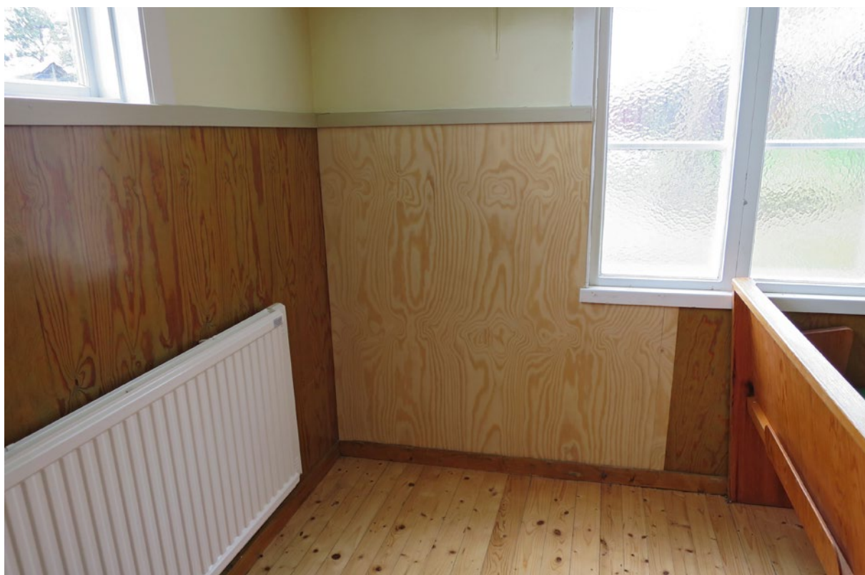
Den upplagade innerväggen i salens nordvästra hörn före målning.
