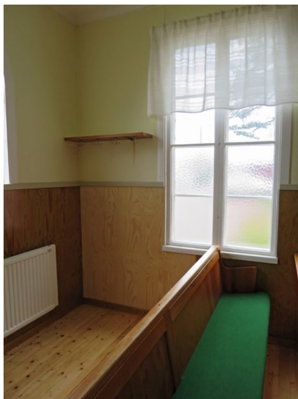
Den upplagade innerväggen i salens nordvästra hörn före målning.
