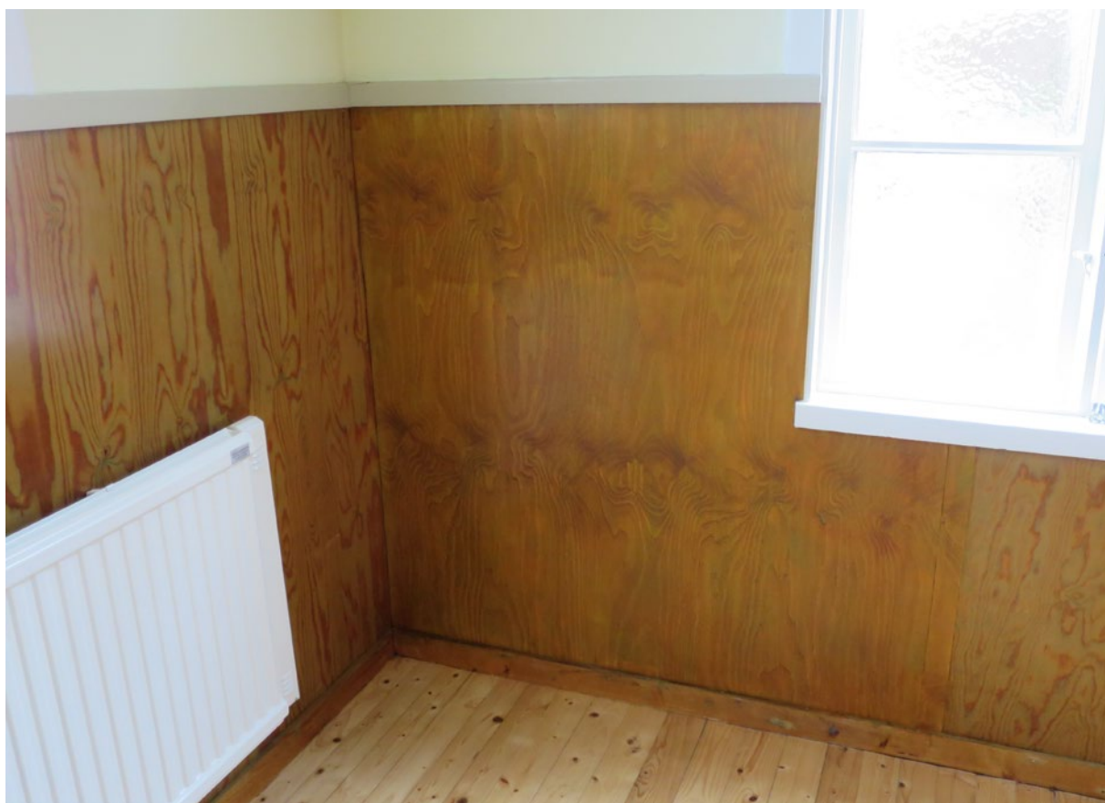
Den upplagade innerväggen i salens nordvästra hörn efter målning.
