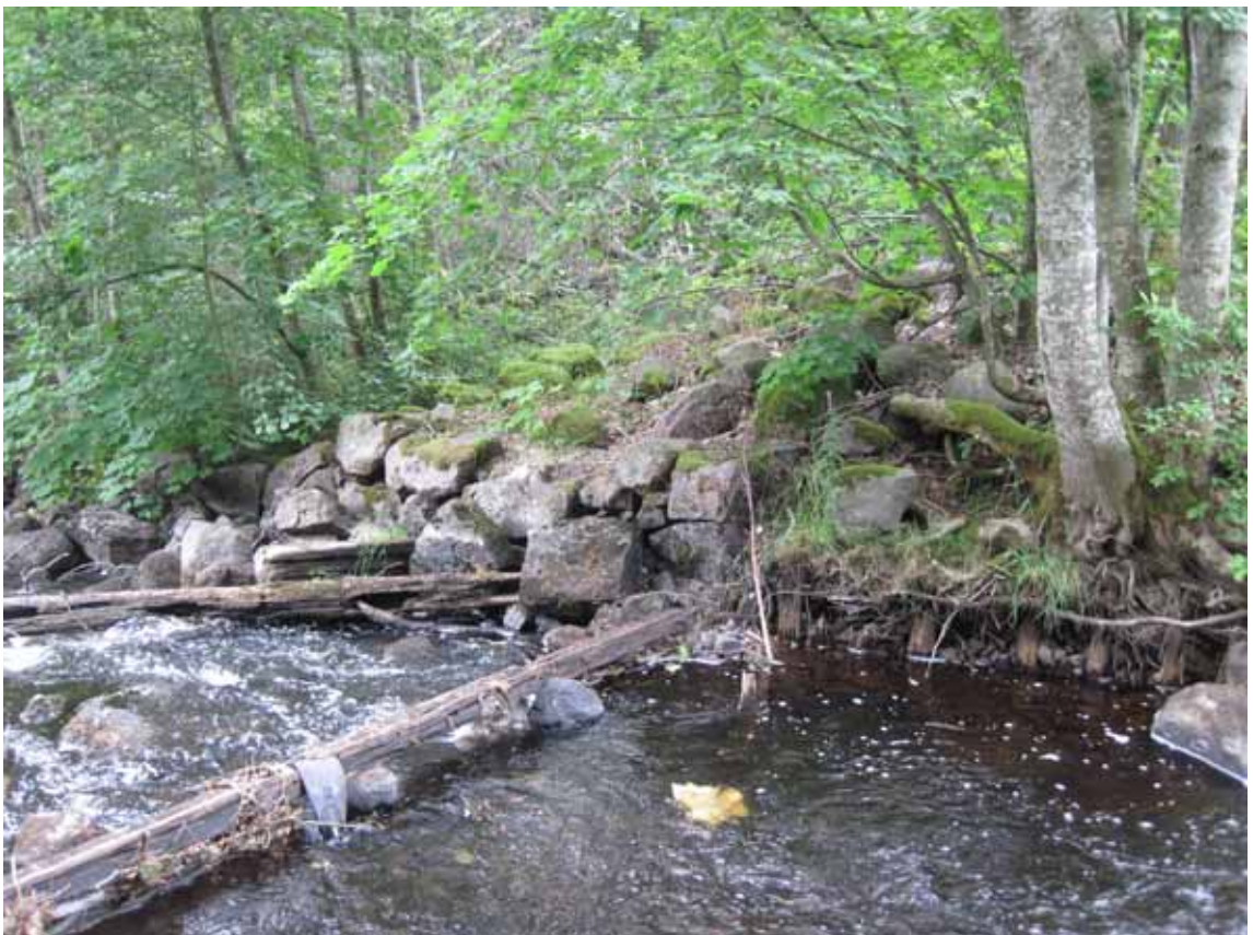
Större fundament på båda sidorna av åfåran.
