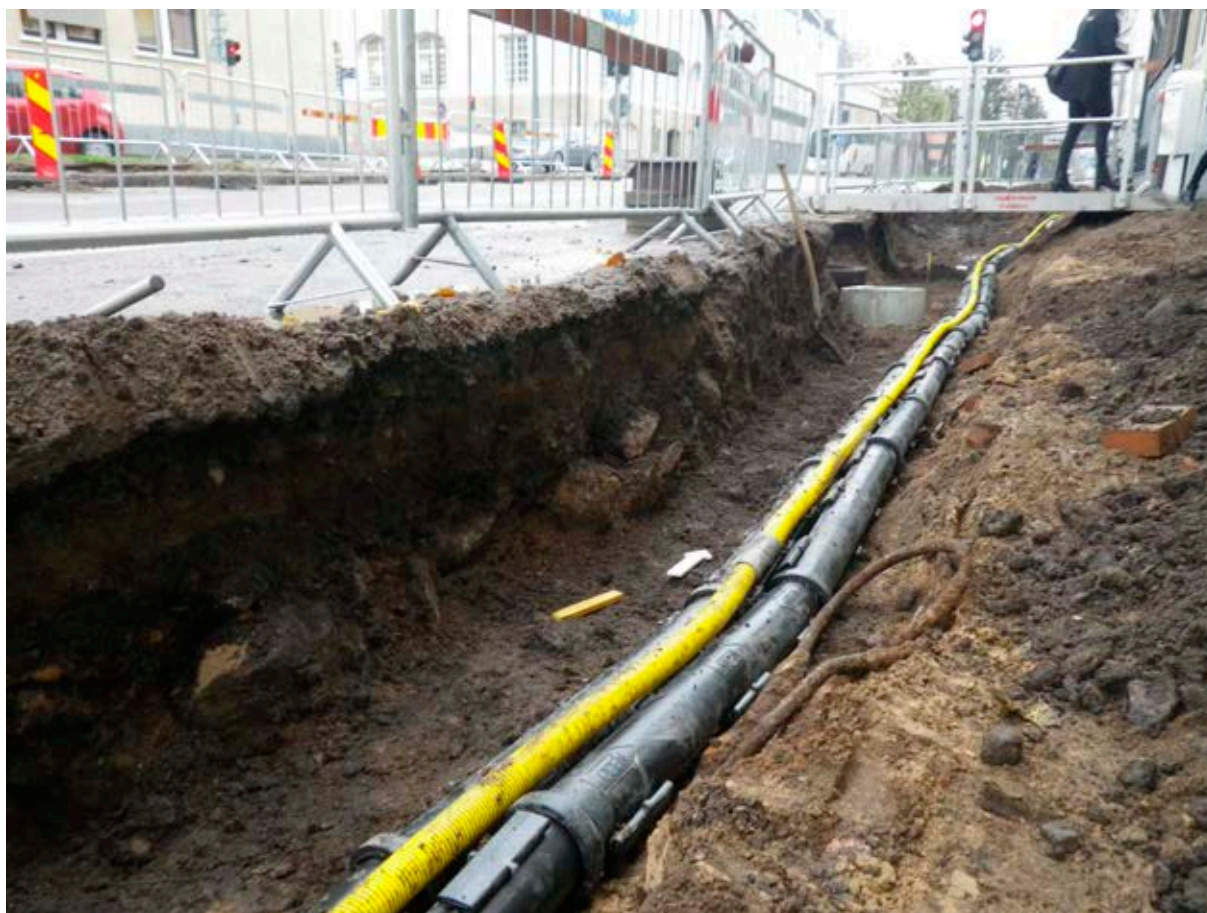
Fig. 16: Schaktet med stenläggningen A2 synlig i den västra schaktkanten. Foto från sydöst.
