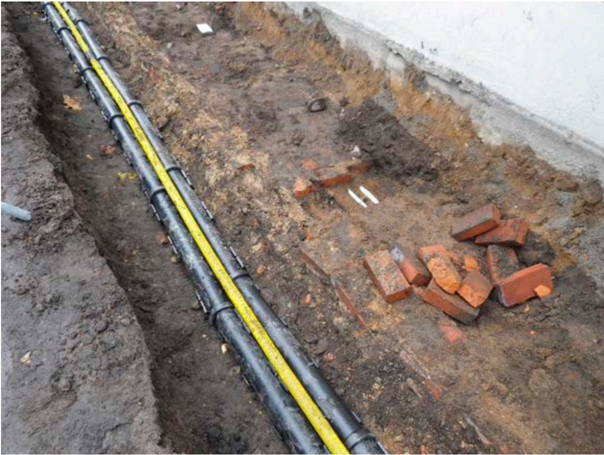
Fig. 14: Längs med Smålandspostens hus fanns ett flertal ledningar men såväl bredvid som under dessa fanns bevarade kulturlager. Foto från sydväst Museiarkeologi Sydost.
