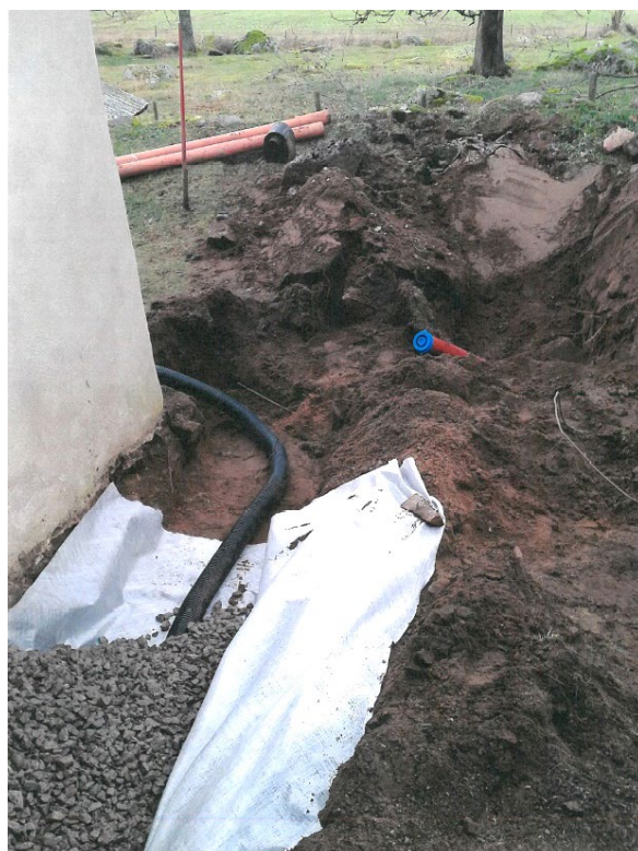
Dagvattenledning Tveta kyrka under pågående åtgärd. Här har den nya grävningen för det nya utfallet mot norra kyrkmuren påbörjats. (Foto: Jörgen Petersson)
