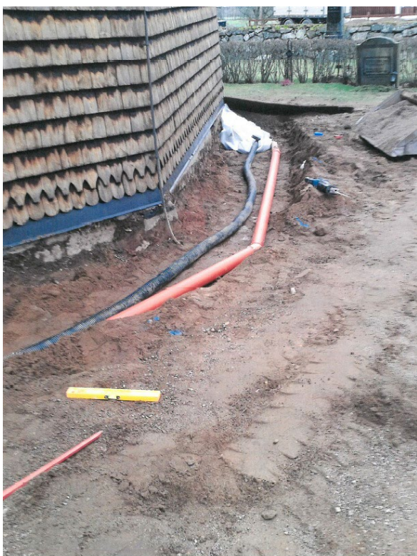
Dagvattenledning Tveta kyrka under pågående åtgärd. Här pågår nedläggning av det nya dagvattensystemet. (Foto: Jörgen Petersson)
