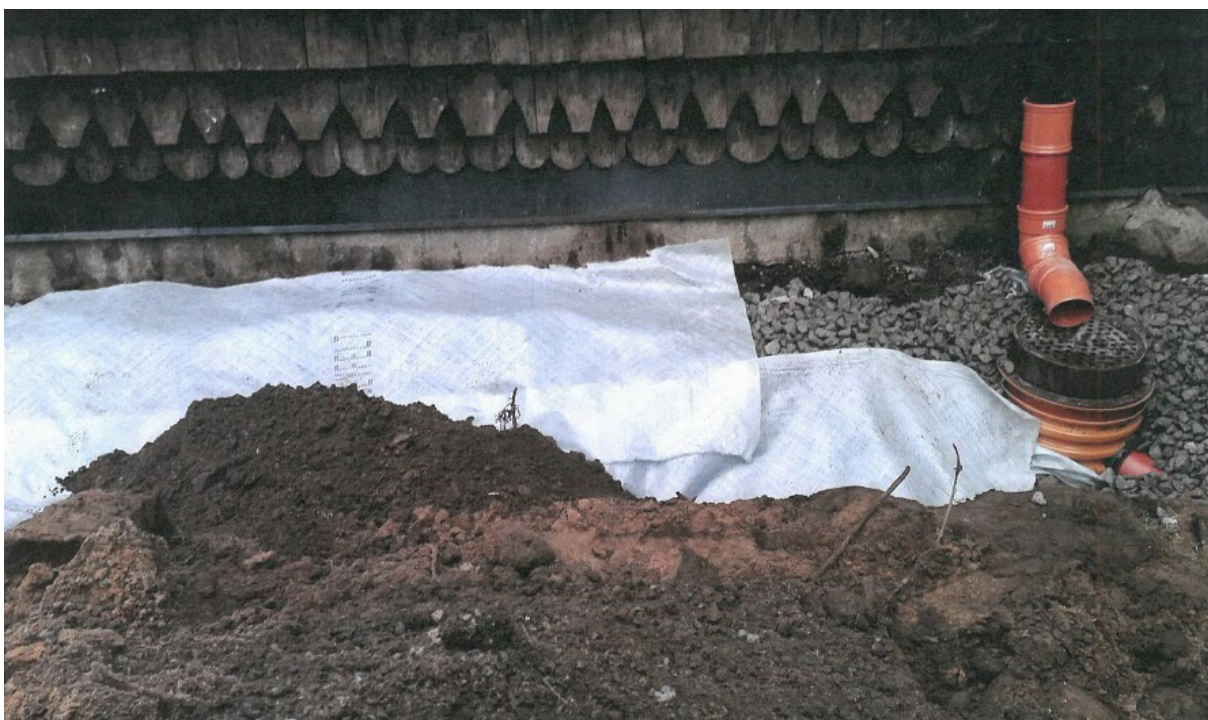
Dagvattenledning Tveta kyrka under pågående åtgärd. Här pågår nedläggning av det nya dagvattensystemet. Till höger syns rensbrunnen med tillhörande sandfång, som monterats under en utkastare. (Foto: Jörgen Petersson)
