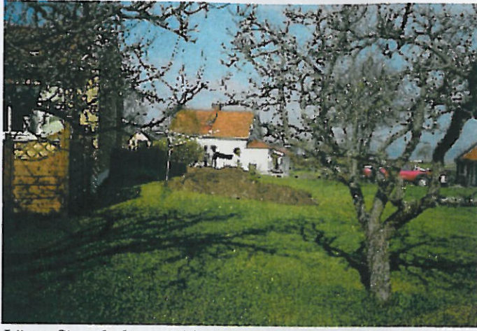
Läget för schakten vid husets norra gavel. I bakgrunden väg 136 och Köpingsviken. Från öster.
