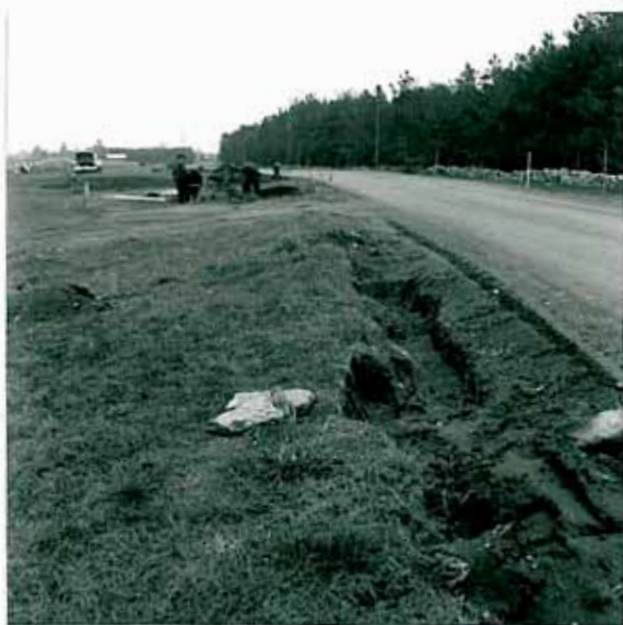
29. Stensättningen 4/59 fr SSV. På gräset ett par i Vägskiliet på trättade, löst liggande kantstenar. Sannolikt tillhörande stensättningens kantledjor.
