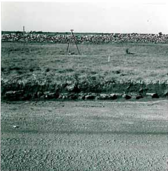
7. Stenpackning med överliggande brandlagen i skärningen mot vägbanan (2/59 B) fr SÖ.
