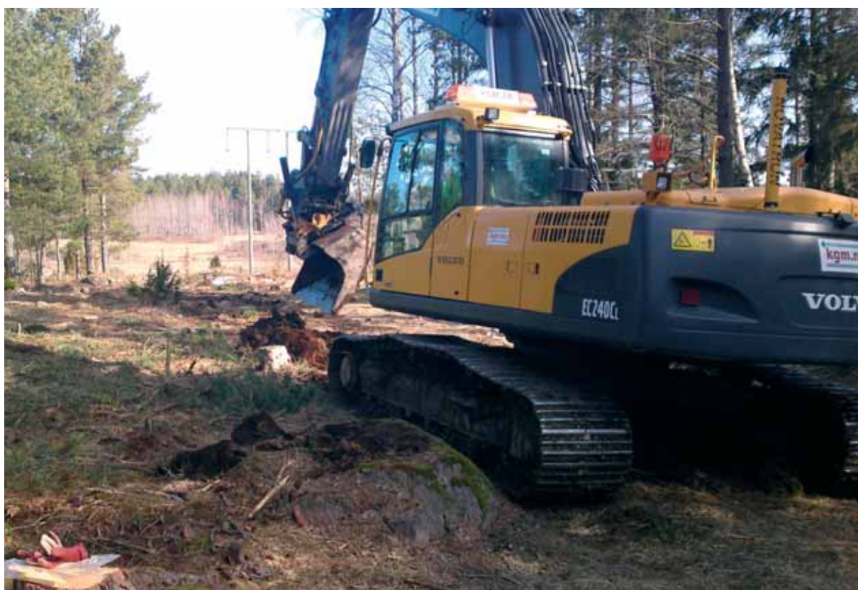
Fig. 1. Schaktning i den skogklädda kullen. Foto från S av V Palm, KLM/VM.
