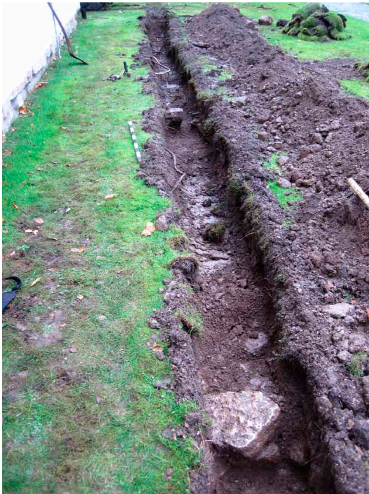
Fig. 8. Schaktet för elkabeln samt de påträffade stensamlingarna. Foto: Nicholas Nilsson, KLM.
