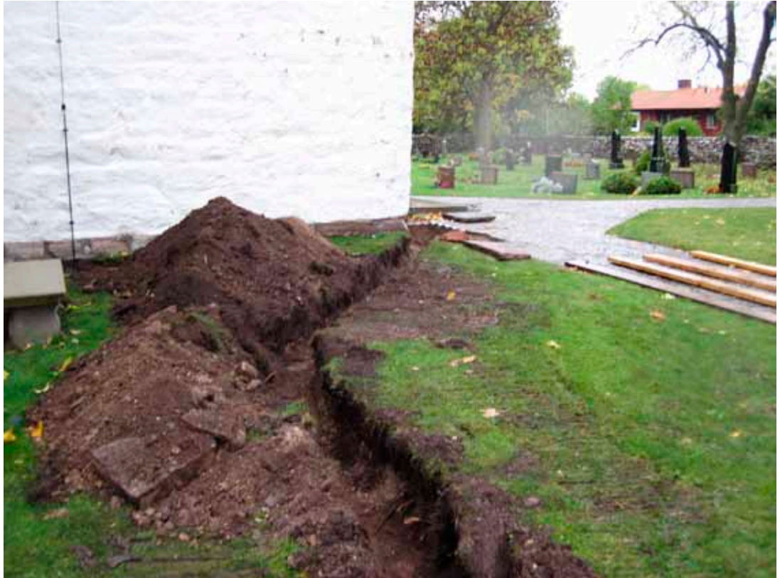
Fig 7. Schakten vid tornet där det grävdes något mer än planerat eftersom den befintliga kabelanslutningen inte låg där den skulle. Foto: Ulrika Söderström, KLM.
