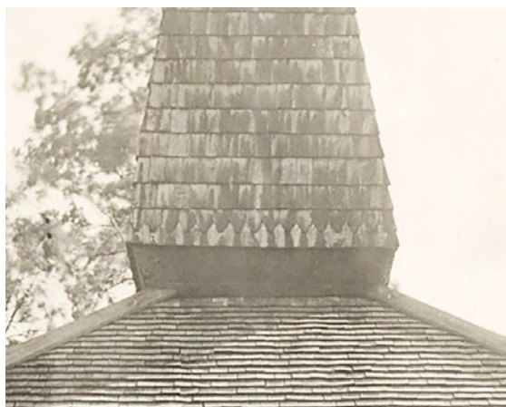
Spetssågade stickspån längst ner på spiran. Detalj från foto från 1920-talet.
