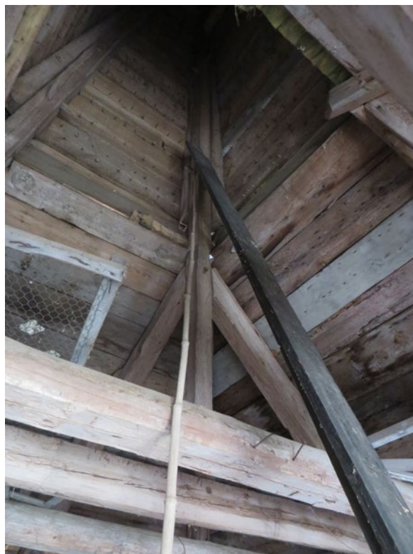
Takbjälkar som bär upp spiran. Återanvända brädor i svallet.
