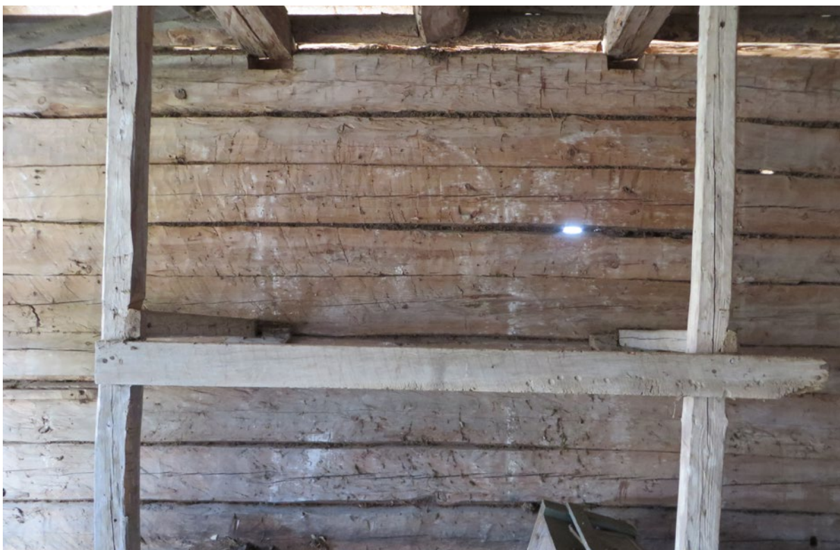
Tvärbjälkarna vilar inte längre på timret utan stöttas upp av hyllkonstruktionens stolpar. Notera de vaga spåren av bågar på väggen.
