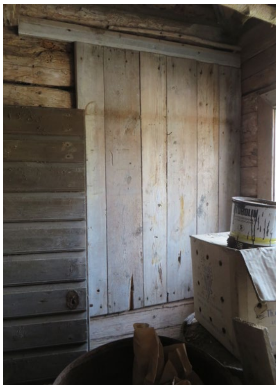
Invändig igensättning av tidigare fönsteröppning i västra fasaden.
