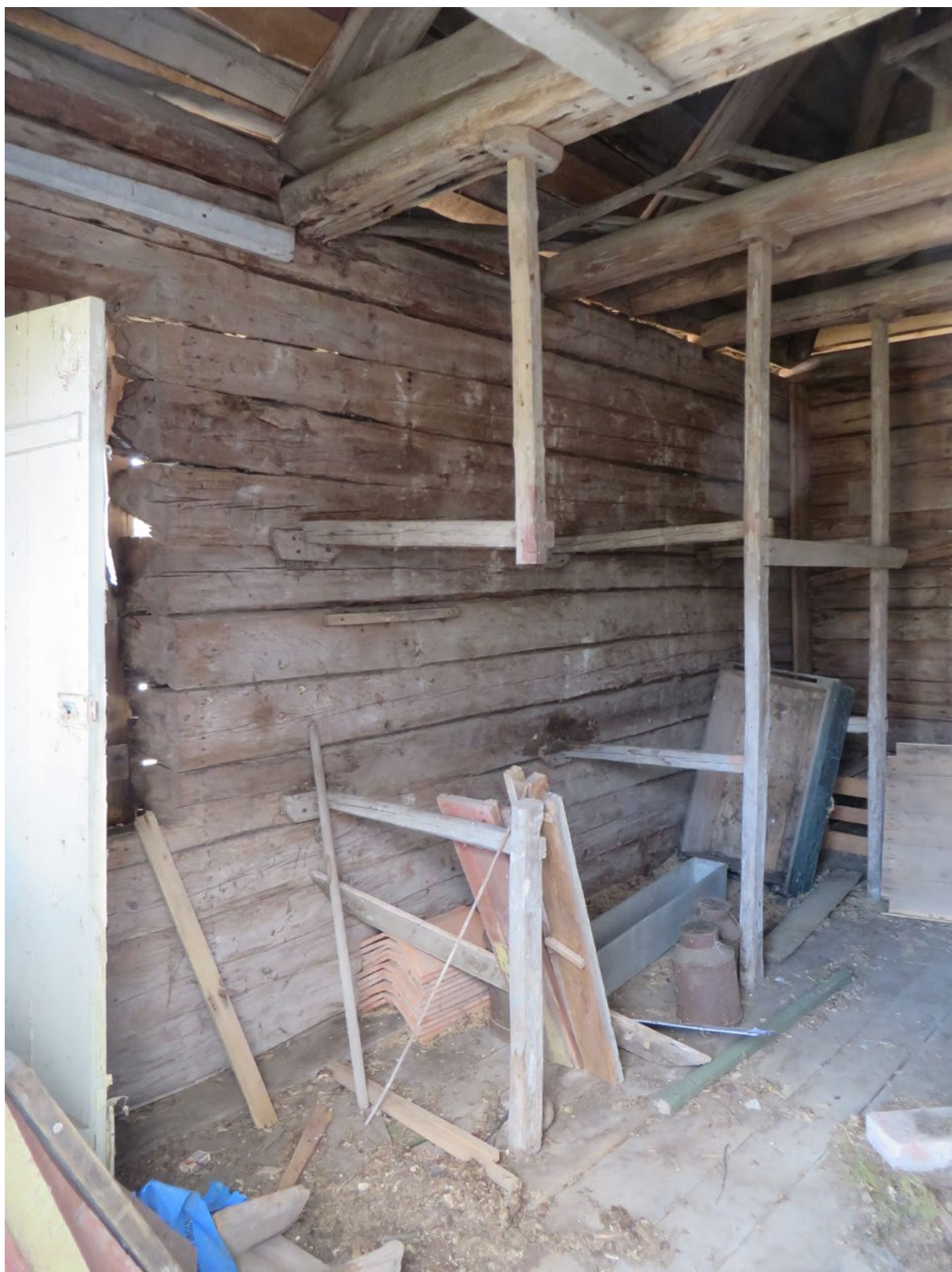
Notera den snedsågade fönsteröppningen utan sedvanlig gât för fönsterkarm. Östra väggen.
