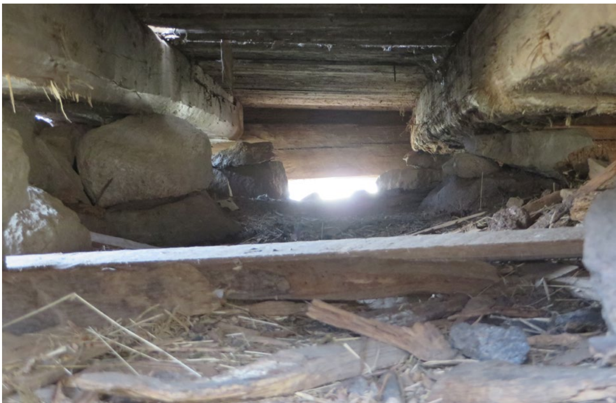
Golvbjälkar vilar på upplag av sten direkt på marken. Inga synliga rötskador.
