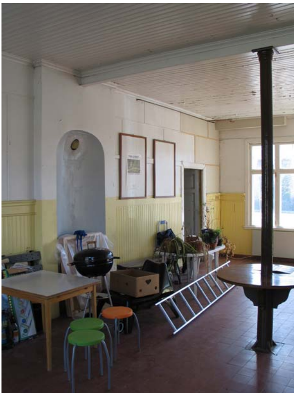
I vänsalens mitt finns ett bord som omgärdar en pelare i gjutjärn
