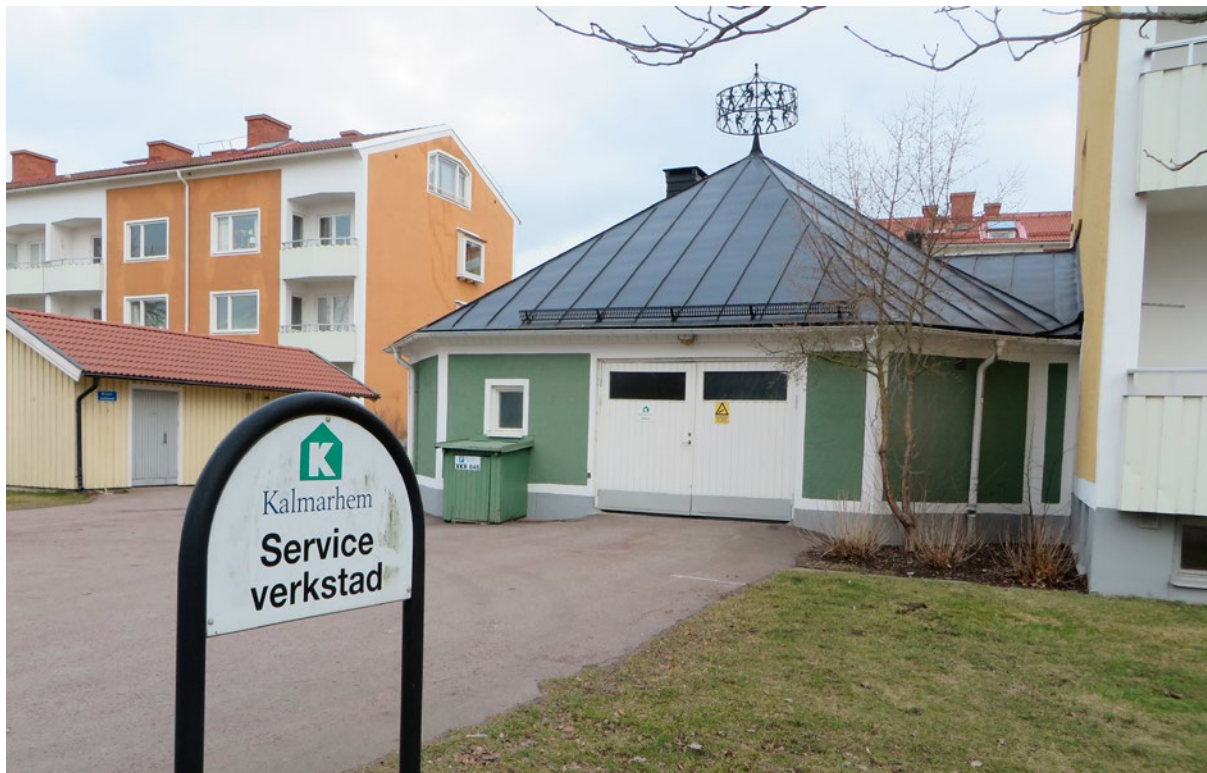
Den gamla panncentralen används som reparationsverkstad. Bild Kalmar läns museum 2017.
