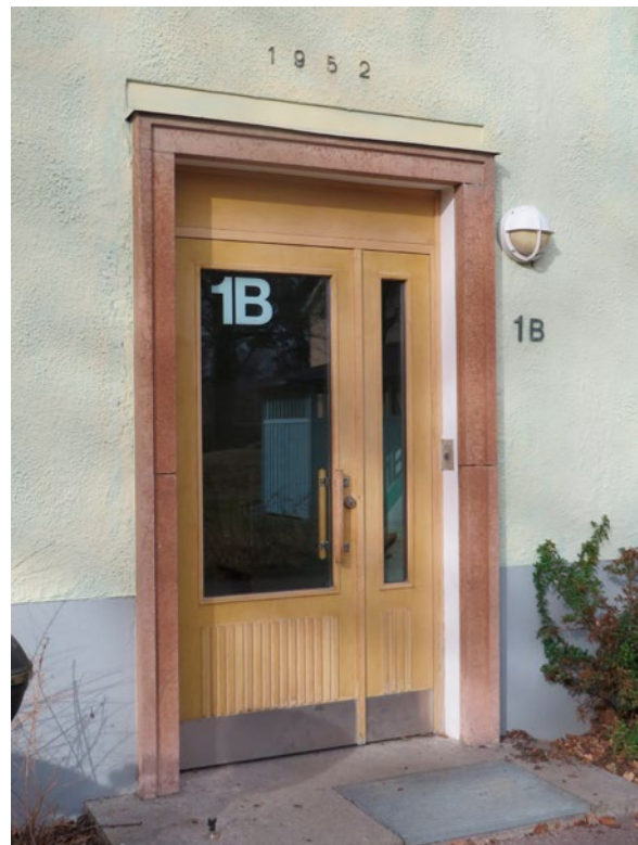
En av områdets vackra ursprungliga dörrumfattningar i kalksten, och nytillverkad ytterdörr i ek i en stil som passar 1950-talsarkitekturen. Bild Kalmar läns museum 2017.
