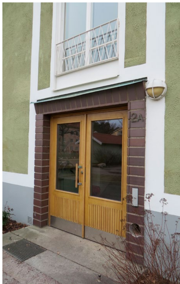
En av områdets ytterdörrar med klinker som omfattning i stället för kalksten. En nätt kopparplåt som skydd överst och originalsmidesräcke vid trapphusets fönster. Bild Kalmar läns museum 2017.
