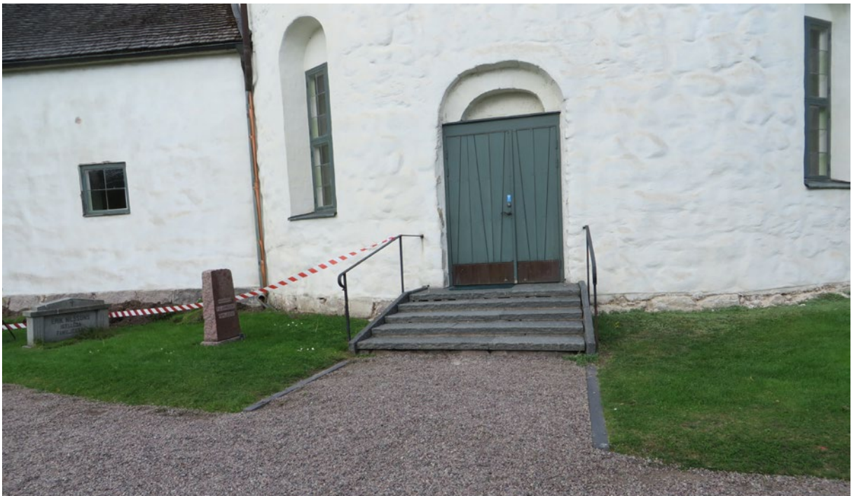
Vid huvudingången på södra fasaden inför arbetet.
