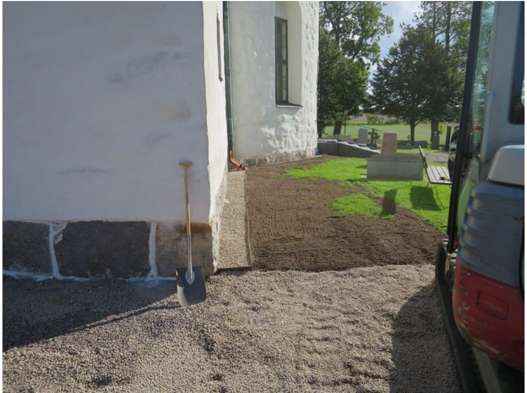
Kyrkans södra del när stenfoten är lagats, kortenstål och singel lagts intill fasaden och marken är återställd.
