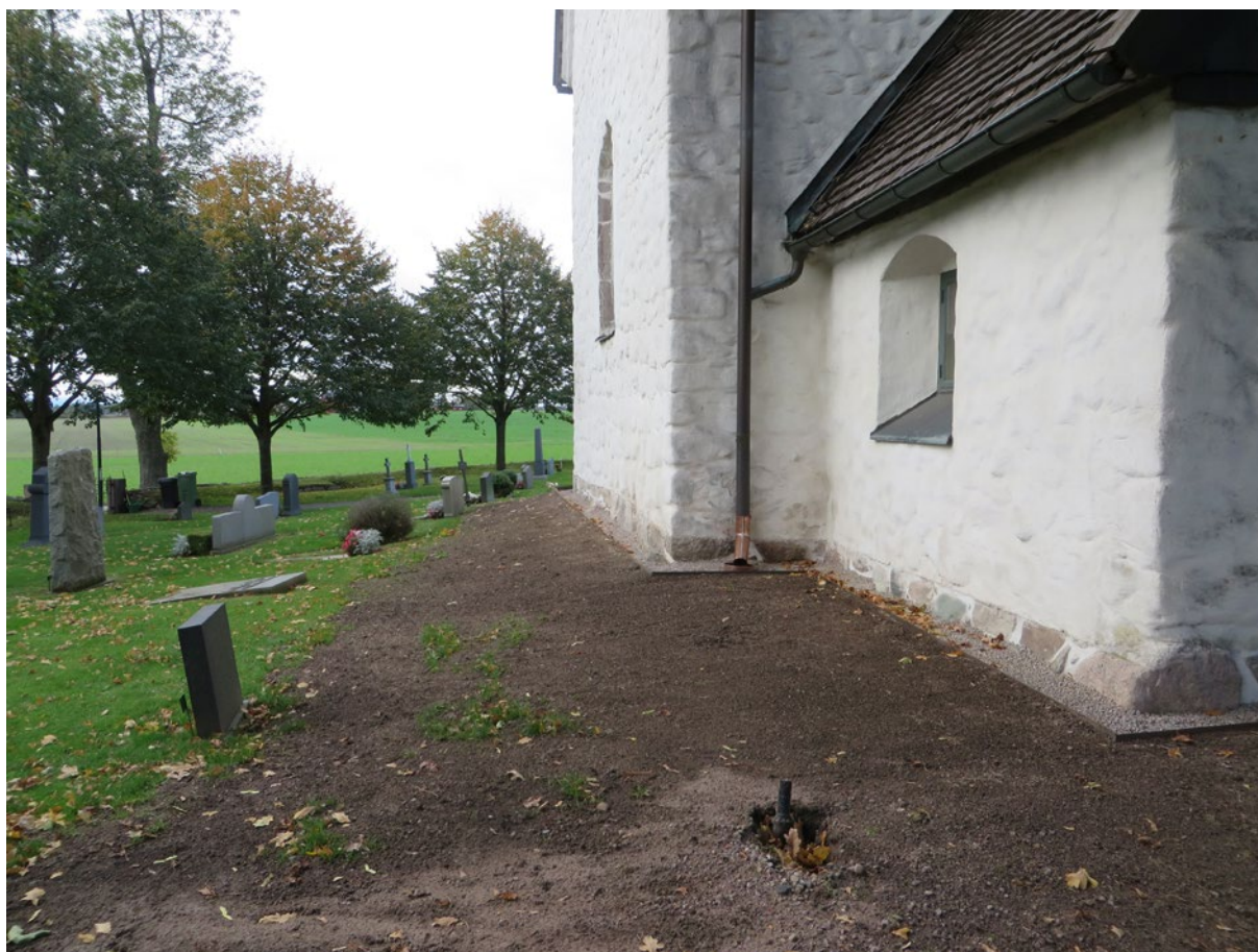
Arbetena färdigställda. Kyrkans östra fasad.
