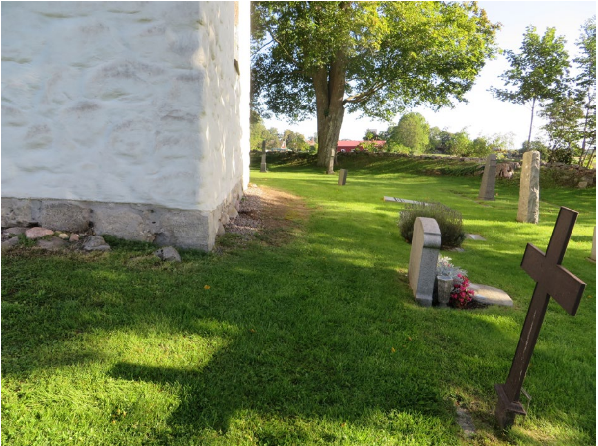
Koret, bild från sydost, inför arbetet.
