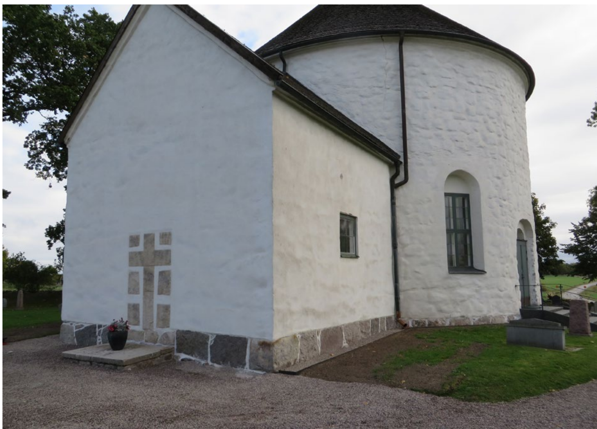
Arbetena färdigställda. Här kyrkans södra och västra fasader.
