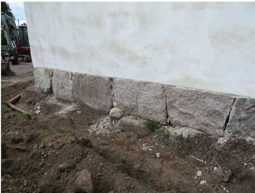
Del av rundhusets stenfot mot norr som rengjorts och fått äldre fog borttagen inför omfogning.
