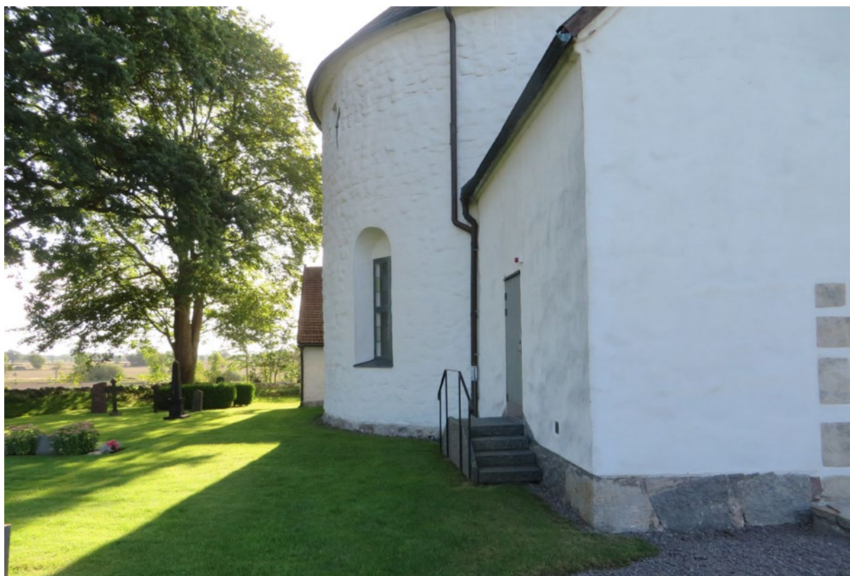
Kyrkans norra del inför arbetet.
