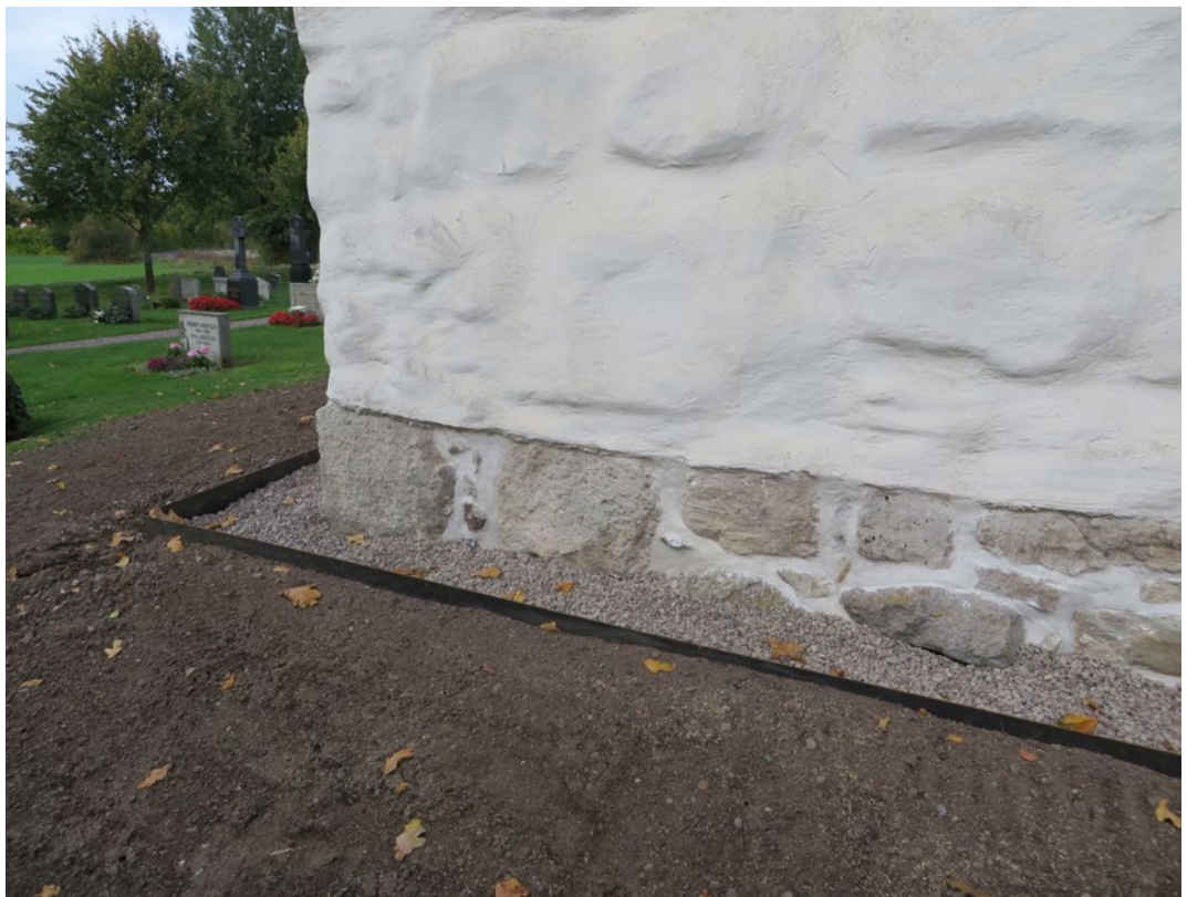
Lagad stenfot på rundhuset mot norr.
