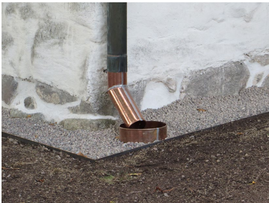
Detalj där man ser kompletterat stuprör och regnvattensbrunn vid sakristians norra fasad.
