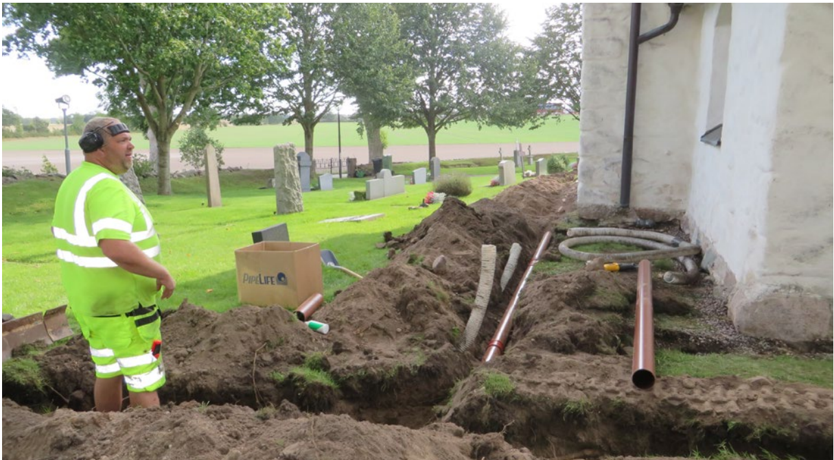
Grävmaskinist Fredrik Muhr står i ett av schakten som grävts upp för placering av dagvattenledningar. Bilden är tagen vid koret i öster.
