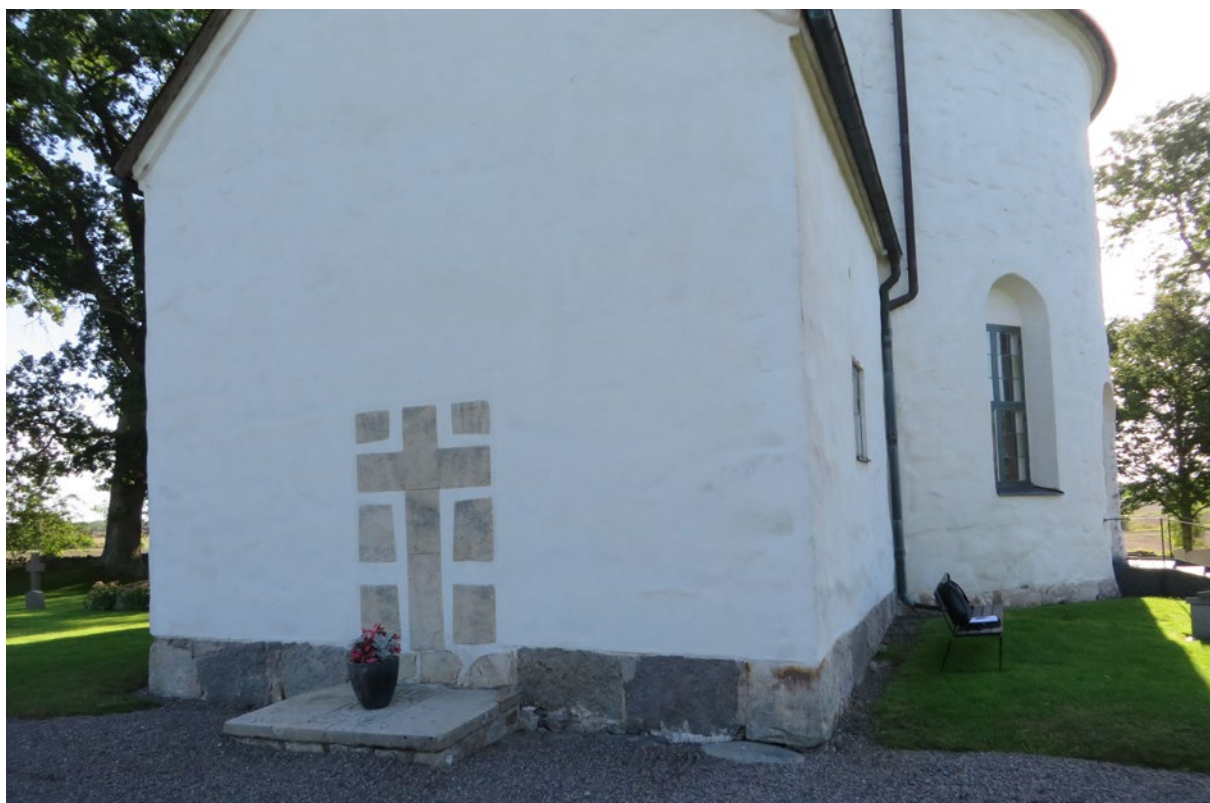
Kyrkans östra del inför arbetet.
