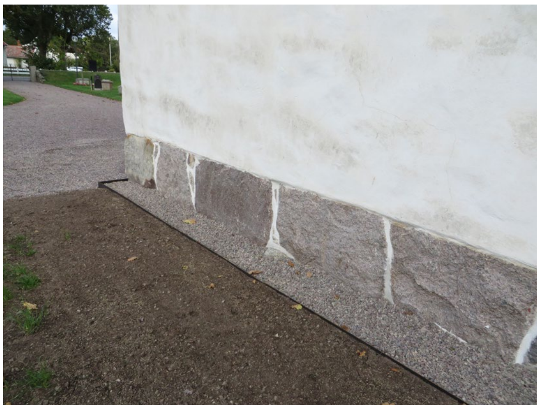
Lagad stenfot på kyrkans västra byggnadsdel mot söder.
