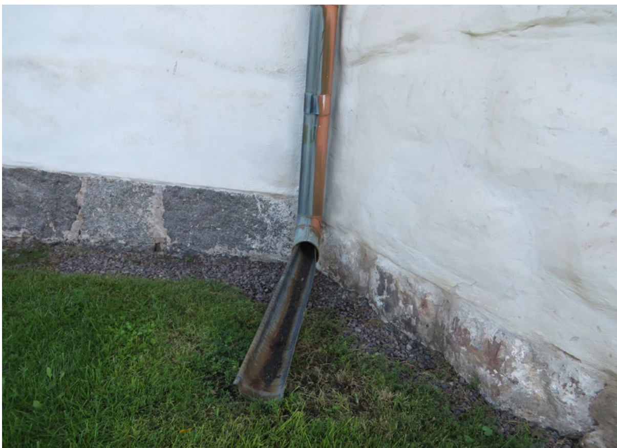
Stuprör och stenfot vid mötet mellan rundhus och kor i söder inför arbetet.
