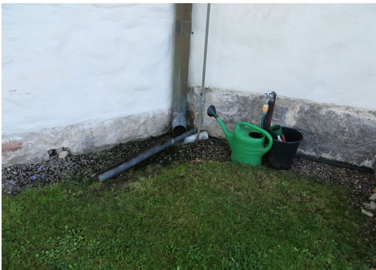
Norra sidan, rundhuset. Här ser man hur regnvatten från stupröret leddes bort med en lös ränna och att stenar fallit ut ur stenfoten.
