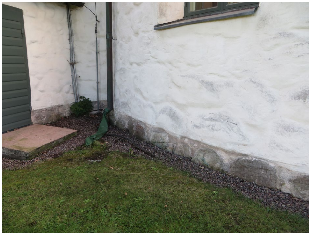
Stuprör och stenfot i möte mellan rundhus och sakristia inför arbetet.
