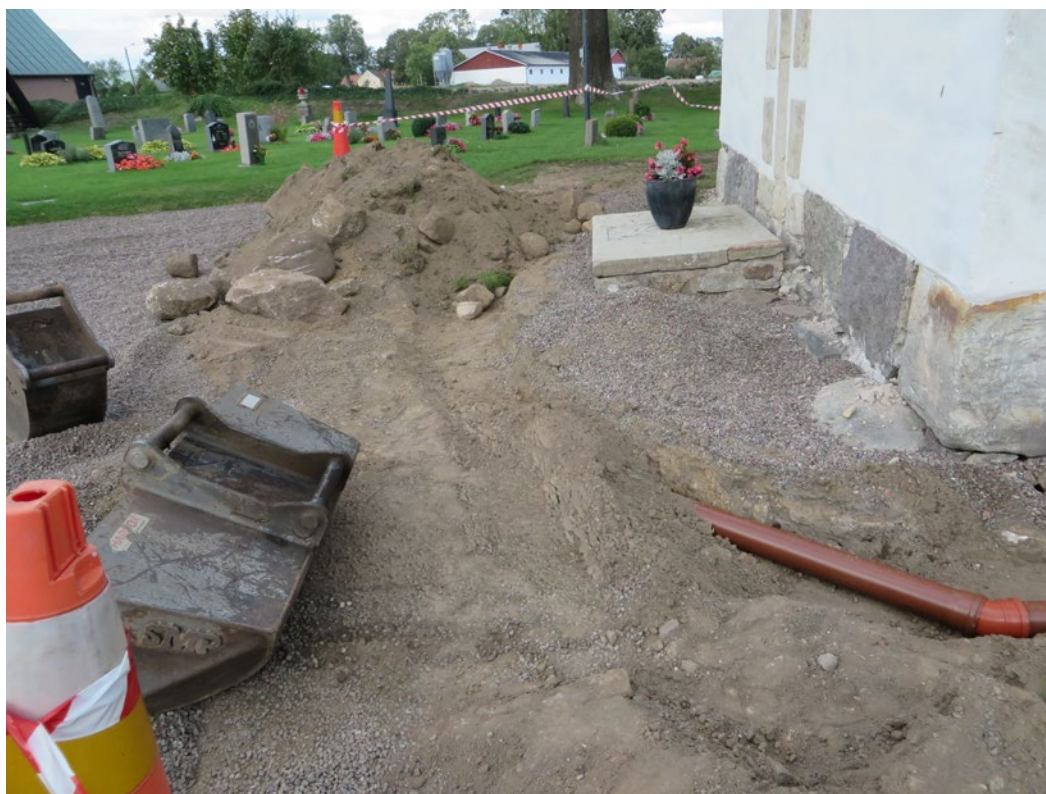
Rör för dagvatten, detalj. Vid stuprör i mötet mellan kor och sakristia i öster.
