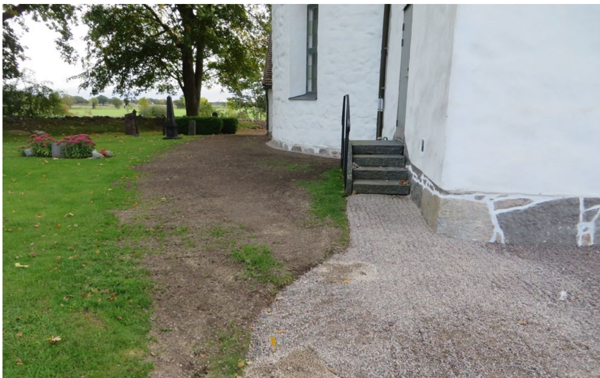
Arbetena färdigställda. Kyrkans norra fasad där grusgången drogs fram till trappan, som en ändring mot tidigare.
