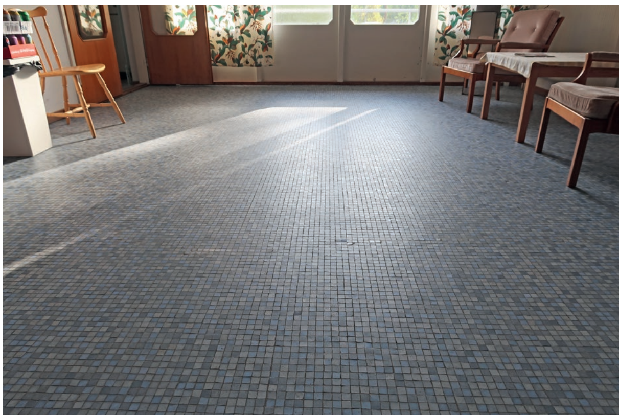
Golvet i övervåningens foajé efter åtgärd. Fotografi mot öster.
