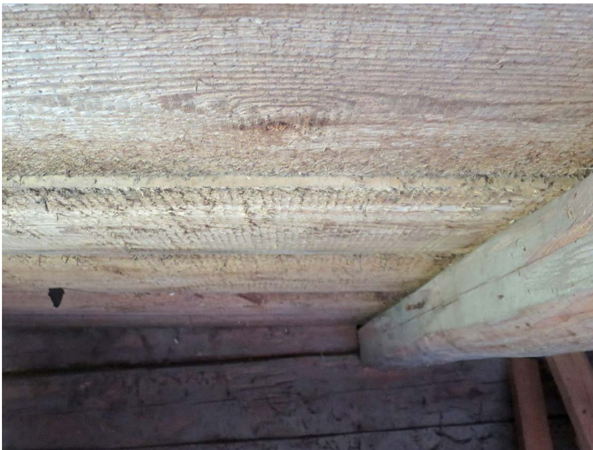
Mellanbjälklaget fotograferat från bottenvåningen. Brädorna har tydliga spår av ramsågning. Bjälklagets bärande balkar är liksom takåsarna utförda av avbarkat rundtimmer.
