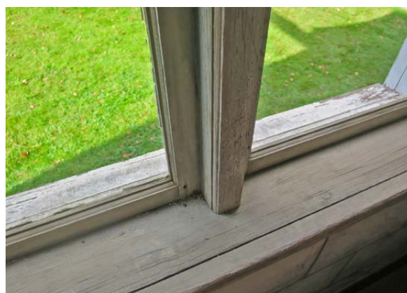
Fönsterpost i "Salen", rum 10. Profilen har störst likheter med typer som daterats till en period omkring 1780–1800.
