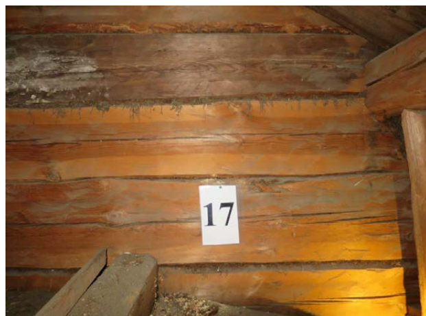
Prov 17 Mellanvägg mot nordväst.
