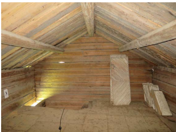
Prov 3 Yttervägg mot öster.
