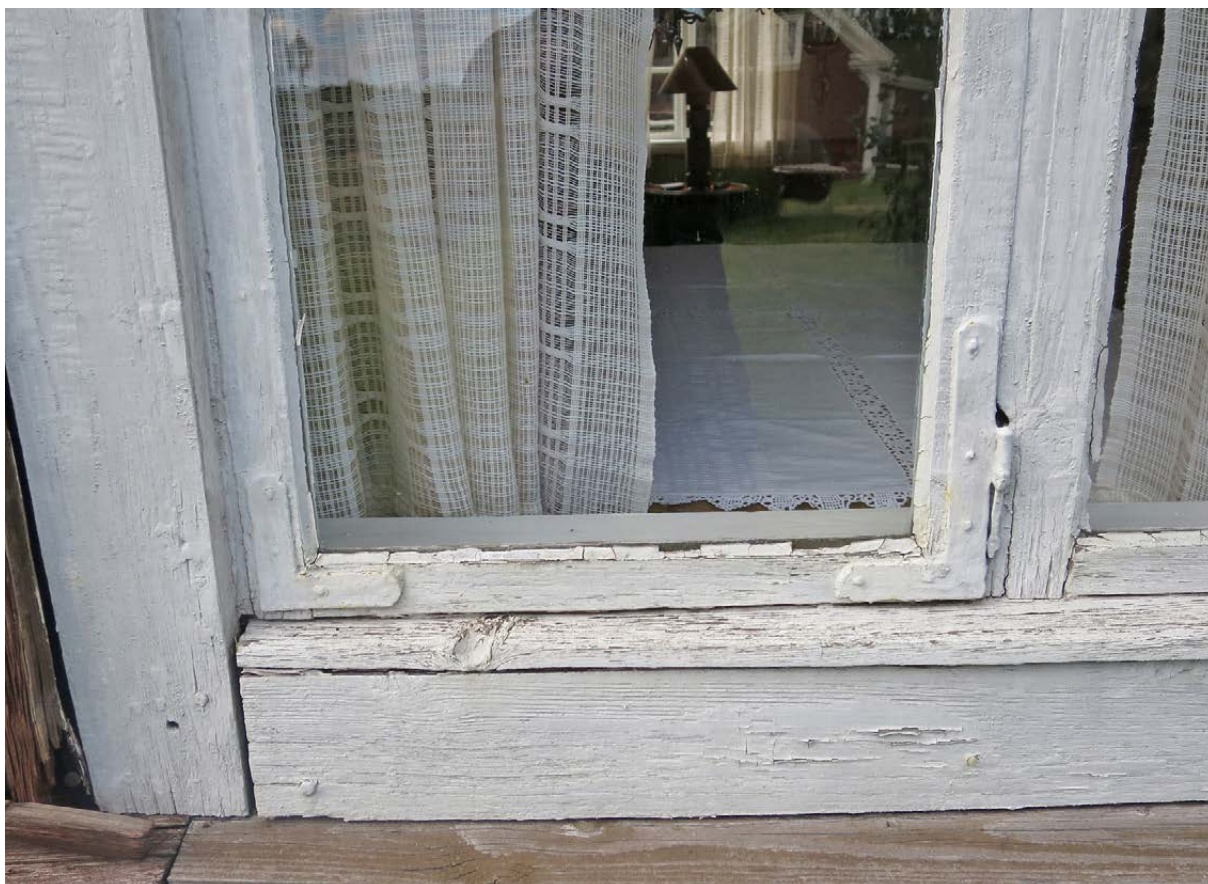
Närbild av fönster på bottenvåningen i byggnad 6. De utvändiga beslagen är av en typ som var vanlig från 1700-talets senare del fram till 1850-talet.
