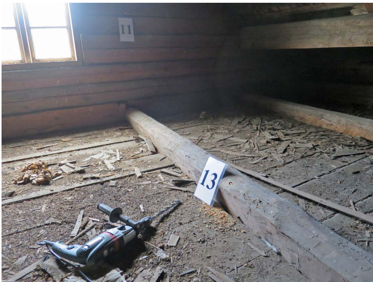
Fotografi från vinden i byggnad 6. Prov 13, från vindsbjälklagets balk, har daterats till perioden 1793–1809. Dateringen styrker teorin att övervåningarna på både byggnad 6 och 5 tillkommit i början av 1800-talet. Sannolikt har även byggnadernas bottenvåningar uppförts vid samma tillfälle.
