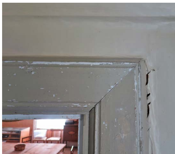
Dörrfoder i rum 201. Fodrets ålderdomliga utförande påminner om typer som brukar förknippas med barocken under 1600-talet och första hälften av 1700-talet. Med undantag för bottenvåningen i byggnad 5 har i stor sett alla innerdörrar i byggnad 5 och 6 samma eller snarlika dörrfoder. Profilen återfinns även på kanterna av de brädor som sitter i innertaken.
