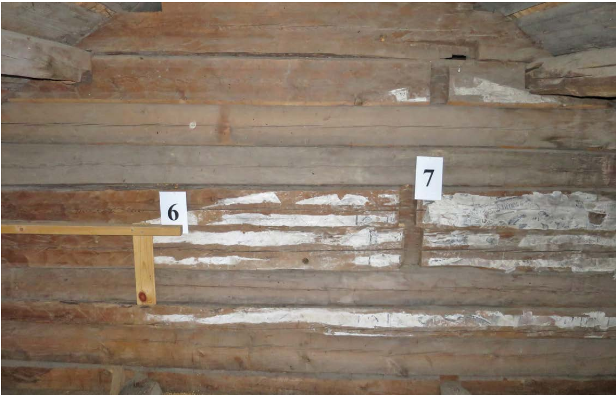
Vägg mot nordost på vinden i hus 5. Väggens är gemensam med hus 6. På bilden har lägena av prov 6 och 7 markerats. Prov 6, som togs i en återanvänd bemålad stock, daterades till vinterhalvåret 1681/82. Virke med lika hög ålder (datering 1683–1693) återfinns även på bottenvåningen i samma vägg. Prov 7, som togs i stocken just över det stora bemålade väggpartiet, har daterats till perioden 1865–1885.
