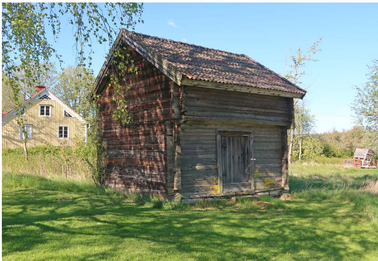
Loftboden, byggnad 1, fotograferad från öster. Dörröppningen vetter mot nordost.
