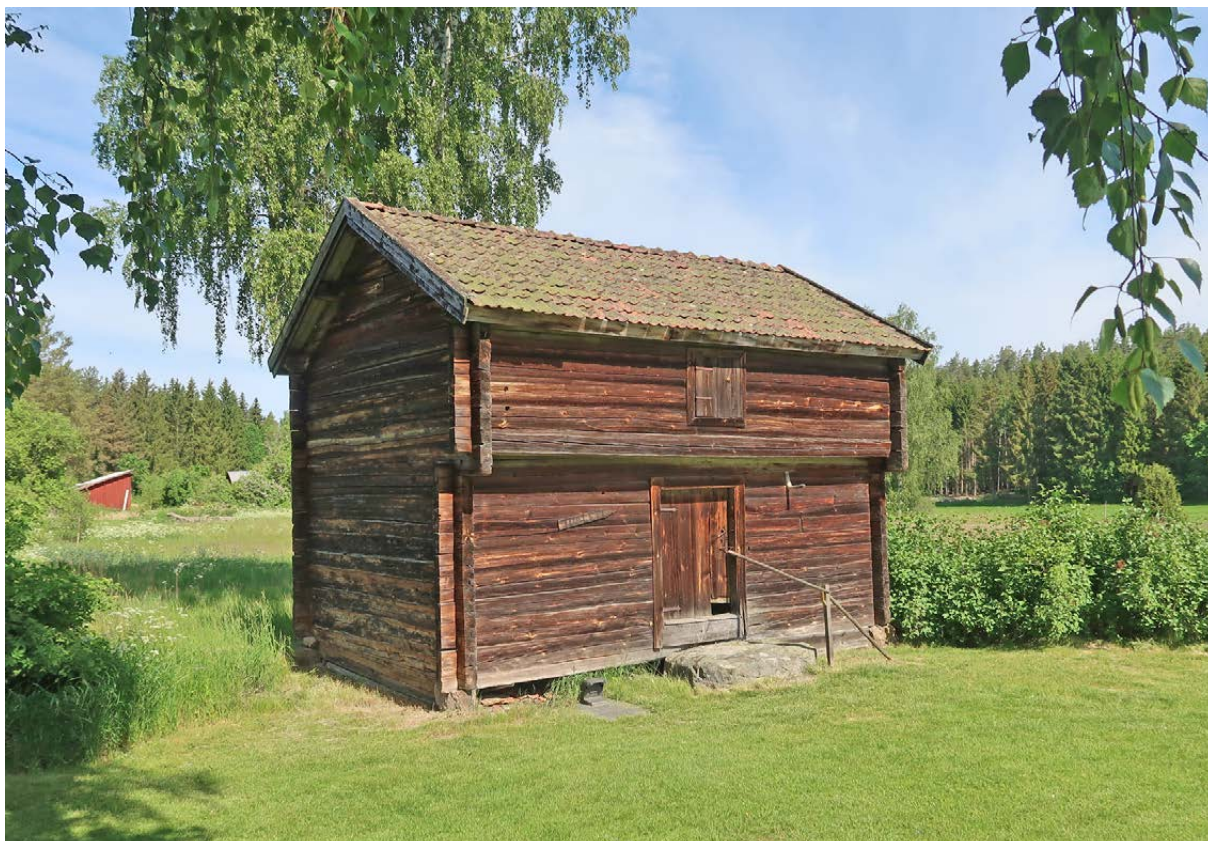
Loftboden, byggnad 2, fotograferad från söder.
