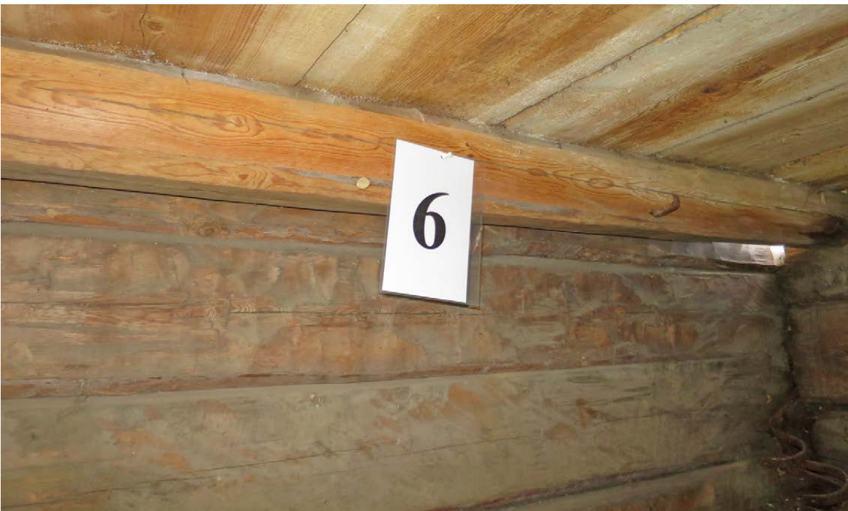
Virket till andra våningens bjälklag och väggar är omkring 90 år yngre än på bottenvåningen. Bilden visar prov 6, som togs från en bärande balk till andra våningens bjälklag. Provet har daterats till vinterhalvåret 1760/61.
