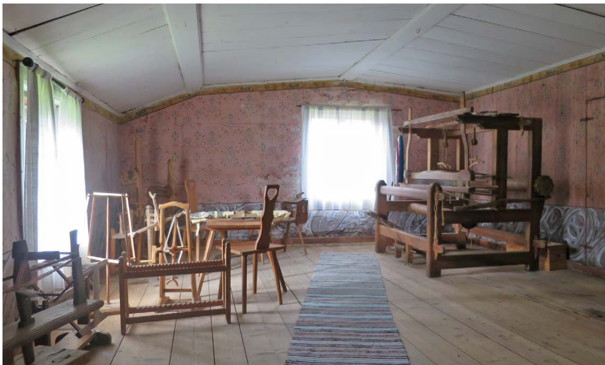
"Rosa rummet", rum 7 på övervåningen i byggnad 7. Fotografi mot gaveln i nordväst. På brädväggen till höger är måleriet utfört direkt på träytan. Övriga väggar har först klätts med lumpapp.
