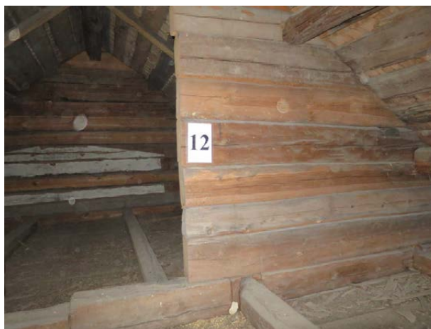
Prov 12 Mellanvägg mot nordväst.
