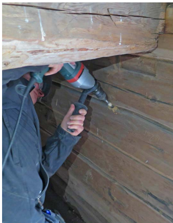
Ett prov tas på vinden i en av gavelväggarna i hus 5.
