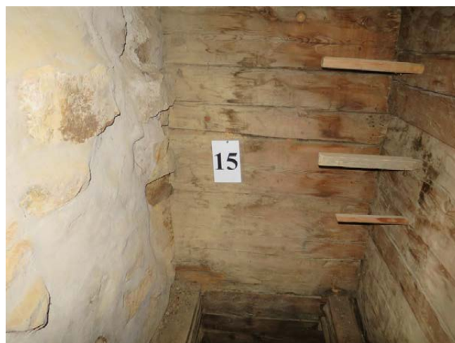
Prov 15 Mellanvägg mot nordväst.
