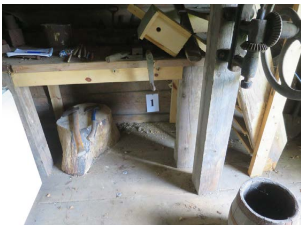
Prov 1 Yttervägg mot nordväst.
