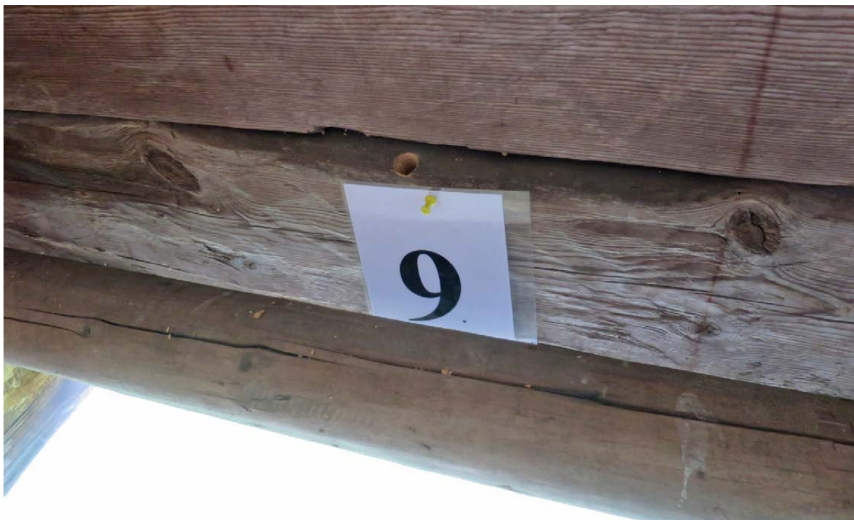
Byggnad 3. Prov 9, taget från loftgångens bröstning, har samma datering som prov 6 (vinterhalvåret 1760/61).
