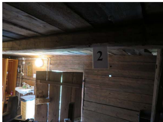
Prov 2 Balk mellanbjälklag.
