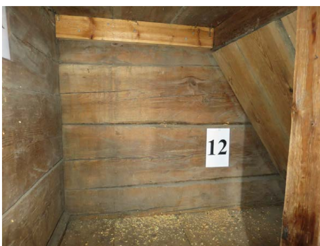
Prov 12 Mellanvägg mot nordväst.
