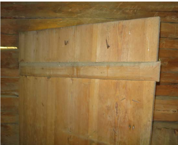
Insida av övervåningens dörr längst åt vänster (sydväst). Alla dörrar har profilerade kanter på tvärlåarna.
