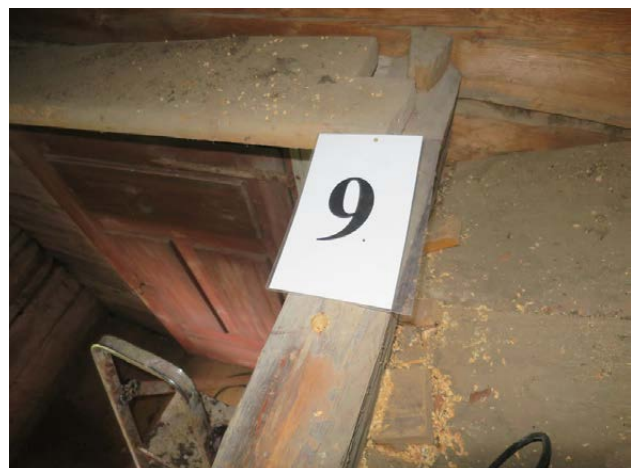
Prov 9 Bjälklag mot vinden.
