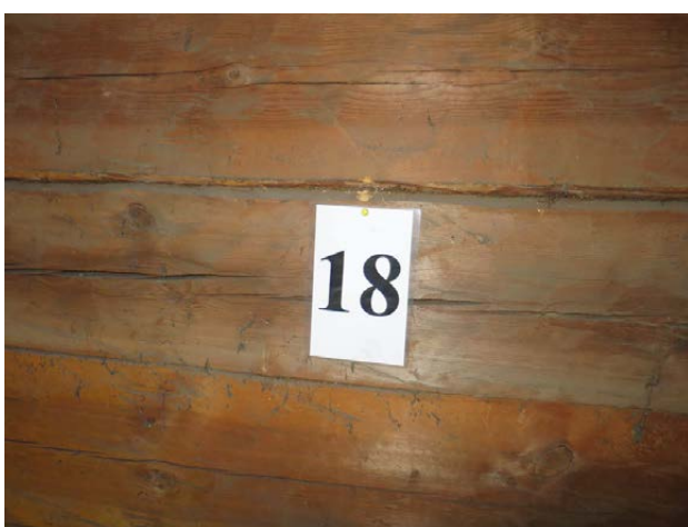
Prov 18 Mellanvägg mot nordväst.
