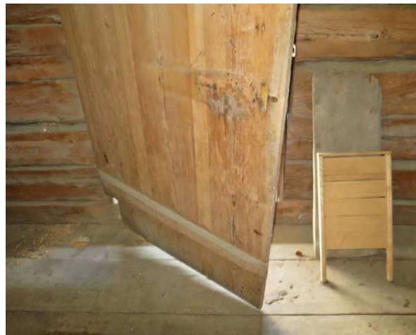
Insida av andra våningens vänstra dörr (mot sydväst). Spår visar att dörren haft samma typ av stocklås som bottenvåningens dörrar.
