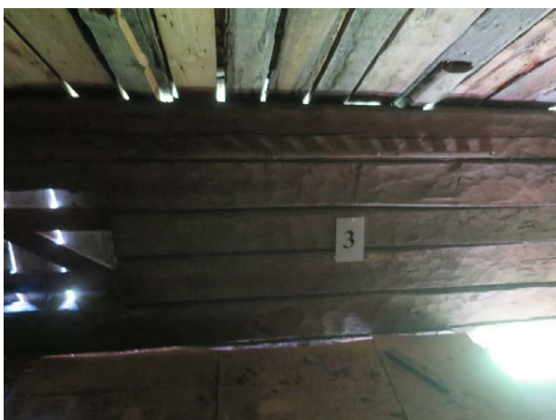
Prov 3 Yttervägg mot sydväst.
