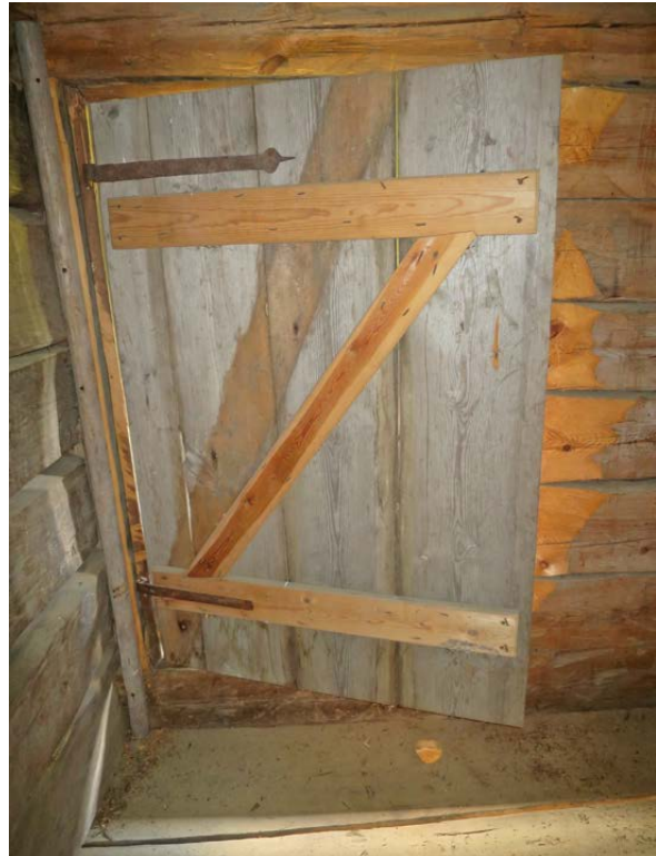
Övervåningens vänstra (sydvästra) dörr fotograferad från insidan. Dörren har blivit reparerad eller ombyggd någon gång under 1900-talet. Dörrbladets brädor är troligen inte ursprungliga.
