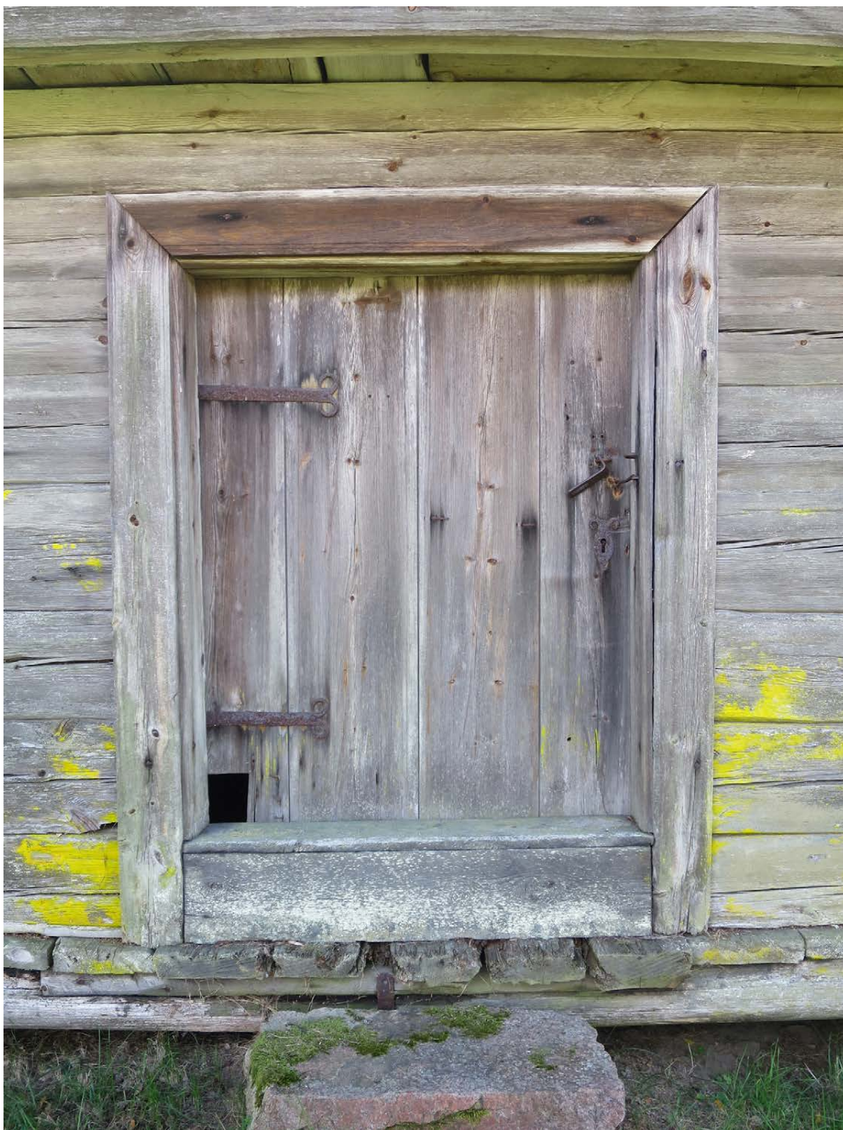
Bodens ytterdörr mot nordost. Dörren är konstruerad som en traditionell bräddörr. Gångjärnen och nyckel-skyften är utförda i smide. Lägga märke till de smidda delarnas samordnade dekor.
