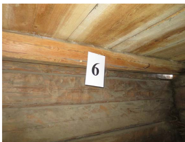
Prov 6 Balk, golvbjälklag, vån 2.
