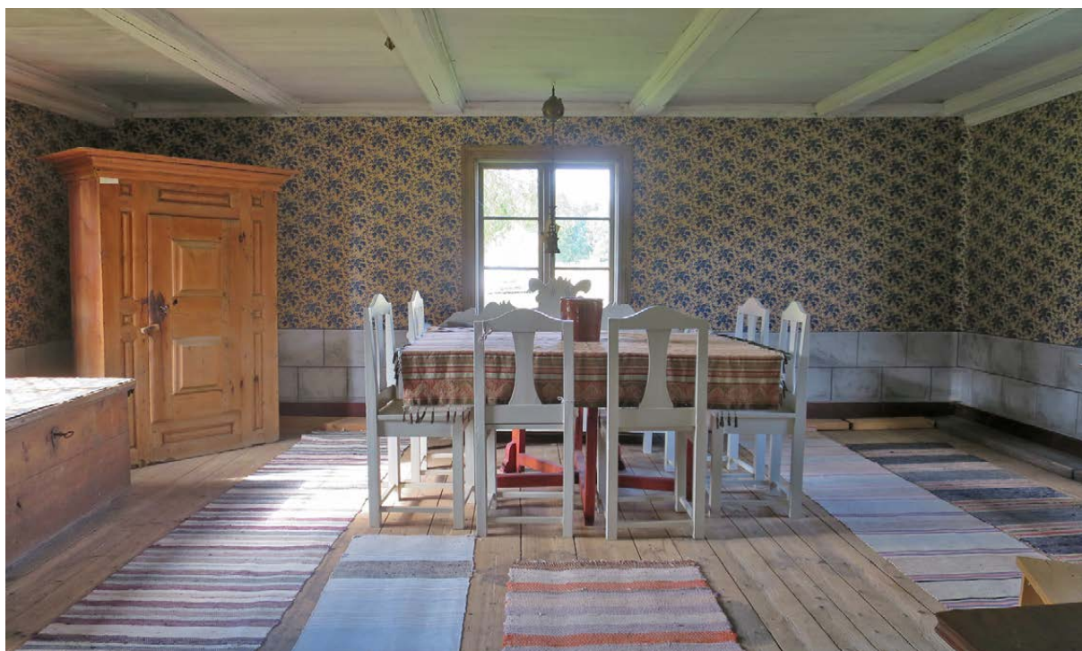
Rum 10 på bottenvåningen i byggnad 7. Vid 1990-talets renovering återfick rummet samma tapetmönster och målade bröstning som det hade omkring 1860-1870. Tapeten nyttillverkades med den gamla som förlaga.
