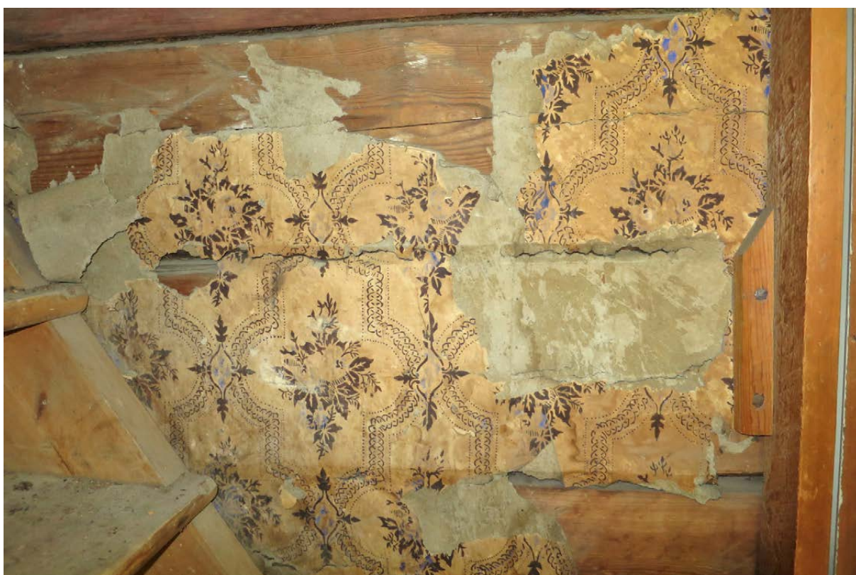
Tapetrester på timrad innervägg vid trappa upp till vinden i byggnad 5. Medaljongmönster i denna stil var vanliga under 1870- och 80-talet.
