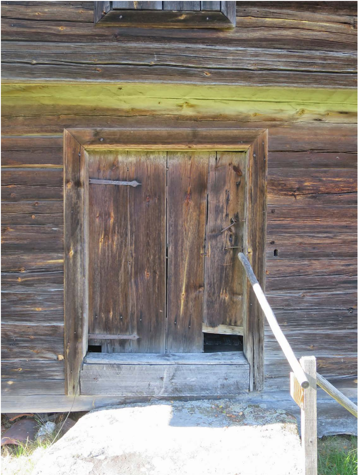
Ytterdörr till byggnad 2. Placeringen mot sydost har gjort att dörren med åren fått en mer vittrad yta än dörren till byggnad 1, vilken är vänd mot nordost.
