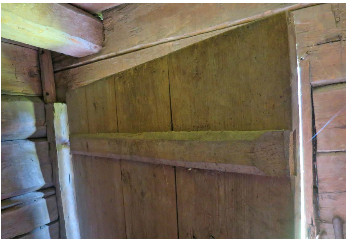
Övre tvärså på baksidan av bottenvåningens vänstra dörr. Ingen av byggnadens dörrar har profilerade kanter på tvärsåarna.
