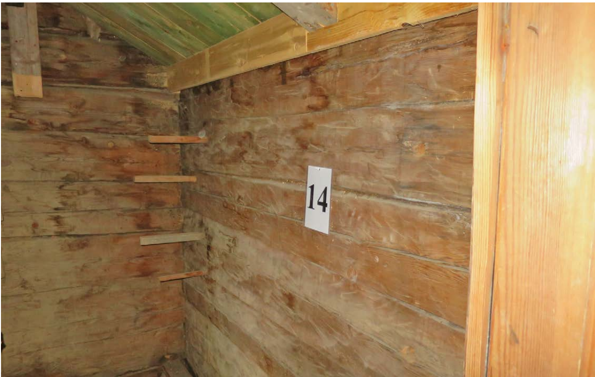
Prov 14 togs i ytterväggen mot nordost inne i ett smalt förråd på övervåningen i byggnad 8. Provet har daterats till vinterhalvåret 1785/86. Inne i samma förråd togs ytterligare ett prov, nr 15, i mellanväggen som syns till vänster i bild. Det provet gavs en trolig datering till åren 1784-1787. Samtliga prover som tagits från virke i byggnad 8 har beräknade fällningsår som möjliggör avverkning vintern 1785/86.
