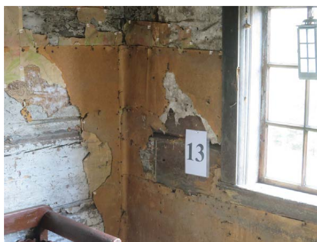
Prov 13 Yttervägg mot nordväst.
