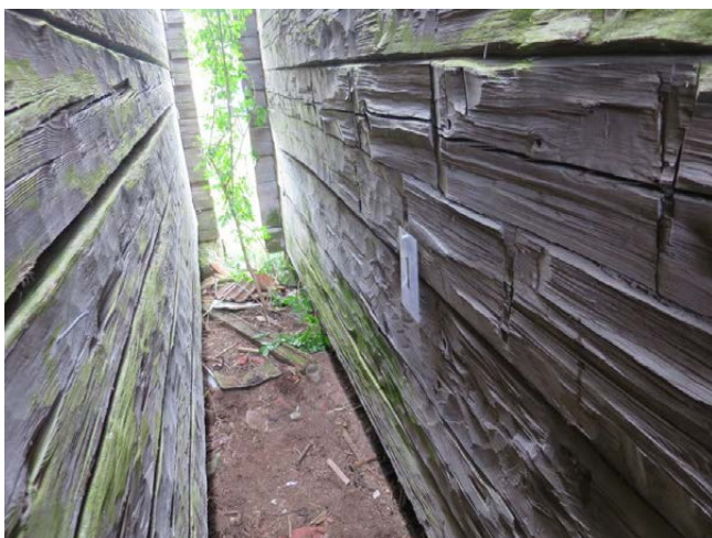
Prov 1 Yttervägg mot sydväst
