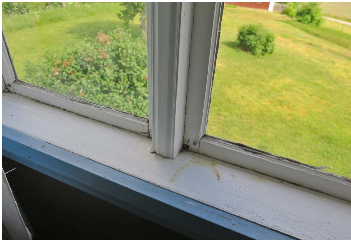
Mittpost till fönster i rum 212 på övervåningen i byggnad 6. Alla fönster i byggnad 5 och 6 har ungefär samma profil på mittposterna. Störst likhet har de med typer som i Sander Roséns bok daterats till en period omkring 1780-1800.
