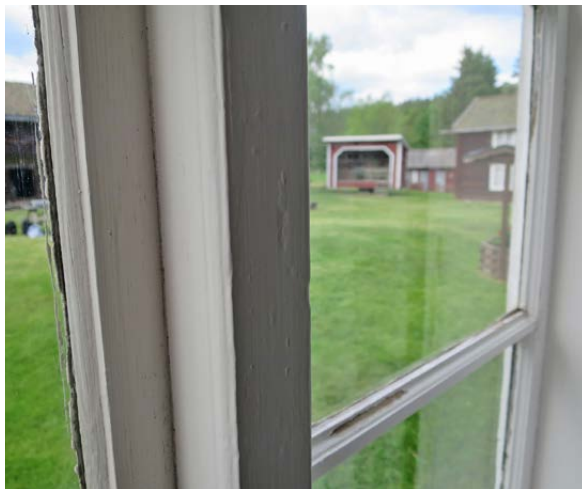
Mittpost till fönster i rum 103 på bottenvåningen i byggnad 5.
