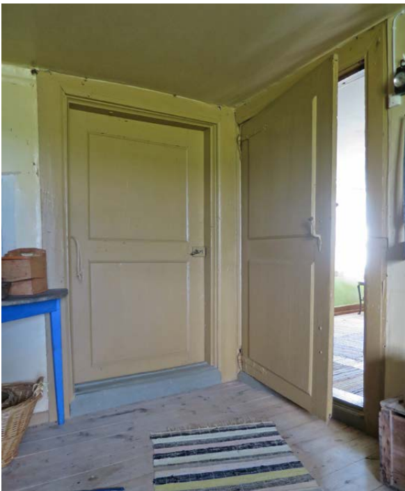
Dörrparti i rum 112, på bottenvåningen i byggnad 6. Alla motsvarande rum på bottenvåningarna i byggnad 5, 7 och 8 har liknande dörrpartier, där ytan mellan dörrarna inretts med skåp. Detaljutförandet skiljer sig dock åt i samtliga fall. Här är dörrbladen indelade i två lika stora spegelfält.
