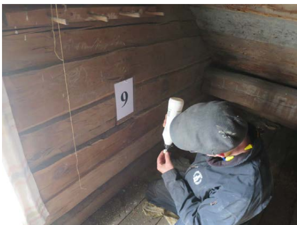
Prov 9 Yttervägg mot sydväst.
