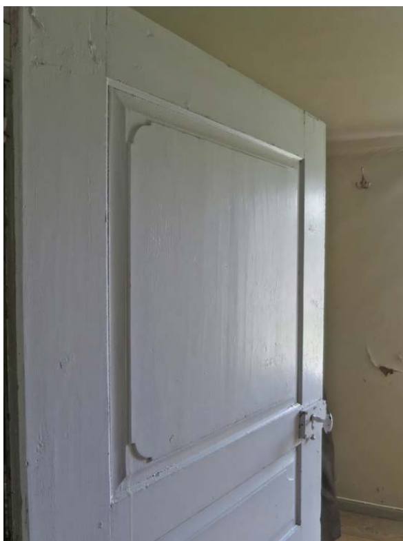
Dörr i rum 201. I släpljus framträder dörrspegelns handhyvlade yta.
