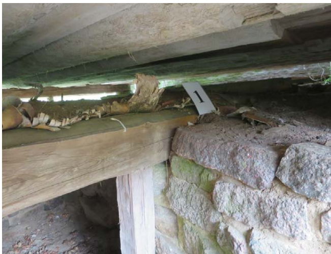
Prov 1 Balk i källare.
