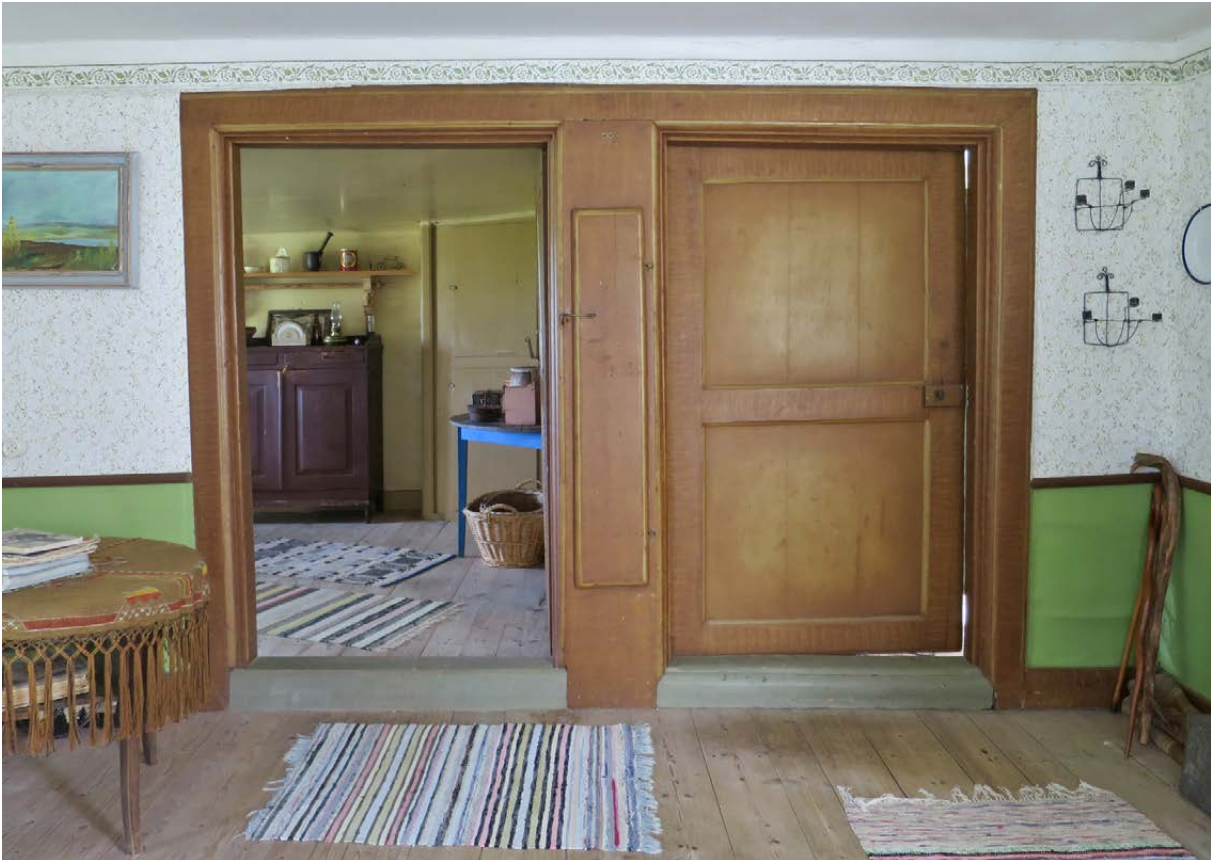
Dörrparti i rum 112, på bottenvåningen i byggnad 6. Alla motsvarande rum på bottenvåningarna i byggnad 5, 7 och 8 har liknande dörrpartier, där ytan mellan dörrarna inretts med skåp. Detaljutförandet skiljer sig dock åt i samtliga fall. Här är dörrbladen indelade i två lika stora spegelfält.
