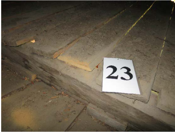
Prov 23 från vinden, planka som utgör del av tak i trapphus, rum 9, i hus 7.
