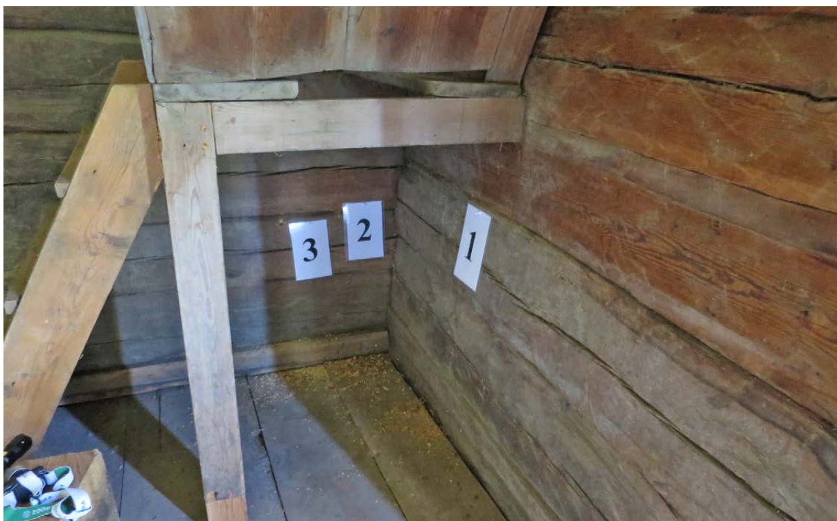
Proverna 1, 2 och 3 togs under trappan på bottenvåningen i byggnad 7. De har daterats till perioderna 1754-1784, 1784-1803 och 1791-1794. Det tredje provets datering visar att uppförandet av byggnad 7 tidigast kan ha påbörjats 1791.
