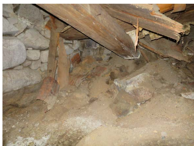
Prov 19 och 20 sågades ut golvplankor ur det nedrasade golvbjälklag som man kan nå från källare under köksgolvet i hus 7.
