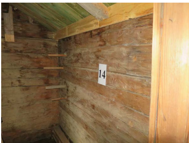
Prov 14 Yttervägg mot nordväst.
