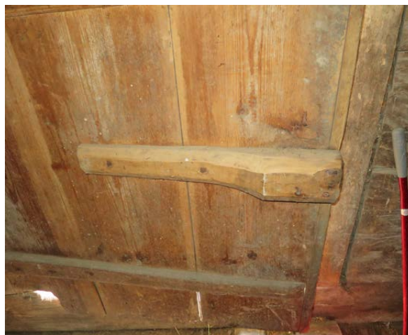
Bottenvåningens tre dörrar har samma sorts stocklås som dörren till byggnad 1. Bilden visar bottenvåningens dörr längst åt höger (nordost).
