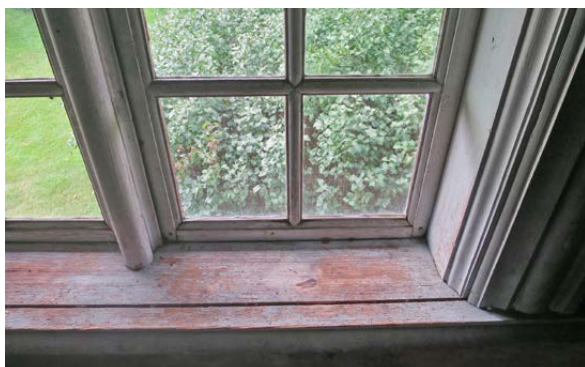
Fönsterpost i "Barockrummet", rum 1. Den runda fönsterposten överensstämmer med en typ som daterats till 1741. Samma profilering återkommer på flera andra fönster i huset, bland annat i "Rokokorummet", rum 2.
