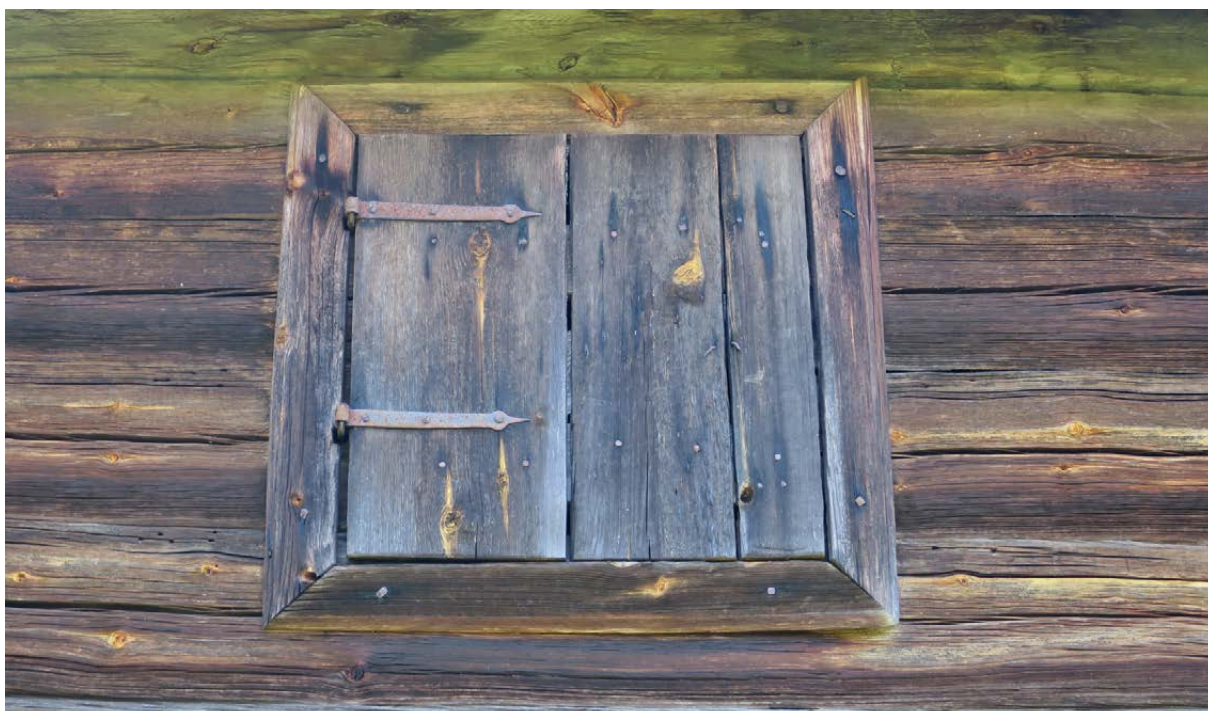
Övervåningens lucka är utåtgående, men i övrigt har den samma konstruktion och utformning som bottenvåningens dörr.
