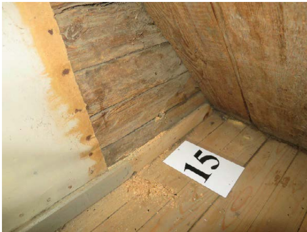
Prov 15 taget i innervägg i skrub, under trappan, hus 5.
