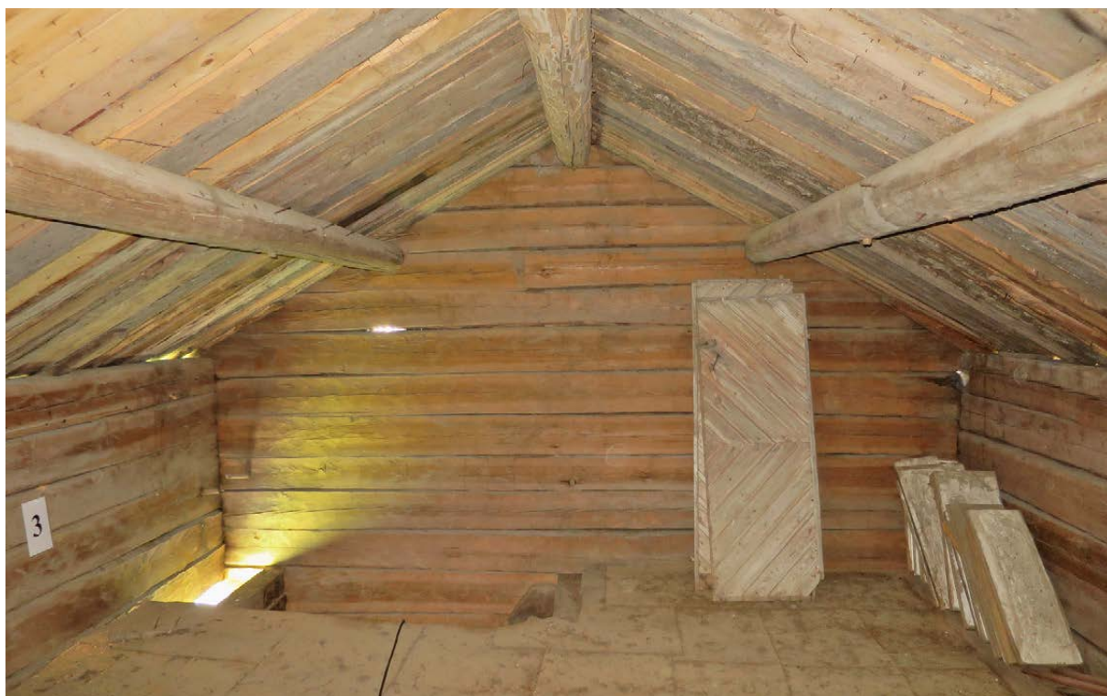
Byggnad 2, fotografi mot sydväst på övre våningen. Borrprov nr 3 togs i ytterväggen mot sydost, till vänster i bild. Analysen gav samma resultat som prov nr 2, vinterhalvåret 1793/94.
