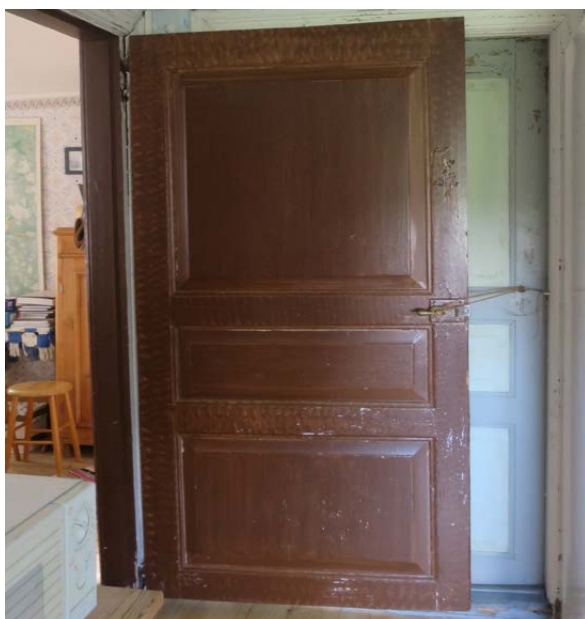
Dörr mellan rum 102 och 103.
