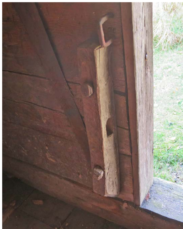
Trästycket vid dörröppningens sida är en del av en primitiv låsanordning.
