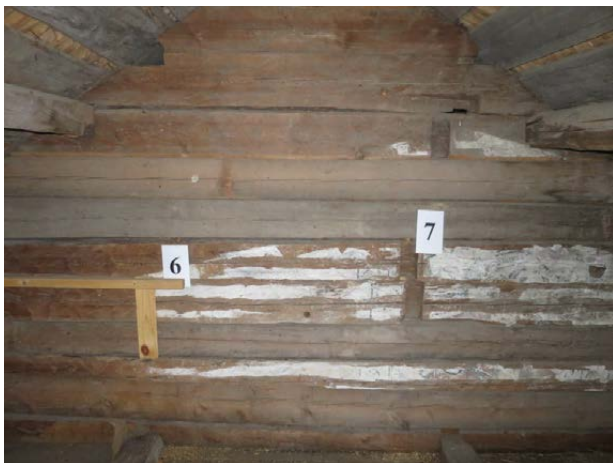
Prov 6-7 Mellanvägg. Prov 6 i återanvänt virke och prov 7 i vad som förefaller vara virke från husets byggnadstid.
