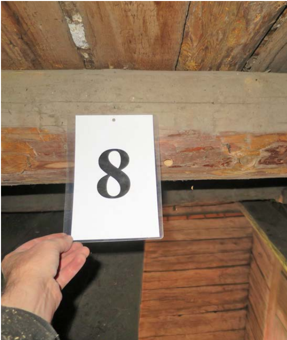
Prov 8, från en sidoås till det sydvästra takfallet på byggnad 7, daterades till vinterhalvåret 1787/88.
