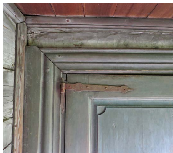
Närbild av dörrens gångjärn. Fotografi från farstun. Gångjärnet har samma utförande som hos de flesta av dörarna till gårdens bodar. Modellen förknippas främst med 1600-talet, men tycks alltså ha fortsatt användas under hela 1700-talet.
