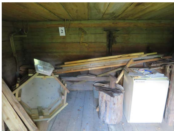
Prov 2 Yttervägg mot sydväst.
