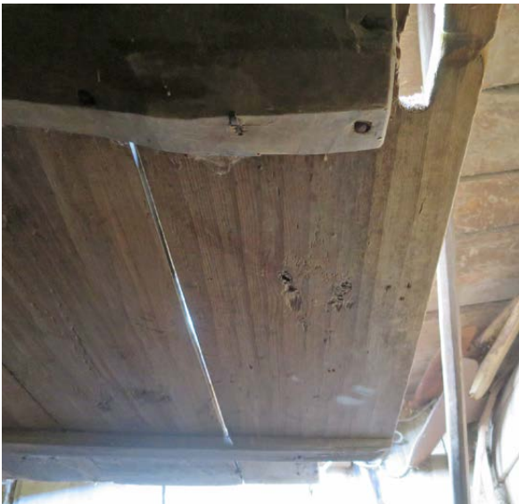
Närbild av stocklås och hyvelspår på insidan av bottenvåningens vänstra dörr. Stocklåset har samma form som hos dörarna till bottenvåningen på byggnad 3.
