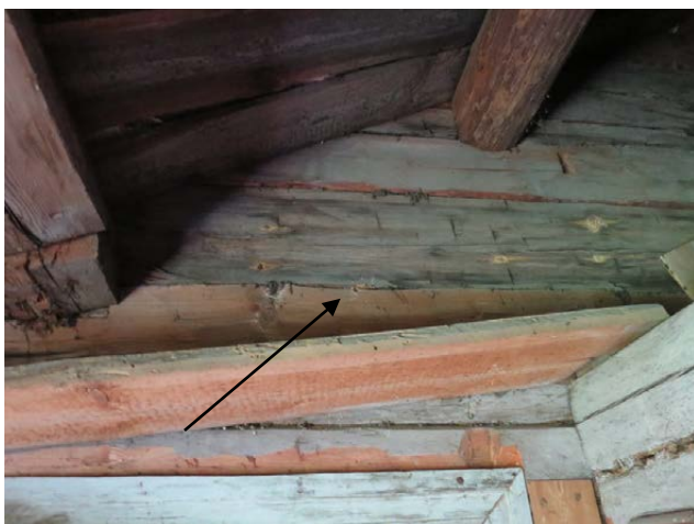
Prov 10. Mellanvägg mot nordväst, pilen visar borrhålet.
