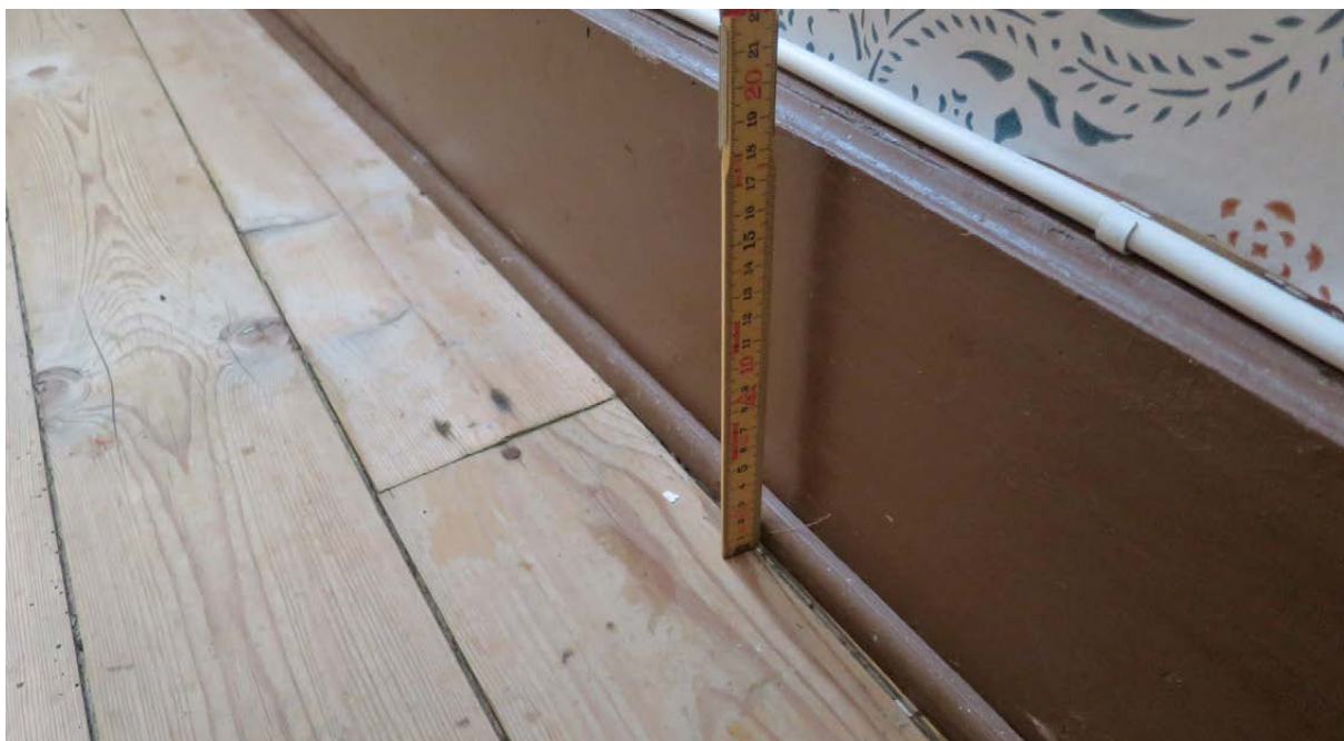
Golvsockel i rum 103 på bottenvåningen i byggnad 5. Sockeln är ungefär 19 cm hög. Överkantens enkla profil kan dateras till omkring år 1800.
