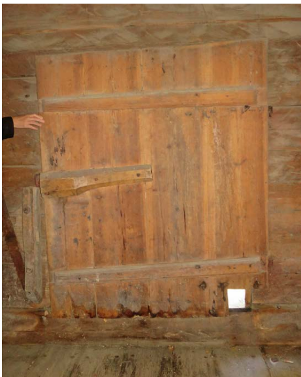
Bräddörren sedd från insidan.
