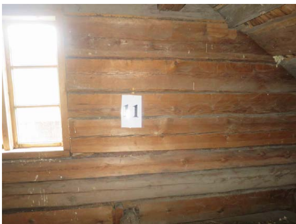
Prov 11 Yttervägg mot nordost.
