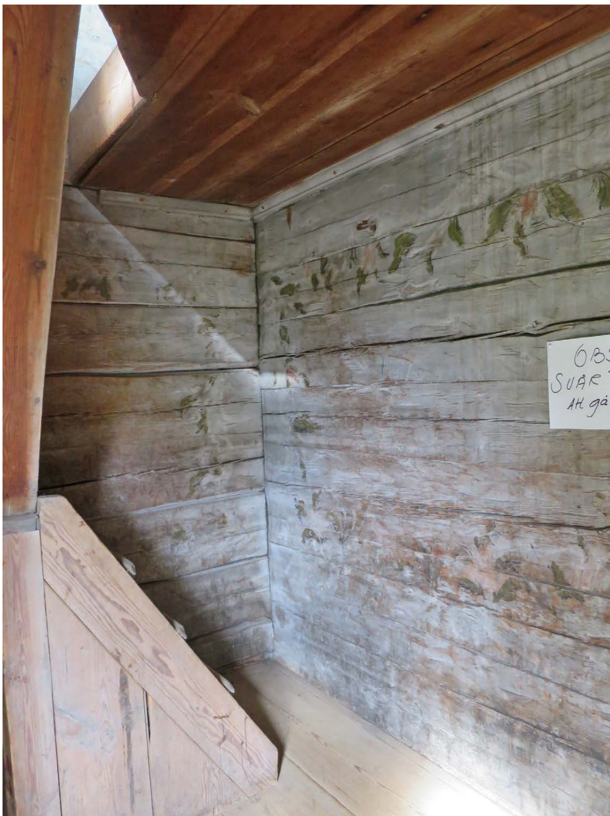
Tre av de fyra väggarna i förstugan intill det gustavianska rummet är bemålade med blomsterrankor i rektangulära fält. Måleriet är utfört direkt på timmerstommen.
