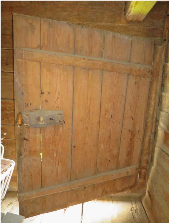
Insidan av bottenvåningens högra dörr. Stocklåset har ungefär samma form som hos dörren till byggnad 2.
