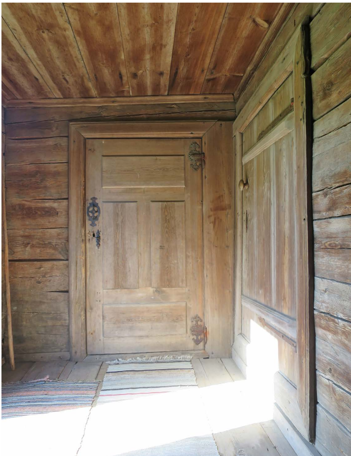
Fotografi från farstun (rum 12) mot salen (rum 10). Salsdörrens sida mot farstun har utanpåliggande speglar. Dörrens gångjärn är ålderdomliga. Typen förekommer vanligen under 1600-talets senare hälft och 1700-talet. Till vänster i bild syns dörren mot köket (rum 11). Den är liksom gårdens boddörrar byggd som en traditionell bräddörr.
