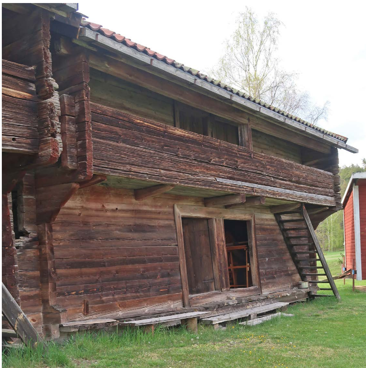
Byggnad 4 fotograferad från söder. Till vänster skymtar byggnad 3.
