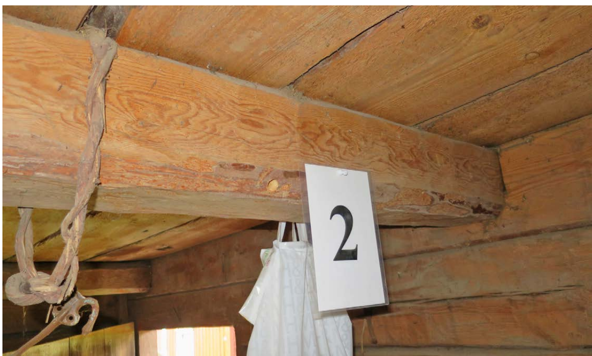
Prov nr 2 i byggnad 4, loftbod. Provet togs i en av mellanbjälklagets balkar. Analysen visade att timret fällts under vinterhalvåret 1766/67.
