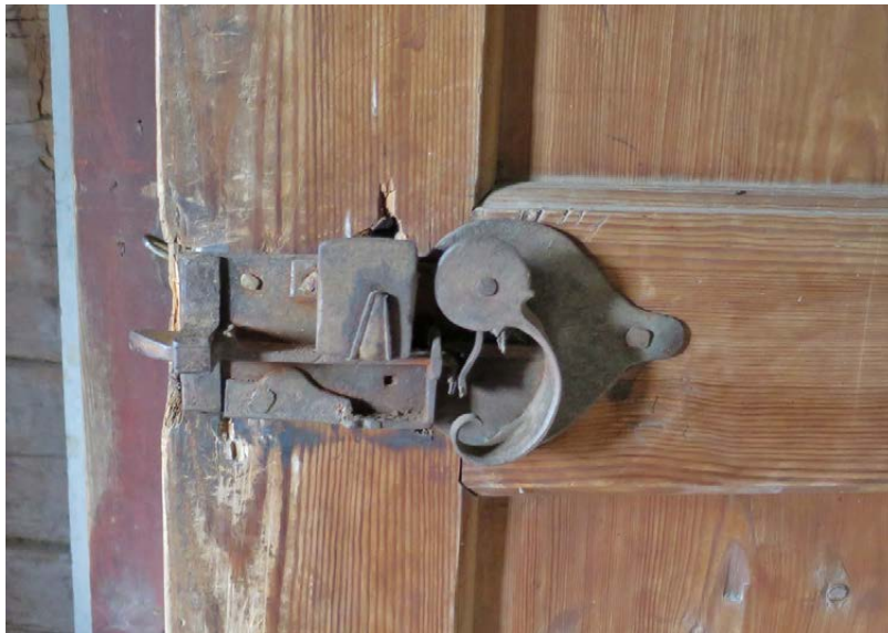
Kammarens dörr är försedd med ett så kallat smäljelås. Låstypen var vanlig under 1700-talet och 1800-talets första hälft.
