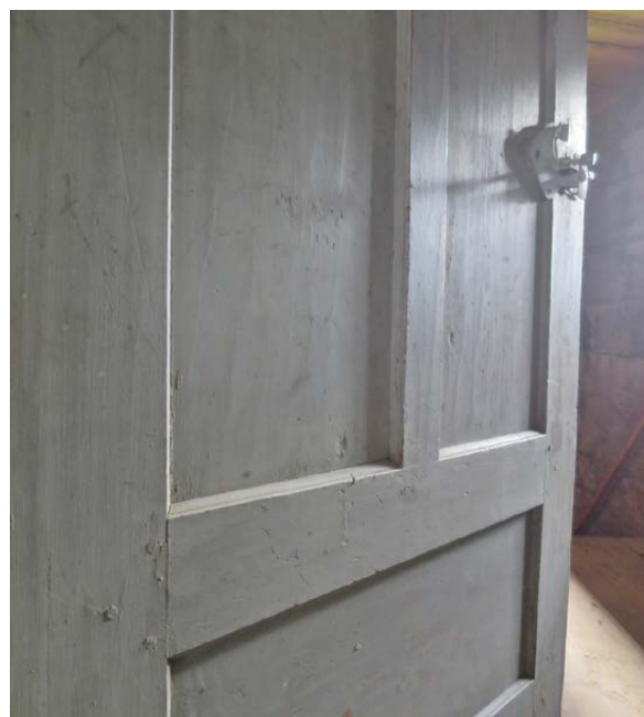
I släpljus framträder de handhyvlade ytorna tydligt.
