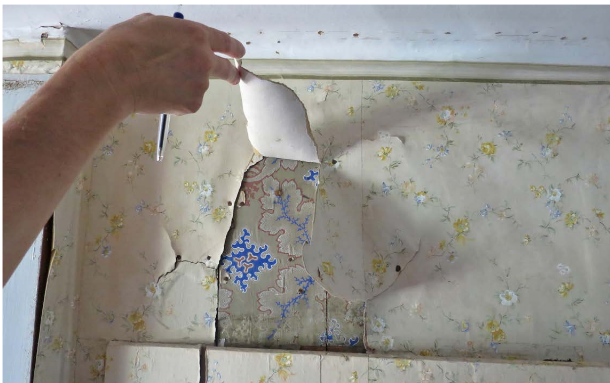
Tapeter i rum 213 på övervåningen i byggnad 6. Under 1940-talstapeten skymtar ett äldre tapetskikt. Färgerna var vanliga under 1860-talet men mönstret påminner mer om tapeter från 1880- och 90-talet.
