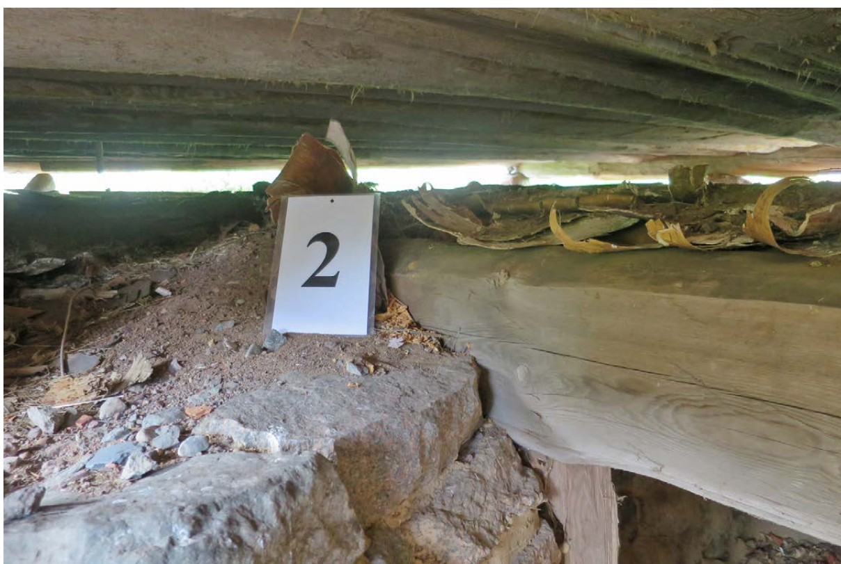
Byggnad 3. Prov 2 togs i en balk över källaren. Provet har daterats till vinterhalvåret 1772/73. Som framgår av bilden har källarens konstruktion ingen kontakt med bottenvåningens golvbjälklag.
