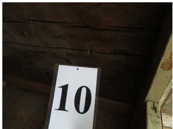
Prov 10 Yttervägg mot nordost.
