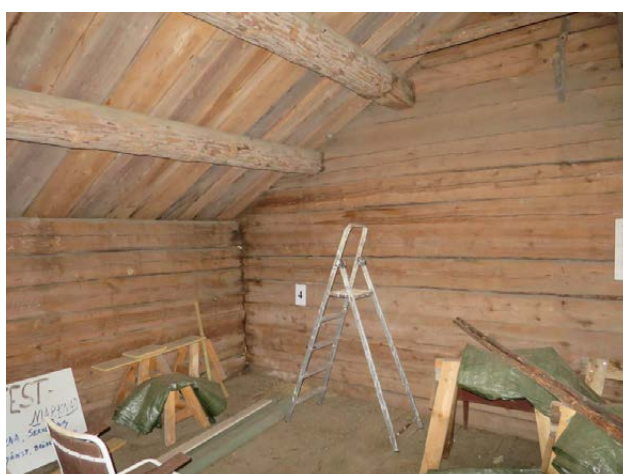
Prov 4 Yttervägg mot nordost
