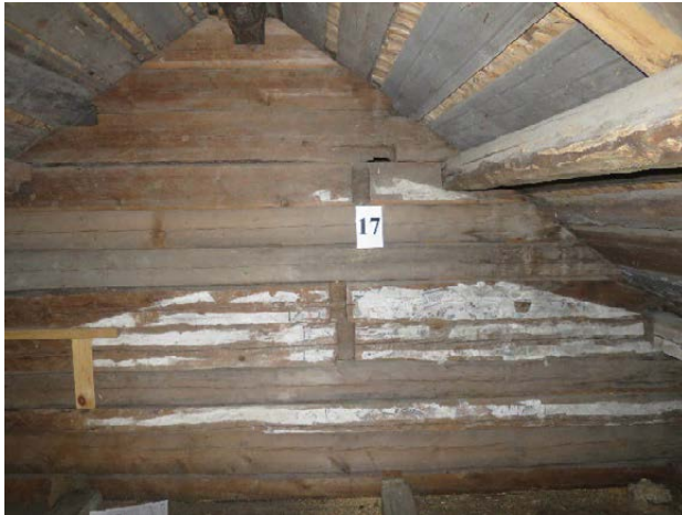
Prov 17, mellanvägg på vinden, hus 5.
