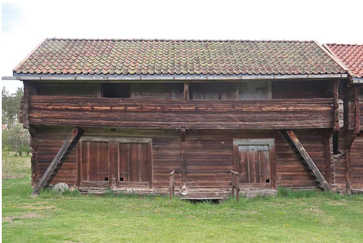
Byggnad 3, huvudfasad mot sydost. Det finns tre dörrar på bottenvåningen och två dörrar på övervåningen.
