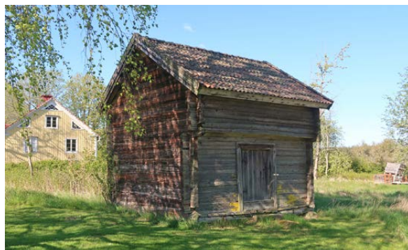
Hus 1 på Fröreda är en utkragad loftbod med utkragningen på långsidan.
