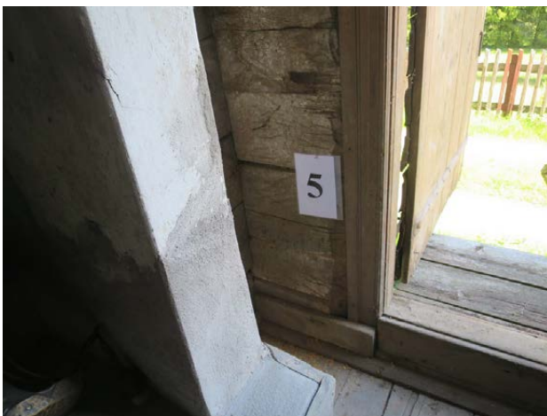
Prov 5 Yttervägg mot nordväst.
