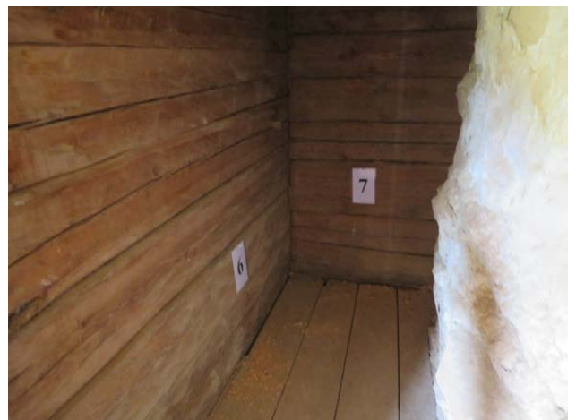
Prov 6 Yttervägg mot nordväst och prov 7 mellanvägg i nordost.
