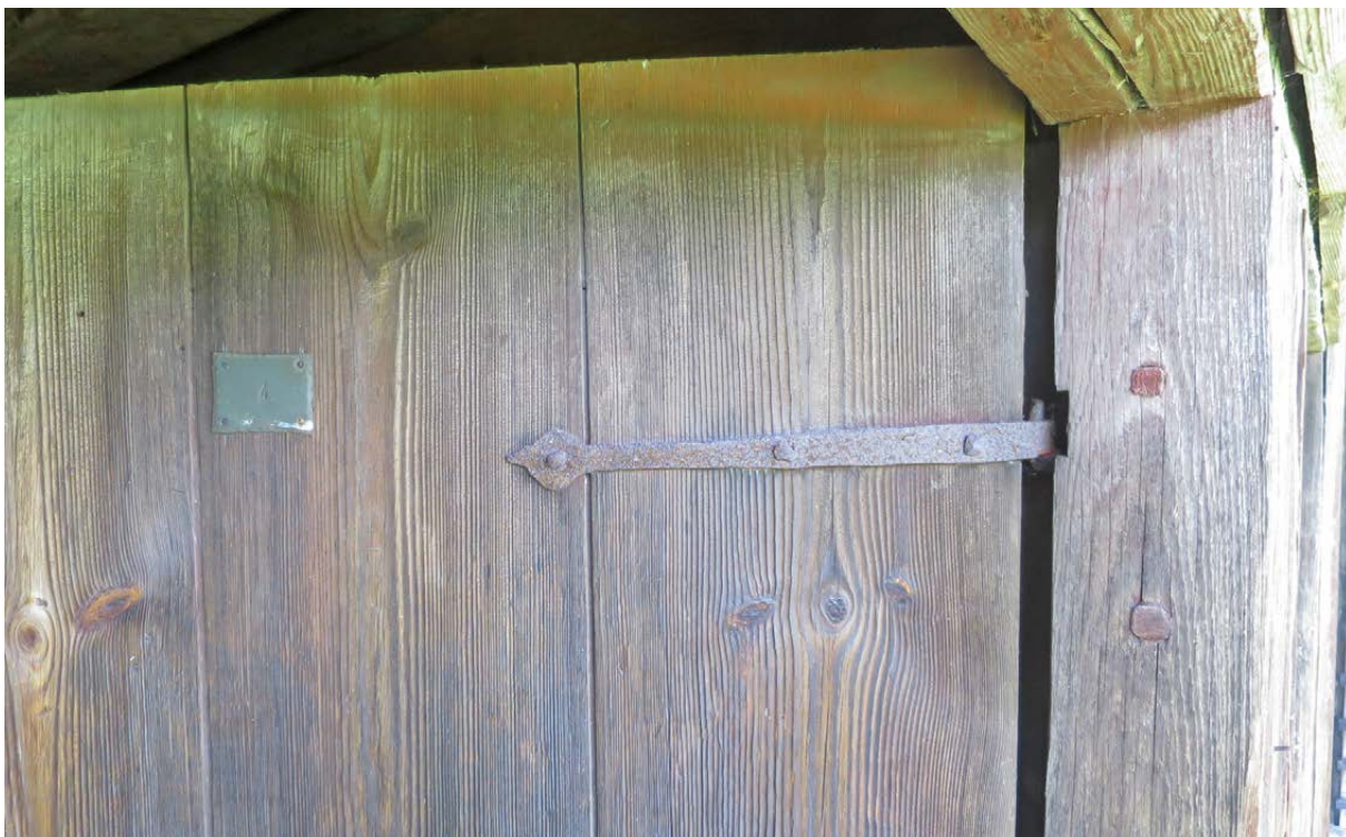
Närbild av gångjärn till bottenvåningens vänstra (sydvästra) dörr.
