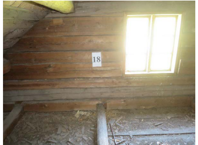
Prov 18, yttervägg, vinden hus 6.
