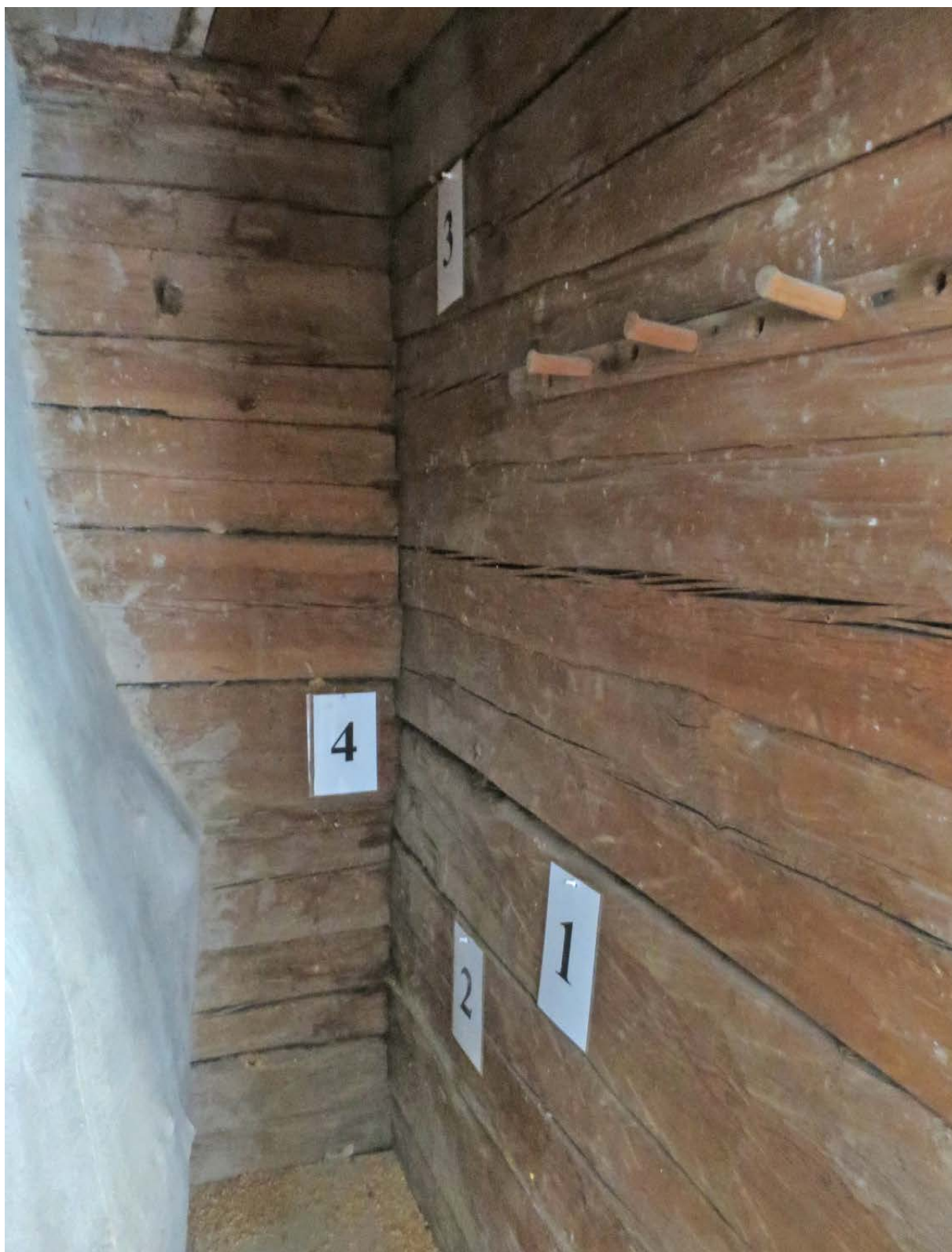
I ett förråd på andra våningen i byggnad 5 togs fyra prover. Analysen gav följande resultat: Prov 1, 1759–1781, prov 2, 1760–1774, prov 3, vintern 1799/1800 och prov 4 vintern 1803/04. Dateringarna tyder på att andra våningens väggar uppförts 1804 eller något år senare.
