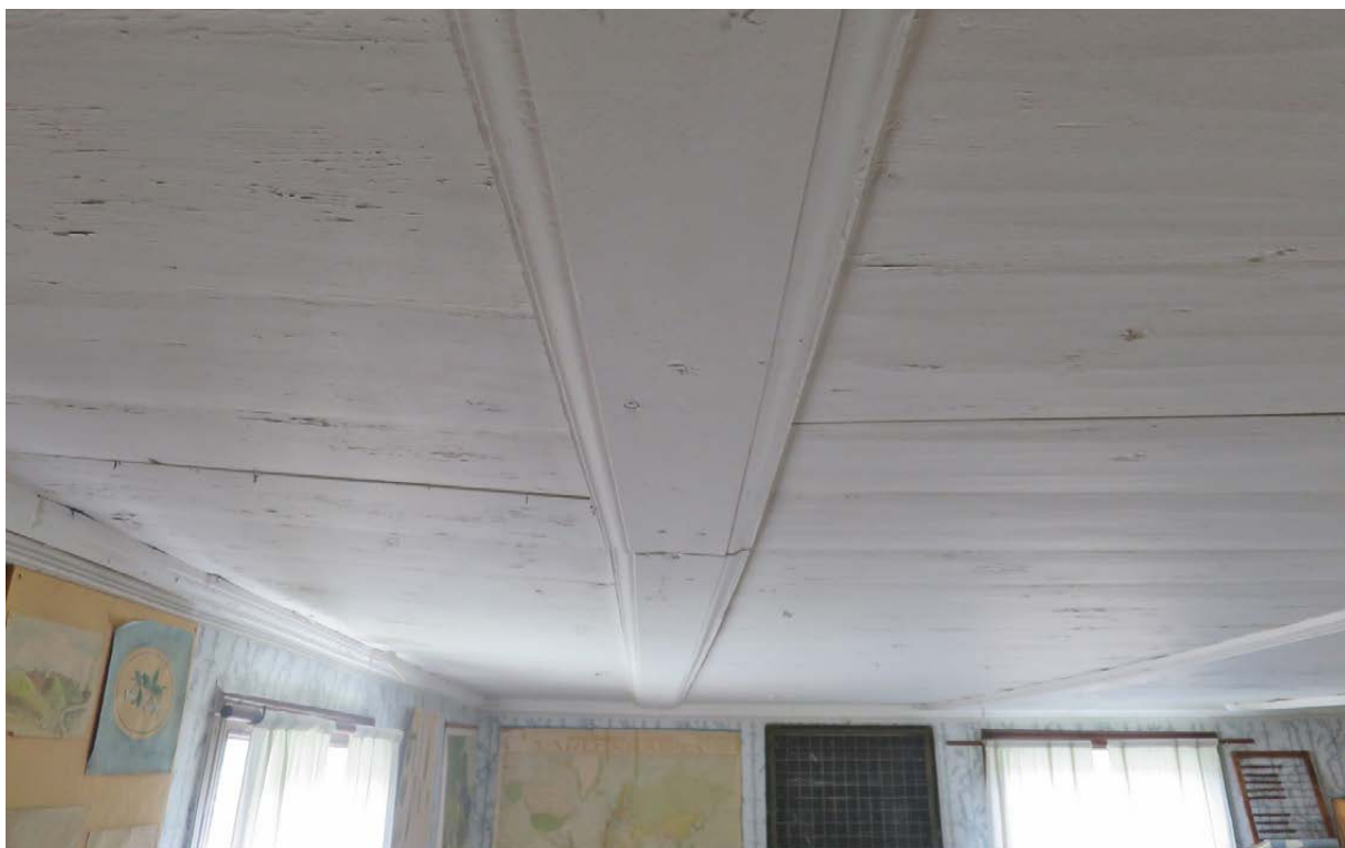
Brädorna i innertaken har samma profil som de flesta dörrfodren i byggnad 5 och 6. Bilden visar taket i rum 212.
