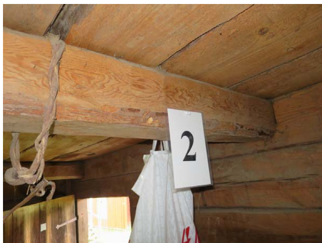
Prov 2 Balk mellanbjälklag.
