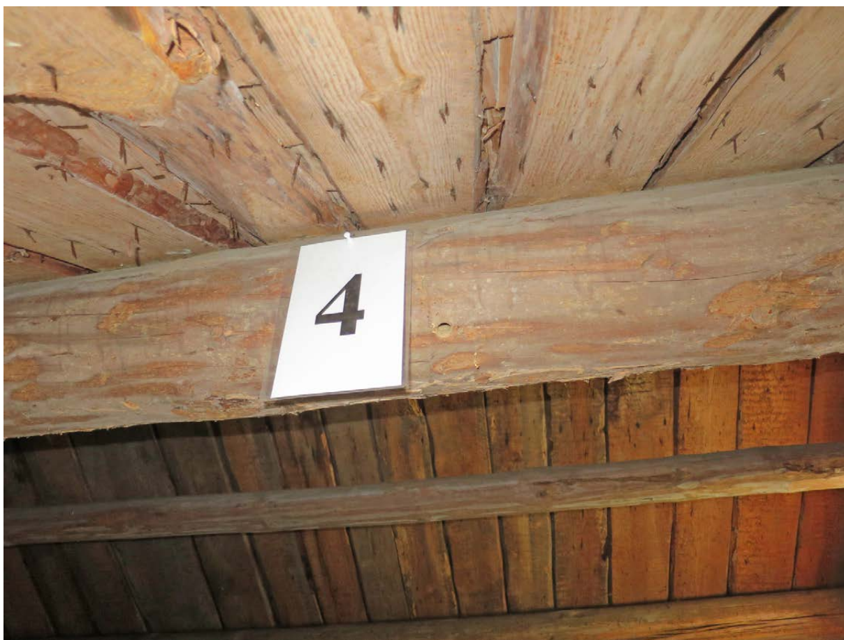
Prov nr 4 i byggnad 1, loftbod. Provet togs i en av takets sidoåsar. Analysen visade att tallen fällts vinterhalvåret 1761/62.
