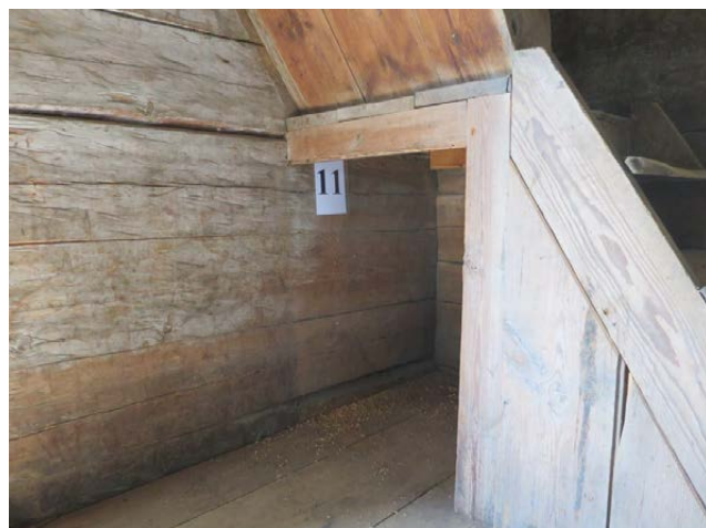
Prov 11 Yttervägg mot sydväst.
