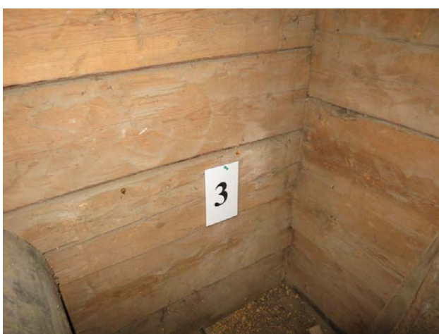
Prov 3 Yttervägg mot sydväst
