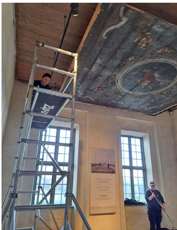
Rengöring och förstärkning av upphängningsanordning takmålning Kalmar slott.
