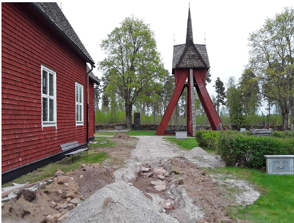
Spåren av det gamla vapenhuset vid Tutaryds kyrka. I det öppna schaktet syns syllstenarna till vapenhuset.
