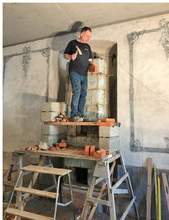
Restaurering av kakelugn, Kalmar slott.
