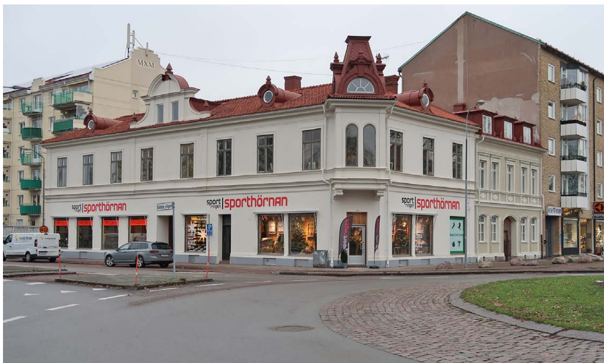
Anrika Sporthörnan i Kalmar genomgick varsam renovering och ombyggnad och fick ny färgsättning med hjälp av byggnadsantikvarisk medverkan under 2022. Pryder sin plats i stadsbilden!
