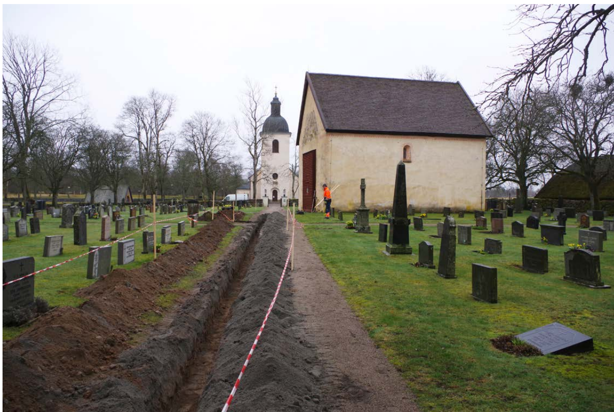
Figur 8. Schakt 1 gick genom kyrkogårdens norra del, foto från norr.
