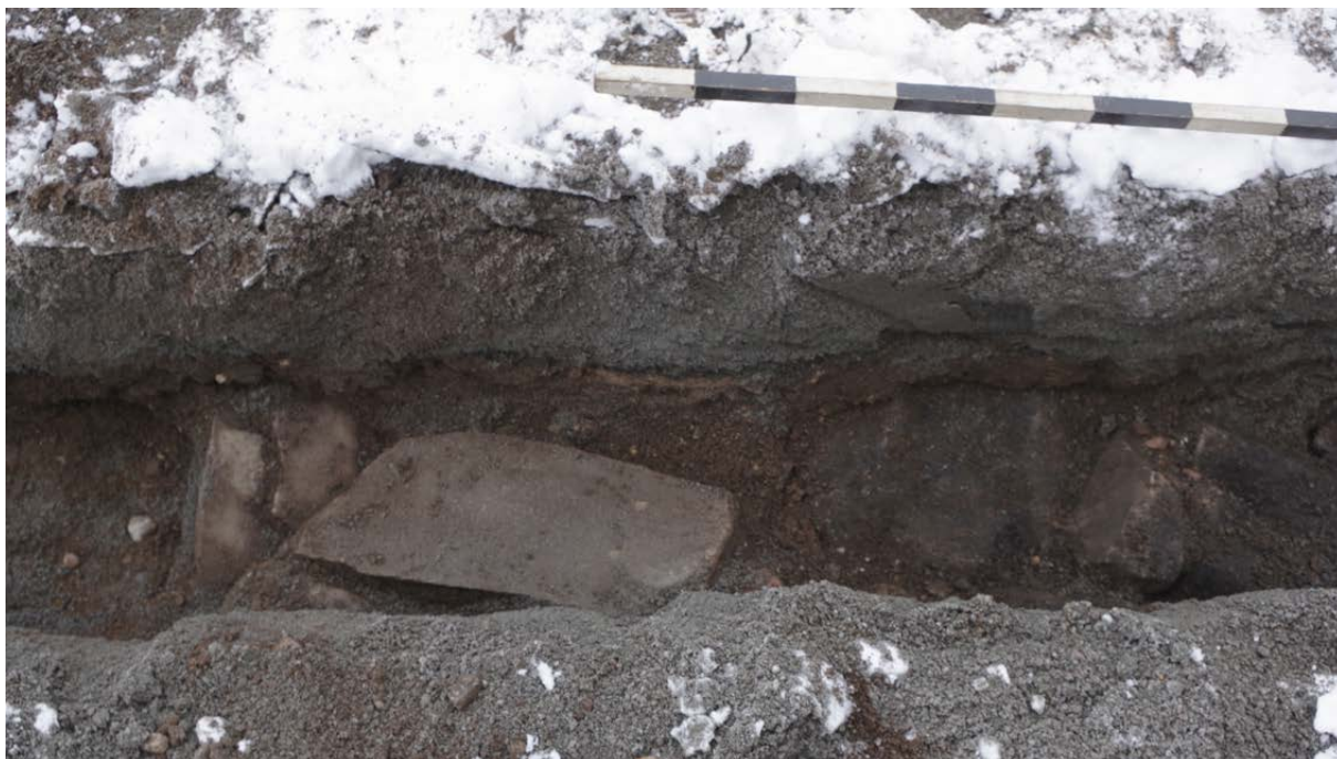
Figur 14. En del av korets norra grundmur, stenpackning A3 (till vänster i bild) frilades i schaktet. Till höger den senare nedgrävningen A7. Foto taget från öster.
