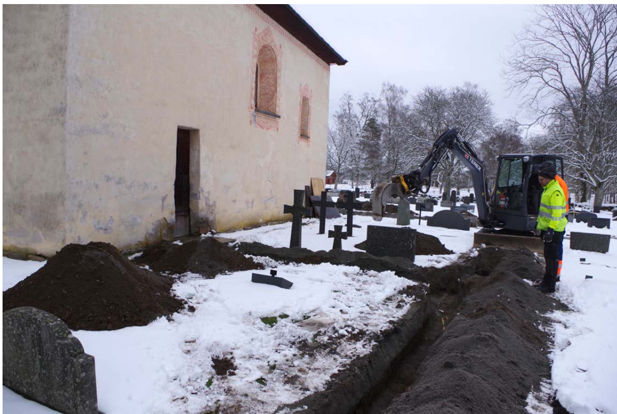
Figur 7: Schaktgrävning längs kyrkans södra sida, foto taget från väster.
