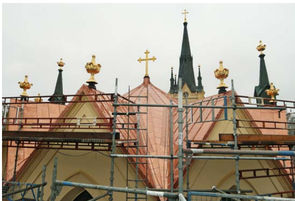
Koppartaket på Oskarshamns kyrka, före och efter omläggning.
