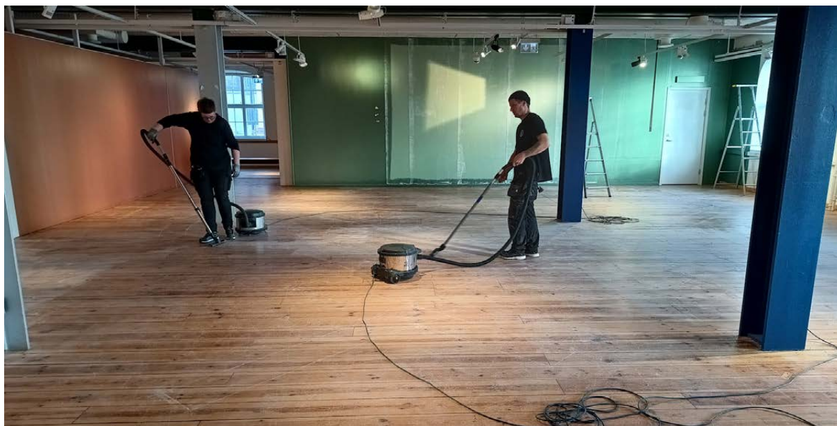
Förberedelser inför byggnation av utställningen Borgarnas ö.
